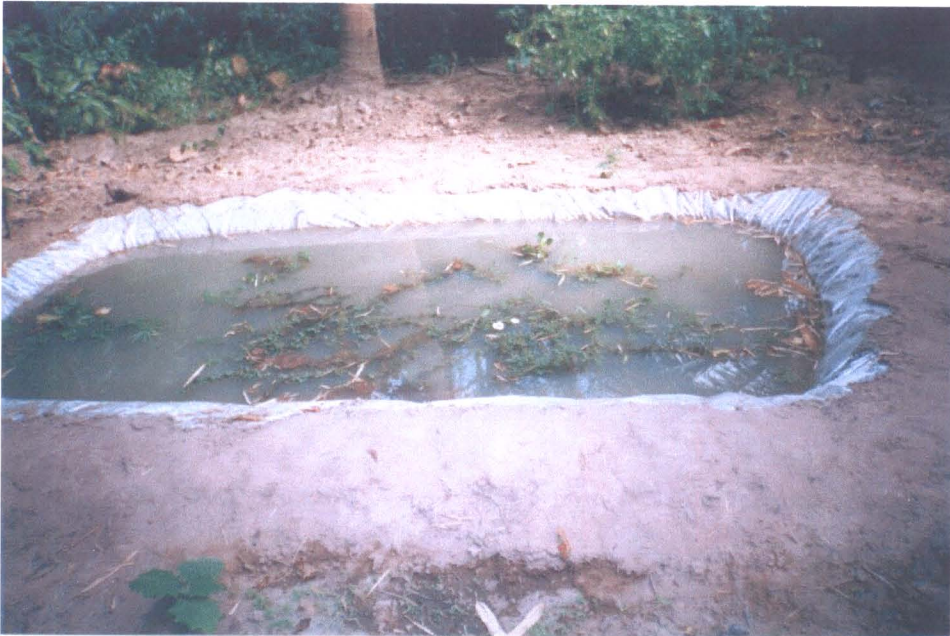
รูปที่ 6 บ่อทดลองเลี้ยงกบ ใช้พลาสติกกรองแทนปูนก่อนที่จะฉาบปูน
