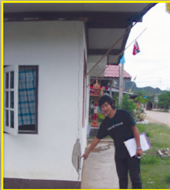
28 กันยายน 2549 บ้านบางปู หมู่ 8 ต.สามร้อยยอด อ.สามร้อยยอด จ.ประจวบคีรีขันธ์ ผนังบ้านร้าวและกระเบื้องหลังคา หล่น ขนาดแผ่นดินไหวคือ 4.2, 4.8, 5.0
