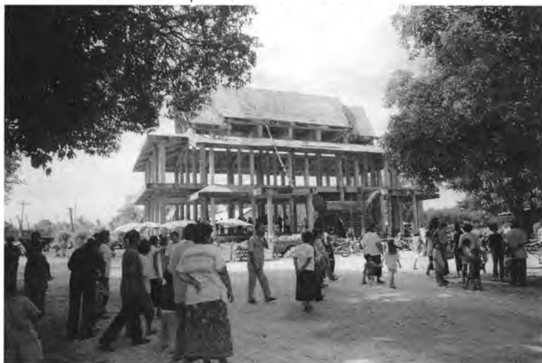
ปัจจุบันมีการรื้อศาลาวัดหลังเก่า และสร้างเป็นศาลาอเนกประสงค์ ภายในมีห้องสมุดเป็นที่ระลึกถึงอาจารย์ป่วย
