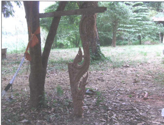
รูปภาพขณะดำเนินการซ่อมแซมคันทวย
