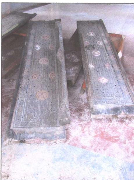
รูปภาพขณะดำเนินการซ่อมแซมประตู
