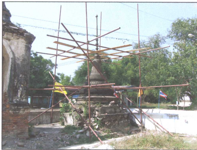
รูปภาพขณะดำเนินการติดตั้งนั่งร้าน
