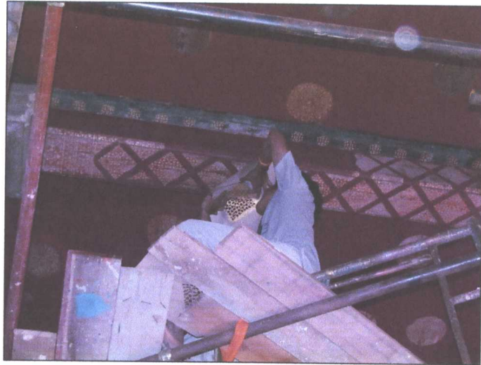
รูปภาพขณะดำเนินการซ่อมแซมลวดลายฝ้าเพดาน
