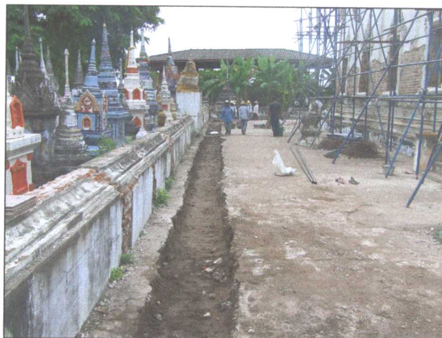
รูปภาพขณะดำเนินการขุดแนวรางระบายน้ำ
