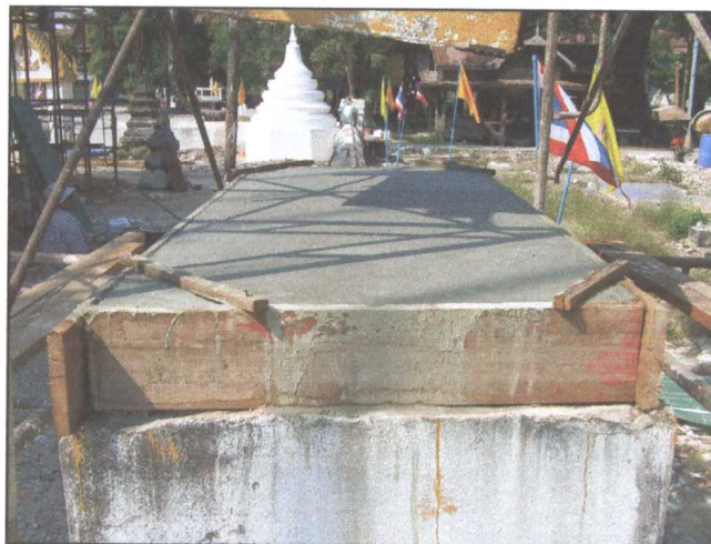
รูปภาพขณะดำเนินการเทคอนกรีตทับหลัง
