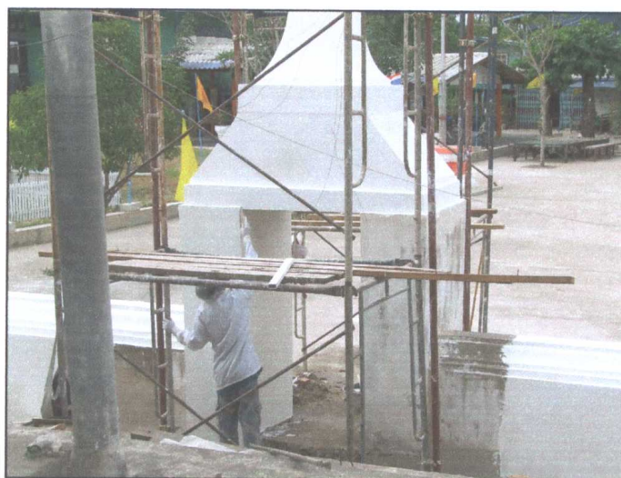
รูปภาพขณะดำเนินการขัดปูนดำซุ้มประตู
