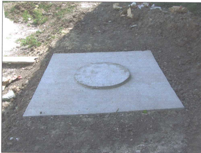
รูปภาพเมื่อดำเนินการก่อสร้างบ่อพักน้ำแล้วเสร็จ
