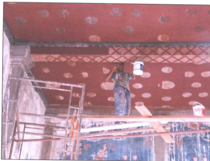
รูปภาพขณะดำเนินการทำสีฝ้าเพดาน
