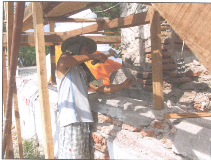
รูปภาพขณะดำเนินการเจาะเย็บและเจาะฉีดน้ำปูนก่ออิฐก่อแพ่งแก้ว
