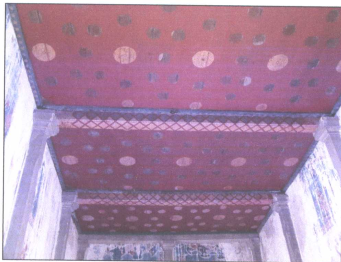
รูปภาพขณะดำเนินการซ่อมแซมฝ้าเพดานภายในแล้วเสร็จ
