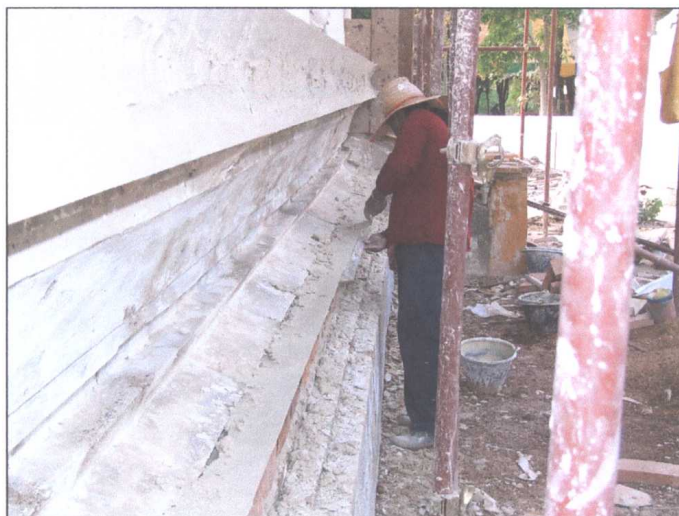
รูปภาพขณะดำเนินการจับเหล็กม้วนผนังใหม่
