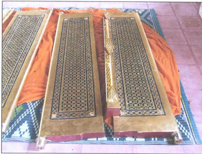
รูปภาพขณะดำเนินการซ่อมแซมลวดลายประตูดหน้าต่าง
