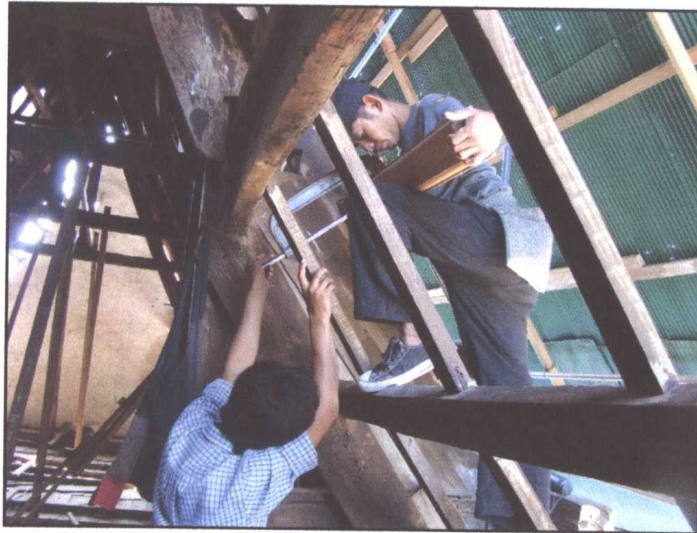
รูปภาพขณะดำเนินการติดตั้งกระทงไม้
