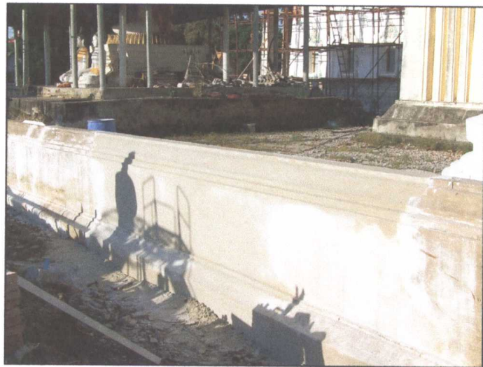
รูปภาพขณะดำเนินการฉาบปูนใหม่
