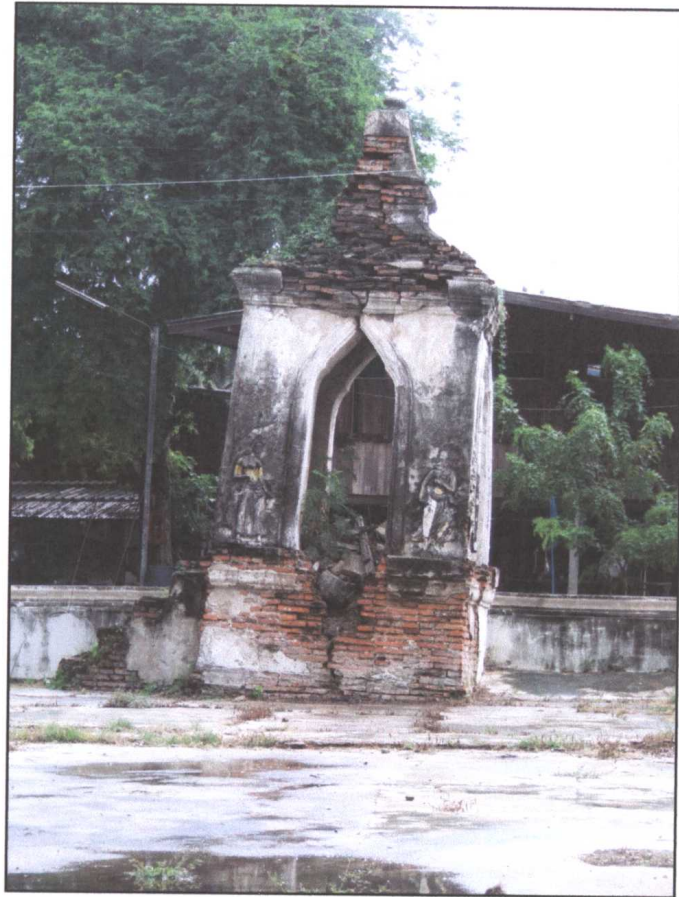
รูปภาพสภาพก่อนการบูรณะหอรระฆัง
