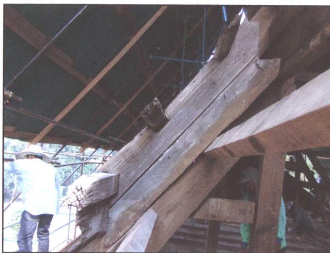
รูปภาพขณะดำเนินการรื้อถอน
