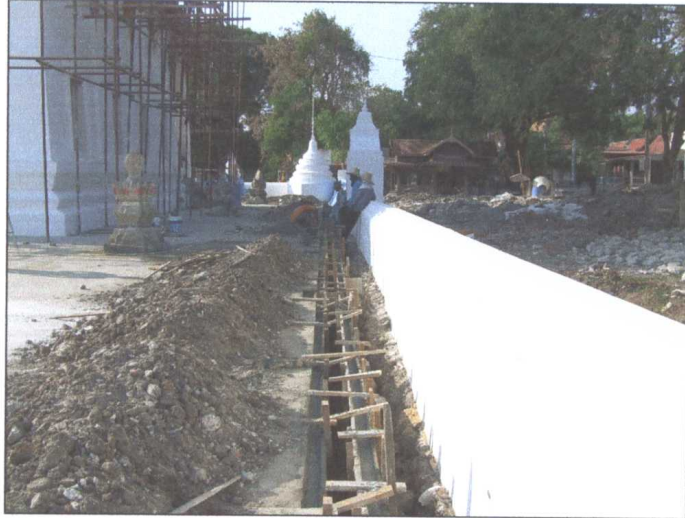
รูปภาพขณะดำเนินการติดตั้งแบบหล่อคอนกรีต
