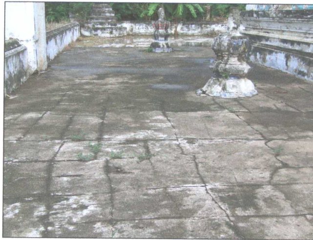
รูปภาพก่อนดำเนินการก่อสร้างรางระบายน้ำ
