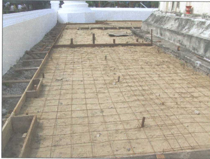
รูปภาพขณะดำเนินการผูกเหล็กเสริมคอนกรีต
