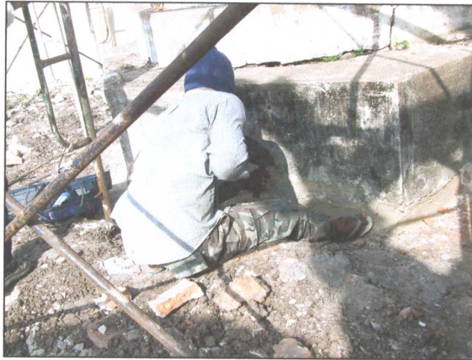
รูปภาพขณะดำเนินการเจาะฉีดน้ำปูน
