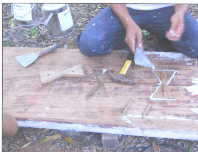
รูปภาพขณะดำเนินการซ่อมแซมประตู
