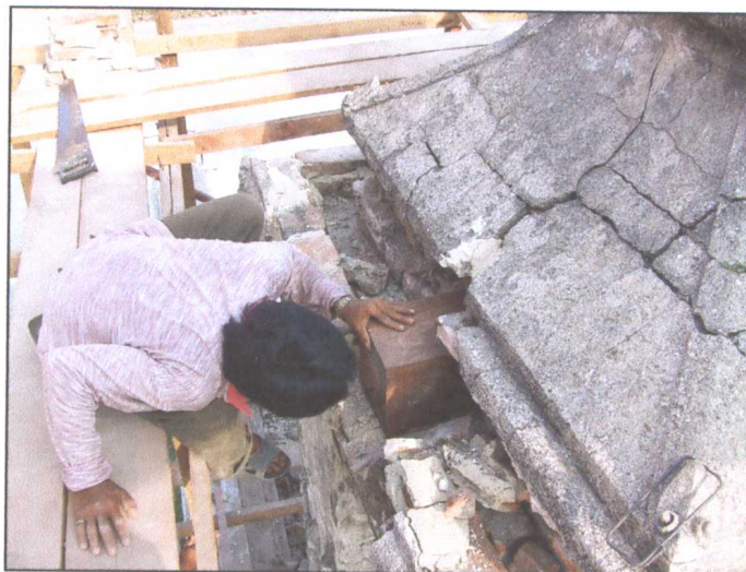
รูปภาพขณะดำเนินการติดตั้งไม้แขวนระฆัง
