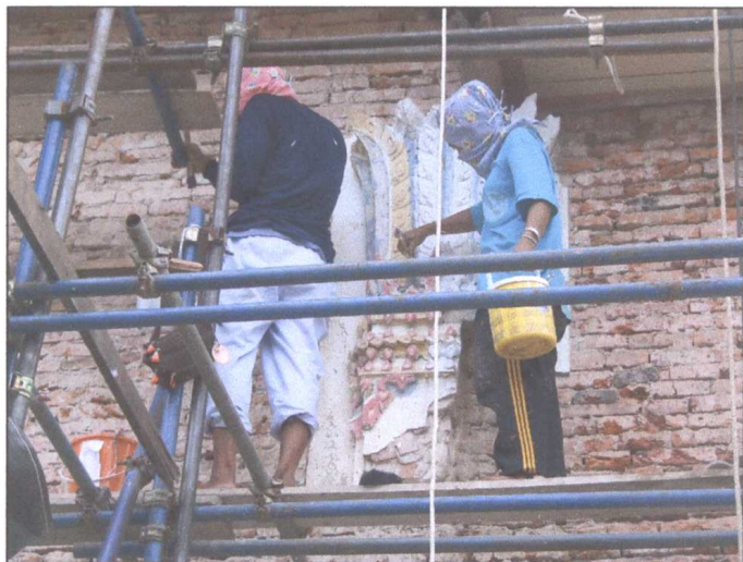
รูปภาพขณะดำเนินการเสริมความแข็งแรงลายปูนปั้น
