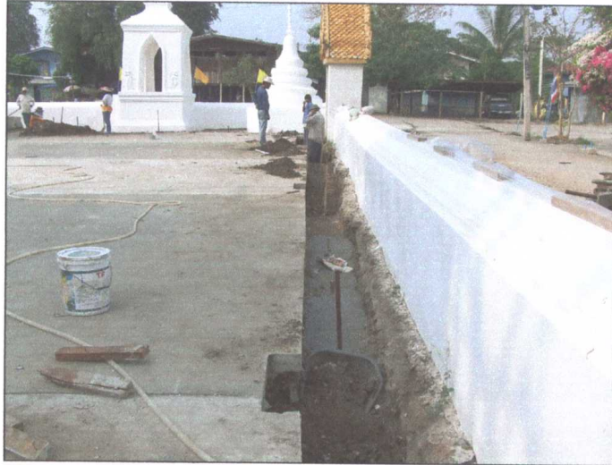
รูปภาพขณะดำเนินการเทคอนกรีตหยาบ
