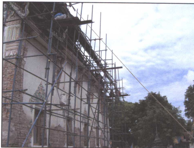
รูปภาพขณะติดตั้งนั่งร้าน
