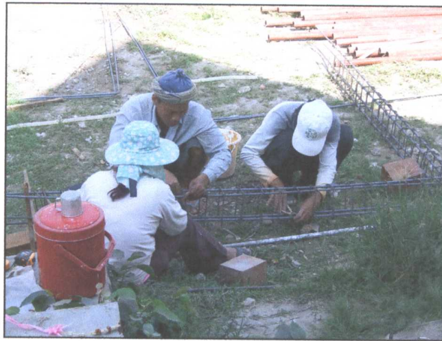
รูปภาพขณะดำเนินการผูกเหล็กคานรัดฐาน
