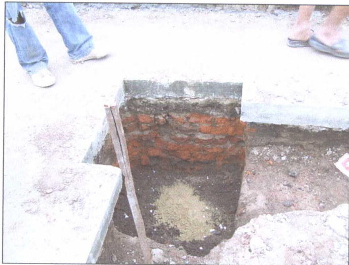
รูปภาพขณะดำเนินการเทขุดหลุมบ่อพัก
