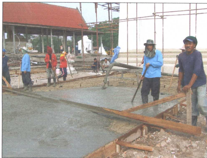
รูปภาพขณะดำเนินการเทคอนกรีตพื้น
