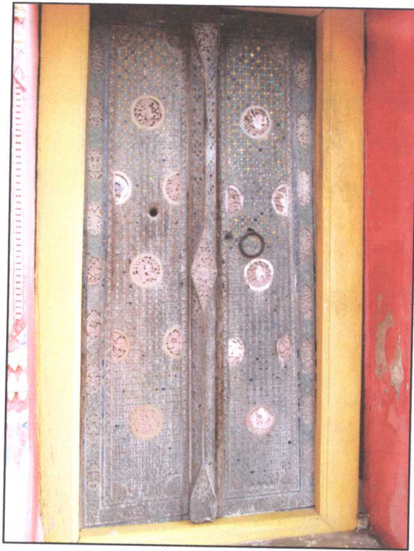
รูปภาพสภาพก่อนการบูรณะประตูโบสถ์
