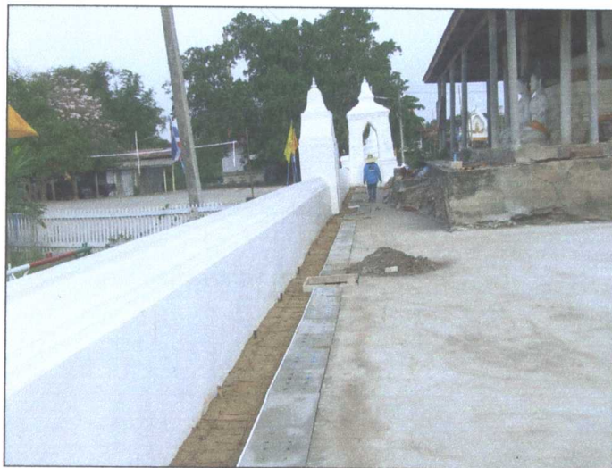
รูปภาพขณะดำเนินการติดตั้งฝารางระบายน้ำ
