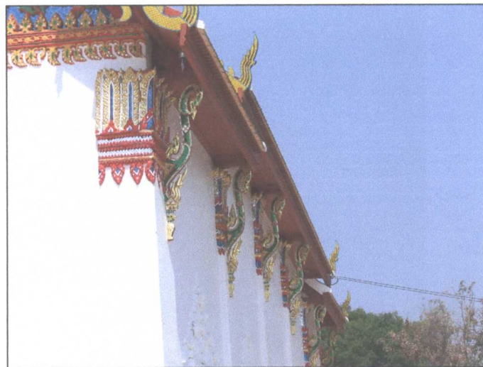
รูปภาพเมื่อดำเนินการติดตั้งแล้วเสร็จ
