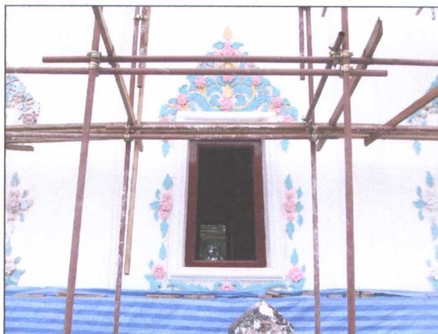
รูปภาพเมื่อดำเนินการซ่อมแซมแล้วเสร็จ
