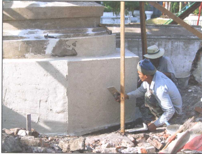
รูปภาพขณะดำเนินการฉาบปูนหมัก
