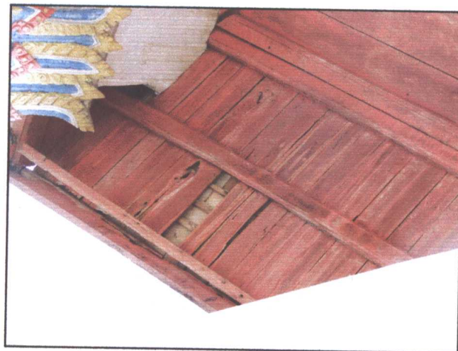
รูปภาพสภาพก่อนการบูรณะฝ้าเพดานภายนอก
