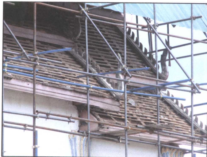
รูปภาพเมื่อรื้อถอนกระเบื้องแล้วเสร็จ
