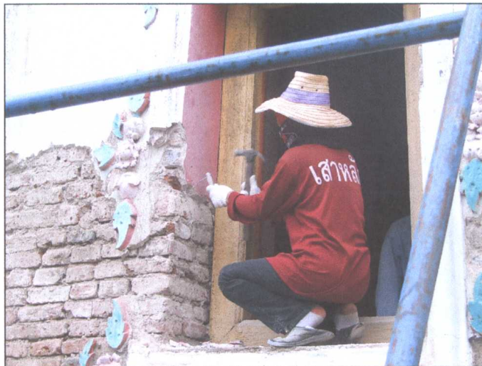
รูปภาพขณะดำเนินการซ่อมแซมผนัง
