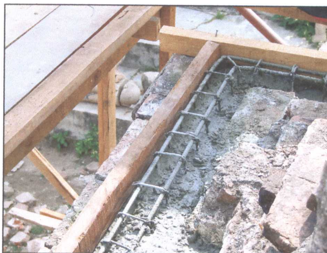
รูปภาพขณะดำเนินการเทคอนกรีตเสริมความมั่นคง
