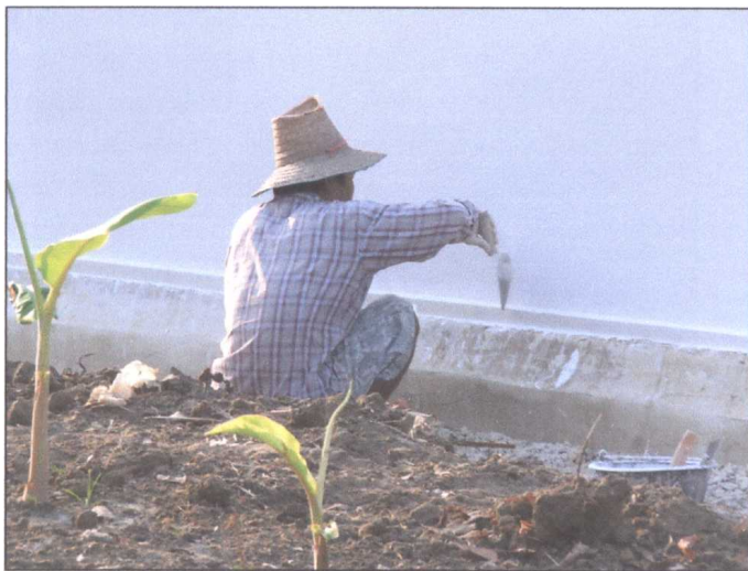
รูปภาพขณะดำเนินการขัดปูนดำ
