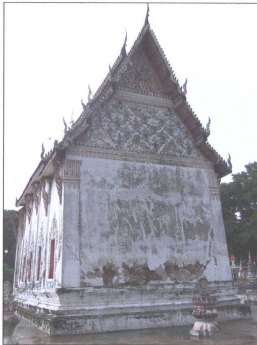
รูปภาพก่อนดำเนินการซ่อมแซมผนัง
