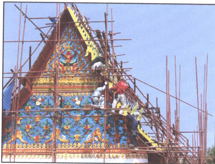
รูปภาพขณะดำเนินการติดตั้ง
