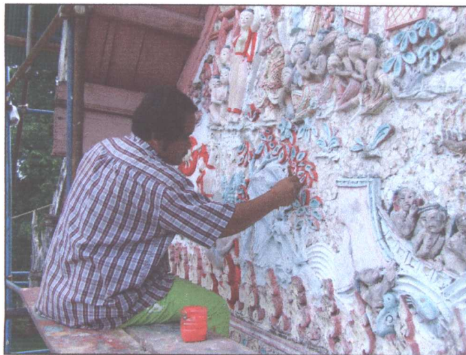
รูปภาพขณะดำเนินการปั้นเสริมลวดลาย
