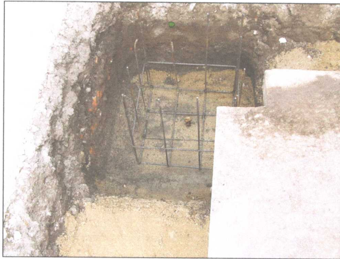
รูปภาพขณะดำเนินการเสริมเหล็กบ่อพัก
