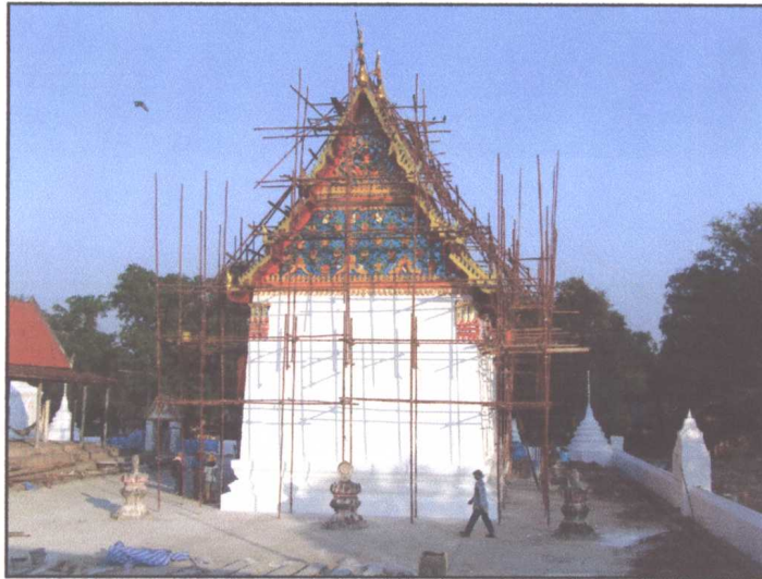
รูปภาพเมื่อดำเนินการติดตั้งเครื่องประดับหลังคาแล้วเสร็จ
