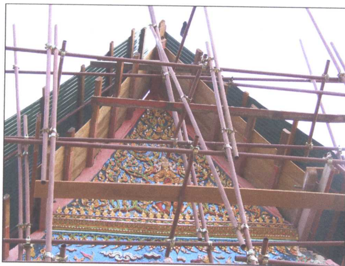
รูปภาพเมื่อดำเนินการทาน้ำยาเคลือบสีแล้วเสร็จ
