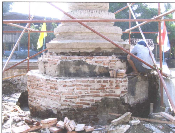
รูปภาพขณะดำเนินการก่ออิฐเสริมความมั่นคง
