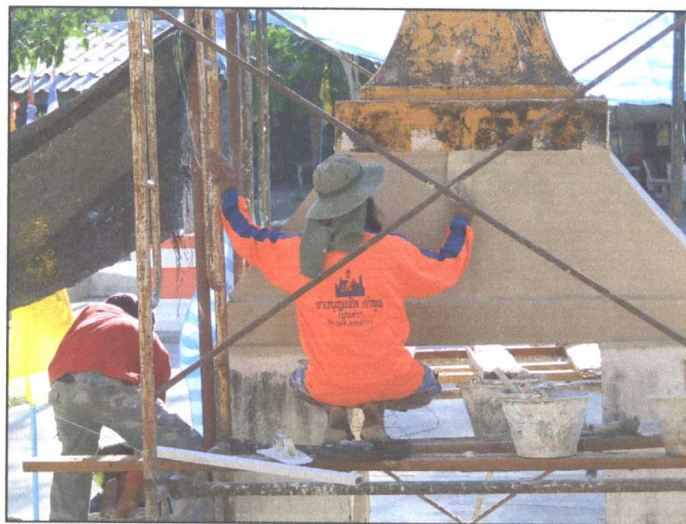
รูปภาพขณะดำเนินการฉาบปูนซุ้มประตู
