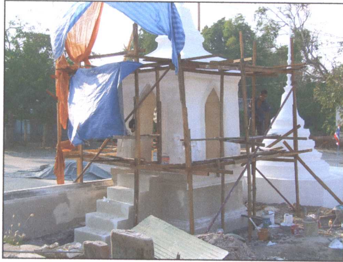
รูปภาพขณะดำเนินการซ่อมแซมบันได
