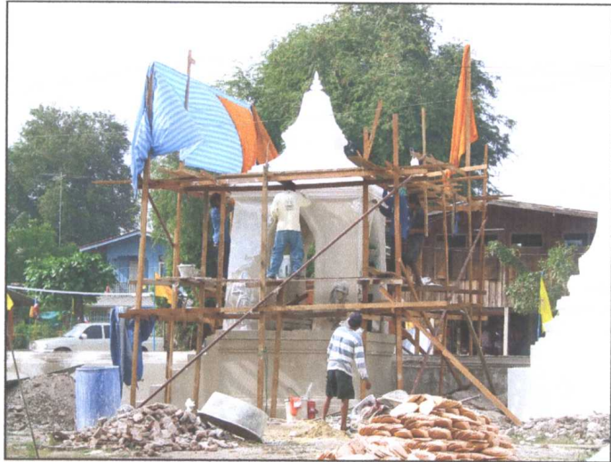
รูปภาพขณะดำเนินการขุดปูนดำ
