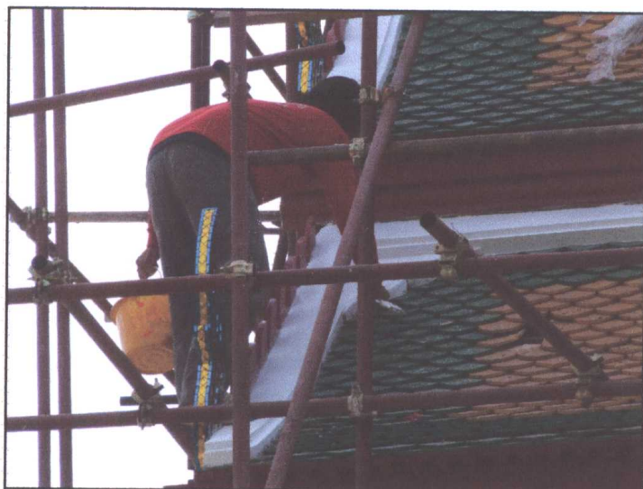
รูปภาพขณะดำเนินการจัดทำคอนกรีตหลบข้างกระเบื้อง
