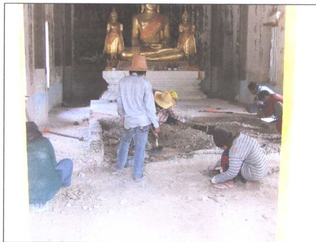
รูปภาพขณะดำเนินการรื้อถอนพื้นเดิม
