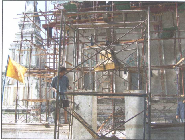
รูปภาพขณะดำเนินการรื้อถอนซุ้มประตู
