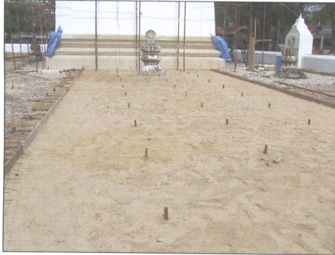
รูปภาพขณะดำเนินการจัดทำระดับพื้นใหม่
