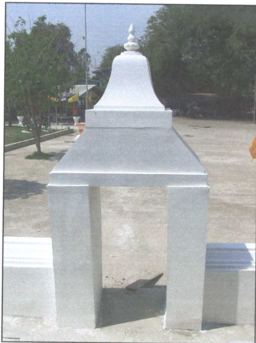
รูปภาพเมื่อดำเนินการบูรณะซุ้มประตูหมายเลข ๒ แล้วเสร็จ
