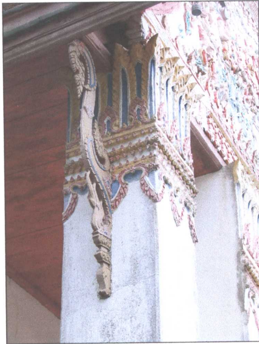
รูปภาพก่อนดำเนินการซ่อมแซมบัวหัวเสา
