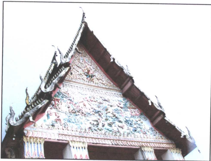
รูปภาพสภาพก่อนการบูรณะหน้าบันด้านหน้าโบสถ์
