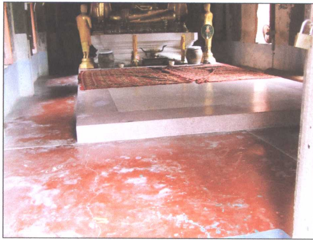
รูปภาพก่อนดำเนินการซ่อมแซมพื้นภายใน
