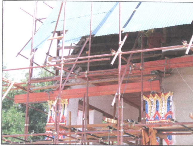
รูปภาพขณะดำเนินการติดตั้งเชิงชายไม้
