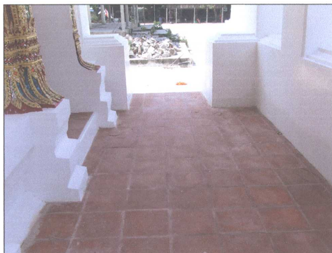
รูปภาพเมื่อดำเนินการปูพื้นแล้วเสร็จ
