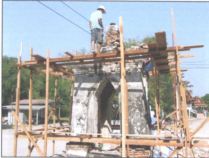
รูปภาพขณะดำเนินการติดตั้งนั่งร้าน
