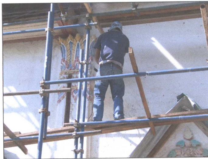
รูปภาพขณะดำเนินการสกัดปูนที่เสื่อมสภาพ
