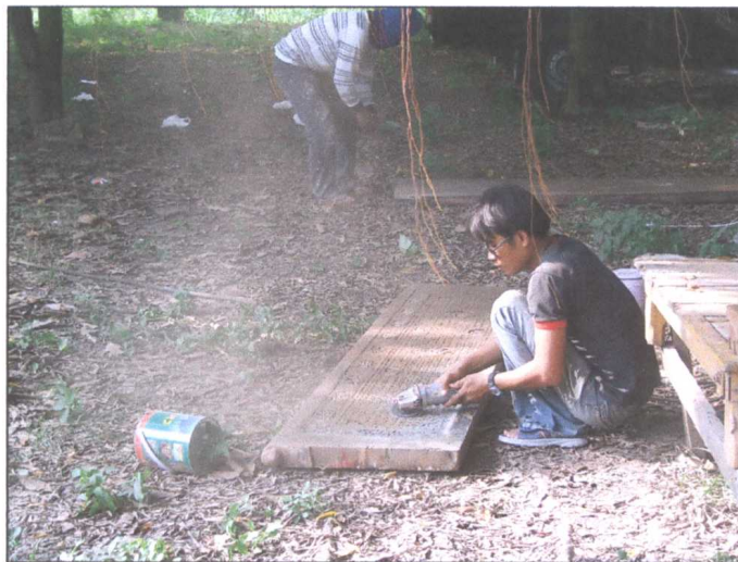
รูปภาพขณะดำเนินการซ่อมแซมประตู-หน้าต่าง
