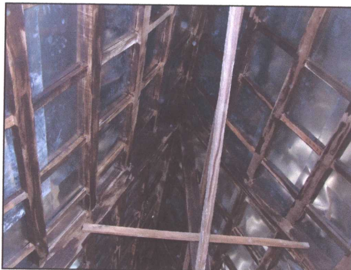
รูปภาพขณะดำเนินการติดตั้งสังกะสี เบอร์ ๒๘
