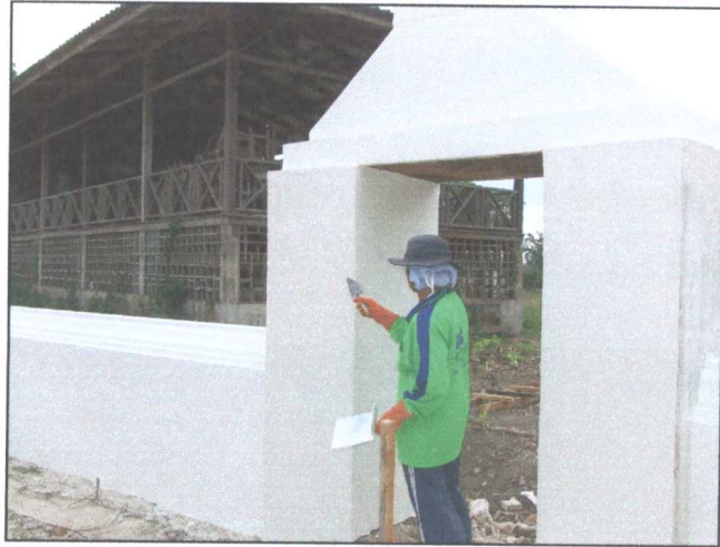
รูปภาพขณะดำเนินการขุดปูนดำชุ้มประตู
