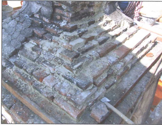
รูปภาพขณะดำเนินการก่ออิฐเสริมในส่วนที่ชำรุด
