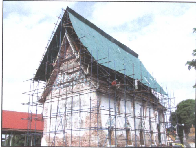
รูปภาพขณะสร้างหลังคาคลุม
