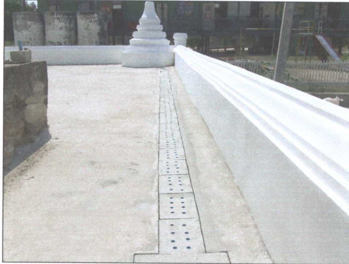
รูปภาพเมื่อดำเนินการก่อสร้างรางระบายน้ำแล้วเสร็จ
