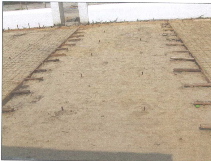
รูปภาพขณะดำเนินการบดอัดทราย
