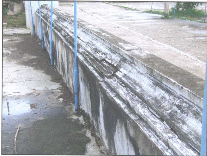
รูปภาพขณะดำเนินการทำความสะอาดกำแพงแก้ว
