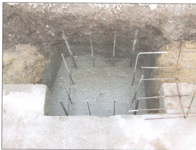
รูปภาพขณะดำเนินการเทคอนกรีตพื้นบ่อพัก
