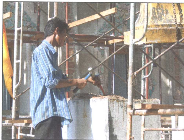
รูปภาพขณะดำเนินการกะเทาะผิวปูนฉาบและอิฐที่ชำรุดออก
