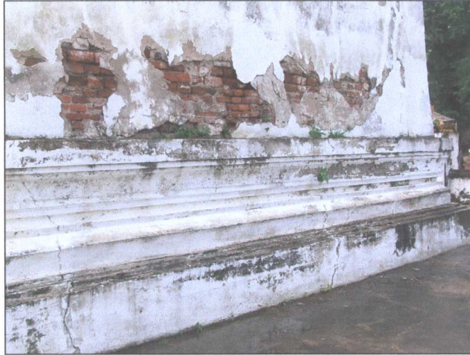
รูปภาพก่อนดำเนินการซ่อมแซมผนัง
