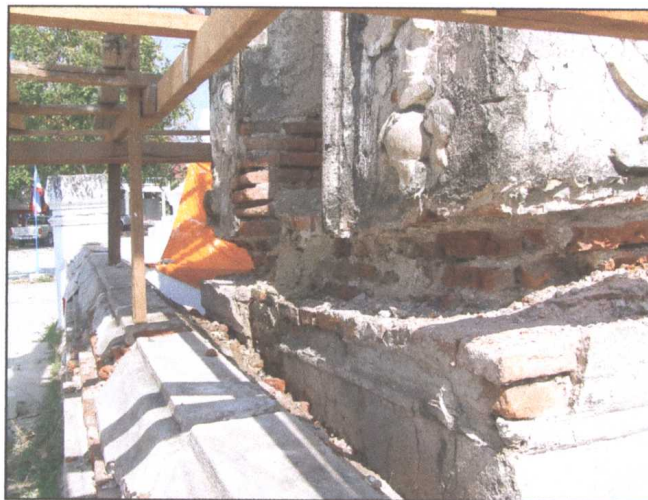
รูปภาพขณะดำเนินการสกัดผนังเพื่อเทคานคองกรีตเสริมความมั่นคง
