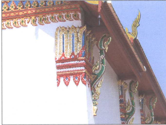
รูปภาพเมื่อดำเนินการซ่อมแซมแล้วเสร็จ
