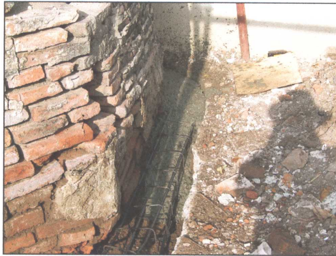
รูปภาพขณะดำเนินการเทคานคอนกรีตเสริมความมั่นคง
