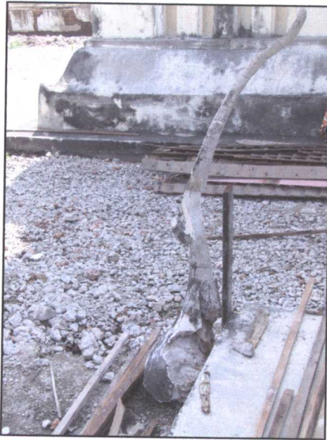
รูปภาพเมื่อรื้อถอนเครื่องประดับหลังคา
