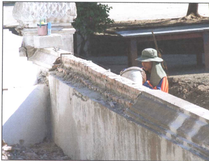
รูปภาพขณะดำเนินการก่ออิฐซ่อมแซมส่วนที่ชำรุด
