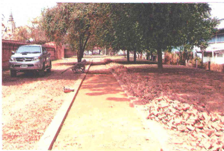
ภาพที่ ๒๑ การปรับปรุงพื้นทางเท้าเดิม
