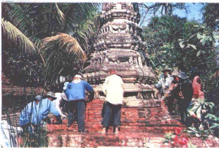
ภาพที่ ๑๗ - ๑๘ การขุดล้างทำความสะอาดผิวโบราณสถาน
