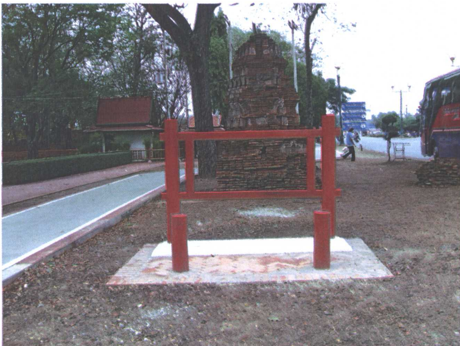
ภาพที่ ๓๒ การก่อสร้างป้ายชื่อโบราณสถานด้านหน้าวัด
