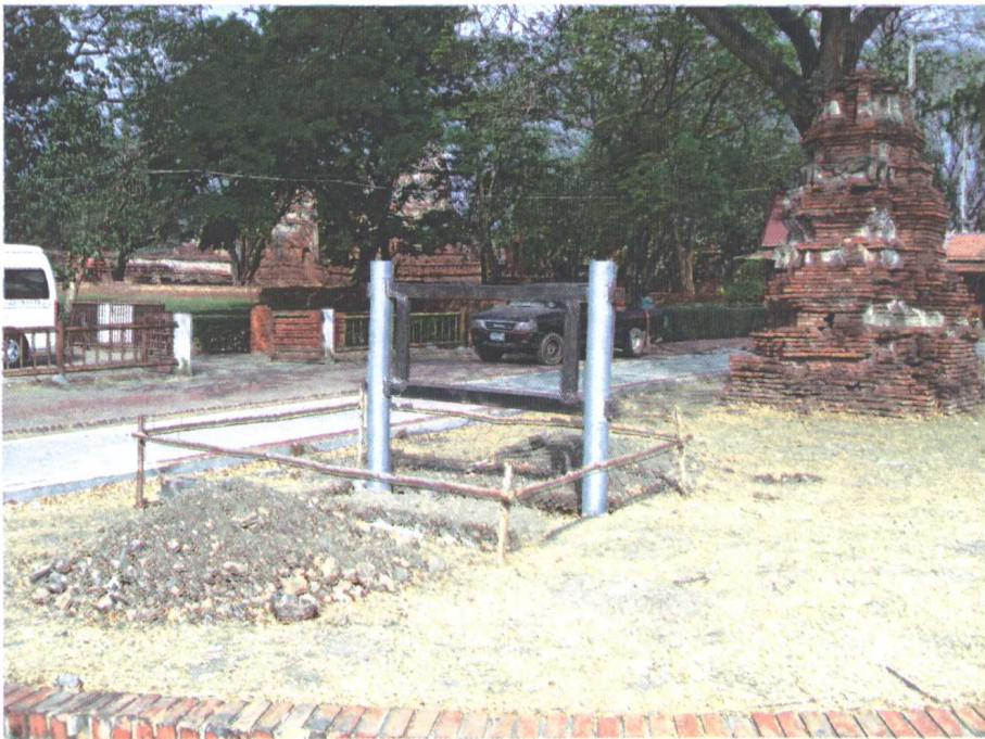
ภาพที่ ๓๐ การก่อสร้างป้ายชื่อโบราณสถานด้านหน้าวัด
