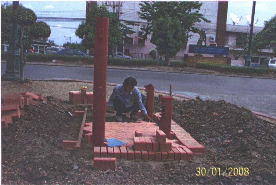
ภาพที่ ๓๑ การก่อสร้างป้ายชื่อโบราณสถานด้านหน้าวัด
