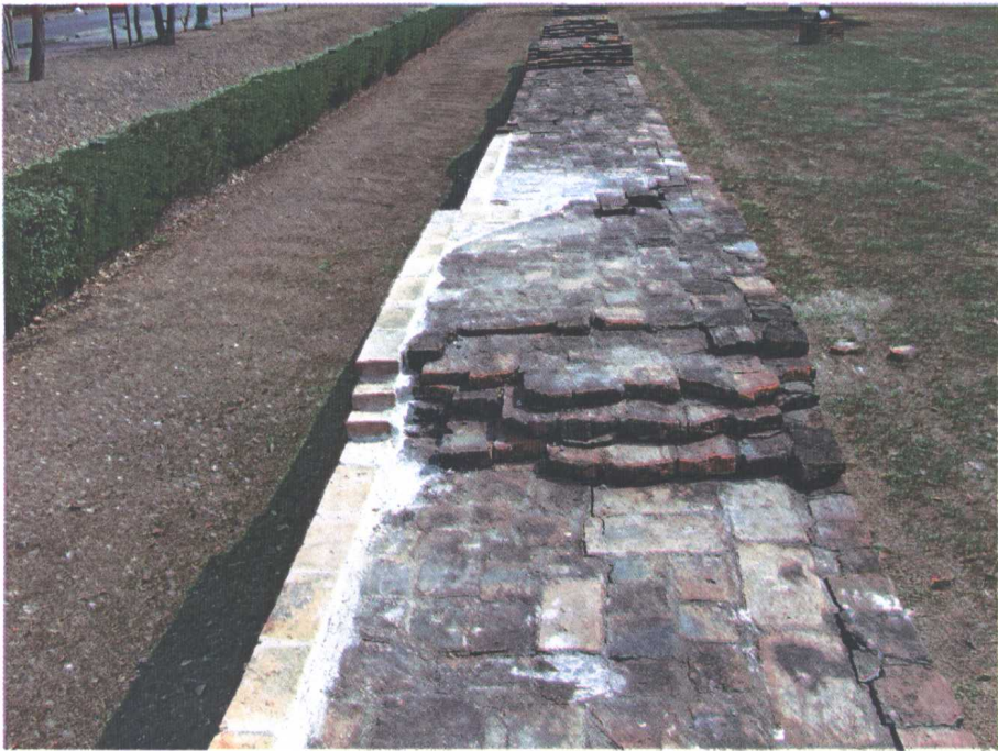
ภาพที่ ๔๐ สภาพโบราณสถานหลังการก่ออิฐซ่อมแซม
