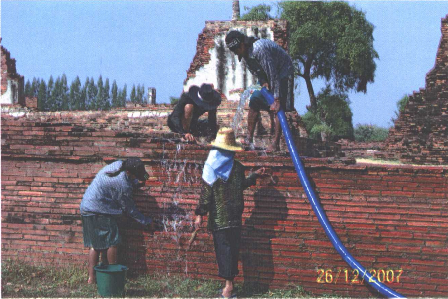
ภาพที่ ๑๕ การขัดล้างทำความสะอาดผิวโบราณสถาน
