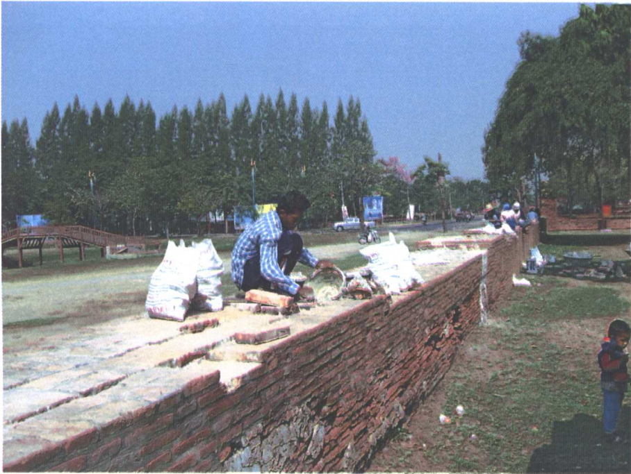
ภาพที่ ๒๑ การก่ออิฐซ่อมแซมบริเวณกำแพงวัดทางด้านทิศตะวันตกเฉียงเหนือ
