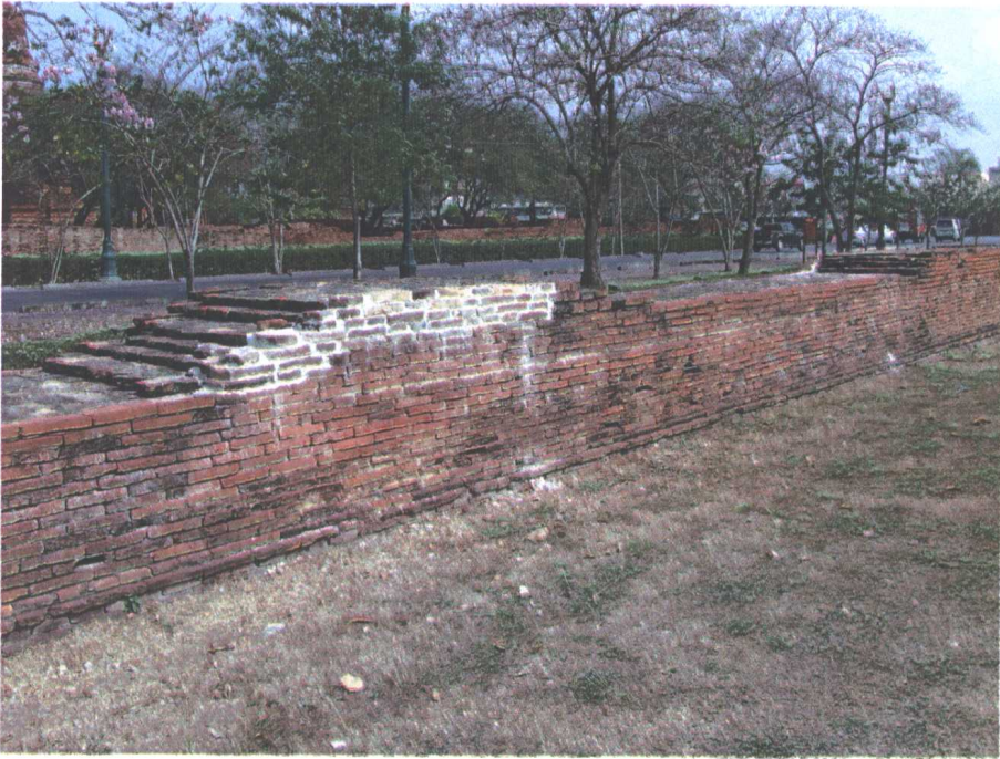
ภาพที่ ๔๑ สภาพโบราณสถานหลังการก่ออิฐซ่อมแซม
