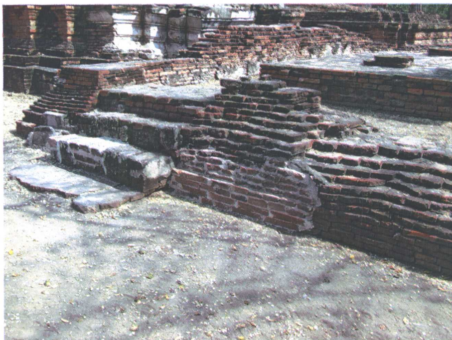
ภาพที่ ๔๔ สภาพโบราณสถานหลังการก่ออิฐซ่อมแซม
