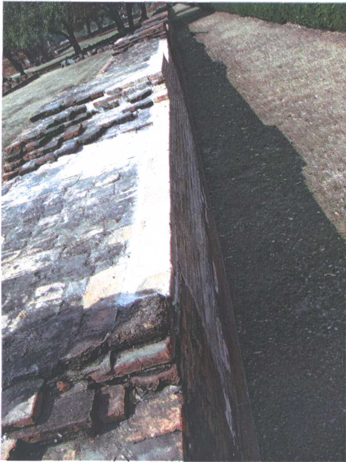
ภาพที่ ๔๒ สภาพโบราณสถานหลังการก่ออิฐซ่อมแซม
