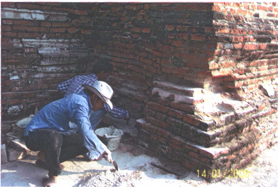
ภาพที่ ๒๒ การก่ออิฐซ่อมแซมบริเวณฐานเจดีย์
