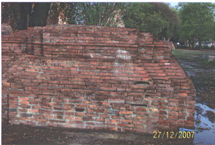
ภาพที่ ๓๕ สภาพโบราณสถานหลังการขุดล้างทำความสะอาดผิว
