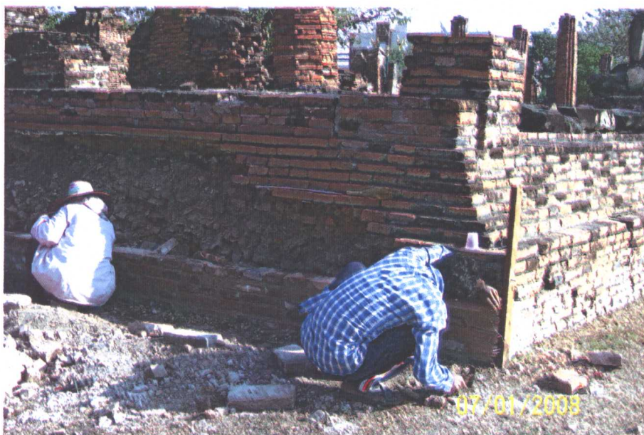
ภาพที่ ๑๙ การก่ออิฐซ่อมแซมบริเวณกำแพงวัดทางด้านทิศเหนือ
