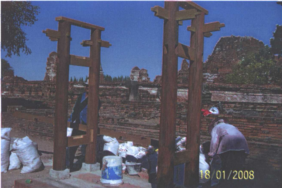
ภาพที่ ๒๖ การก่อสร้างซุ้มป้ายบรรยายโบราณสถาน
