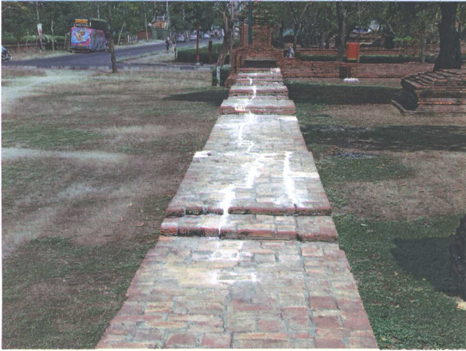
ภาพที่ ๓๙ สภาพโบราณสถานหลังการก่ออิฐซ่อมแซม
