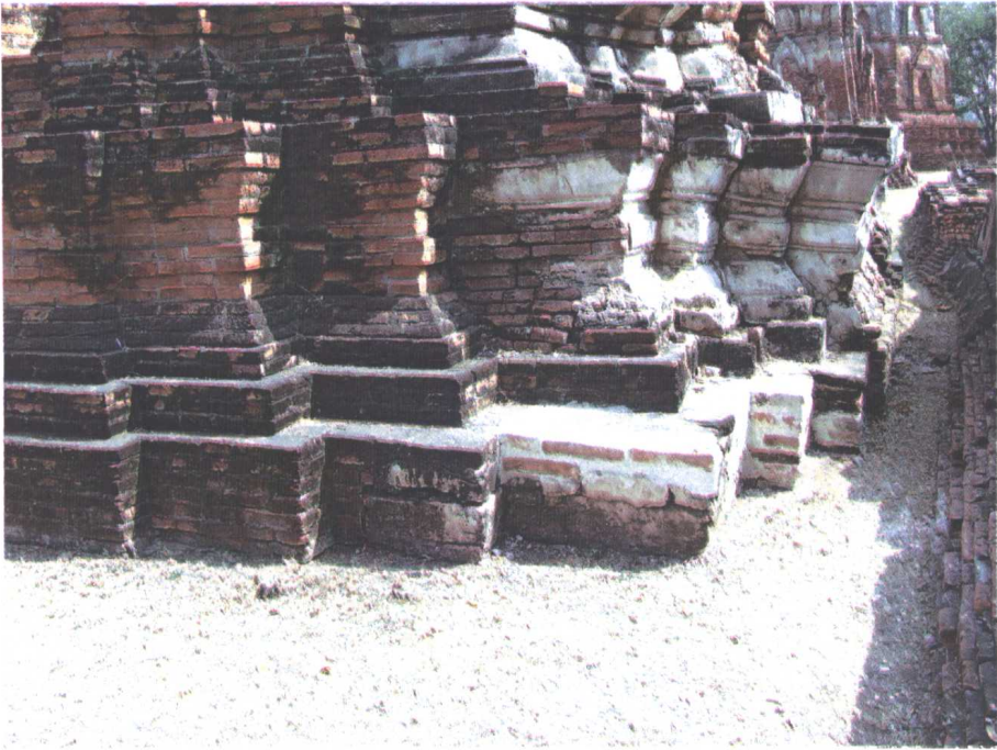
ภาพที่ ๔๕ สภาพโบราณสถานหลังการก่ออิฐซ่อมแซม
