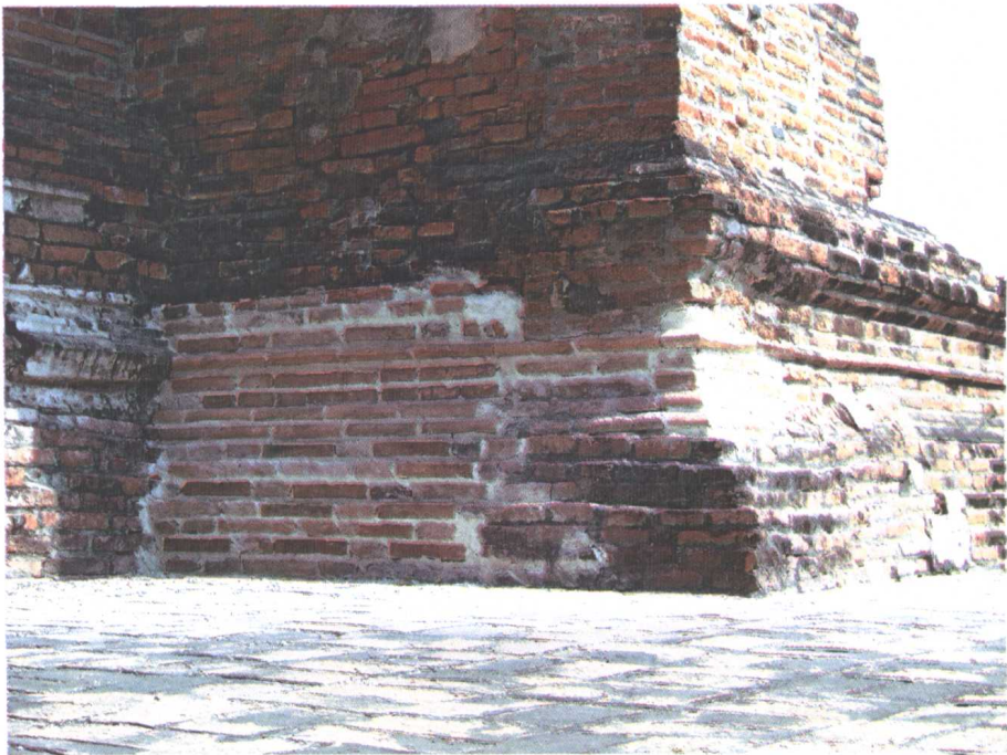
ภาพที่ ๔๖ สภาพโบราณสถานหลังการก่ออิฐซ่อมแซม
