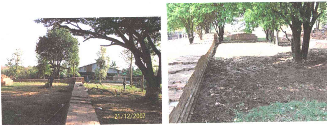
ขณะทำการรื้อถอนต้นหญ้า, ไม้พุ่มและไม้ยืนต้นที่บดบังทัศนียภาพ ไถปรับพื้นที่เพื่อปรับปรุงดิน และปลูกหญ้าธรรมชาติ
