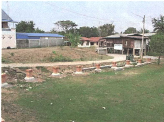
ภายหลังการก่อสร้างรั้วเสาหลักก่ออิฐราวเหล็กสองชั้นและรั้วเสาหลักก่ออิฐเดี่ยวเสร็จ
