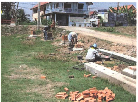
ขณะทำการก่อสร้างรั้วเสาหลักก่ออิฐราวเหล็กสองชั้นและรั้วเสาหลักก่ออิฐ
