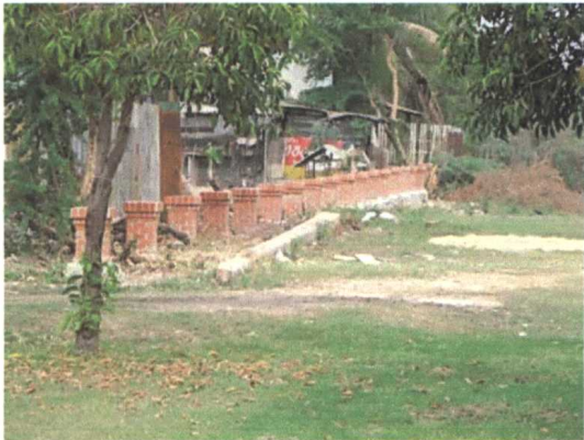
ภายหลังการก่อสร้างรั้วเสาหลักก่ออิฐราวเหล็กสองชั้นและรั้วเสาหลักก่ออิฐเดี่ยวเสร็จ
