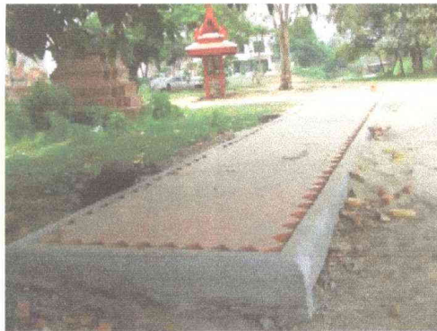
ขณะดำเนินการสร้างงานป้ายและก่อสร้างพื้นทางเดิน
