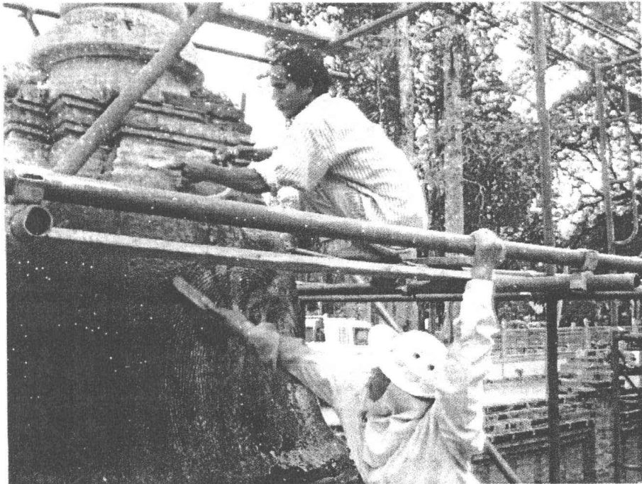
ภาพที่ 146 การทำความสะอาดผิวปูนฉาบเจดีย์รายหมายเลข 1
