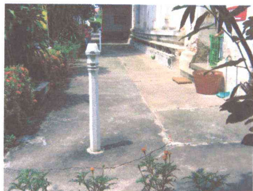
ภาพที่ ๔ วิหารด้านทิศใต้ สภาพก่อนขุดแต่ง
