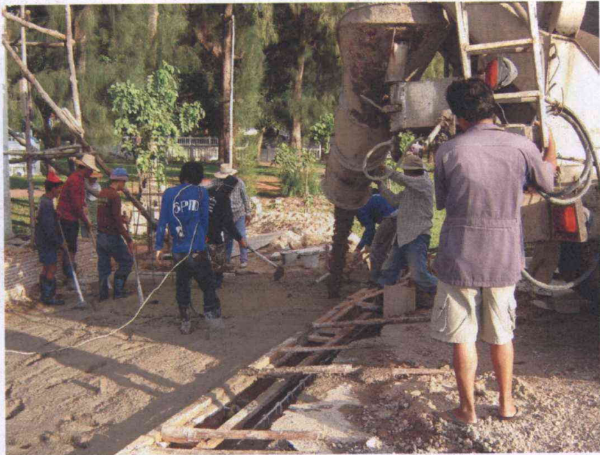
เท คอนกรีตเข้าแบบหล่อ
