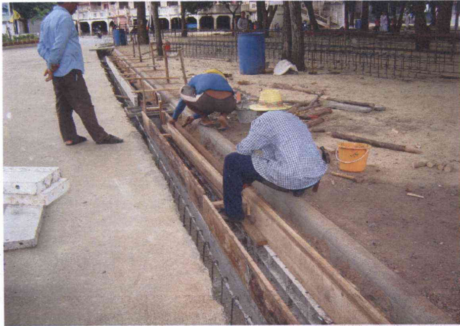
งานวางแบบเพื่อรอเท คอนกรีต ทำร่องรางระบายน้ำ
