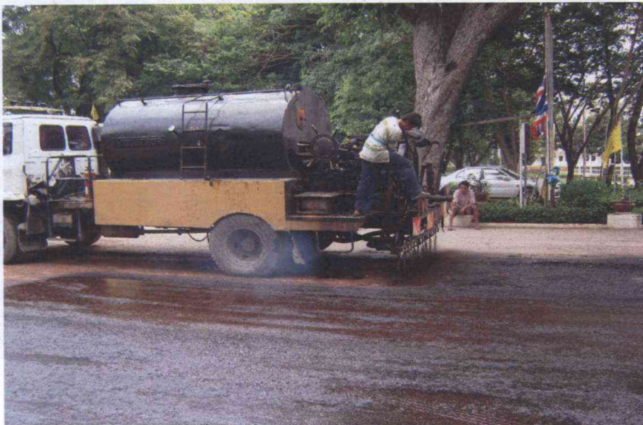
งานลาดยางพื้นถนน
