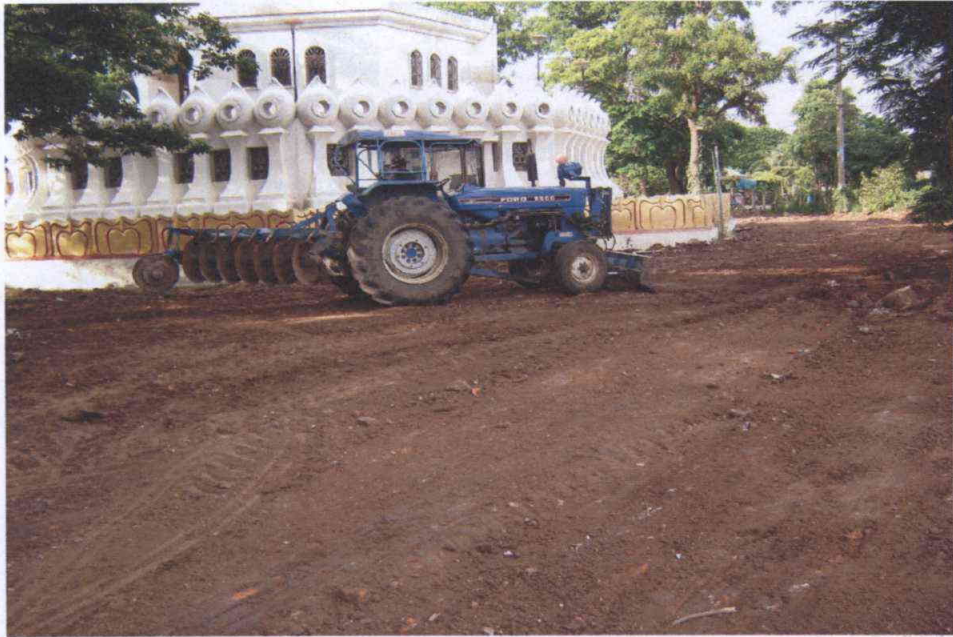
ปรับหน้าดินบริเวณด้านหลังพระอุโบสถ
