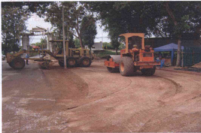
งานปรับหน้าดิน บดอัด ด้วยเครื่องจักรหนัก
