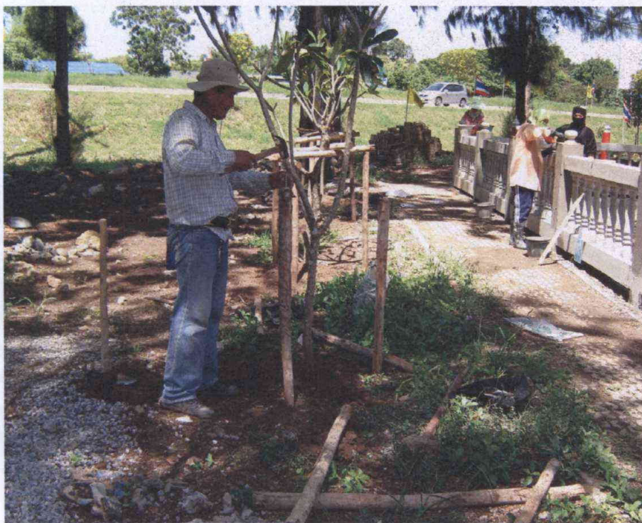
งานทำคอกไม้ค้ำยันต้นไม้ขณะทำการปลูก
