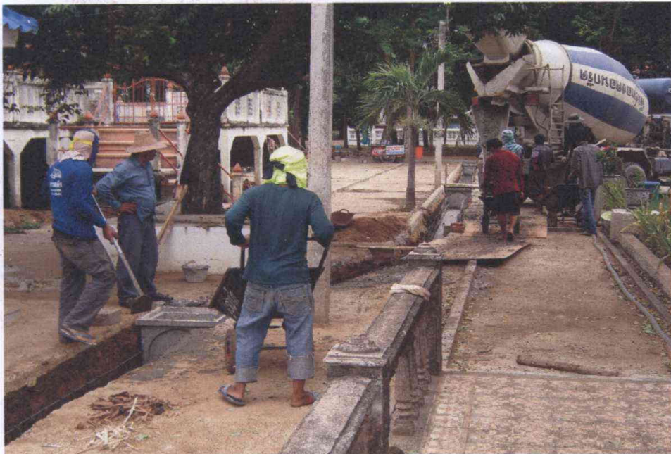
งานทำการเท คอนกรีต ตัวรางระบายน้ำ
