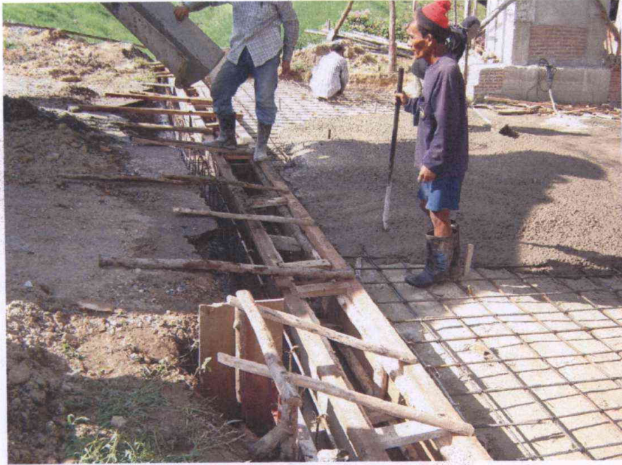
ทำแบบหล่อ รางระบายน้ำพร้อมเทคอนกรีต
