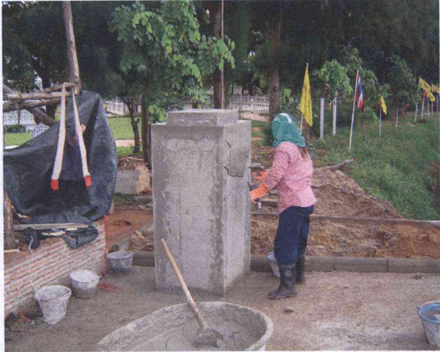
งานทำเสา คสล. ด้านหน้าซุ้มประตูทางเข้า
