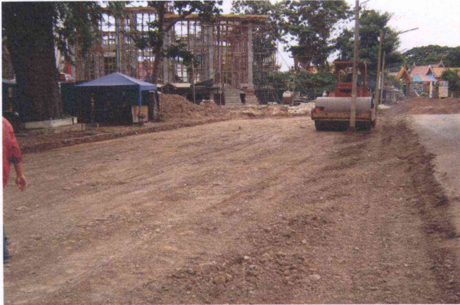
งานใช้เครื่องจักรหนักในการบดอัดดิน
