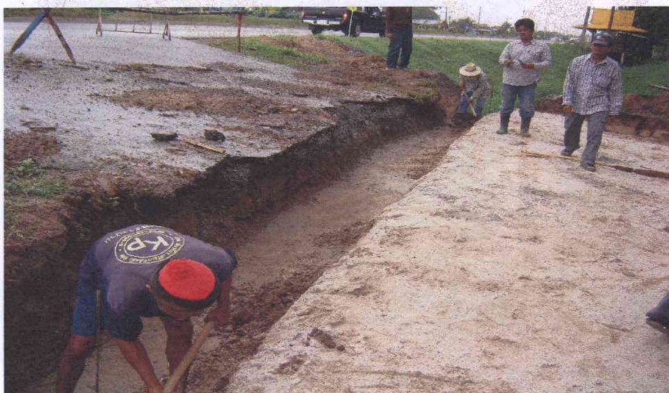
ทำการขุดร่อง เพื่อวางรางระบายน้ำ คสล.
