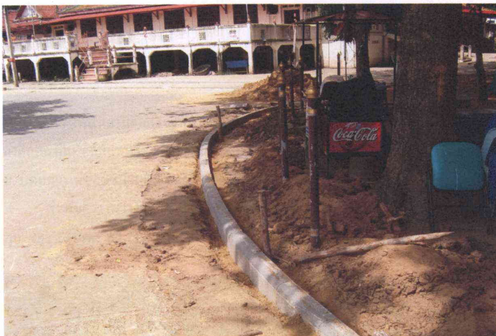
งานวางแนวขอบคั่นหิน คสล. ด้านติดถนนทางเข้าวัด
