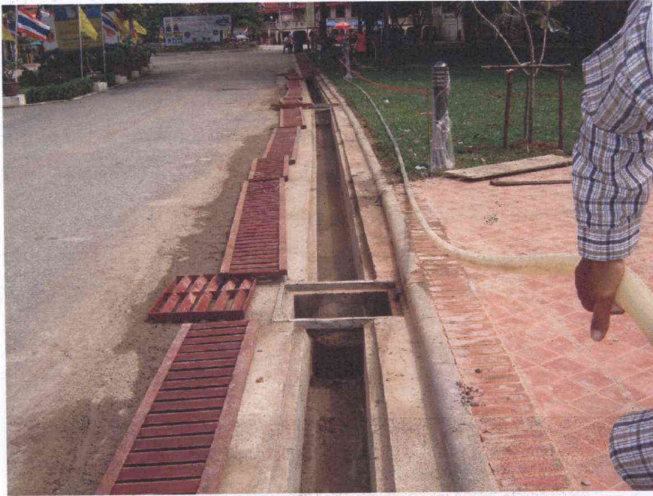
สภาพรางระบายน้ำ คสล. ที่เสร็จเรณีย์พร้อมฝาตะแกรงเหล็กกราง
