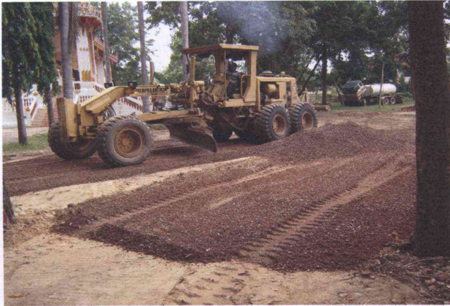
งานถมพื้นหน้าดินด้วยหินคลุกและปรับสภาพผิวด้วยเครื่องจักรหนัก
