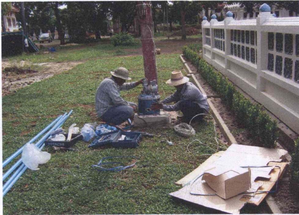
ทำการติดตั้งปั้มน้ำแรงดันเพื่อช่วยให้หัวจ่ายน้ำทำงาน
