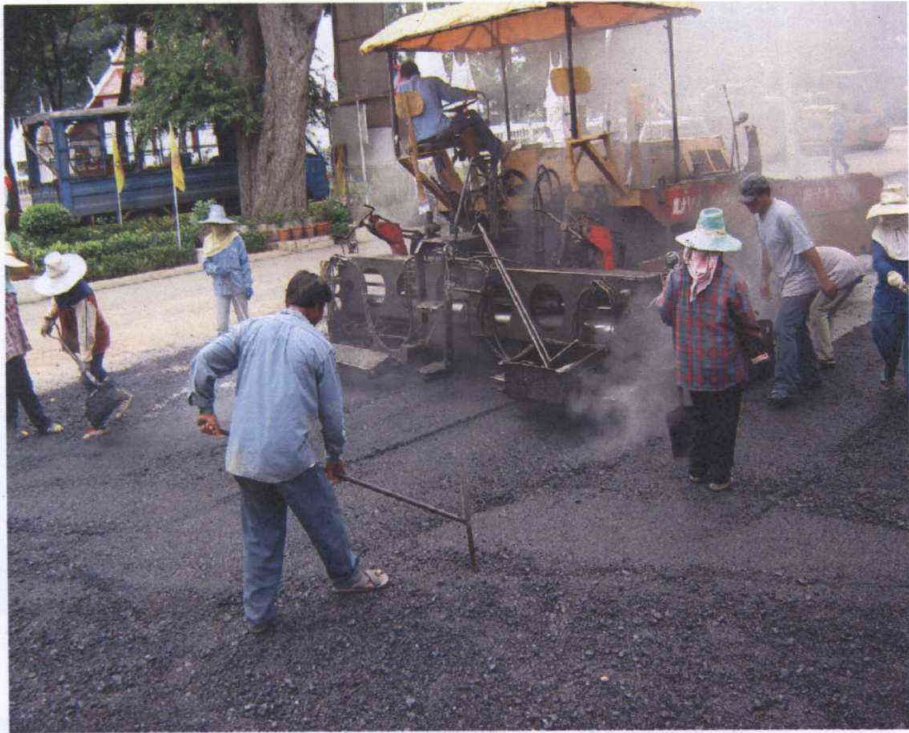
งานทำการลาดพื้นผิวแอสฟัลท์ติก ตาม spec ที่กำหนด
