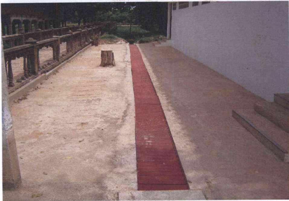
สภาพของราง คสล. พร้อมฝารางเหล็กที่เสร็จสมบูรณ์
