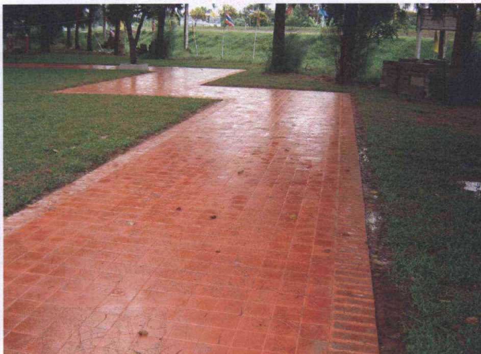
สภาพงานปูกระเบื้องทางเดินขอบอิฐ บปท. ใหญ่ เมื่อเสร็จเรียบร้อย
