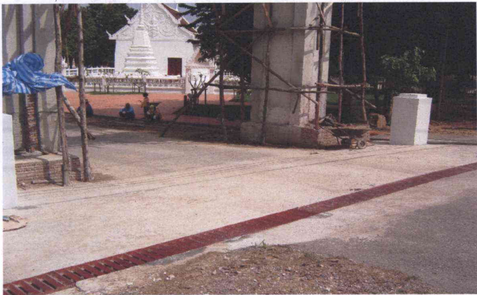
สภาพงานเมื่อเสร็จสมบูรณ์
