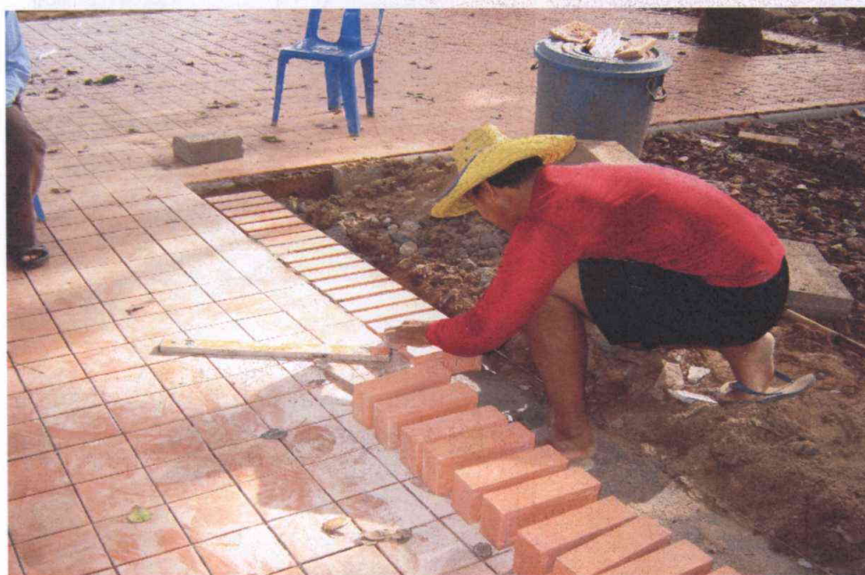
งานวางแนว จัดเรียงขอบคั่นทางเท้า ด้วยอิฐ บปก ใหญ่
