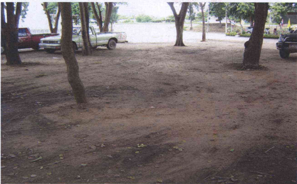
ปรับพื้นที่ด้านลานจอดรถ
