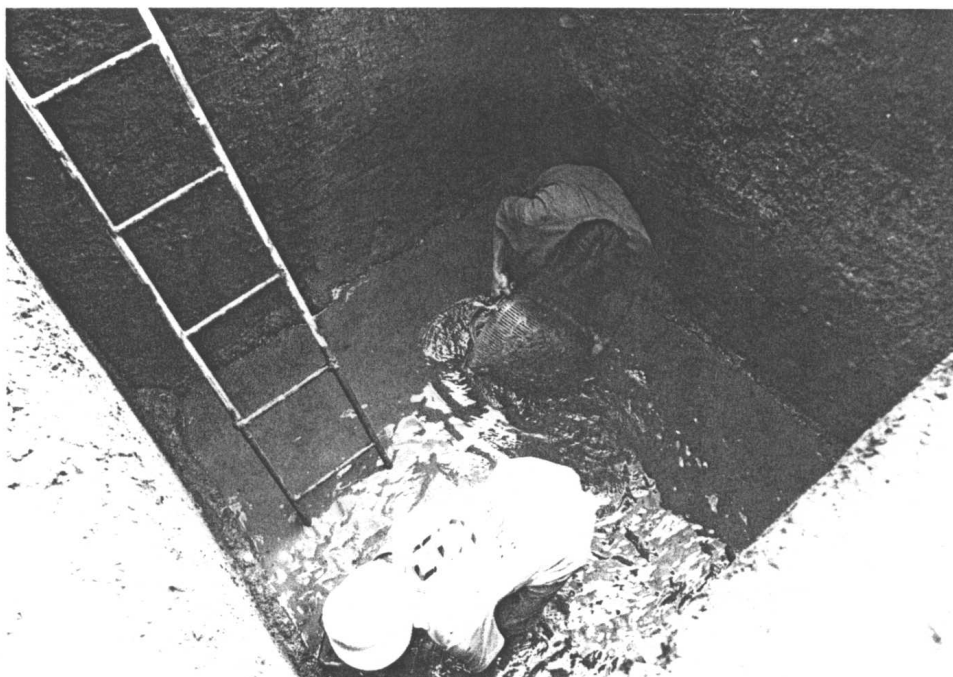
ภาพถ่ายที่ 9 ขณะปฏิบัติงานสูบน้ำออกจากหลุม เพื่อทำการขุดค้น (ฟิล์ม 14/35)
