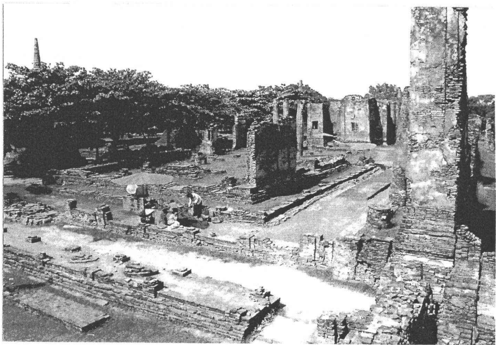
ภาพที่ 36 สภาพขณะทำการขุดแต่งวิหารพระโลกนาถ
