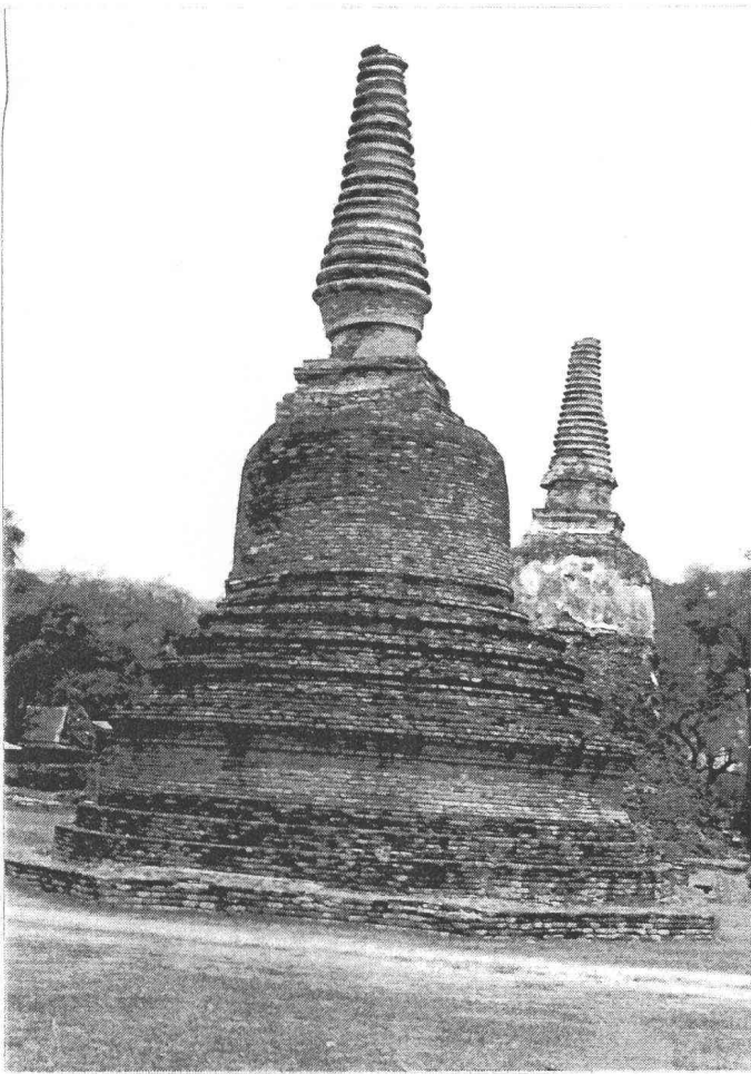
ภาพที่ 109 สภาพก่อนการขุดแต่งเจดีย์ราย
