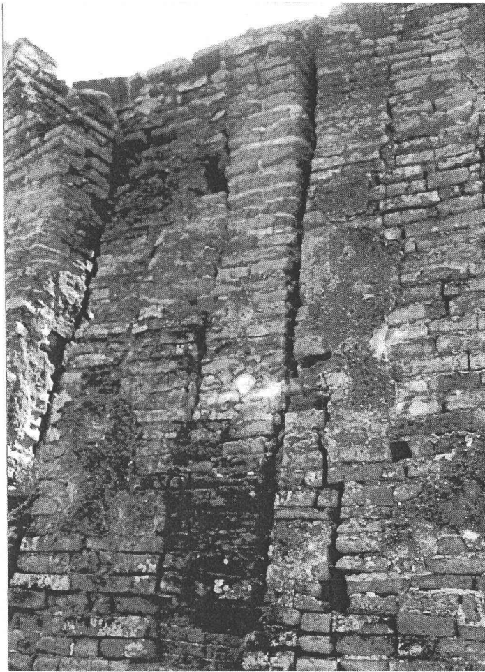
ภาพที่ 35 การบูรณะ โดยมีการก่ออิฐปิดช่อง แสงบางช่องของผนังวิหารพระโลกนาถ
