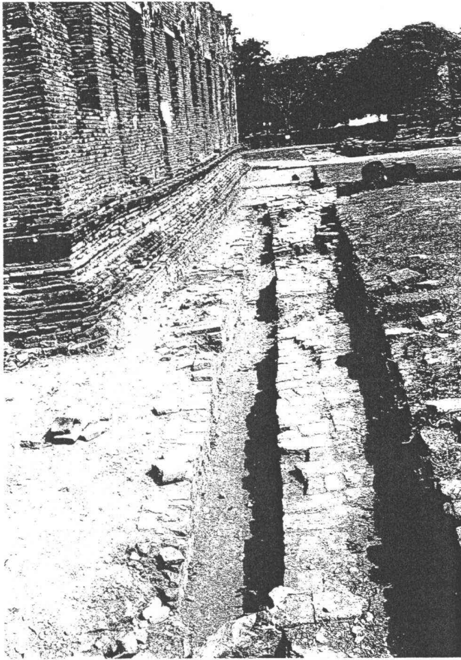
ภาพที่ 53 สภาพภายหลังการขุดแต่ง ฐานอาคารด้านทิศใต้พระที่นั่งจอมทอง ซึ่งติดกับเชิงด้านหน้าวิหารหลวง
