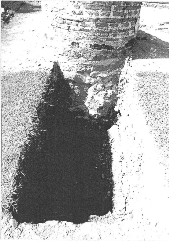
ภาพที่ 31 หลุมขุดตรวจฐานรากที่ฐานเสา ต้นกึ่งกลางภายในวิหาร ซึ่งพบว่ามีการใช้ ศิลาแลงมาก่อนเป็นฐานต่อม่อของเสาอาคาร
