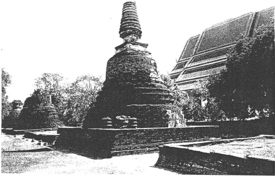
ภาพที่ 71 สภาพภายหลังการขุดแต่งด้านทิศตะวันตกเฉียงใต้ของเจดีย์หมายเลข 30
