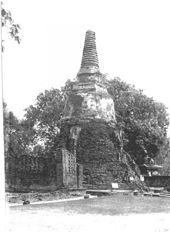
ภาพที่ 104 สภาพภายหลังการขุดแต่งด้านทิศ ตะวันตกเฉียงใต้ของเจดีย์หมายเลข 64 (เจดีย์ประจํามุมตะวันออกเฉียงเหนือ)
