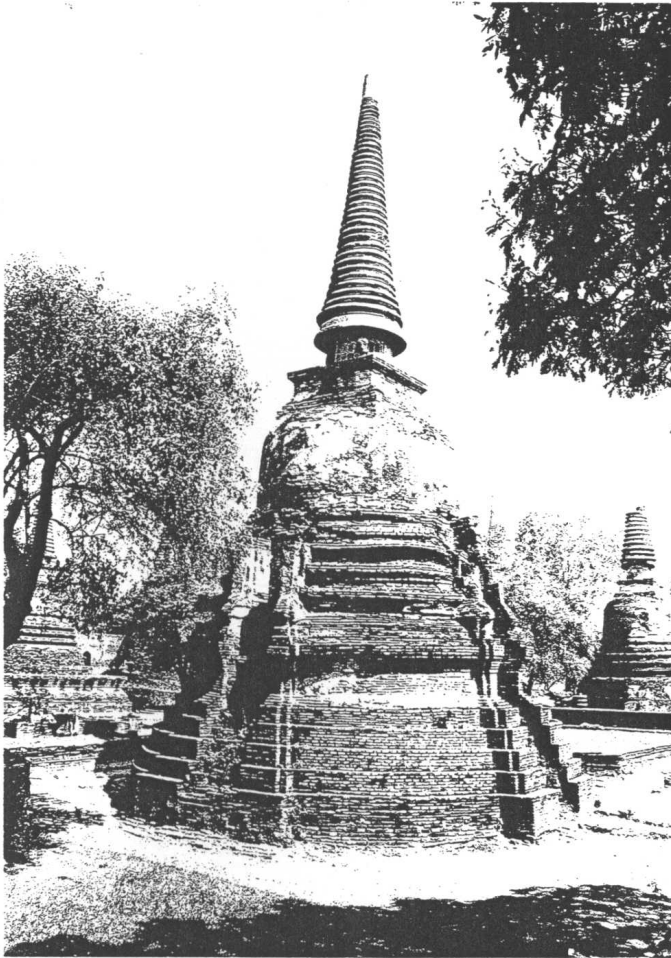
ภาพที่ 75 สภาพภายหลังการขุดแต่งด้าน ทิศตะวันออกเฉียงใต้เจดีย์หมายเลข 32
