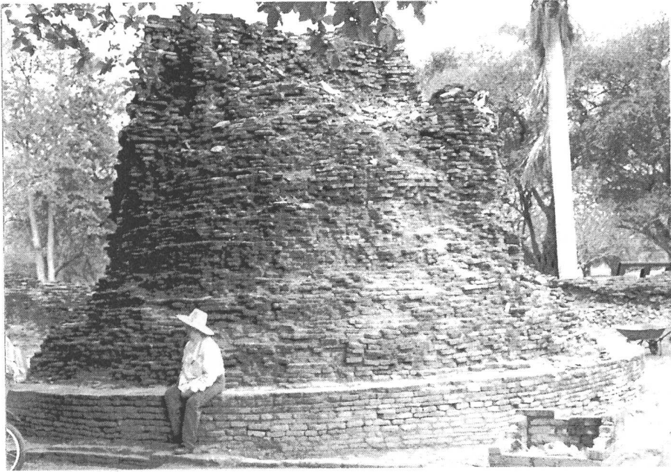
ภาพที่ 97 สภาพภายหลังการขุดแต่งด้านทิศใต้ของเจดีย์รายนหมายเลข 62
