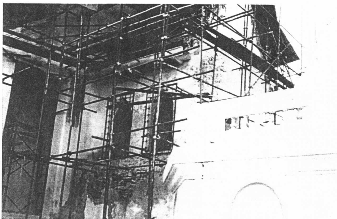
ด้านหลังพระวิหาร วัดบรมวงศอิศรารามวรวิหาร เริ่มติดตั้งนั่งร้านเหล็กเพื่อเตรียมงานซ่อมแซมผนังและโครงหลังคา
