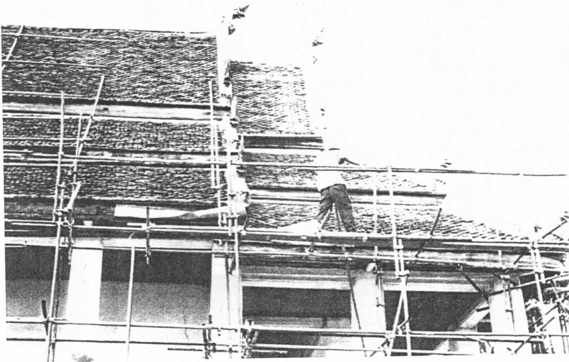
สภาพทั่วไปของหลังคาพระวิหาร ก่อนการดำเนินงานบูรณะซ่อมแซม
