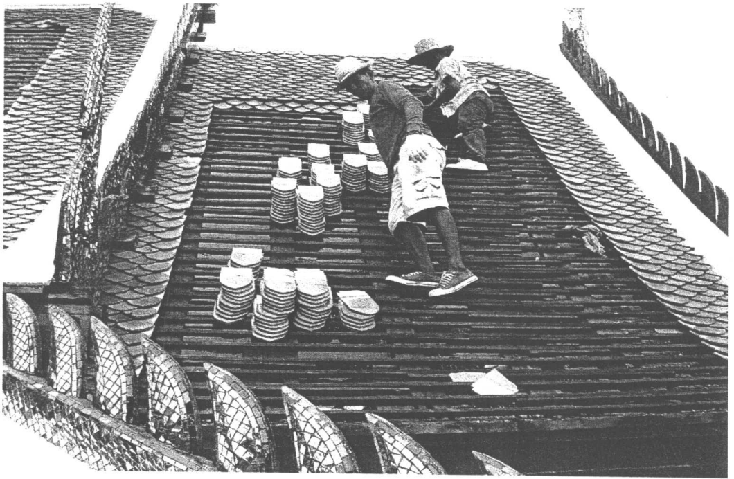
ภาพที่ 35 แสดงภาพการติดตั้งกระเบื้องดินเผาของเดิมและของใหม่เพิ่มเติม
