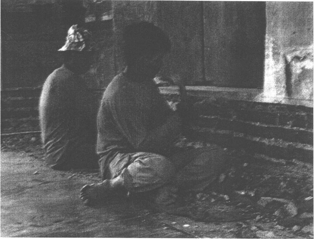
ภาพที่ 7 แสดงการสกัดผิวผนังเดิม เพื่อเปิดเนื้ออิฐและปูนภายใน ระดับความสูง 0.30 ม.
