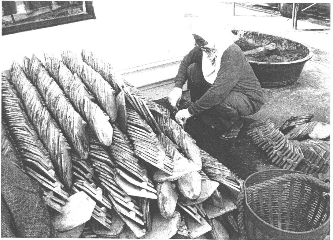
ภาพที่ 28 แสดงภาพการนำกระเบื้องของเดิมมาเรียงก่อนนำไปชุบซิลิโคนใส
