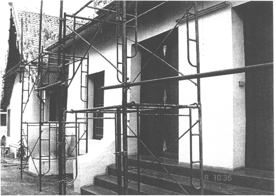
ภาพที่ 15 แสดงภาพการตั้งนั่งร้านด้านข้างอาคาร
