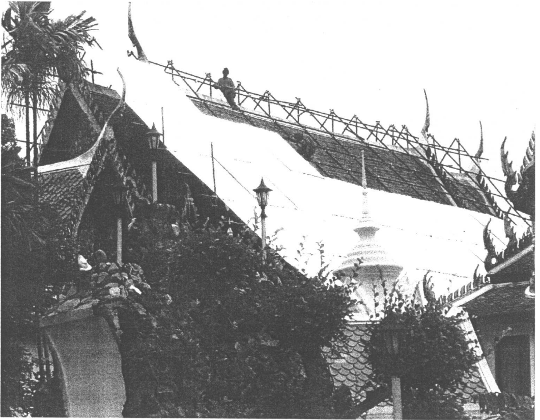
ภาพที่ 20 แสดงภาพการติดตั้งนั่งร้านและหลังคาคลุม
