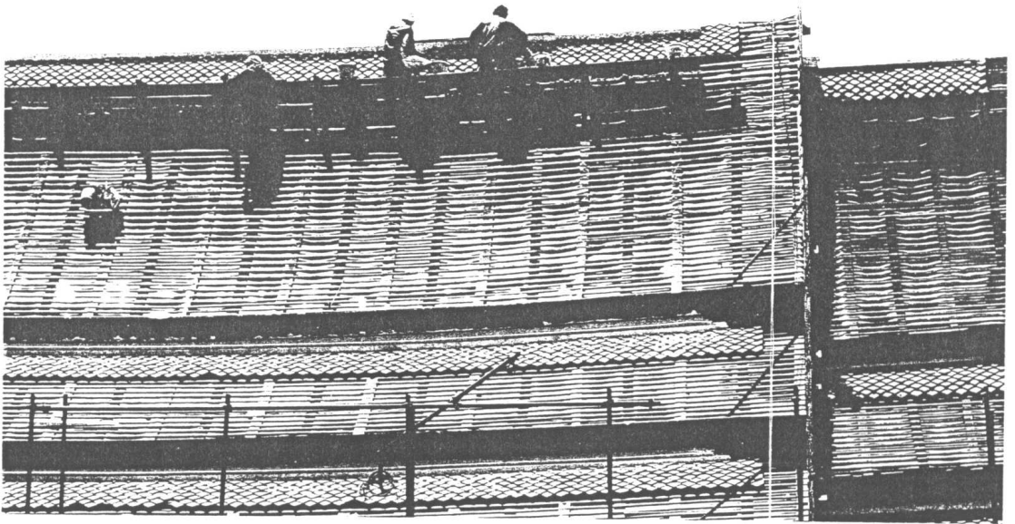
ภาพที่ 27 ทำปูนปั้นทับสันหลังคา
