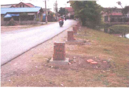
ภาพที่ 71 เสาหลักก่ออิฐ หลังการบูรณะ ทะเบียนภาพถ่าย: วัดหิंसดาวาส - 190
