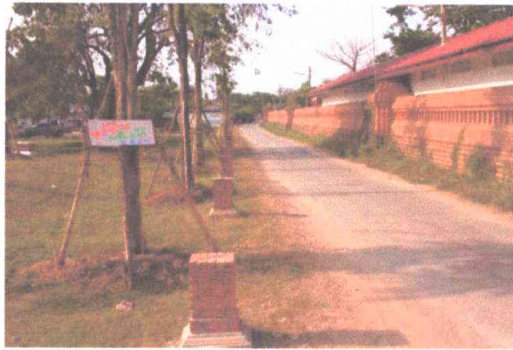
ภาพที่ 72 เสาหลักก่ออิฐ หลังการบูรณะ ทะเบียนภาพถ่าย: วัดหิंसดาวาส - 390
