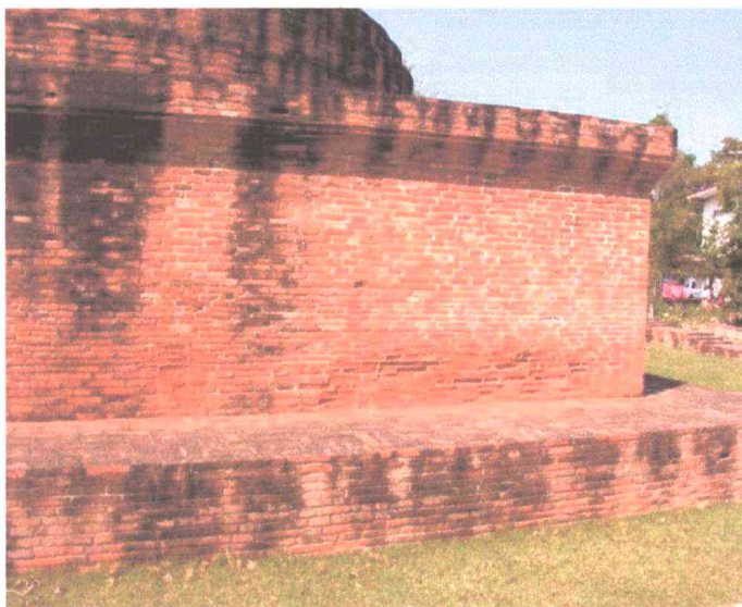
ภาพที่ 17 ฐานเชิงของเจดีย์ฐานสี่เหลี่ยม ทรงสูง ด้านทิศเหนือ ก่อนดำเนินการบูรณะฯ ทะเบียนภาพถ่าย : หัสดาวาส - 011
