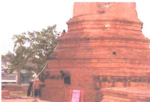
ภาพที่ 34 ดำเนินการขัดล้างโบราณสถาน ทะเบียนภาพถ่าย: วัดหัตถดาวาส - 089
