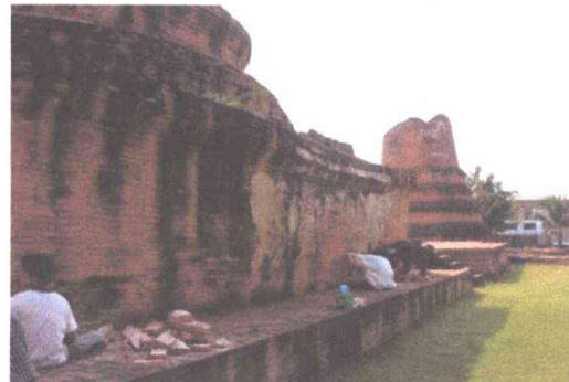
ภาพที่ 38 ก่ออิฐเสริม ฐานเชิงของเจดีย์ฐานสี่เหลี่ยมทรงสูง ทะเบียนภาพถ่าย: วัดหัตถดาต - 71
