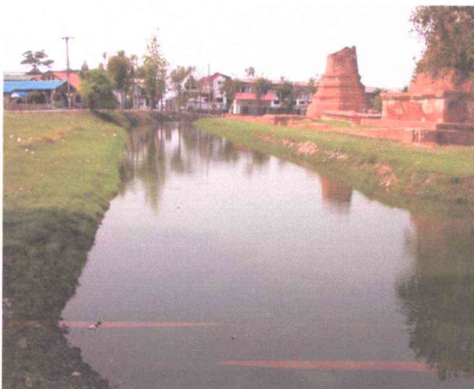
ภาพที่ 79 คูน้ำ ด่านใต้ ภายหลังการบูรณะ ทะเบียนภาพถ่าย : หัตถาวาส - 130
