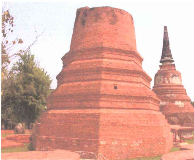
ภาพที่ 82 เจดีย์ประธานแปดเหลี่ยม ภายหลังการบูรณะ ทะเบียนภาพถ่าย : หัสดาวาส - 147
