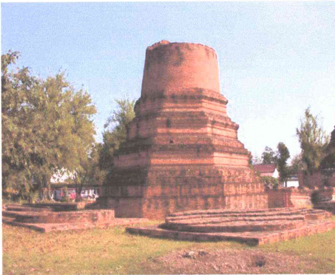
ภาพที่ 8 เจดีย์ประธานแปดเหลี่ยม และเจดีย์ราย ก่อนดำเนินการบูรณะ ทะเบียนภาพถ่าย : หัสดาวาส - 021
