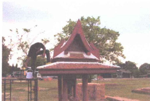
ภาพที่ 58 ซุ้มป้ายบรรยาย ขณะทำการบูรณะ ทะเบียนภาพถ่าย: วัดหิंसดาวาส - 196
