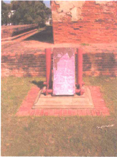
ภาพที่ 50 สภาพของป้ายบรรยาย ก่อนการบูรณะ ทะเบียนภาพถ่าย: วัดหัสดาวาส - 014
