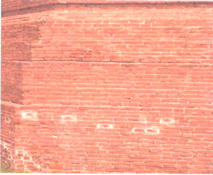
ภาพที่ 83 แนวอิฐที่ก่อสร้างใหม่บริเวณฐาน เจดีย์ ประธานแปดเหลี่ยม ภายหลังการบูรณะ ทะเบียนภาพถ่าย : หัสดาวาส - 152
