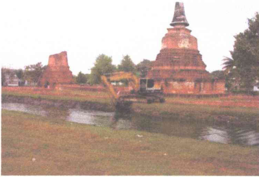
ภาพที่ 35 ดำเนินการขุดลอกคูน้ำ ทะเบียนภาพถ่าย: วัดหัตถดาต - 080
