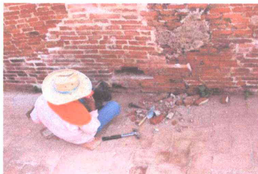
ภาพที่ 40 ก่ออิฐเสริม ฐานเชิงของเจดีย์ฐานสี่เหลี่ยมทรงสูง ทะเบียนภาพถ่าย: วัดหัตถดาต - 72
