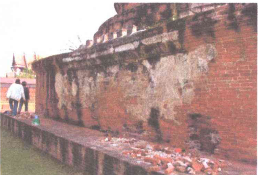
ภาพที่ 39 ก่ออิฐเสริม ฐานเชิงของเจดีย์ฐานสี่เหลี่ยมทรงสูง ทะเบียนภาพถ่าย: วัดหัตถดาต - 72
