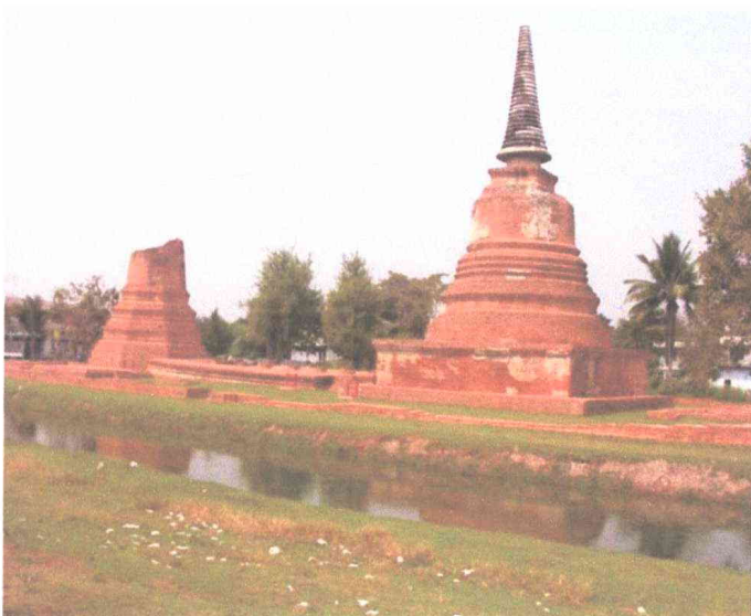
ภาพที่ 78 วัดหัตถาวาส ภายหลังการบูรณะ ทะเบียนภาพถ่าย : หัตถาวาส - 166
