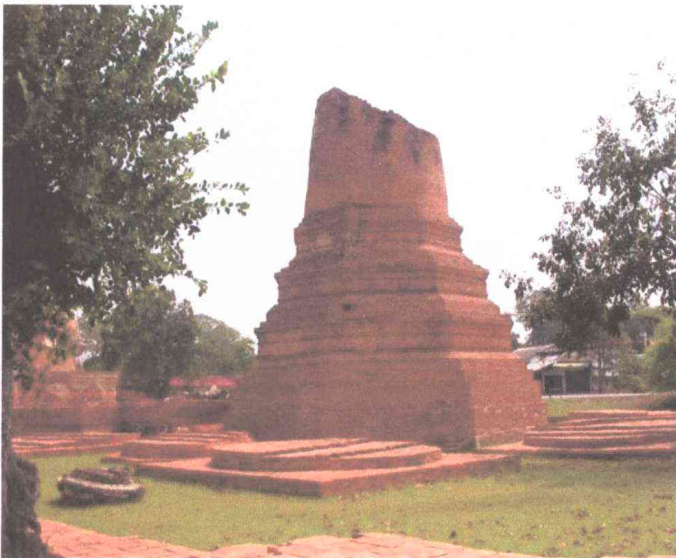
ภาพที่ 84 เจดีย์ประธานแปดเหลี่ยม ภายหลังการบูรณะ ทะเบียนภาพถ่าย : หัสดาวาส - 179
