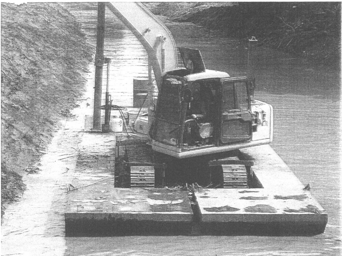
นำแม่คโครลงโปะบริเวณพื้นที่ปฏิบัติงานหลุดลอกคลองสระบัว
