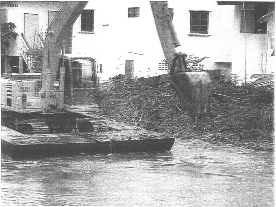
ทำการขุดดินคันคลองให้มีความลึกตามแบบที่กำหนด
