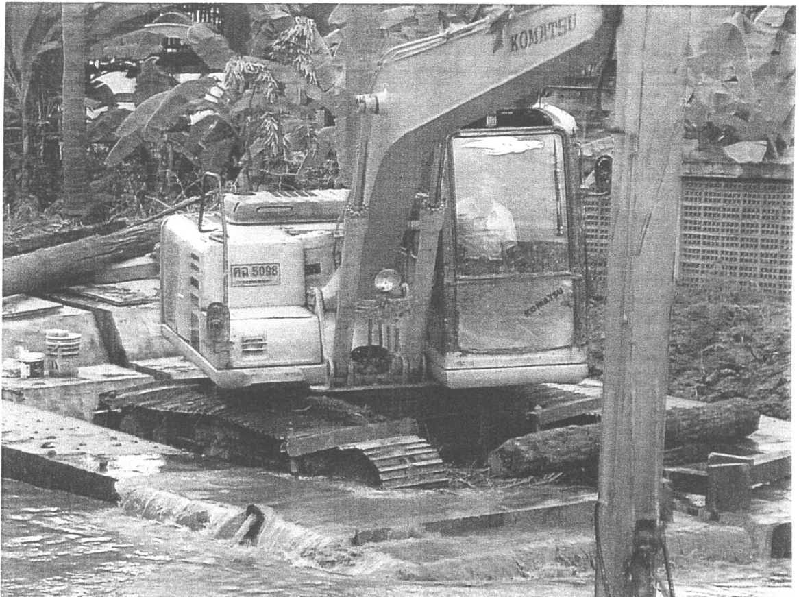
ทำการขุดดินคันคลองให้มีความลึกตามแบบที่กำหนด
