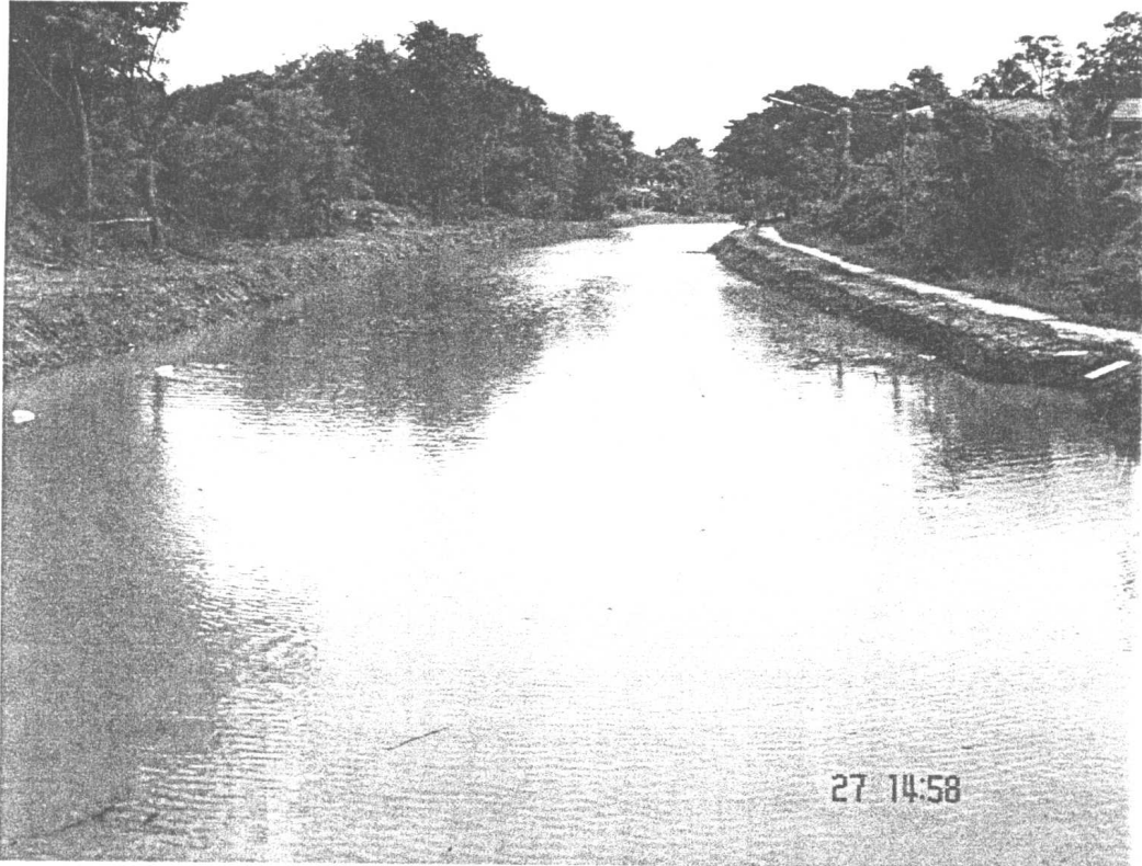
สภาพหลังการดำเนินงานขุดลอกคลองสระบัว
