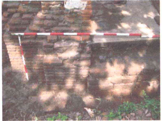
ภาพที่ ๖๔ หลุมขุดตรวจ TP.8.2
