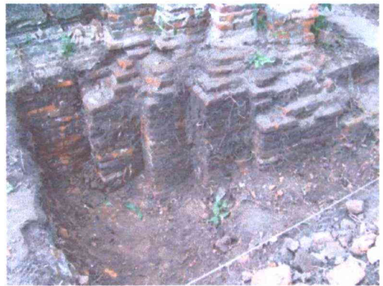
ภาพที่ ๔๖ ฐานของซุ้มประตูที่ยังไม่ได้บูรณะ
