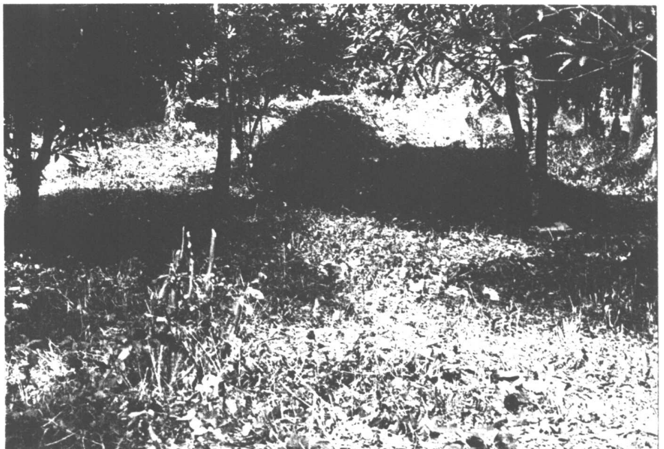
สภาพก่อนการขุดแต่ง เจดีย์ราย หมายเลข 5 ด้านทิศตะวันออก
