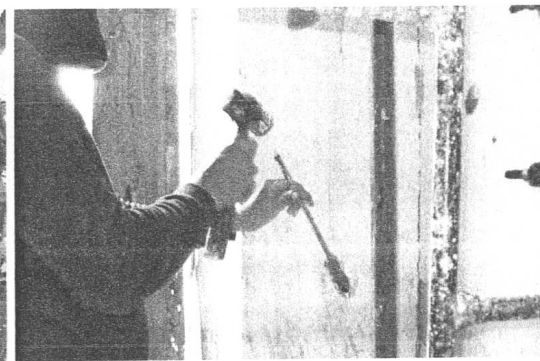
ภาพที่ ๕๕ และ ๕๖ ขณะทำการเจาะเย็บผนังที่แตกร้าว พร้อมอัดฉิน้ำปูนทราย
