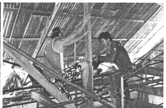
ภาพที่ ๗๕ - ๗๘ ขณะทำการรื้อแผ่นสังกะสีมุงหลังคาเดิม และไม้ระแนง ไม้กลอน ออกจากหลังคาวิหาร
