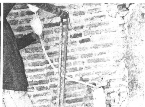
ภาพที่ ๘๙ และ ๙๐ ขณะทำการก่ออิฐเสริมความมั่นคง และอัดฉีดน้ำปูนในบริเวณผนังที่แตกร้าว
