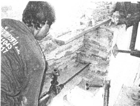
ภาพที่ ๘๗ และ ๘๘ ขณะทำการเจาะเย็บผนังวิหารพระนอนที่แตกร้าว
