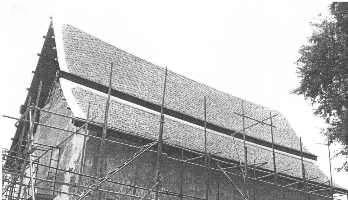
ภาพที่ ๔๗ สภาพหลังคาโบสถ์ หลังทำการปูกระเบื้องแล้วเสร็จ
