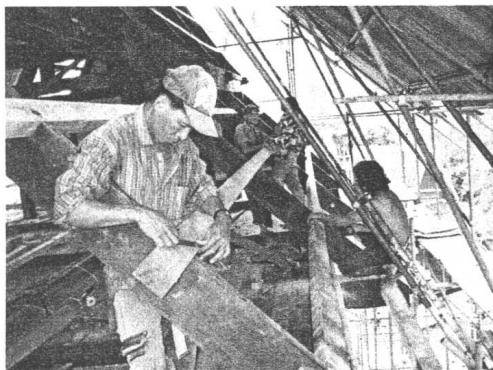
ภาพที่ ๓๖ และ ๓๗ ขณะทำการซ่อมเปลี่ยนไม้โครงสร้างหลังคา
