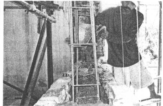
ภาพที่ ๘๓ - ๘๖ ขณะทำการเทคานคอนกรีตเสริมเหล็ก เพื่อเสริมโครงสร้างผนังวิหารพระนอน
