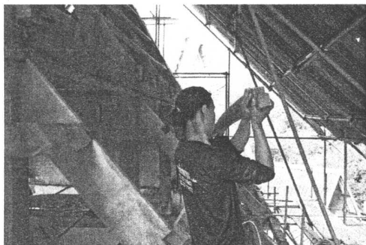
ภาพที่ ๓๒ - ๓๕ ขณะทำการรื้อกระเบื้อง ไม้ระแนง ไม้กลอน
