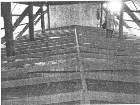
ภาพที่ ๔๓ และ ๔๔ ขณะทำการติดตั้งโครงคร่าวเหล็ก สำหรับรองรับแผ่น Viva Board
