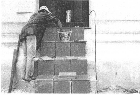
ภาพที่ ๖๖ ขณะดำเนินงานซ่อมแซมบันไดทางเข้า
