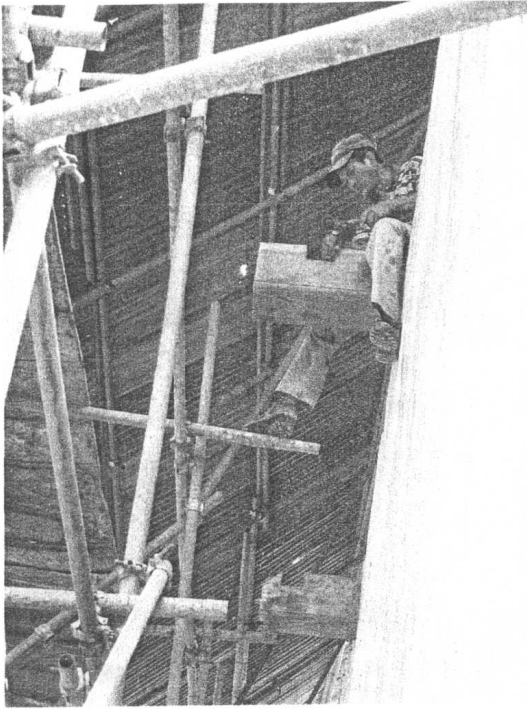
ภาพที่ ๔๐ - ๔๒ ขณะทำการติดตั้งโครงสร้างไม้หลังคาอุโบสถ
