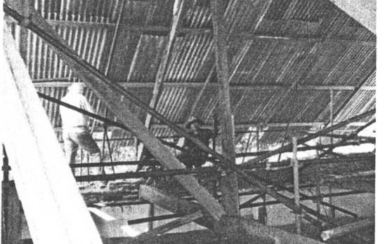
ภาพที่ ๗๙ และ ๘๐ ขณะทำการติดตั้งโครงสร้างไม้หลังคาวิหารพระนอน
