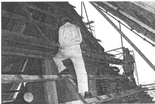
ภาพที่ ๓๒ - ๓๕ ขณะทำการรื้อกระเบื้อง ไม้ระแนง ไม้กลอน
