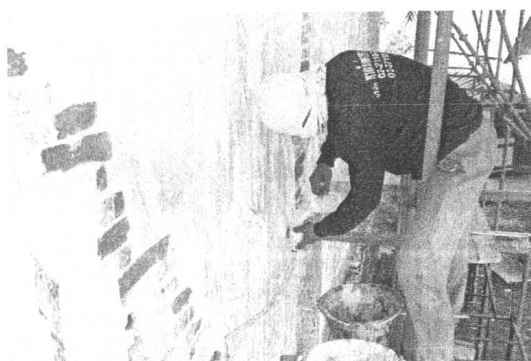
ภาพที่ ๕๕ และ ๕๖ ขณะทำการเจาะเย็บผนังที่แตกร้าว พร้อมอัดฉิน้ำปูนทราย
