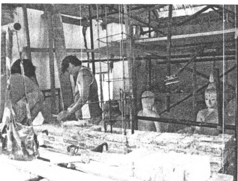
ภาพที่ ๘๙ และ ๙๐ ขณะทำการก่ออิฐเสริมความมั่นคง และอัดฉีดน้ำปูนในบริเวณผนังที่แตกร้าว
