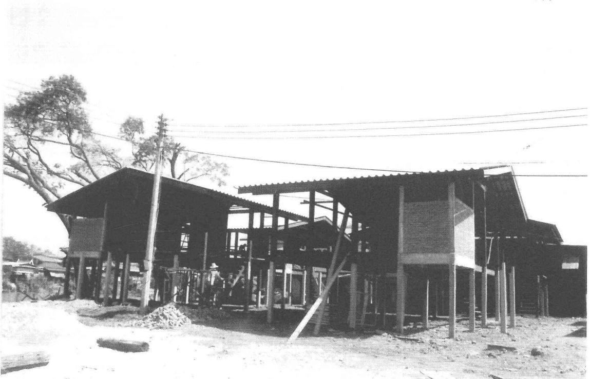
รูปที่ 118 งานอาคารบ้านพักครู ขณะทำการก่อสร้าง (ฟิล์ม 17/9)
