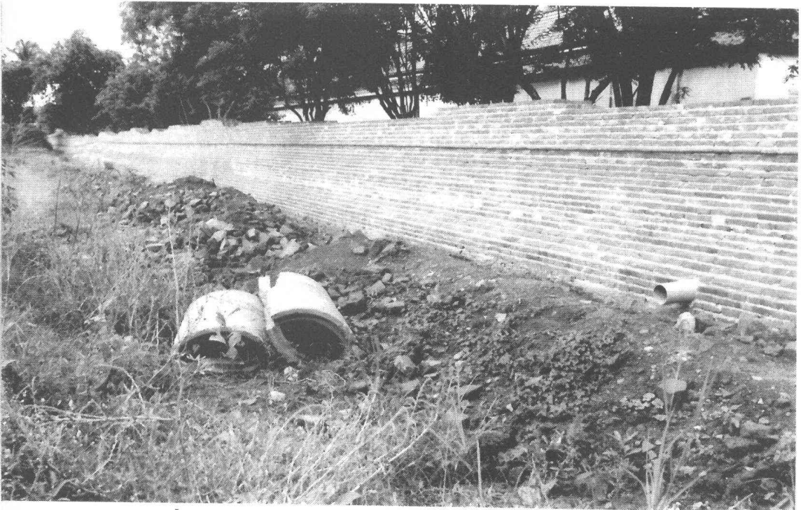
รูปที่ 125 กำแพงแก้วทิศใต้ด้านนอก หลังการบูรณะ (ถ่ายจากทิศตะวันออก) (ฟิล์ม 10/28)
