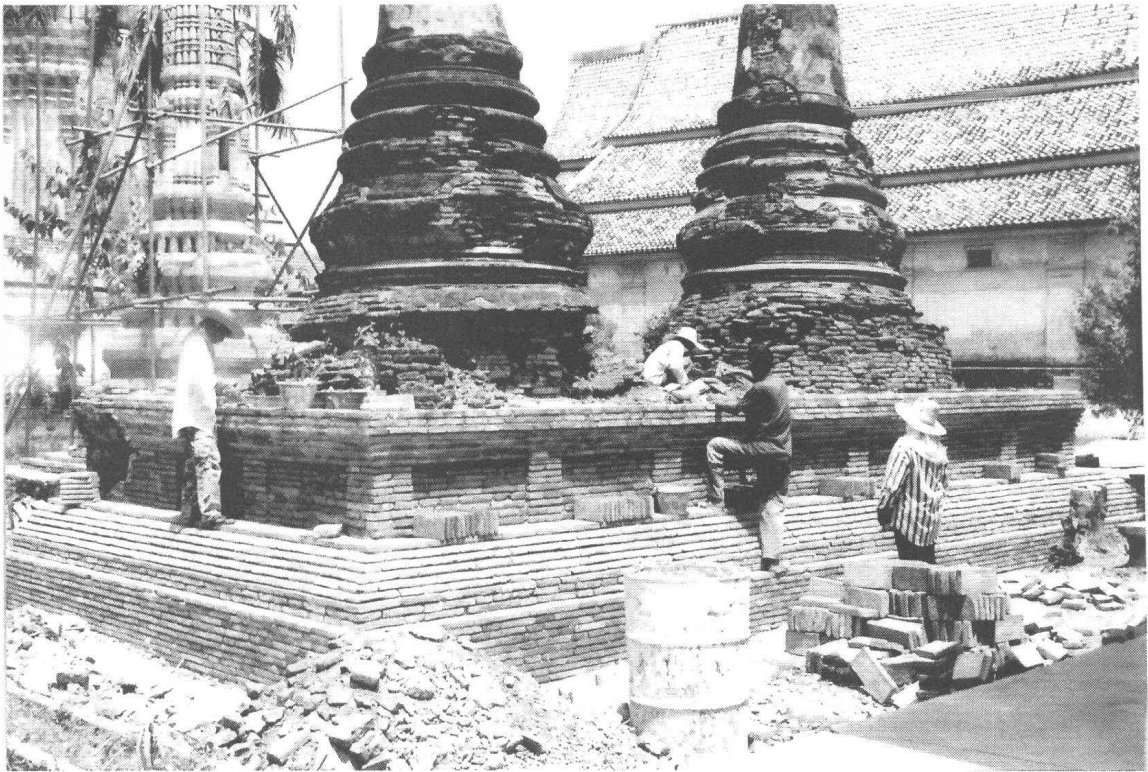
รูปที่ 79 เจดีย์รายหมายเลข 18-19 ขณะทำการบูรณะ (ฟิล์ม 8/17)
