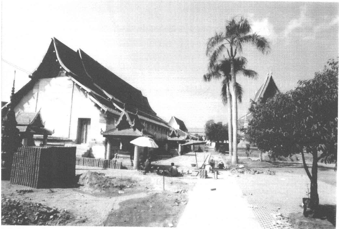
รูปที่ 104 งานพื้นทางเดิน ขณะทำการปูพื้นทางเดิน ด้านทิศเหนือของพระอุโบสถ (ฟิล์ม 16/32)
