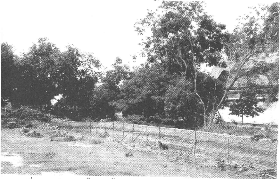
รูปที่ 55 กำแพงแก้วทิศใต้ ขณะทำการบูรณะด้านทิศใต้ (ด้านนอก) (ถ่ายจากทิศตะวันออก) (ฟิล์ม 9/31)
