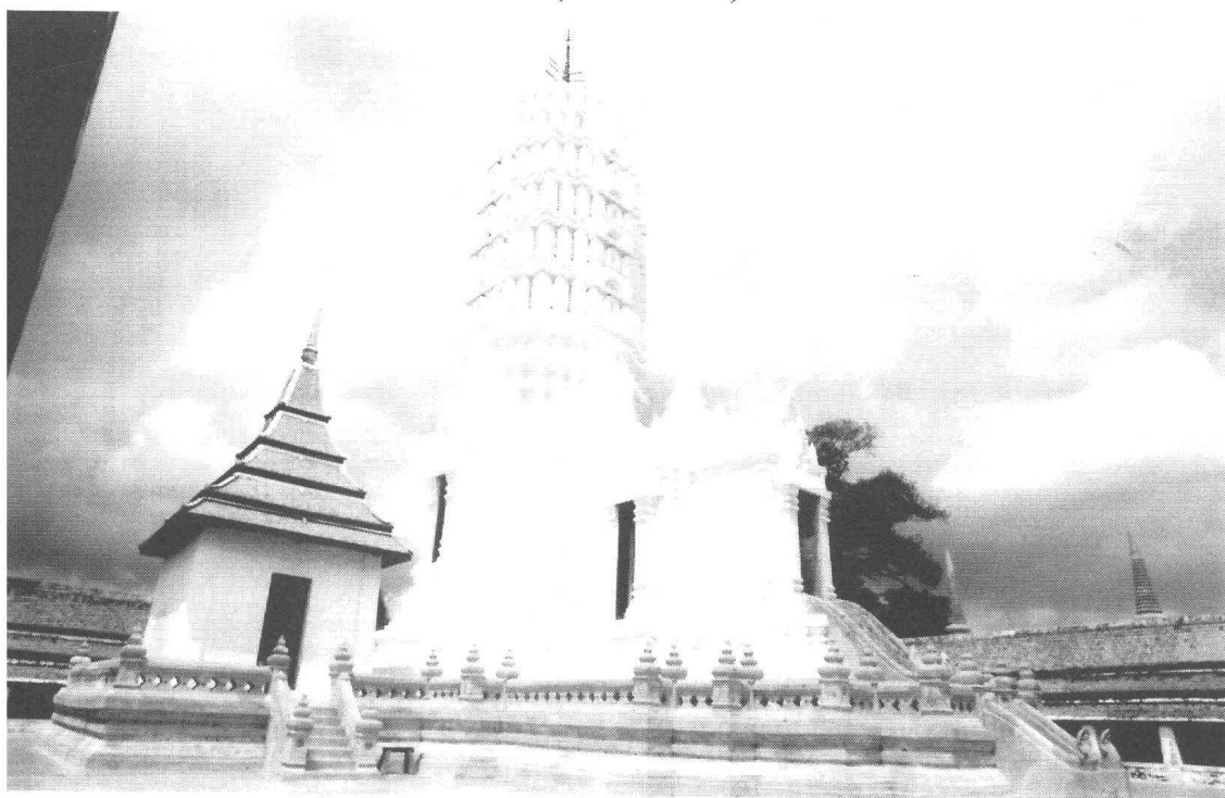
รูปที่ 147 ปรากฏประธาน หลังการบูรณะ ด้านทิศตะวันออกเฉียงใต้ (ฟิล์ม 23/10)
