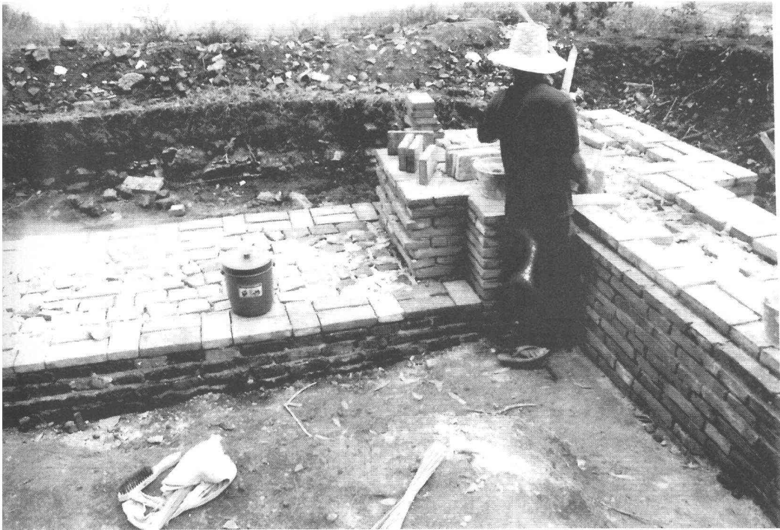
รูปที่ 52 หัวเมื่อกำแพงแก้ว ขณะทำการบูรณะ ทิศตะวันตกเฉียงใต้ (ฟิล์ม 7/21)
