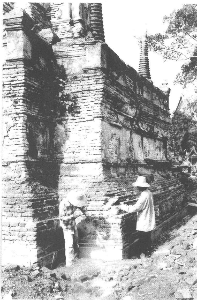
รูปที่ 69 เจดีย์รายหมายเลข 6 ขณะทำการบูรณะเสริมความมั่นคง (ฟิล์ม 8/24)
