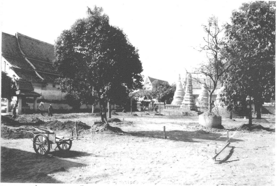
รูปที่ 103 งานพื้นทางเดิน ขณะดำเนินการวางผังและเตรียมพื้นที่ ด้านทิศเหนือพระอุโบสถ
