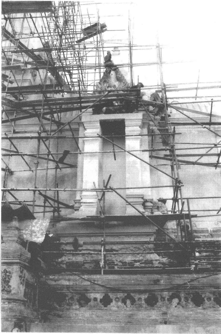
รูปที่ 87 ปรากฏประธาน ขณะทำการบูรณะซุ้มจรนนำ ทิศใต้ของตรีมุข (ฟิล์ม 20/20)
