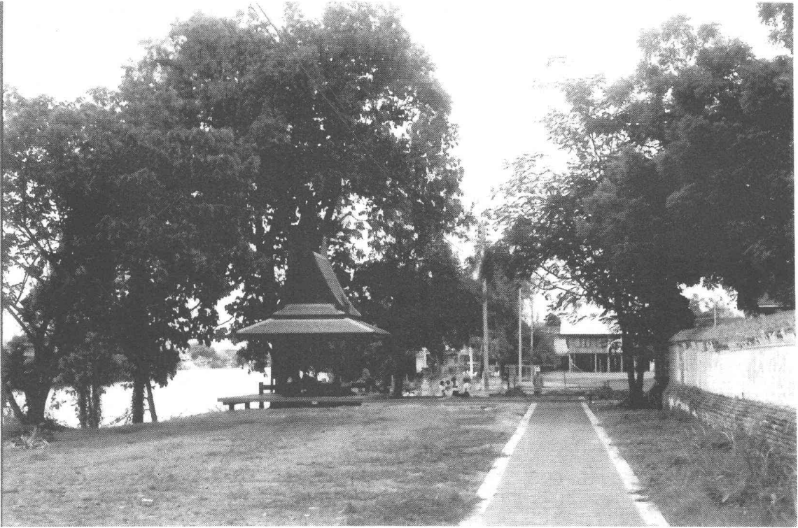
รูปที่ 120 งานพื้่น ขณะทำการพื้่นและขณะทำการก่อสร้างศาลาทรงไทยหลังที่ 2 (ฟิล์ม 20/32)
