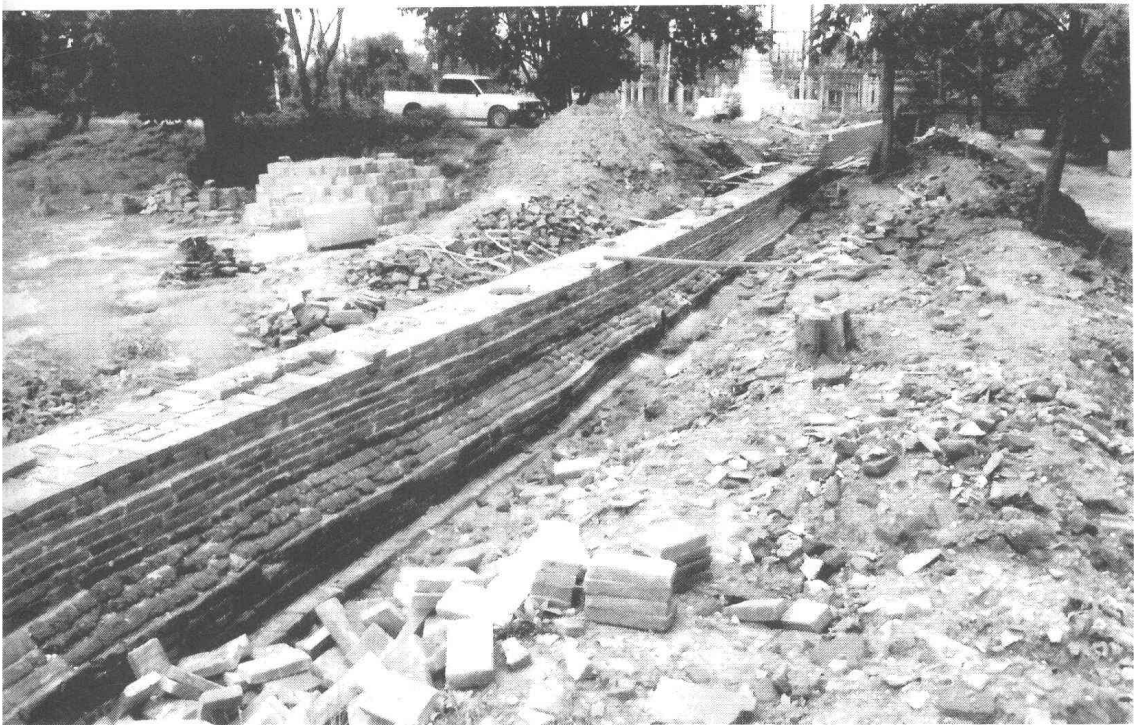
รูปที่ 53 กำแพงแก้วทิศใต้ ขณะทำการบูรณะด้านทิศเหนือ (ด้านใน) (ถ่ายจากทิศตะวันออก) (ฟิล์ม 9/14)
