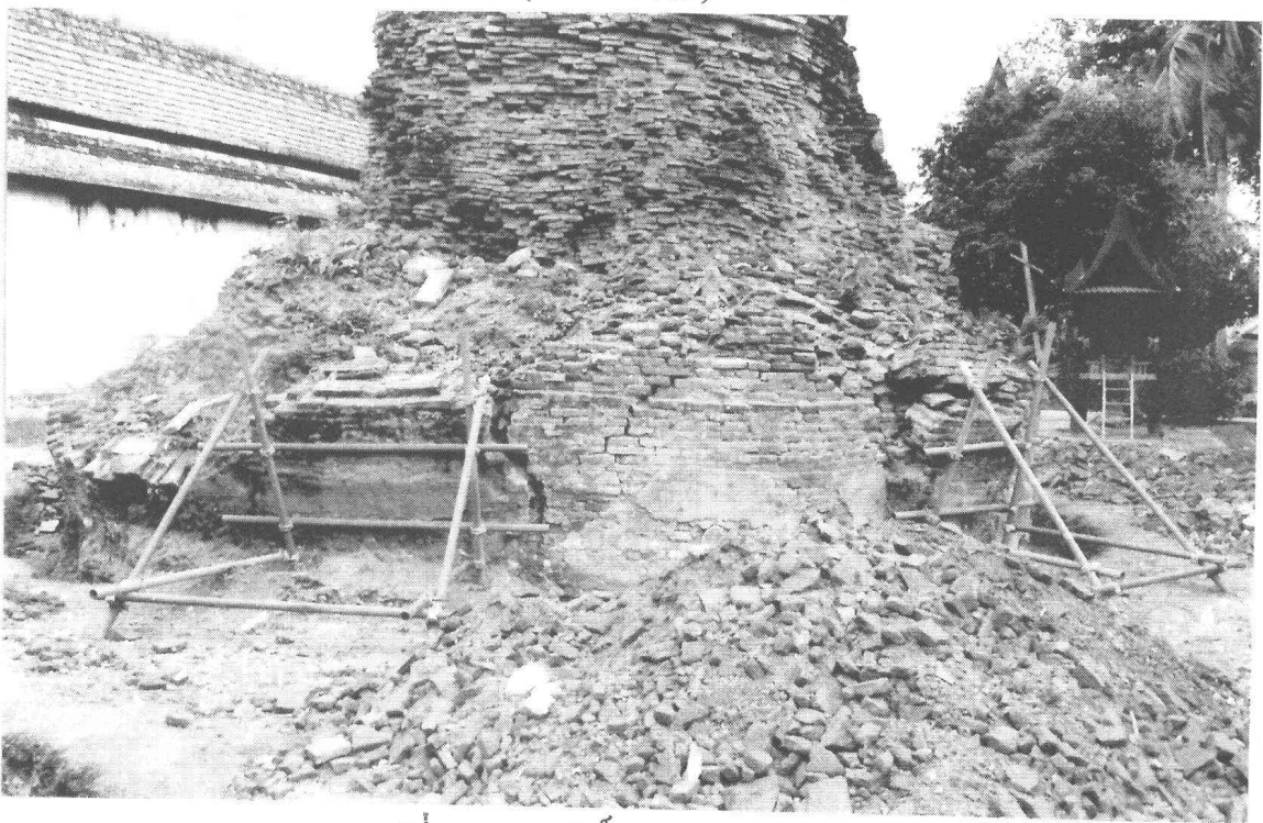
รูปที่ 63 เจดีย์หมายเลข 4 ขณะทำการบูรณะเพื่อเสริมโครงสร้างที่ฐาน ด้านทิศตะวันออก (ฟิล์ม 7/8)
