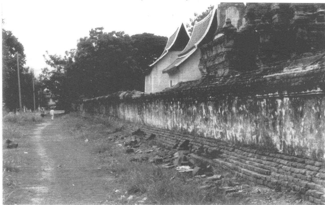
รูปที่ 12 กำแพงแก้วทิศเหนือด้านนอก สภาพก่อนการบูรณะ (ถ่ายจากทิศตะวันตก) (ฟิล์ม 6/36)
