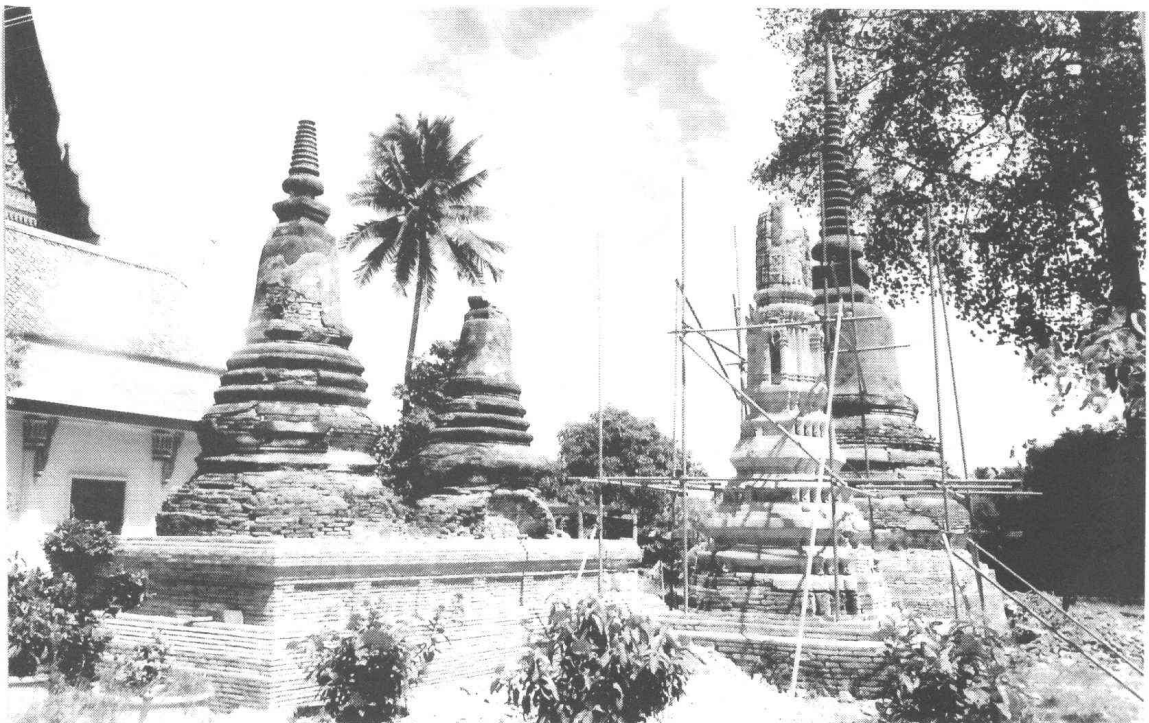
รูปที่ 80 เจดีย์รายหมายเลข 16,17,18 และ 19 ขณะทำการบูรณะ (ฟิล์ม 8/17)
