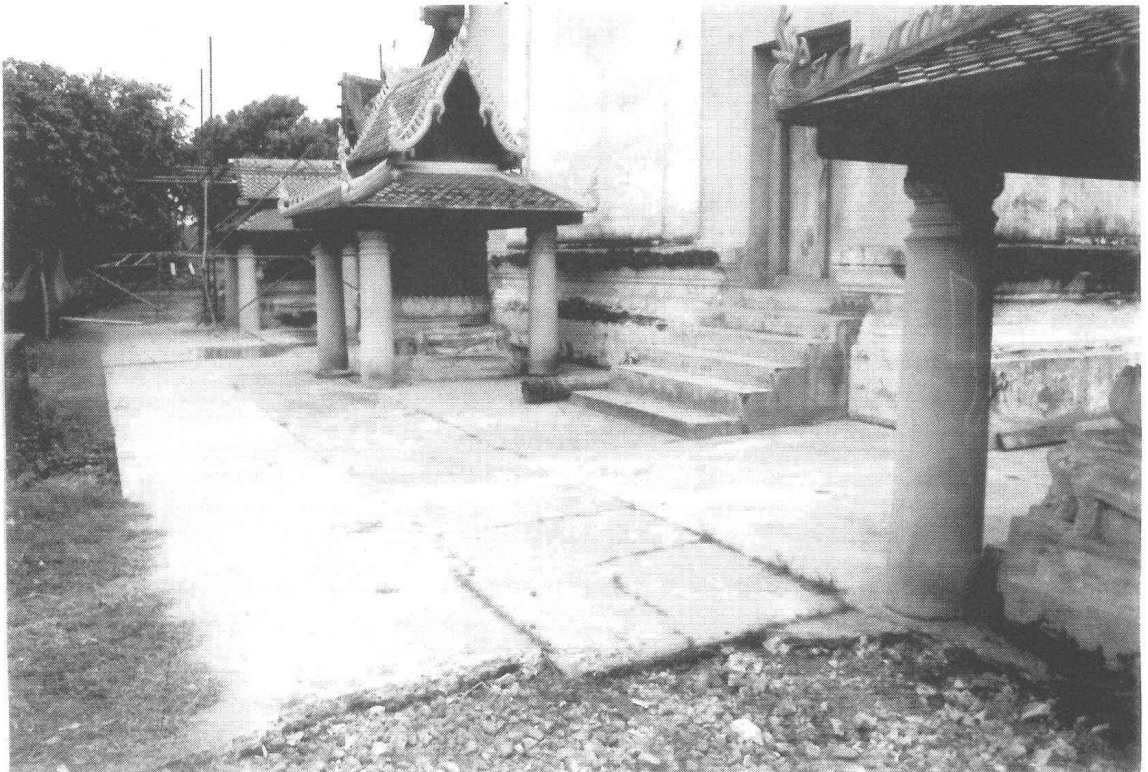
รูปที่ 45 พื้นรอบพระอุโบสถ สภาพก่อนการปรับปรุงภูมิทัศน์ ด้านทิศตะวันออก (ถ่ายจากทิศเหนือ) (ฟิล์ม 12/7)
