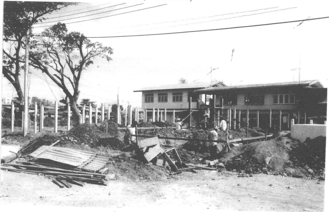
รูปที่ 117 งานอาคารบ้านพักครู ขณะทำการก่อสร้าง (ฟิล์ม 15/34)
