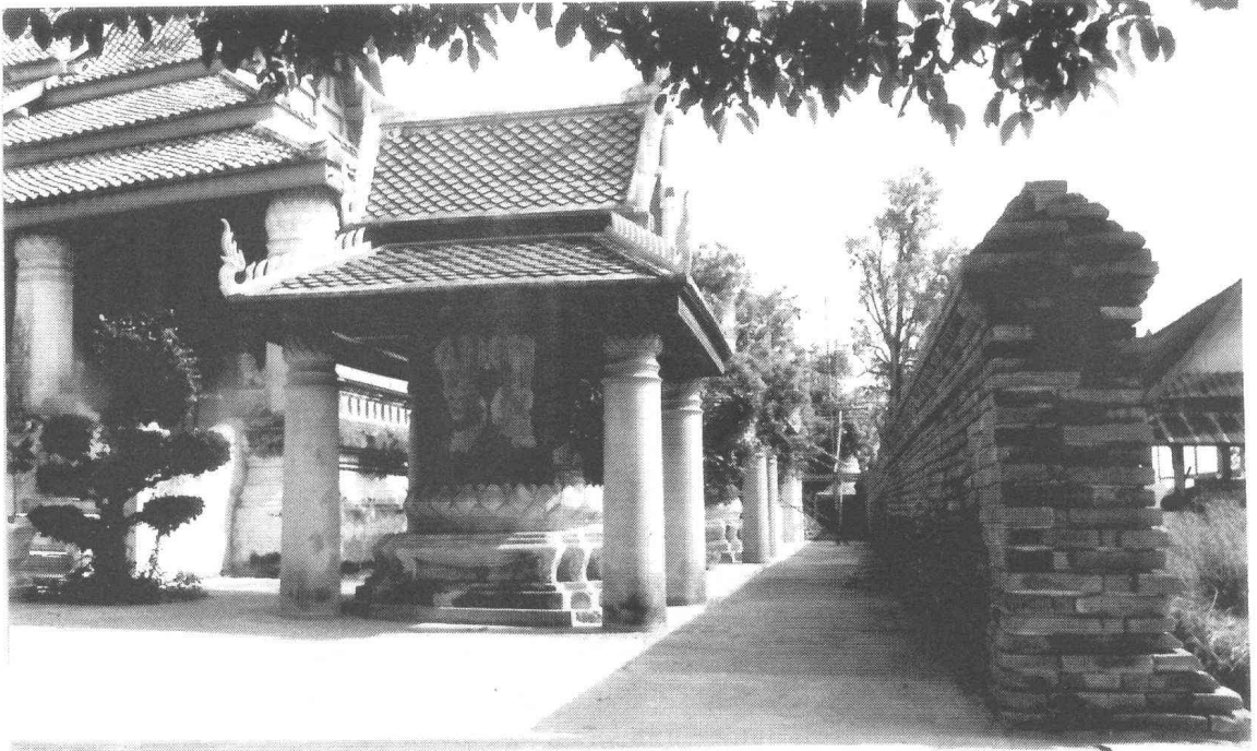
รูปที่ 44 พื้นรอบพระอุโบสถ สภาพก่อนการปรับปรุงภูมิทัศน์ ด้านทิศตะวันตก (ถ่ายจากทิศเหนือ)
