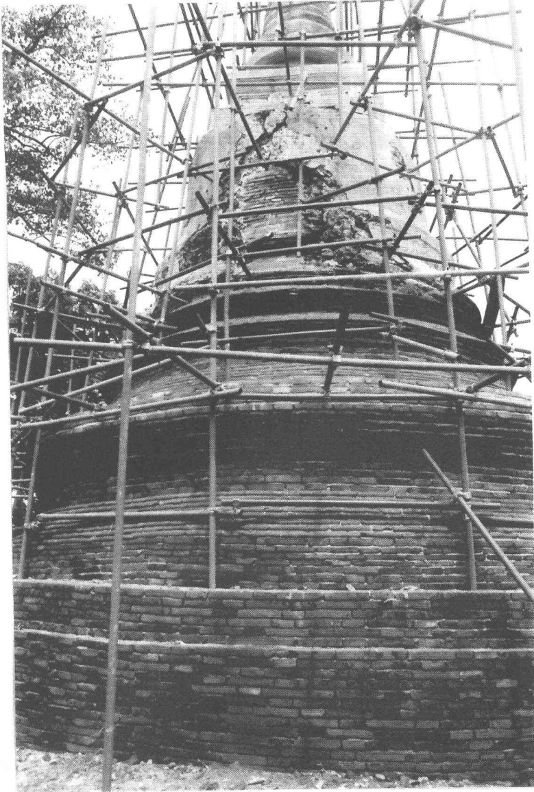
รูปที่ 66 เจดีย์รายหมายเลข 4 ขณะทำการบูรณะ (ฟิล์ม 9/28)
