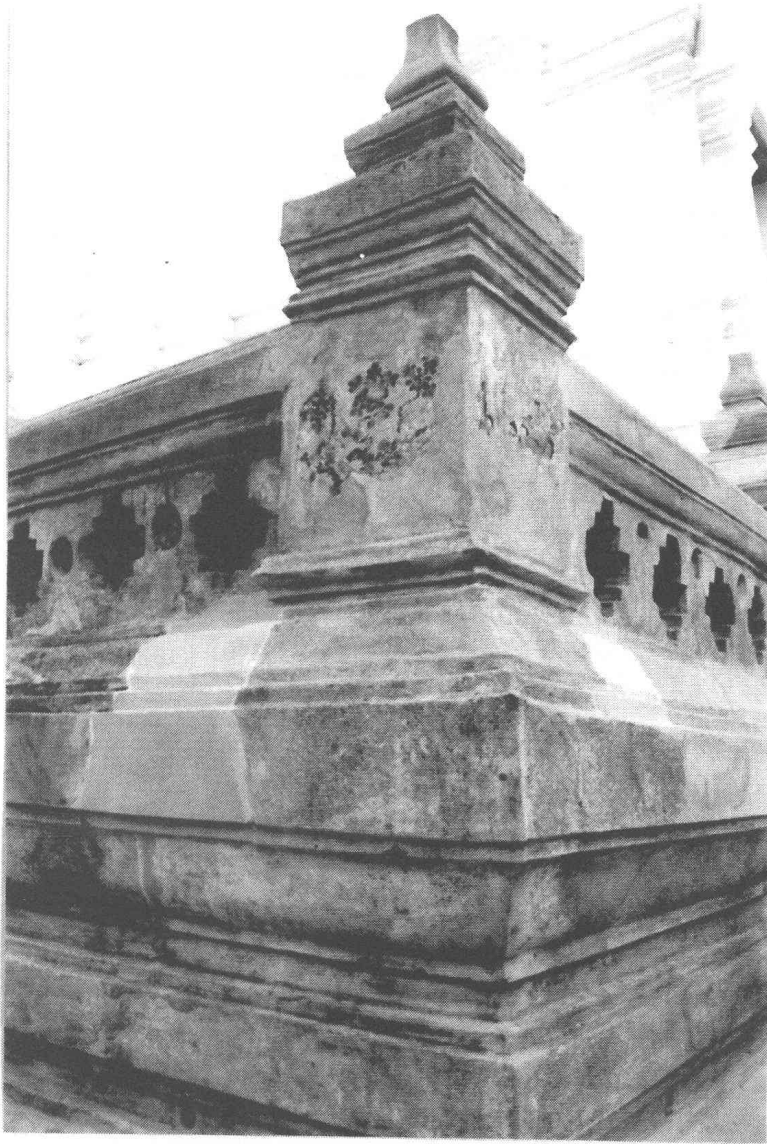
รูปที่ 174 กระเบื้องประดับบนเสาคำแพงฐานไพที หลังการบูรณะ (ฟิล์ม 24/34)
