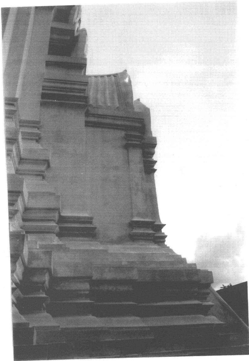
รูปที่ 153 เรือนธาตุปรางค์ประธาน หลังการบูรณะ ด้านซุ้มทิศตะวันตก (ถ่ายจากทิศเหนือ) (ฟิล์ม 24/28)
