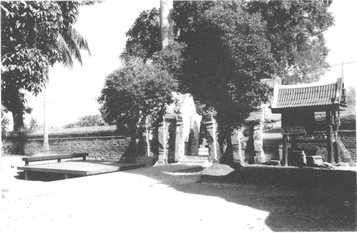
รูปที่ 130 ชุ่มประตูกำแพงแก้วทิศเหนือด้านใน หลังการบูรณะ (ฟิล์ม 19/19)
