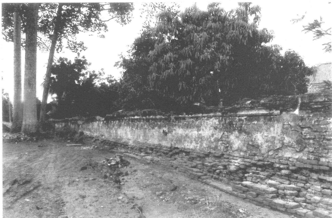
รูปที่ 11 กำแพงแก้วทิศเหนือด้านนอก สภาพก่อนการบูรณะ (ถ่ายจากทิศตะวันตก) (ฟิล์ม 6/32)
