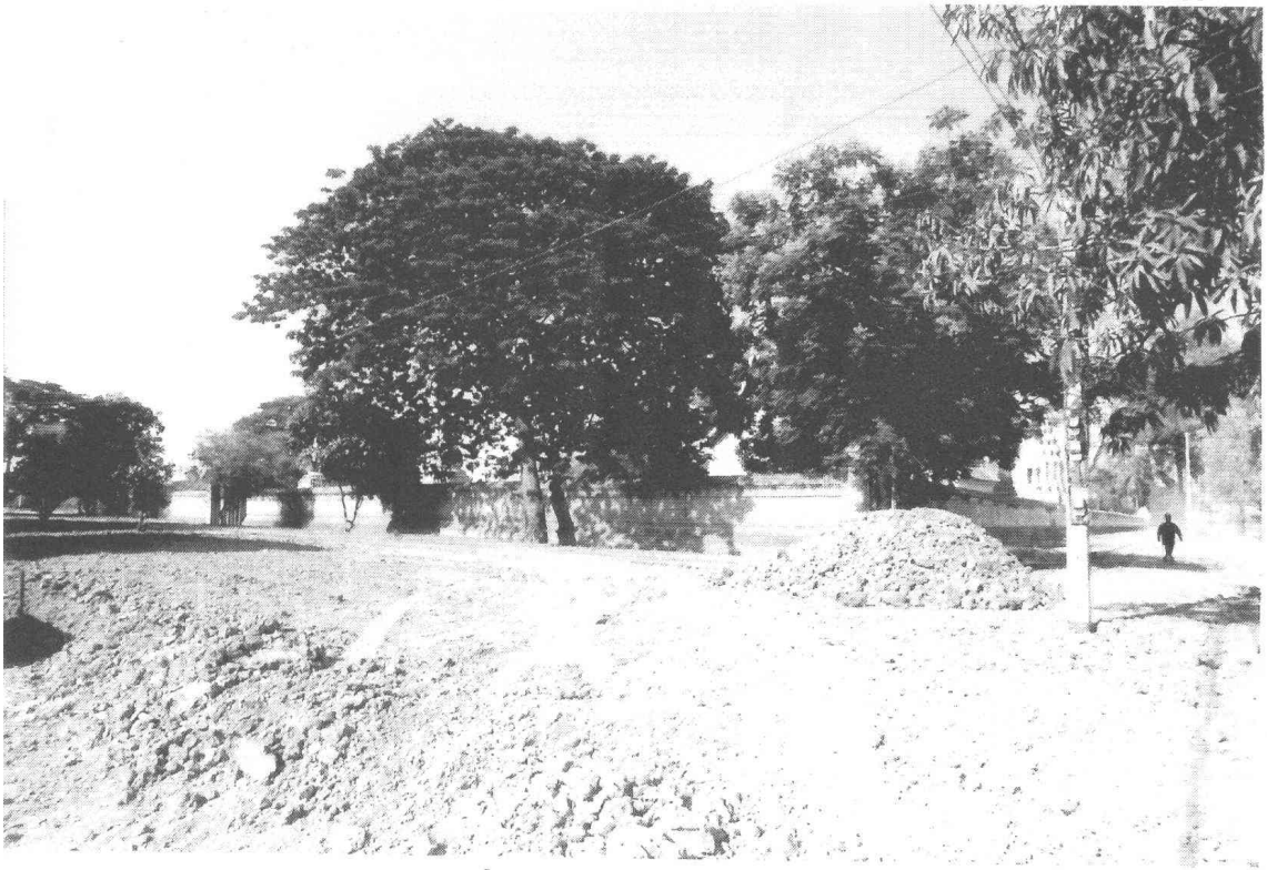
รูปที่ 109 งานพื้นทางเดิน ขณะทำการปรับพื้นที่ ด้านนอกกำแพงแก้วทิศตะวันออก (ฟิล์ม 19/12)
