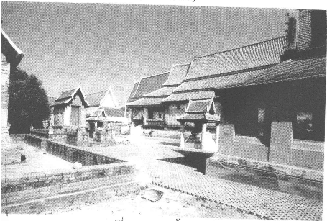
รูปที่ 106 งานพื้นทางเดิน ขณะทำการปูพื้นด้านทิศใต้ของพระอุโบสถ (ฟิล์ม 19/23)
