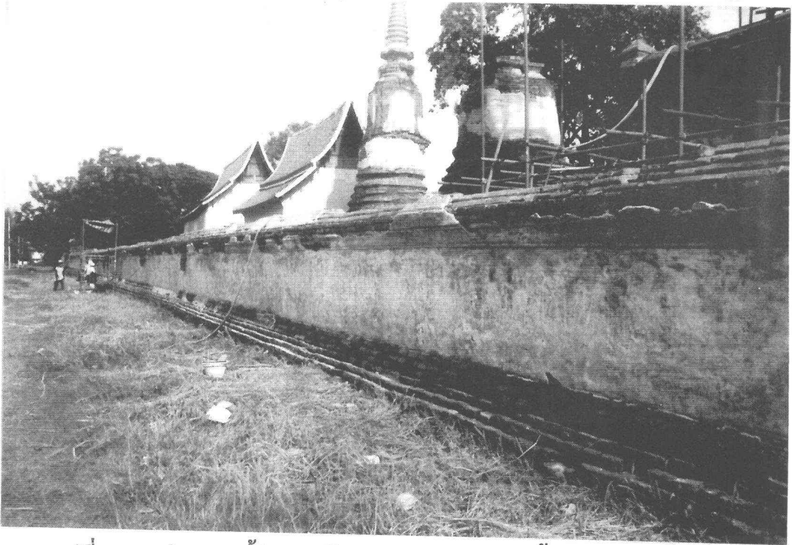
รูปที่ 62 กำแพงแก้วทิศเหนือ ขณะทำการบูรณะด้านทิศเหนือด้านนอก (ถ่ายจากทิศตะวันออก) (ฟิล์ม 10/5)
