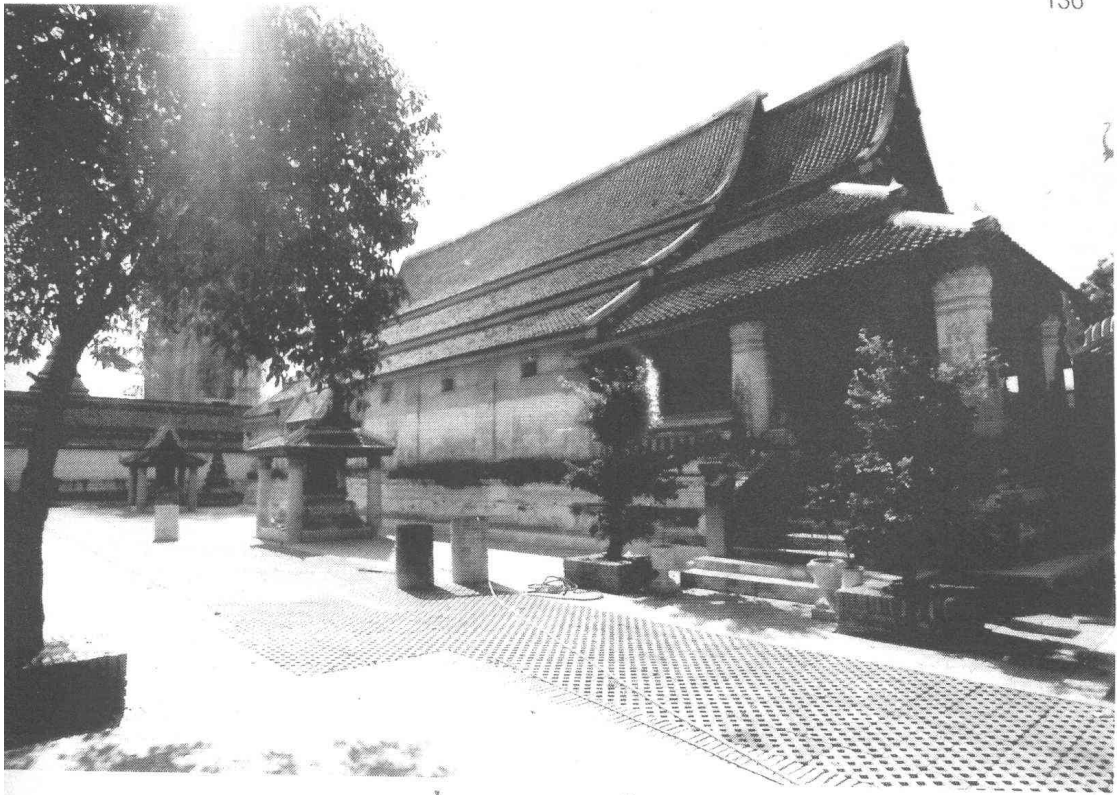
รูปที่ 105 งานพื้นทางเดิน ขณะทำการปูพื้นด้านทิศเหนือของพระอุโบสถ (ฟิล์ม 19/26)
