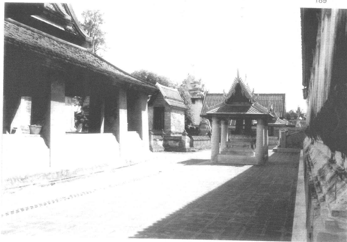
รูปที่ 179 พื้นทางเดิน หลังการปรับปรุงภูมิทัศน์ ด้านทิศใต้ของพระอุโบสถ (ถ่ายจากทิศตะวันออก) (ฟิล์ม 20/4)
