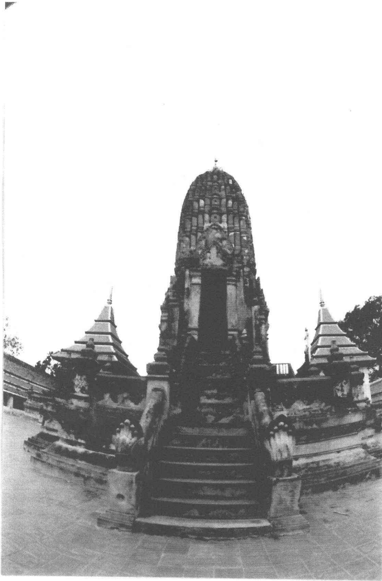
รูปที่ 29 ปรangkัประธาน สภาพก่อนการบูรณะ ด้านทิศตะวันออก (ฟิล์ม 4/14)
