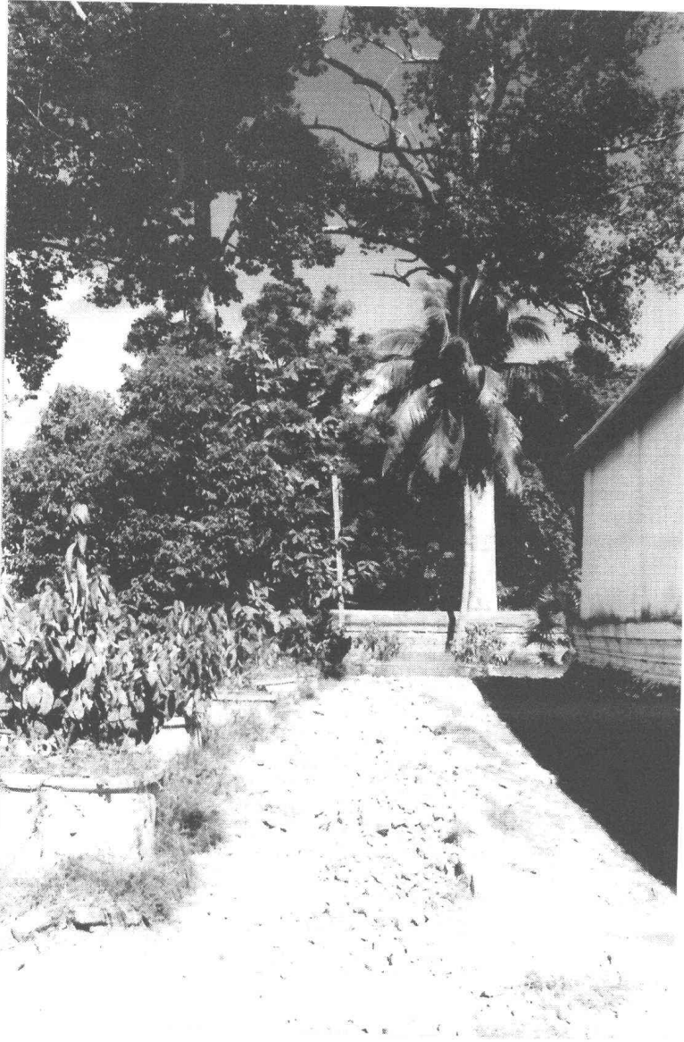
รูปที่ 46 งานพื้นทางเดิน สภาพก่อนการปรับปรุงภูมิทัศน์ (ฟิล์ม 13/9)
