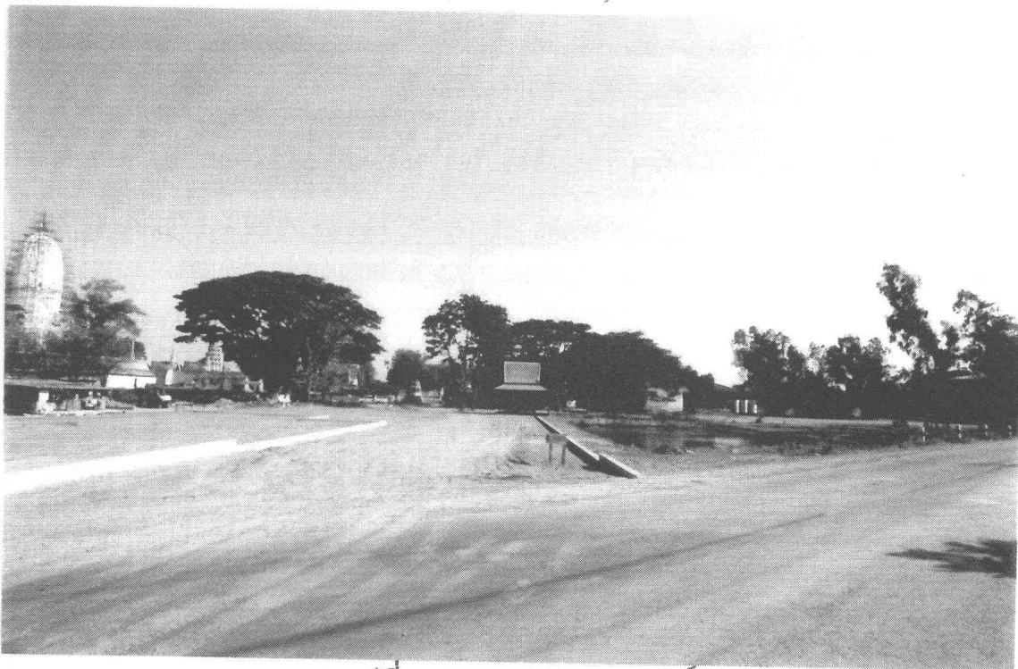
รูปที่ 115 ถนนจอดรถยนต์ ขณะทำการปรับปรุงภูมิทัศน์ (ฟิล์ม 19/2)
