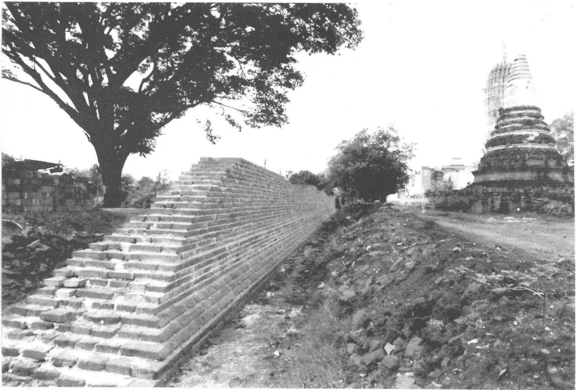
รูปที่ 124 กำแพงแก้วทิศใต้ด้านใน หลังการบูรณะ (ถ่ายจากทิศตะวันออก) (ฟิล์ม 10/29)
