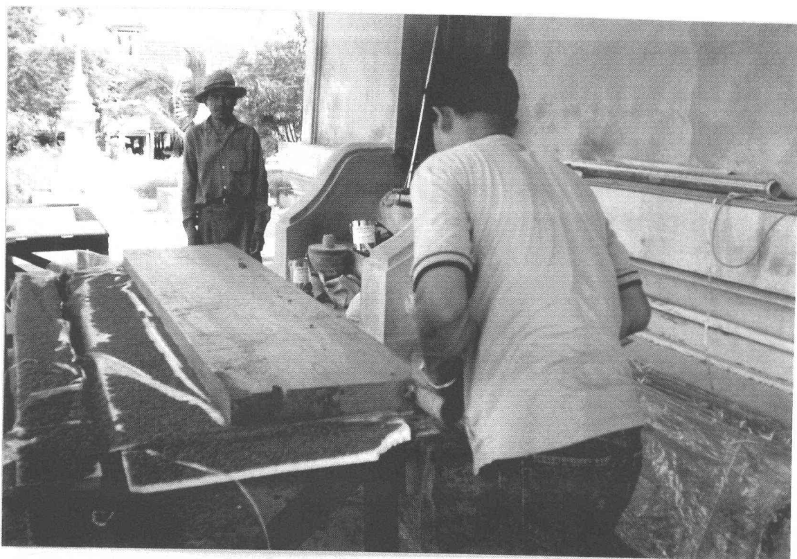
ภาพที่ 19 ขณะทำการซ่อมแซมผิวไม้ด้านนอกของบานหน้าต่าง(ฟิล์ม 4/10)
