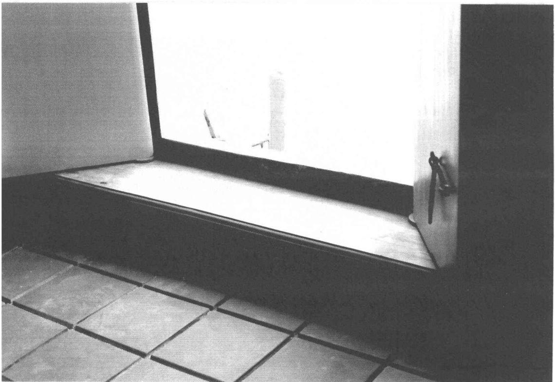
ภาพที่ 24 การติดตั้งบุณระบานประตูโดยใส่ครกและเดือยทองเหลืองชนิดแหวนรองรับและอัดน้ำมันจารบีได้ใหม่หมดทุกบานรวมทั้งติดตั้งสายยูโหละแบบไทย (ประแจเงิน) สำหรับคล้องกุญแจ (ฟิล์ม 5/20)
