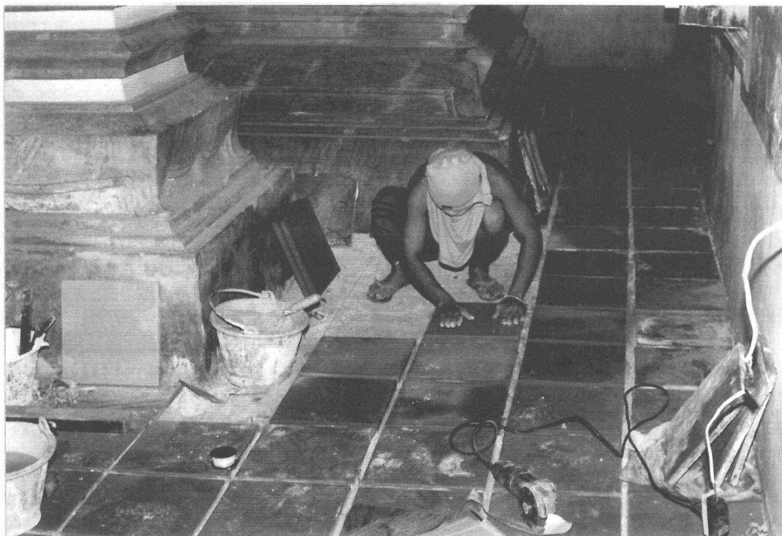
ภาพที่ 14 ขณะทำการปรับปรุงพื้นภายในวิหาร โดยทุบชุดลอกและขนวัสดุรองพื้นเดิมออกทั้งหมด นำแผ่น กระเบื้องดินเผาที่ตัดไว้มาปูพื้นวิหารให้เต็มตามรูปแบบกำหนด (ฟิล์ม 5/24)
