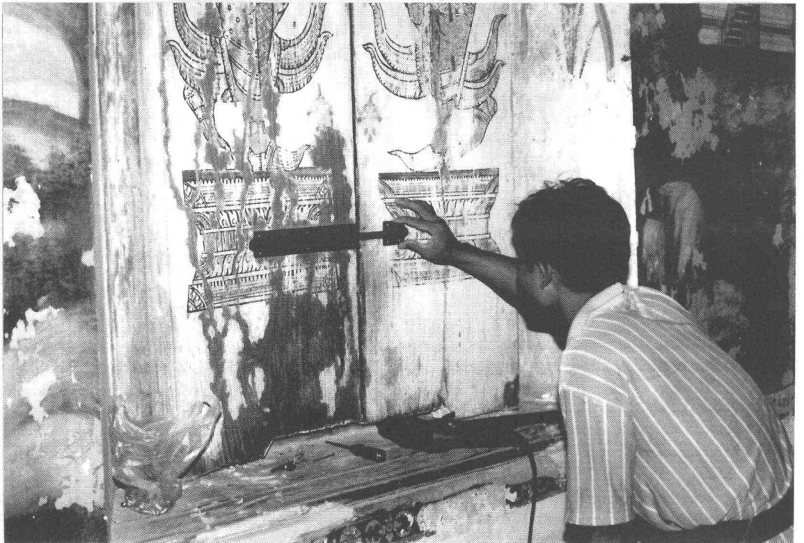
ภาพที่ 22 การติดตั้งหน้าต่างกลับที่เดิมพร้อมทั้งติดตั้งกลอนตามหลักฐานเดิม (ฟิล์ม 5/13)
