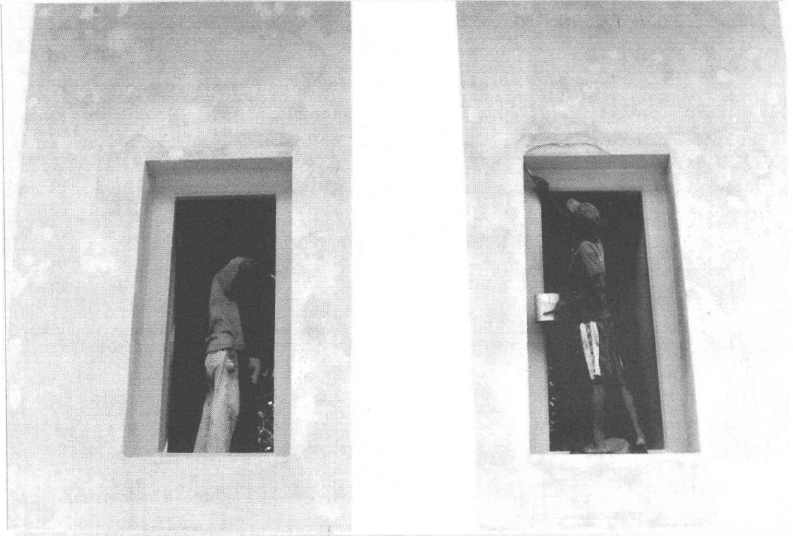
ภาพที่ 23 การทำสีเหลืองตามหลักฐานเดิมที่วงกบหน้าต่างเพื่อรักษาสภาพเนื้อไม้ (ฟิล์ม 5/4)
