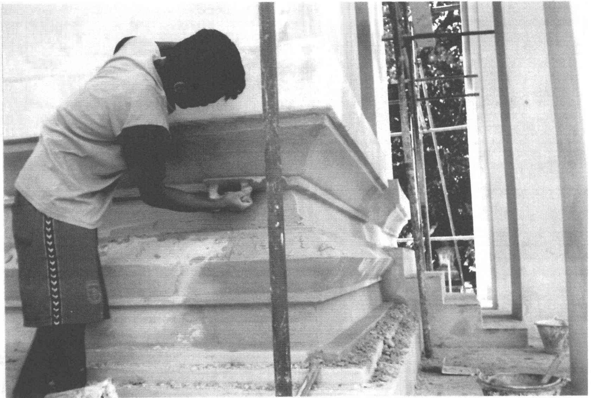
ภาพที่ 10 การใช้ปูนหมักสูตรโบราณฉาบผนังวิหารตามหลักฐานสถาปัตยกรรมเดิม (ฟิล์ม 3/7)
