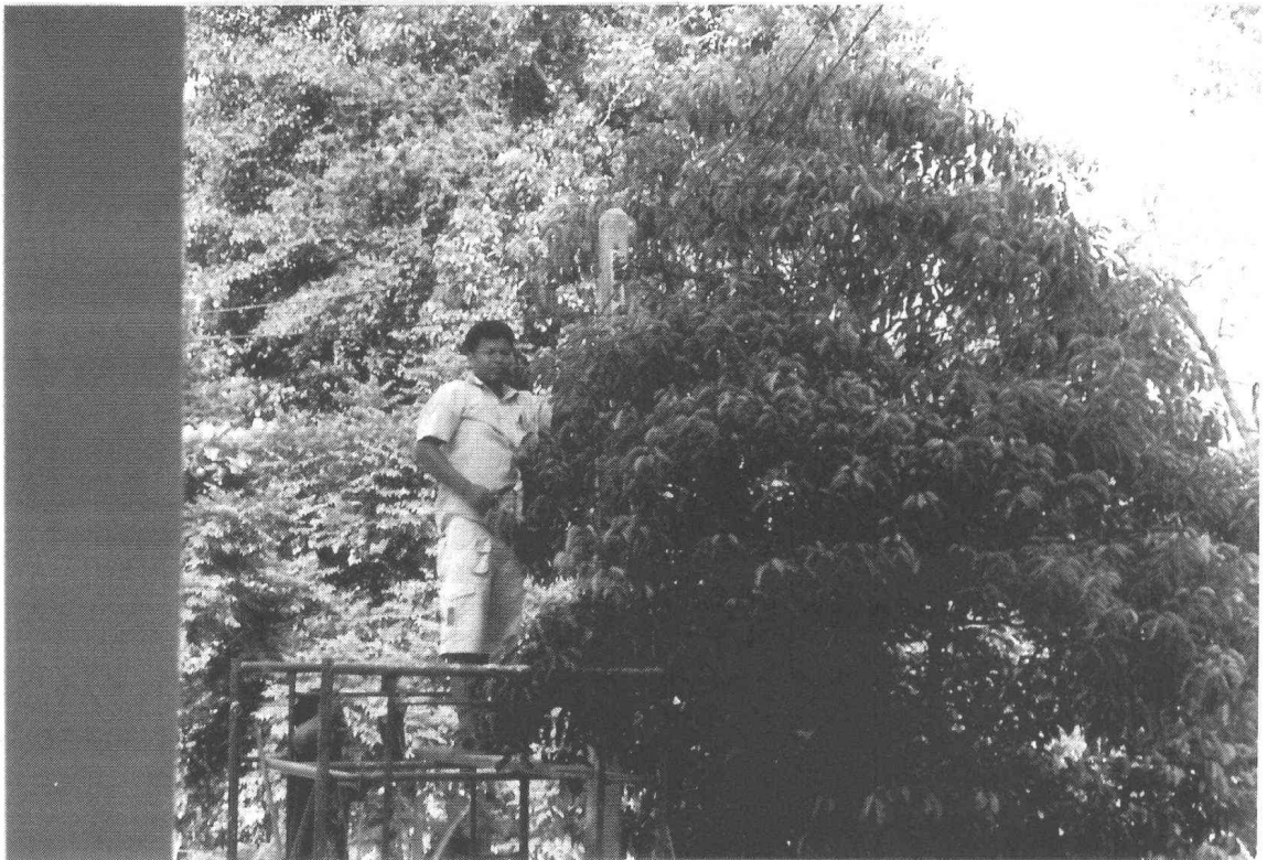
ภาพที่ 28 ขณะทำการตัดกระแสไฟฟ้าเพื่อปรับปรุงระบบไฟฟ้าใหม่ภายในวิหาร (ฟิล์ม3/33)
