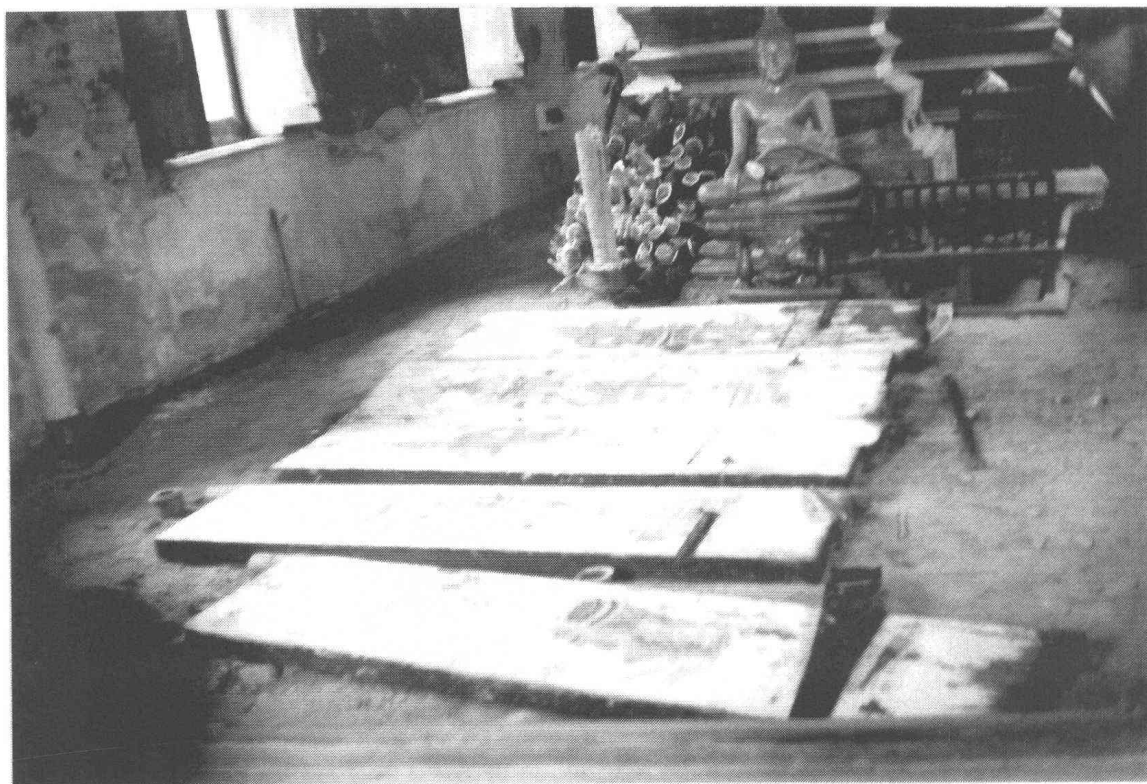
ภาพที่ 17 การรื้อถอดบานหน้าต่างด้านทิศใต้ เพื่อทำการบูรณะ (ฟิล์ม3/29)
