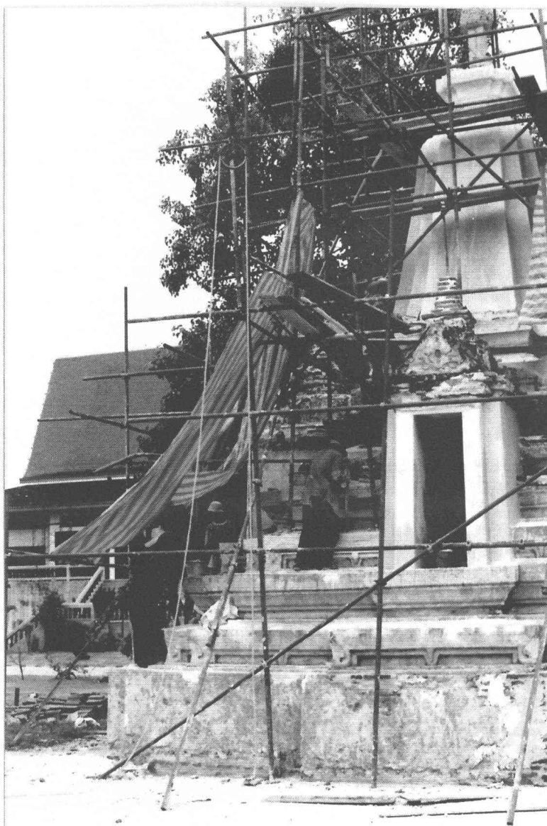
ภาพที่ 47 ขณะทำการฉาบปูนเพื่อบูรณะเจดีย์รายทิศใต้ (ฟิล์ม 5/2)
