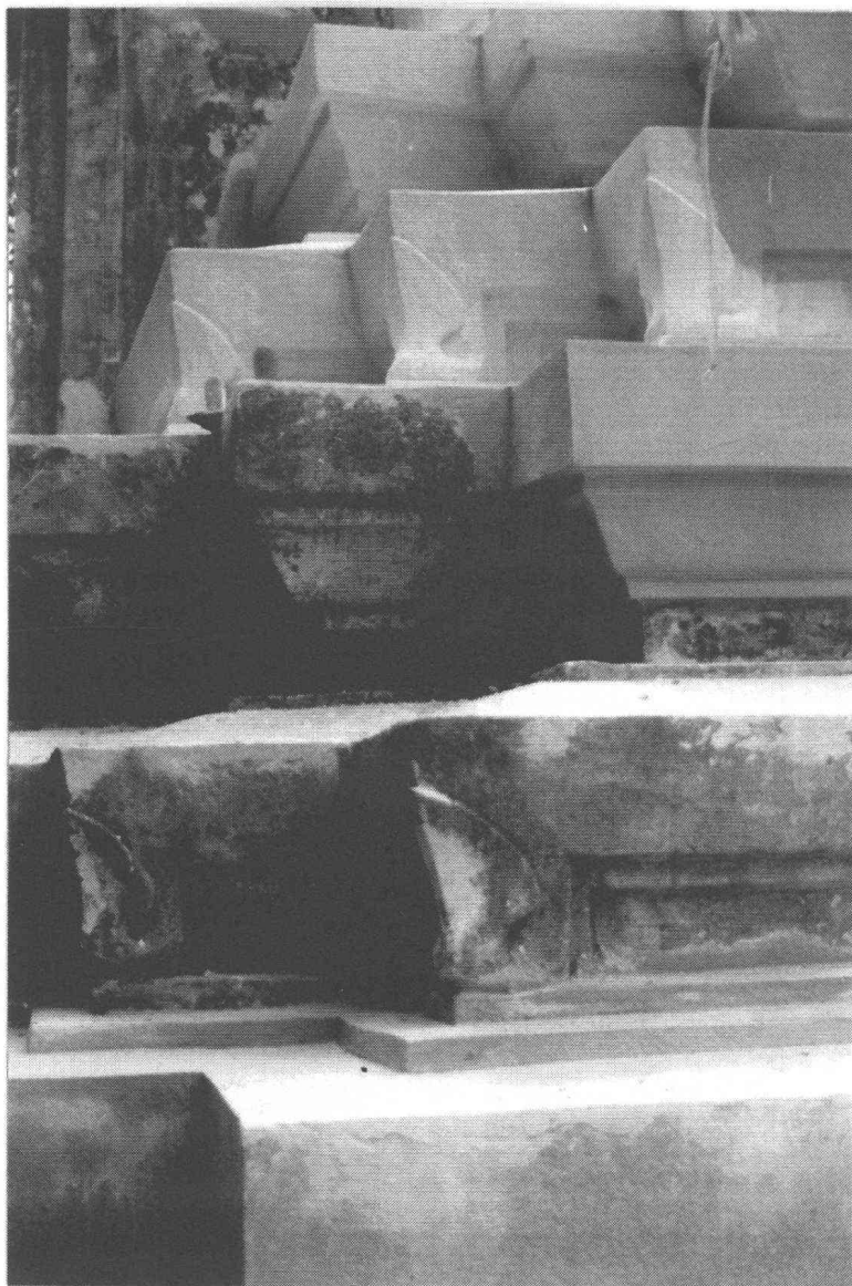
ภาพที่ 48 การฉาบปูนตามหลักฐานสถาปัตยกรรมเดิม ที่ฐานฐานสิงห์เจดีย์รายทิศเหนือ (ฟิล์ม 4/29a)
