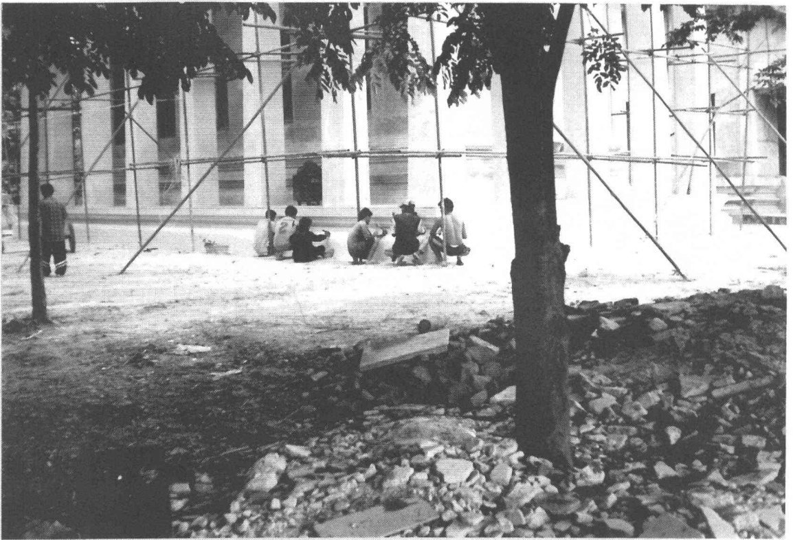
ภาพที่ 7 ขณะปฏิบัติงานสกัดปูนฉาบเดิมที่ฐานวิหารด้านทิศเหนือโดยใช้เครื่องมือขนาดเล็กเช่นสิ่ว สกัด (ฟิล์ม 2/13)
