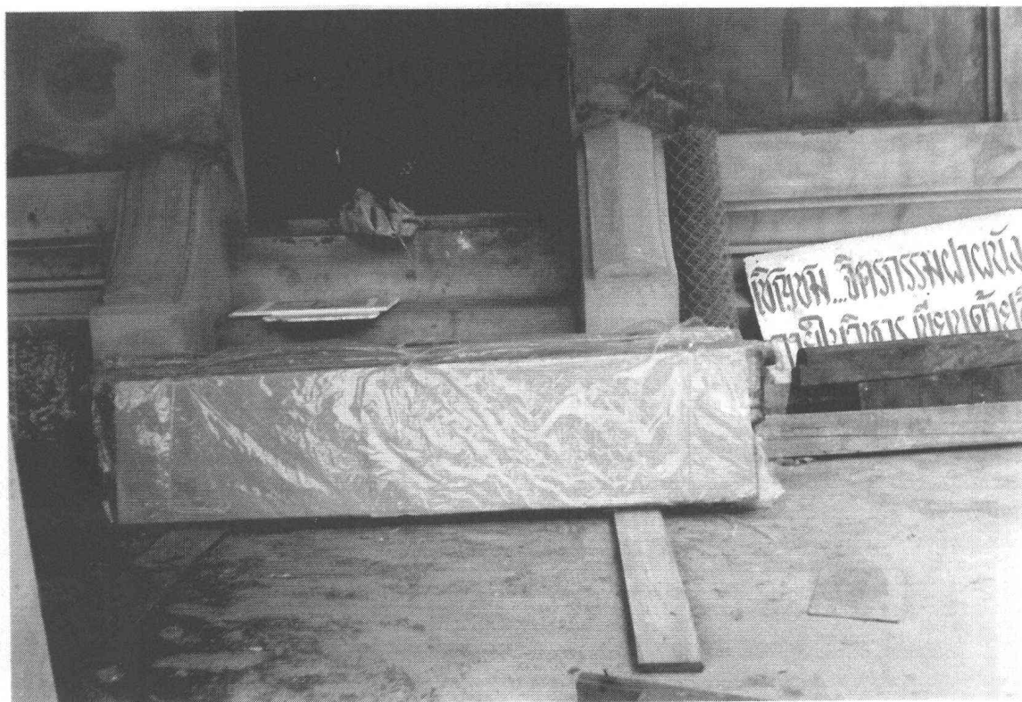
ภาพที่ 18 การใช้กระดาษแข็งแผ่นใหญ่และหนา ห่อหุ้มภาพจิตรกรรมทั้งหมดจนมิดชิดเต็มพื้นที่ จากนั้นจึงใช้แผ่นพลาสติกหุ้มทับอีกชั้นหนึ่ง เพื่อป้องกันความเสียหายก่อนทำการบูรณะ (ฟิล์ม4/5)
