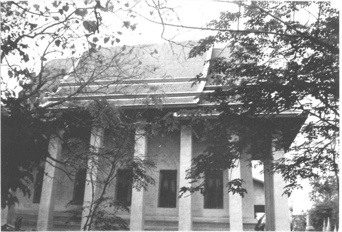
ภาพที่ 3 สภาพก่อนบูรณะวิหารด้านทิศเหนือ (ฟิล์ม 1/32)
