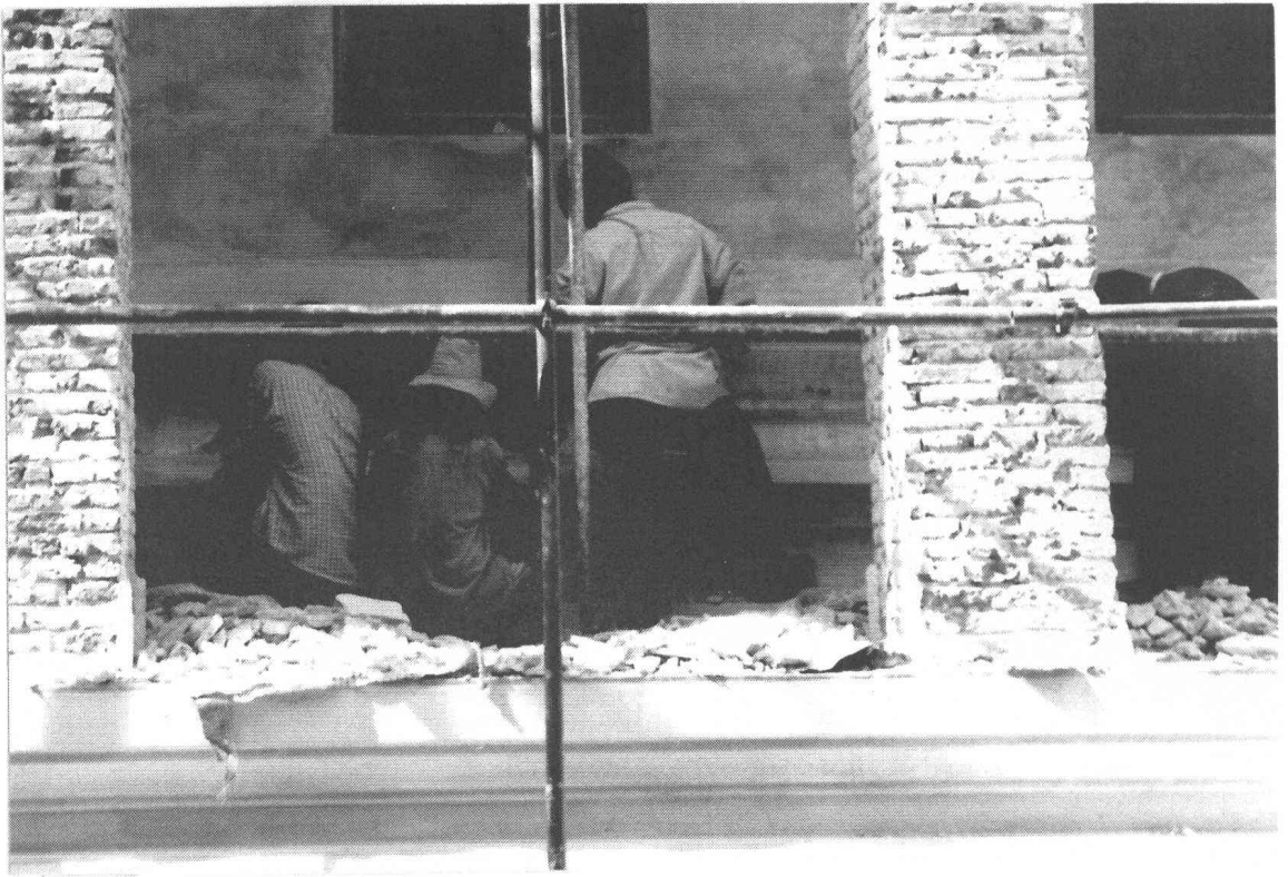
ภาพที่ 9 การสกัดปูนฉาบเดิมที่ฐานชั้นบนของวิหารด้านทิศใต้ (ฟิล์ม 2/34)
