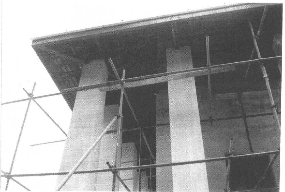
ภาพที่ 12 สภาพภายหลังการฉาบปูนชั้นนอกก่อนขัดปูนดำที่เสวป่าไผ่ของวิหารด้านทิศตะวันออกเจียงเหนือ (ฟิล์ม2/30)
