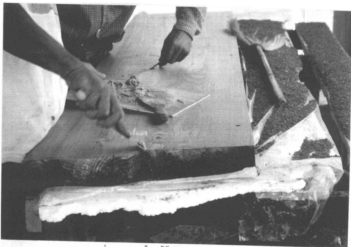
ภาพที่ 20 การลงน้ำยาซีซีซีงเพื่อรักษาเนื้อไม้ (ฟิล์ม 4/12)
