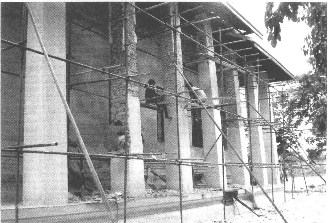
ภาพที่ 8 ขณะปฏิบัติงานสกัดปูนฉาบเดิมที่เสาพาไลของวิหารด้านทิศเหนือ โดยใช้เครื่องมือขนาดเล็กเช่นสิ่ว สกัด (ฟิล์ม 2/29)
