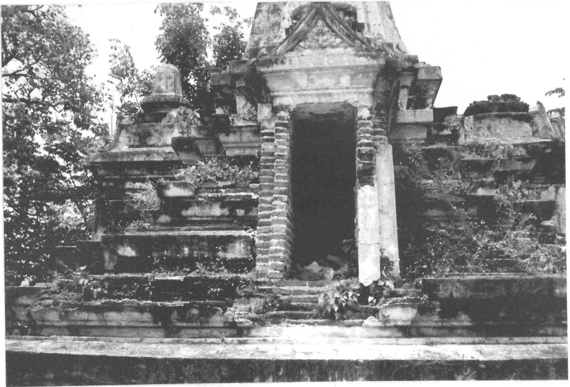
ภาพที่ 43 ชุมเจระนำเจดีย์รายทิศเหนือก่อนการบูรณะ (ฟิล์ม 1/19a)
