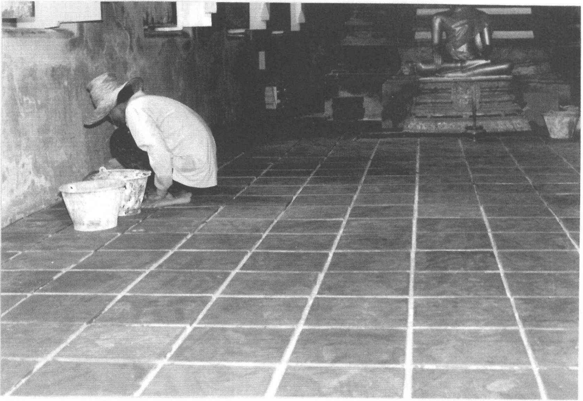
ภาพที่ 15 การเก็บงานรายละเอียดพื้นภายในวิหาร โดยทำการยาแนวด้วยปูนขาวหมัก (ฟิล์ม 5/18)
