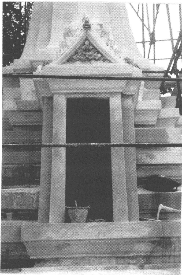
ภาพที่ 49 การฉาบปูนที่เจดีย์รายทิศเหนือตามหลักฐานสถาปัตยกรรมเดิม (ฟิล์ม4/28a)
