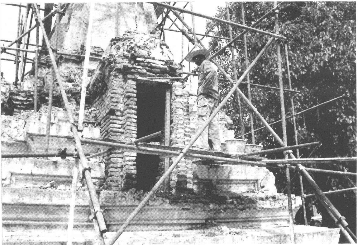
ภาพที่ 44 ขณะทำการก่ออิฐตามหลักฐานเดิมที่ชุมเจระนำด้านเหนือของเจดีย์รายทิศเหนือ (ฟิล์ม 4/6)
