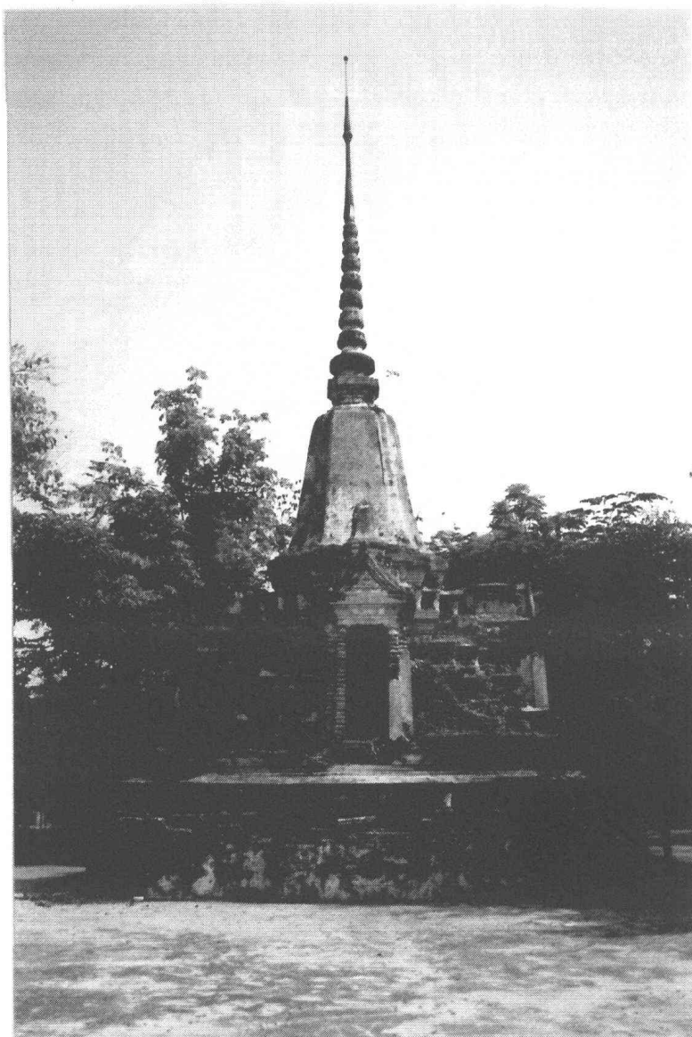
ภาพที่ 41 สภาพก่อนบูรณะเจดีย์รายทรงระฆังย่อมุมไม้สิบสอง ทางทิศเหนือของวิหารซึ่งได้รับการปรับปรุงซ่อมแซมมาบ้างแล้วในปัจจุบัน (ฟิล์ม 1/36)
