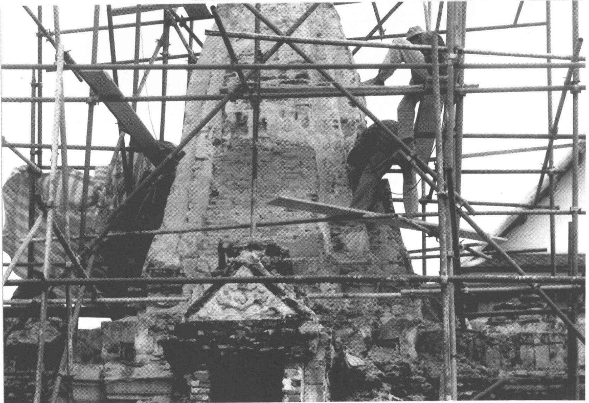
ภาพที่ 46 ขณะสกัดปูนฉาบเดิมที่องค์ระฆังของเจดีย์ราชทิสใต้ (ฟิล์ม4/27a)
