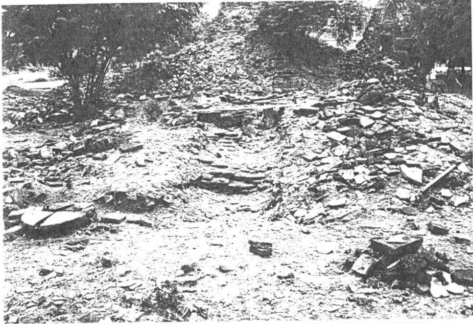
ภาพที่ 7 สภาพก่อนขุดแต่งฐานชุกชีบนโบราณสถานหมายเลข 3 (วิหาร)
