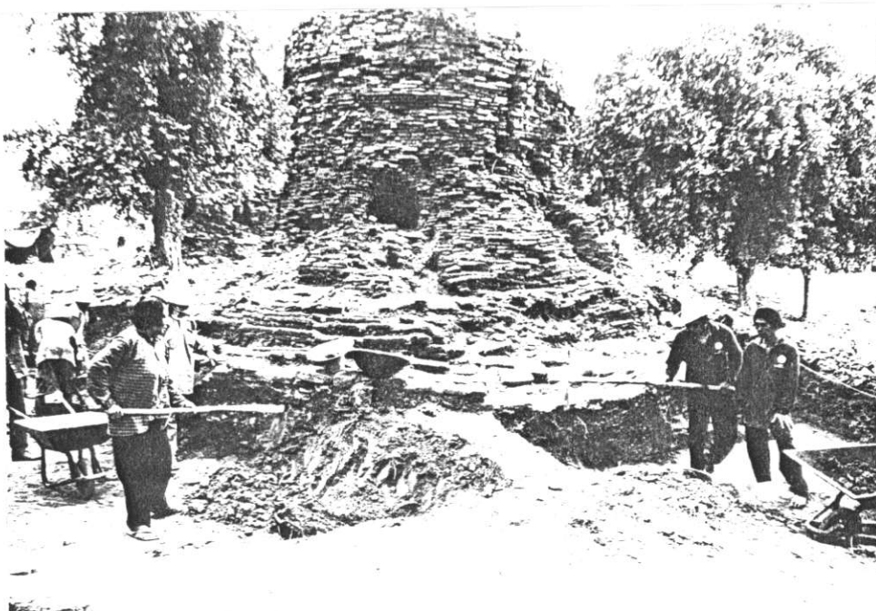
ภาพที่ 5 สภาพโบราณสถานหมายเลข 3 (เจดีย์รายหมายเลข 12) ขณะขุดแต่งด้านตะวันตก
