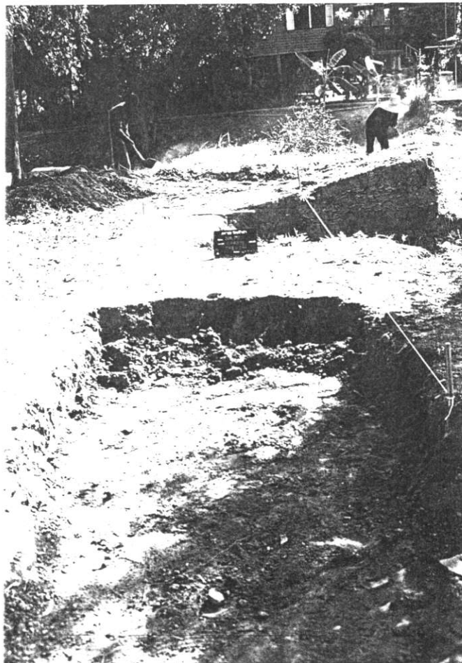
ภาพที่ 30 ขณะกำลังขุดแนว Trench ทางทิศตะวันตก
