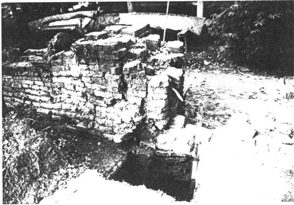
ภาพที่ 7 หลุมขุดตรวจฐานรากซุ้มประตูของแนวกำแพงทิศเหนือ
