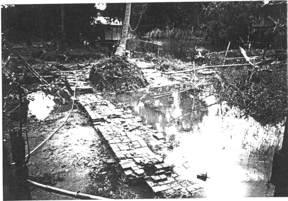
ภาพที่ 14 แนวกำแพงทิศตะวันตกริมคลองสระบัว ขณะถูกน้ำท่วม
