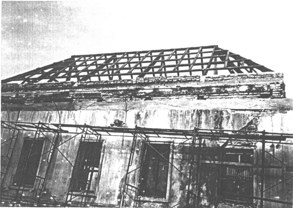
รูปที่ 26 แสดงไม้โครงหลังคาภายหลังการบูรณะ
