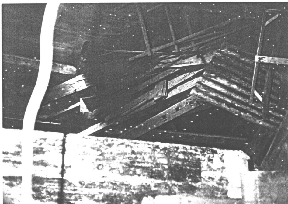
รูปที่ 6 สภาพภายในอาคาร ก่อนการบูรณะ
