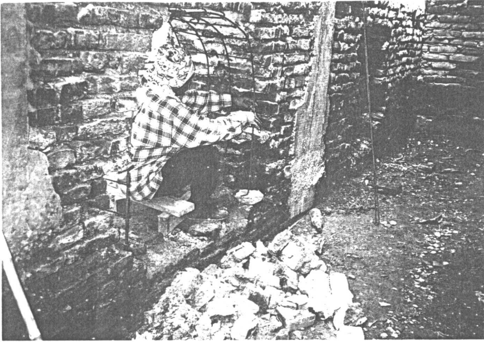
รูปที่ 21 ผูกเหล็กบริเวณช่องคูหาก่อนเสริมเอ็น ค.ศ.ล.
