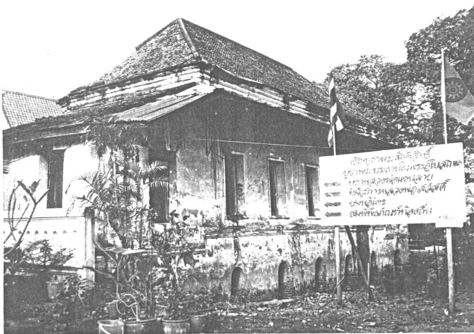
รูปที่ 1 ภาพโดยทั่วไปของอาคาร ก่อนการบูรณะ
