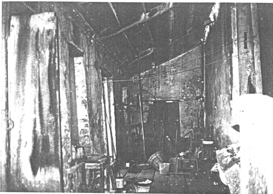
รูปที่ 5 สภาพภายในอาคาร ก่อนการบูรณะ
