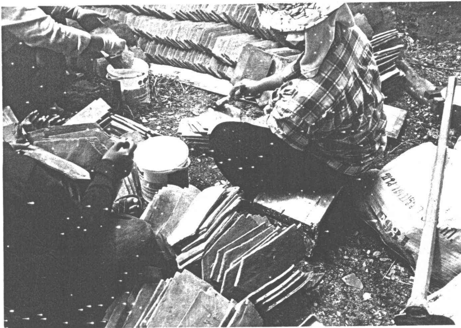
รูปที่ 28 ดำเนินการทาสียาซีเมนต์โคลนกระเบื้องดินเผาungหลังคา
