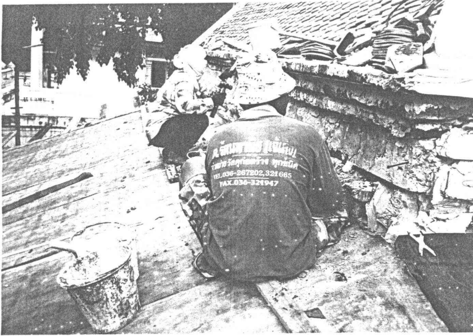
รูปที่ 35 เสริมคาน ค.ส.ล. ทับหลังเหนือเสาระเบียง
