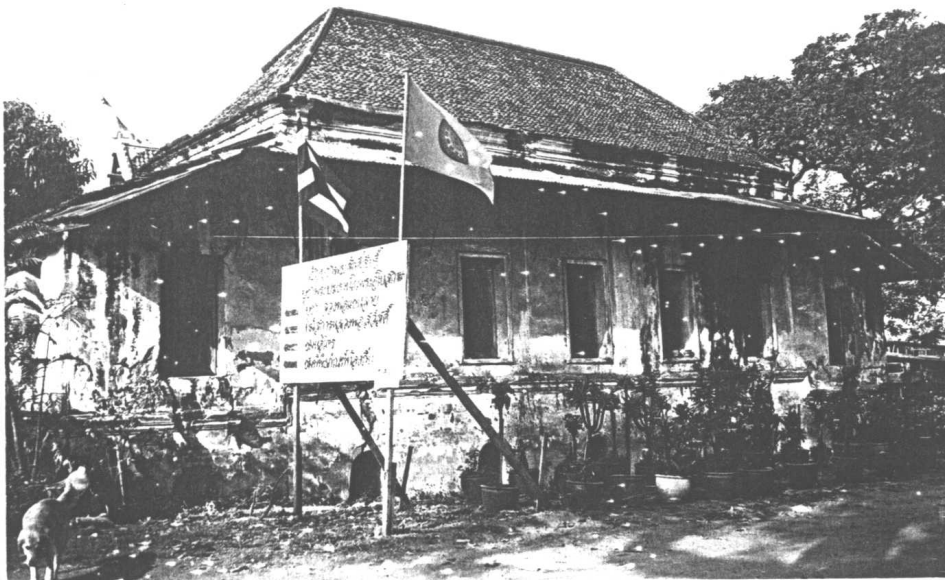
รูปที่ 2 ภาพโดยทั่วไปของอาคาร ก่อนการบูรณะ
