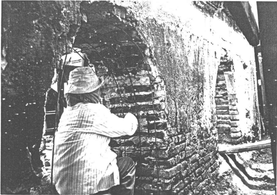
รูปที่ 20 ผูกเหล็กบริเวณช่องคูหาก่อนเสริมเอ็น ค.ศ.ล.
