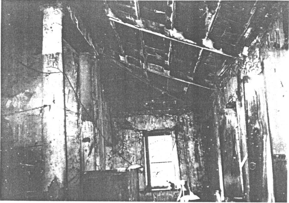
รูปที่ 7 สภาพของฝ้าเพดาน ก่อนการบูรณะ
