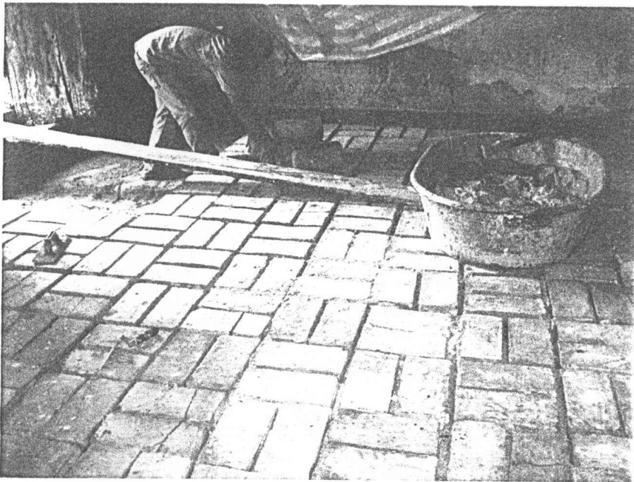
ภาพที่ ๓.๑๓๐ งานปูพื้นด้วยอิฐใหญ่แบบ โบราณยาแนวด้วยปูนขาว
