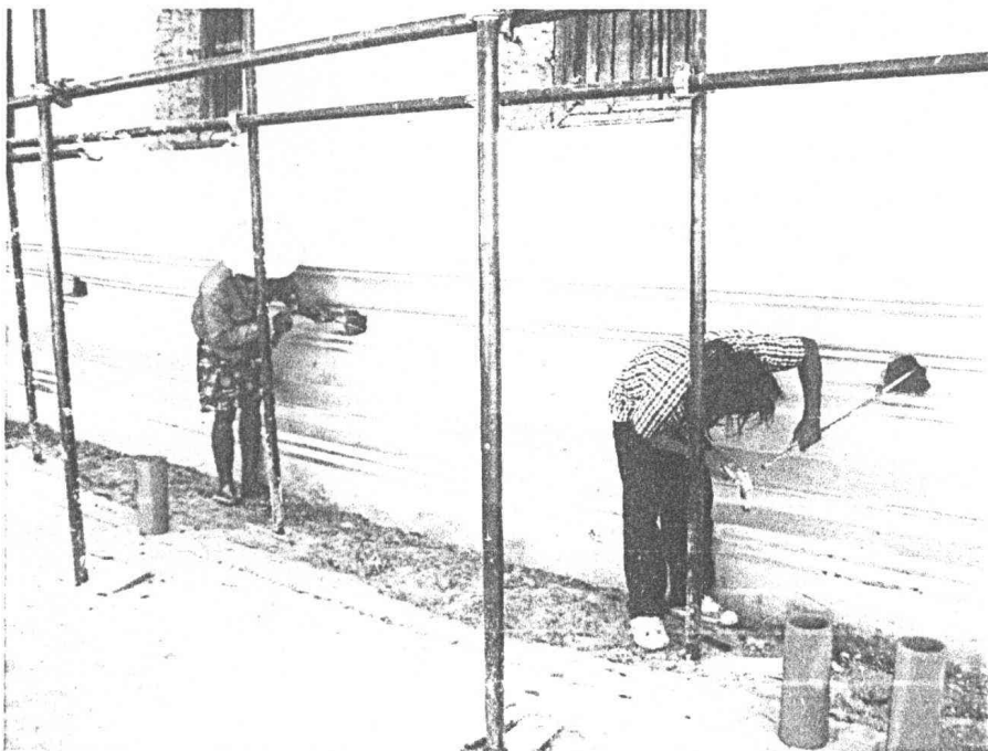
ภาพที่ ๓.๑๔๑ งานเจาะรูติดตั้งท่อระบายความชื้นในผนัง
