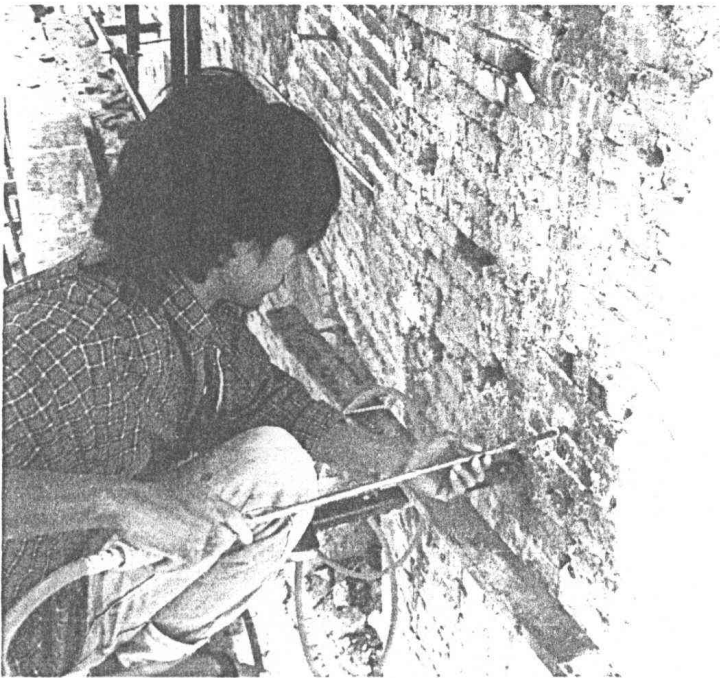
ภาพที่ ๓.๕๖ งานอัดฉีดน้ำปูนทรายในผนัง
