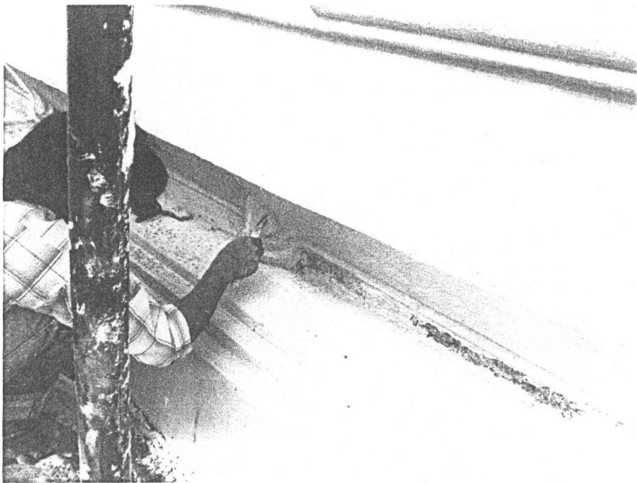
ภาพที่ ๓.๑๐๑ งานจับเพื่อถมฉาบปูนหมักลวดบัวฐานผนัง
