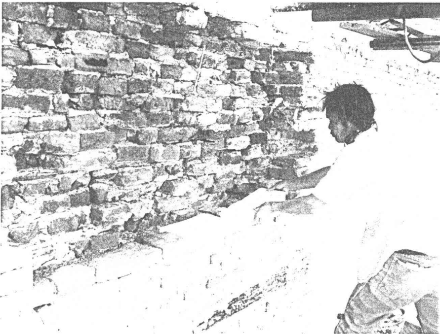
ภาพที่ ๓.๘๒ งานตรวจซ่อมเสริมความมั่นคงผนังเดิม
