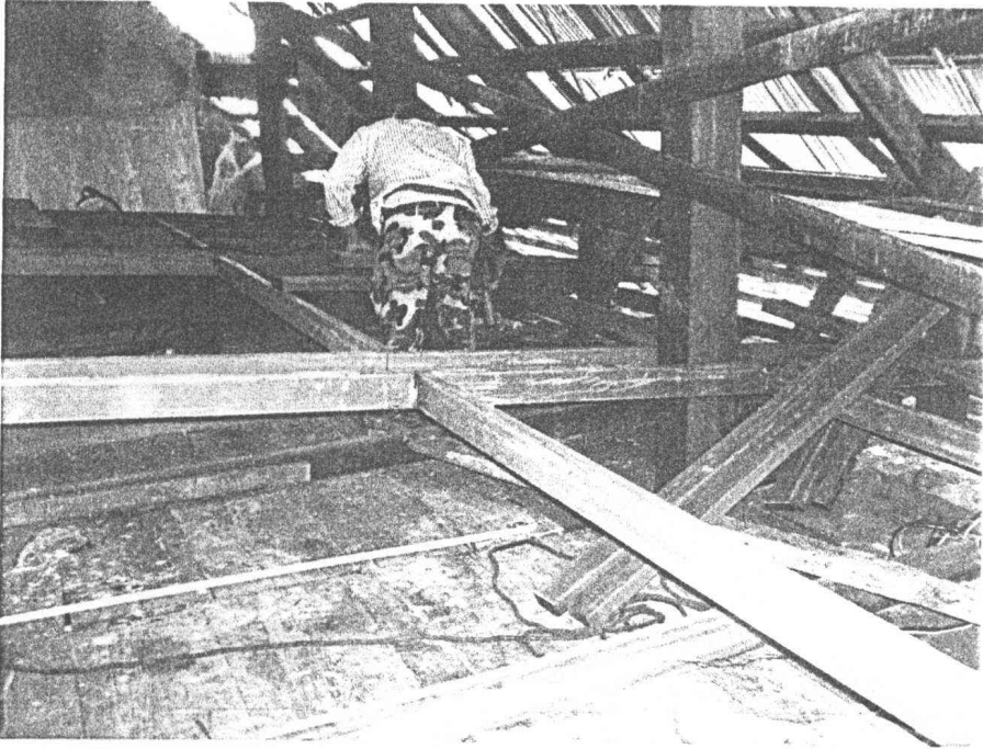
ภาพที่ ๓.๑๑๘ การติดตั้งโครงเหล็กเหนือฝ้าเพดานเพื่อรองรับแผ่นวีว่าบอร์ดป้องกันการรั่วซึม
