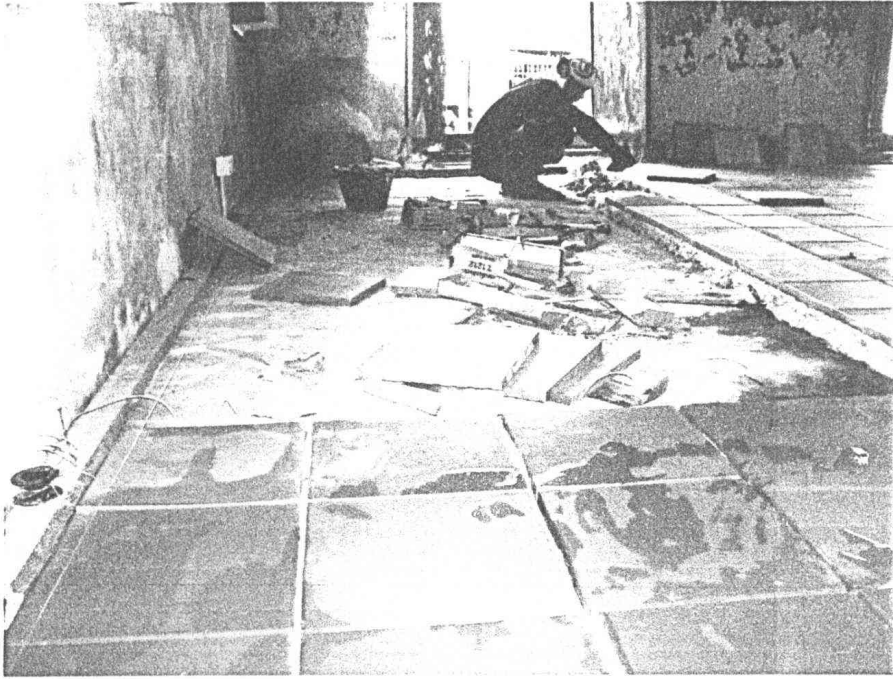
ภาพที่ ๓.๑๓๘ งานปูพื้นด้วยกระเบื้องดินเผา
