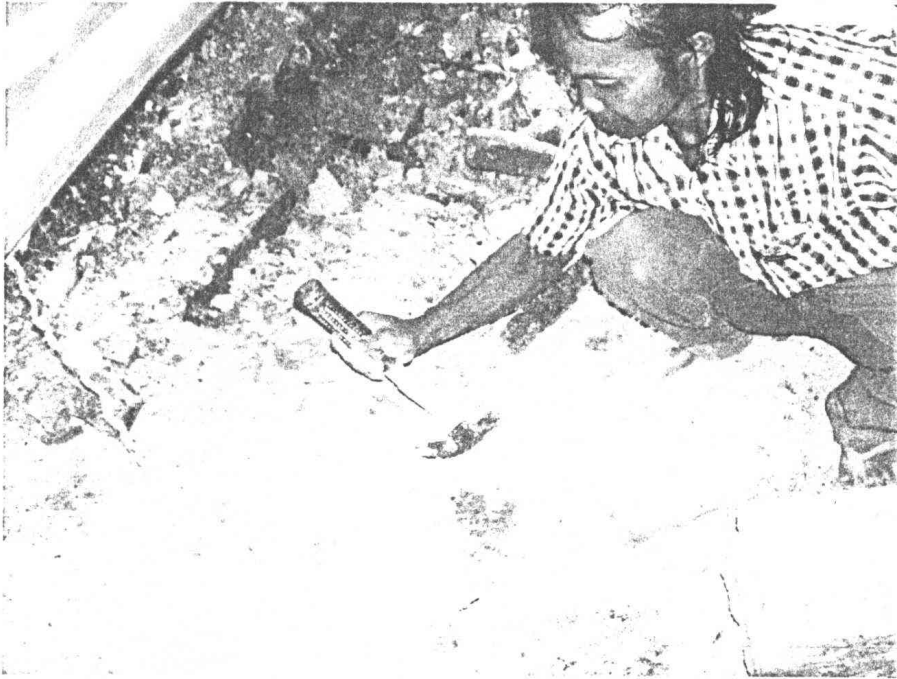
ภาพที่ ๓.๑๒๔ งานรื้อพื้นภายในของเดิม
