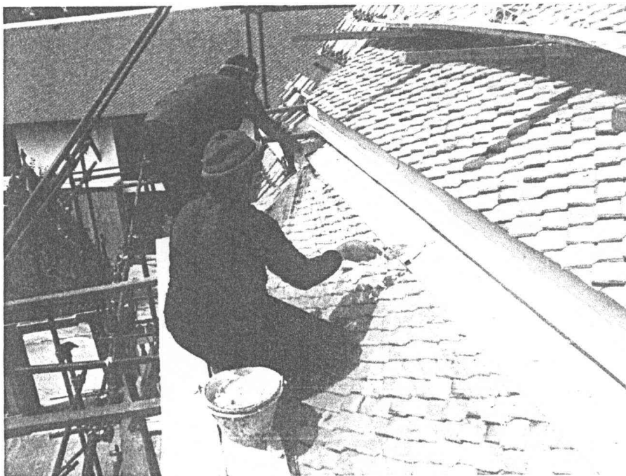
ภาพที่ ๓.๖๕ การปั้นปูนทับหลังหลบแนวกระเบื้องหลังคา
