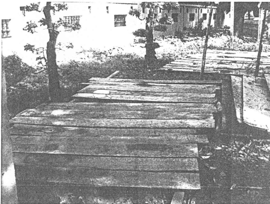
ภาพที่ ๓.๑๑๑ งานจัดทำความสะอาด ไม้ฝ้าเพดานของเดิม
