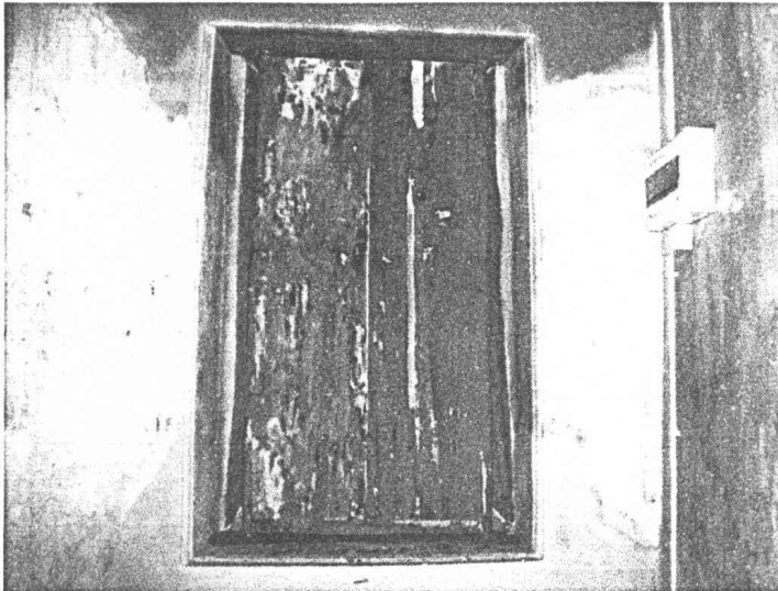
ภาพที่ ๔.๓๘ ซ่อมแซมติดตั้งชุดประตู - หน้าต่างแล้วเสร็จ
