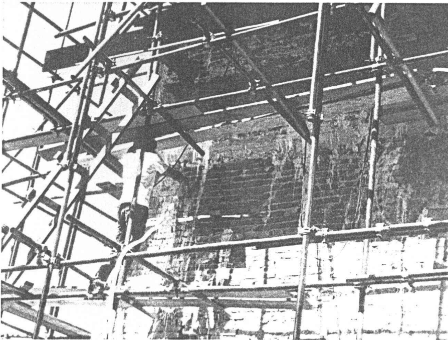
ภาพที่ ๓.๕๔ งานอัดฉีดน้ำปูนทรายในผนัง
