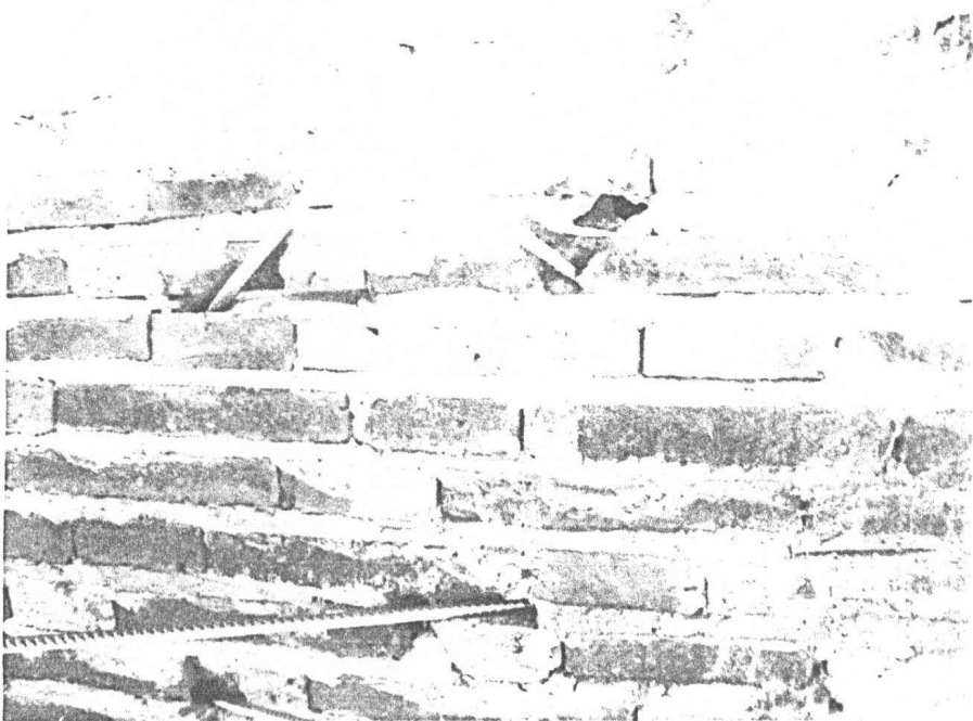
ภาพที่ ๓.๘๒ งานเจาะยึดผนังด้วยเหล็กไร้สนิม
