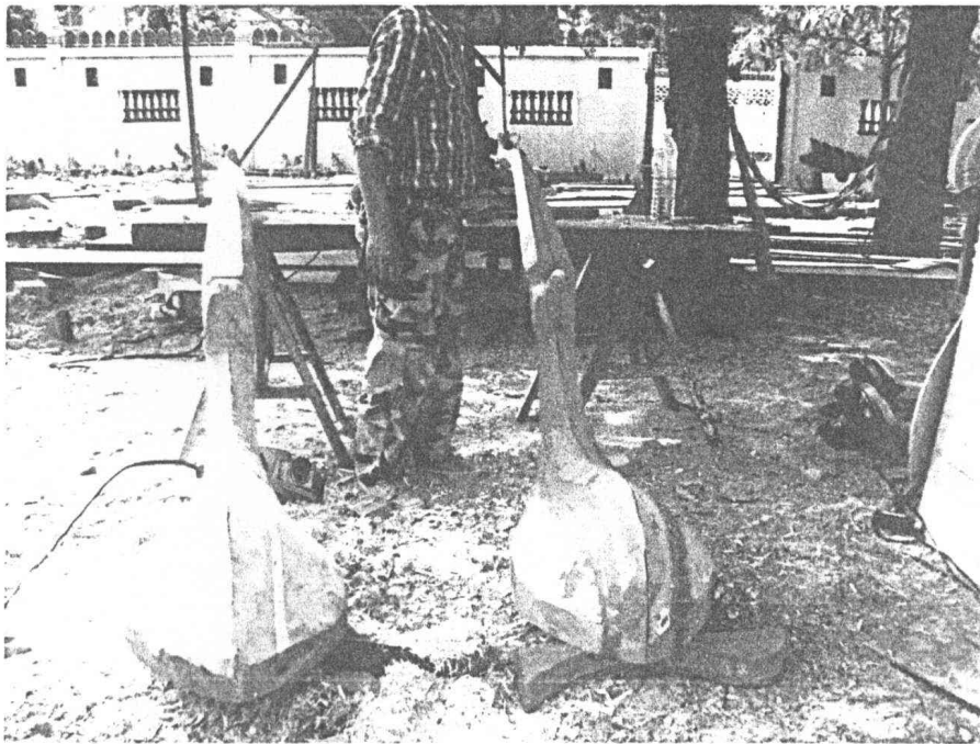
ภาพที่ ๔.๒๖ จัดทำช่อฟ้าใหม่แล้วเสร็จ
