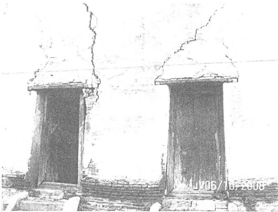
ภาพที่ ๓.๑๗ ช่องประตูอุโบสถ(หลังเก่า)ด้านทิศตะวันออก วัดไม้รวกก่อนการบูรณะ
