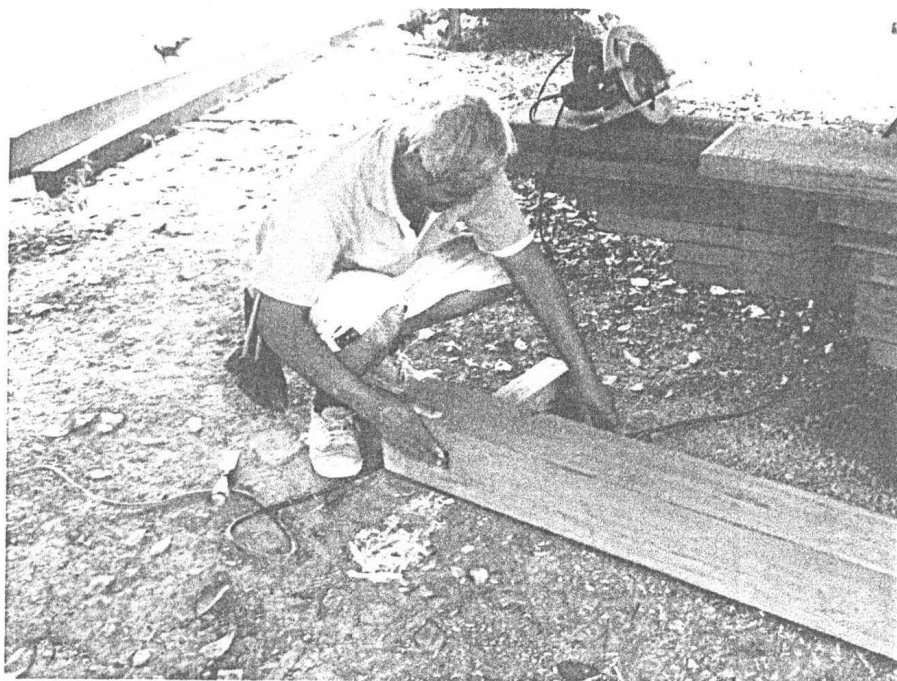
ภาพที่ ๓.๔๐ การปรุงไม้เต้า
