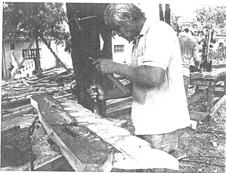
ภาพที่ ๓.๗๓ งานจำหลักไม้ ไม้ตัวถ้ำยอง และใบระกา
