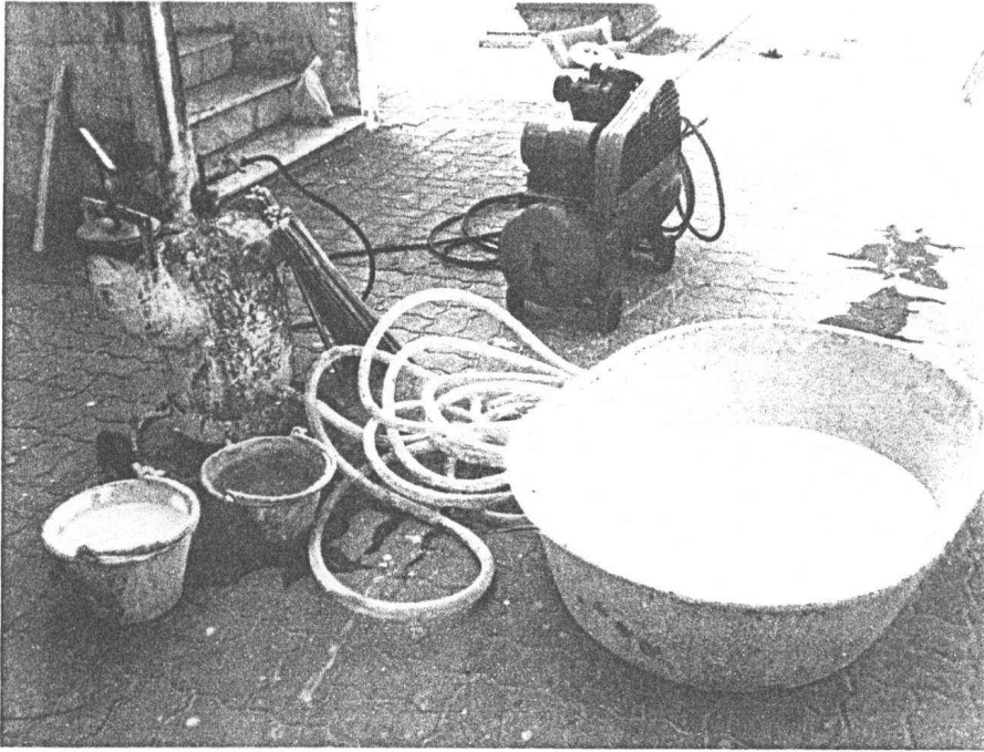
ภาพที่ ๓.๕๓ งานเตรียมการอัดฉีดน้ำปูนทรายในผนัง
