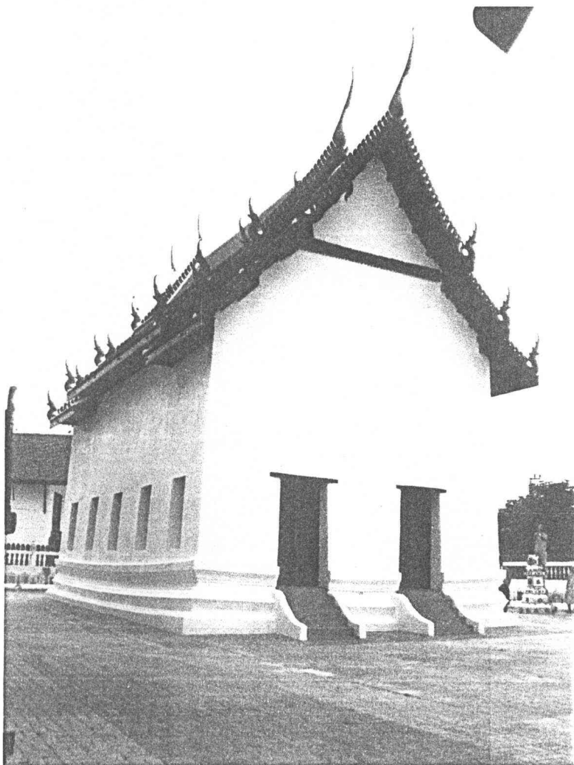
ภาพที่ ๕.๑ ภายนอกอุโบสถ(หลังเก่า)หลังการบูรณะแล้วเสร็จ
