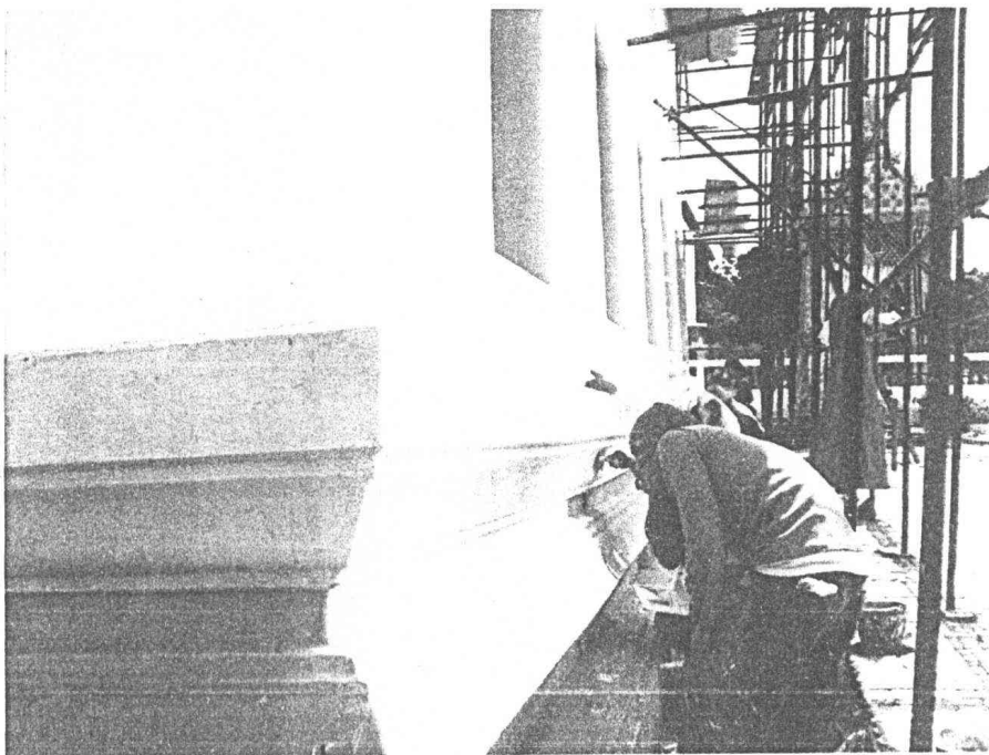
ภาพที่ ๓.๑๐๘ งานขัดผิวปูนตำลวดบัวฐานผนัง
