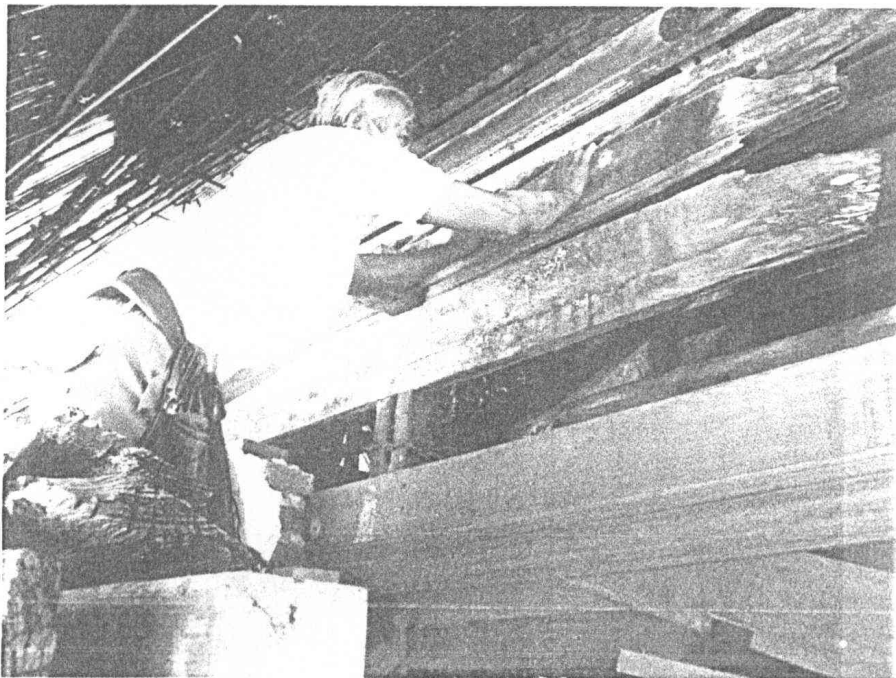
ภาพที่ ๓.๓๗ การตรวจสอบเสริมความมั่นคงไม้โครงสร้างหลังคา
