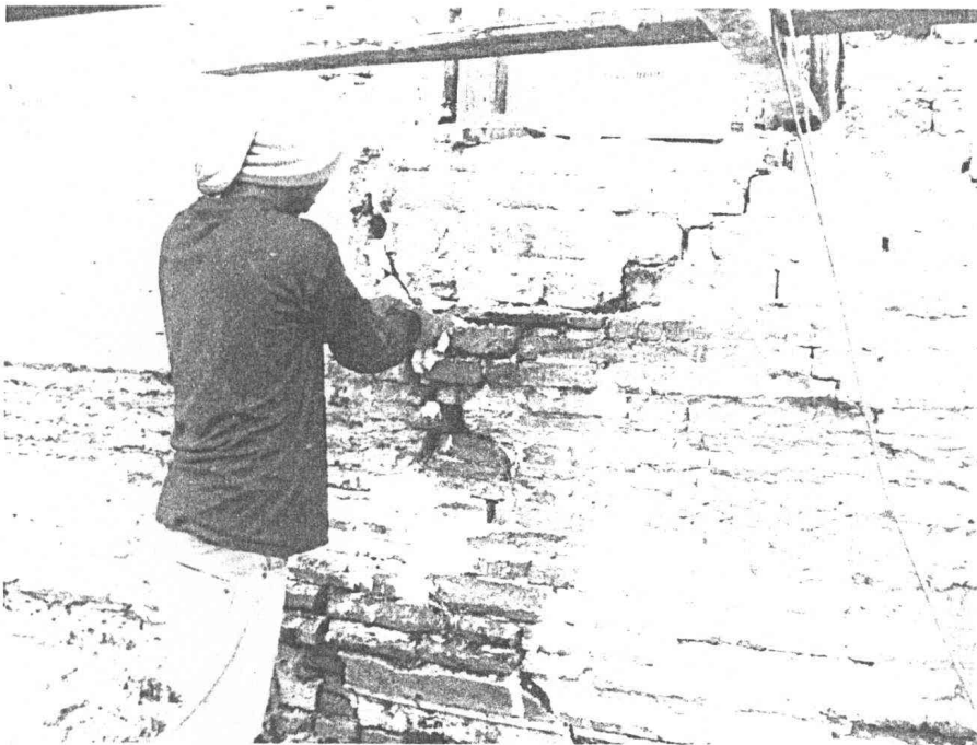
ภาพที่ ๓.๘๕ งานตรวจซ่อมเสริมความมั่นคงผนังเดิม
