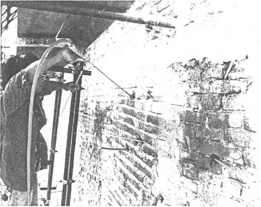
ภาพที่ ๓.๕๕ งานอัดฉีดน้ำปูนทรายในผนัง
