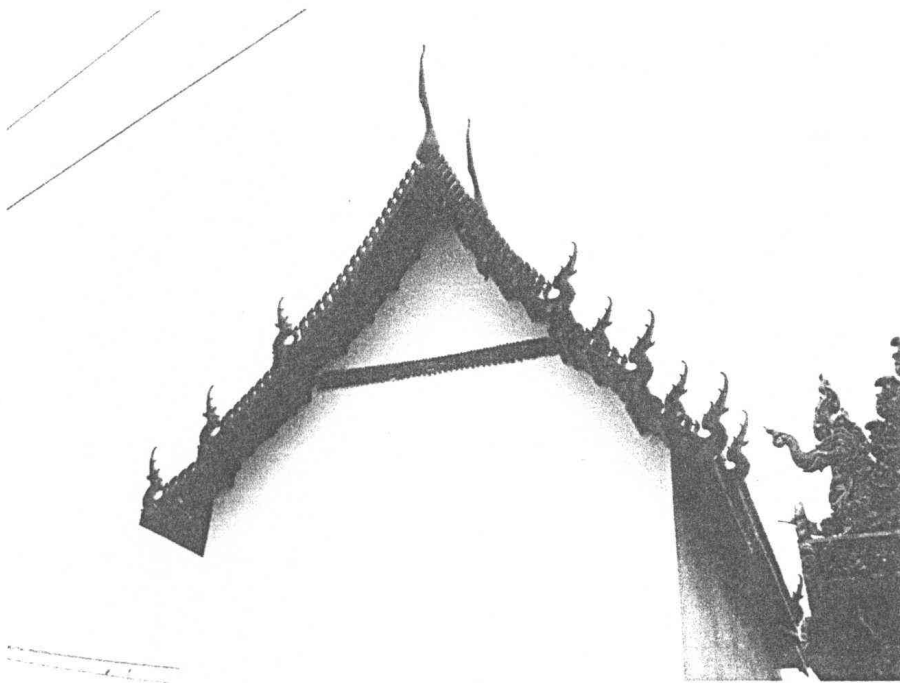
ภาพที่ ๕.๒ ภายนอกอุโบสถ(หลังเก่า)หลังการบูรณะแล้วเสร็จ
