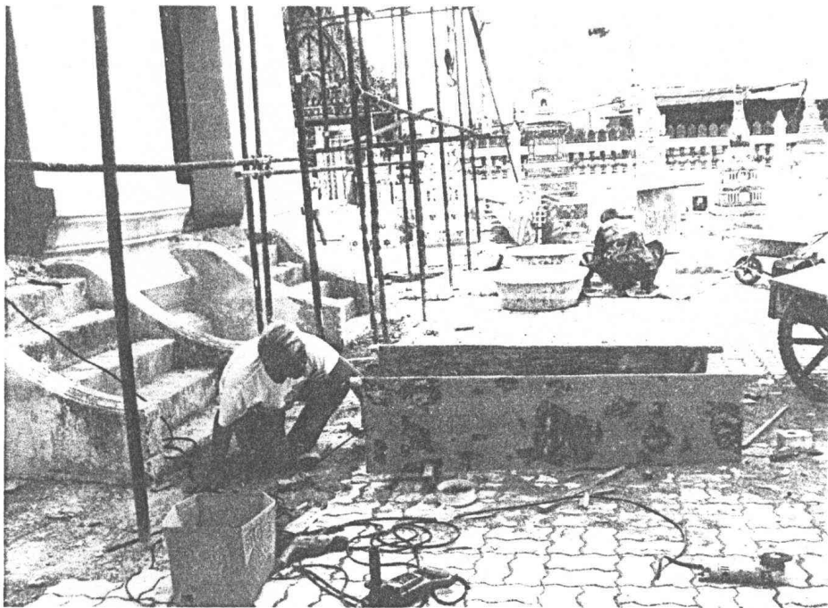
ภาพที่ ๓.๑๔๕ งานติดตั้งครกทองเหลืองชุดประตู่ - หน้าต่าง
