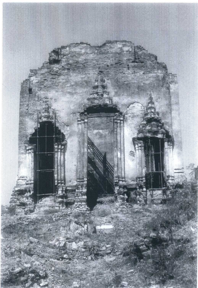
4.อุโบสถก่อนการขุดแต่ง (ฟิล์มหมายเลข1/1)
