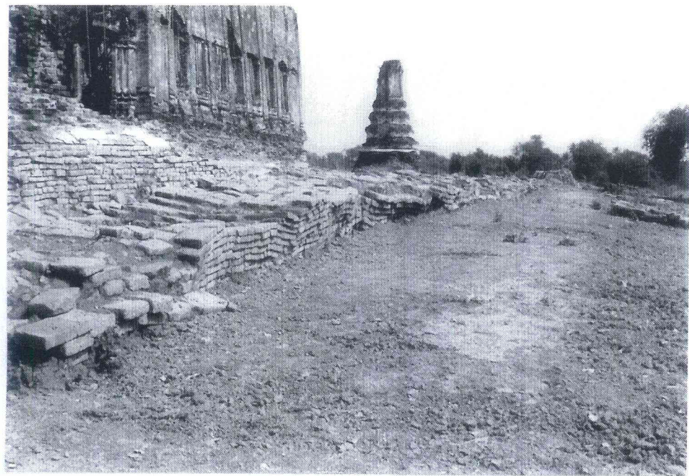
33. แนวกำแพงแก้วล้อมรอบเขตพุทธาวาสด้านทิศใต้ หลังการขุดแต่ง (ฟิล์มหมายเลข 16/17)
