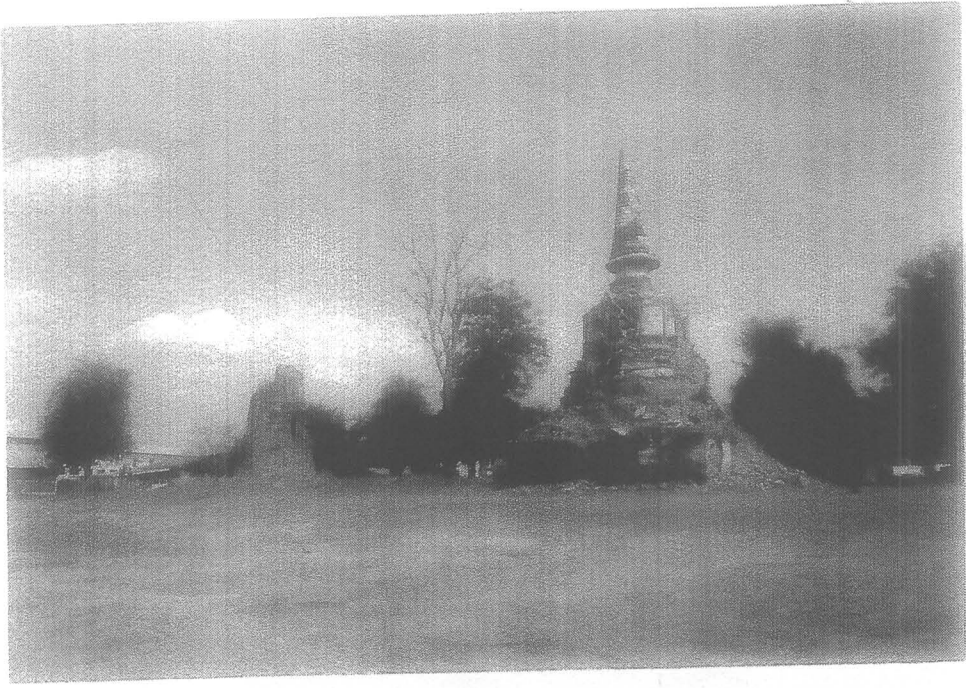
ภาพที่ 1 โบราณสถานวัดหัตถดาบาสก่อนการขุดแต่ง (ฟิล์มม้วนที่ 2/5 )
