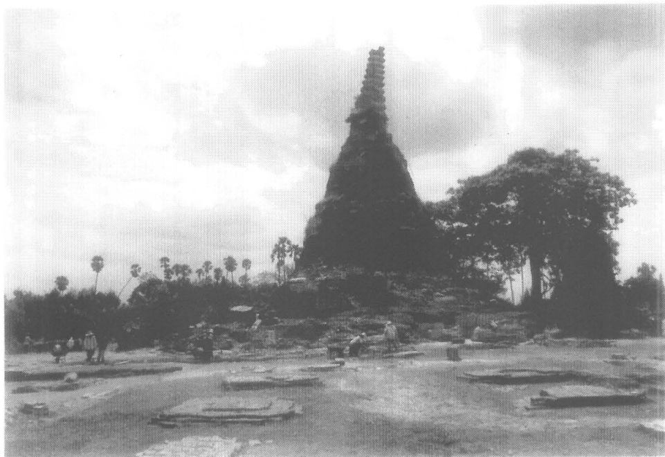
รูปที่ 15 สภาพหลังการขุดแต่งอุโบสถและเจดีย์ประธาน (ฟิล์ม 5/36)
