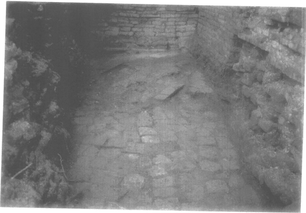
รูปที่ 117 แนวอิฐปูพื้นสมัยที่ 1 ภายในหลุมทดสอบของเจดีย์ประธาน (ฟิล์ม 9/9)
