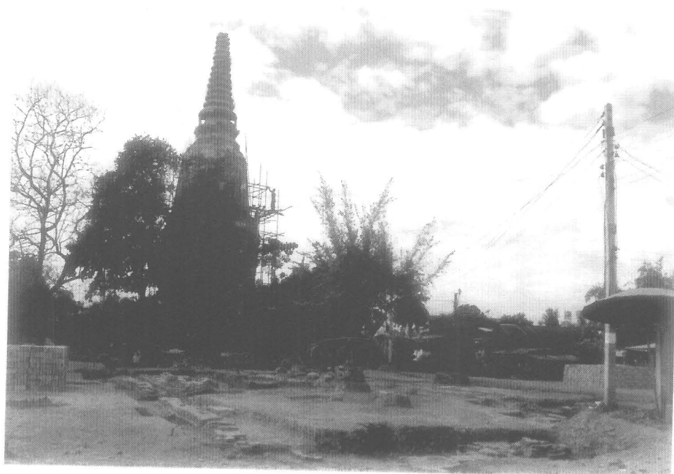
รูปที่ 40 วิหารหลังการขุดแต่งด้านทิศตะวันออก (ฟิล์ม 6/11)
