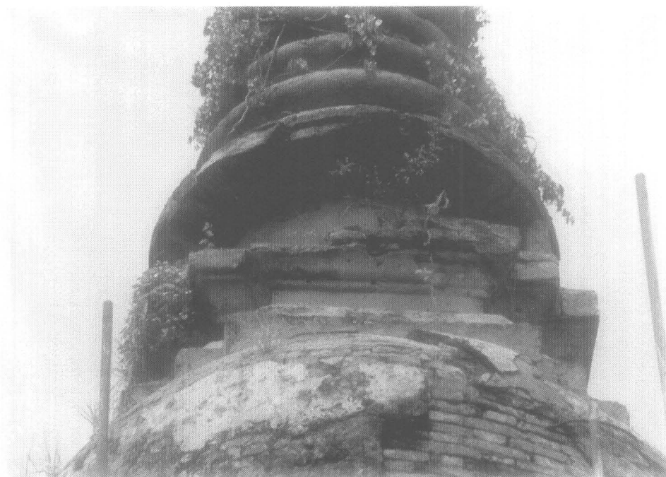
รูปที่ 32 ชุดฐานบัลลังก์ย่อมุมไม้สิบสอง (ฟิล์ม 4/13)
