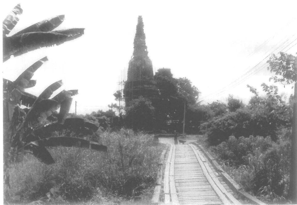
รูปที่ 20 สภาพทั่วไปของวัดด้านทิศตะวันตก (ฟิล์ม 2/16)
