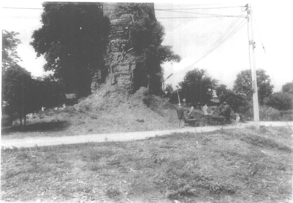
รูปที่ 16 สภาพพื้นที่ของกำแพงวัดด้านทิศเหนือก่อนการขุดแต่ง (ฟิล์ม 1/20)
