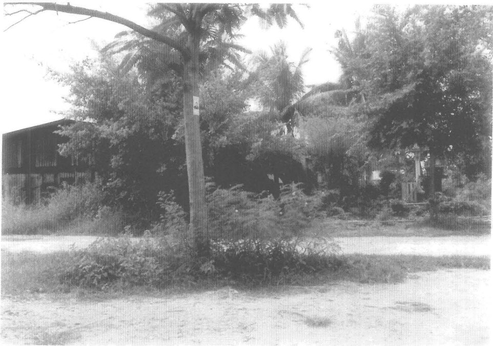
รูปที่ 14 สภาพก่อนการขุดแต่งของวิหารด้านทิศเหนือ (ฟิล์ม 2/4)
