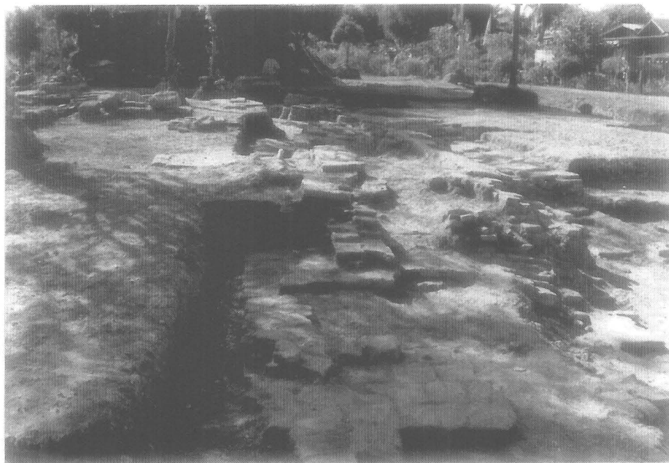
รูปที่ 49 ผนังวิหารทิศเหนือมีสภาพที่พังทลายลงมาจากแรงกดทับของถนน (ฟิล์ม 5/34)
