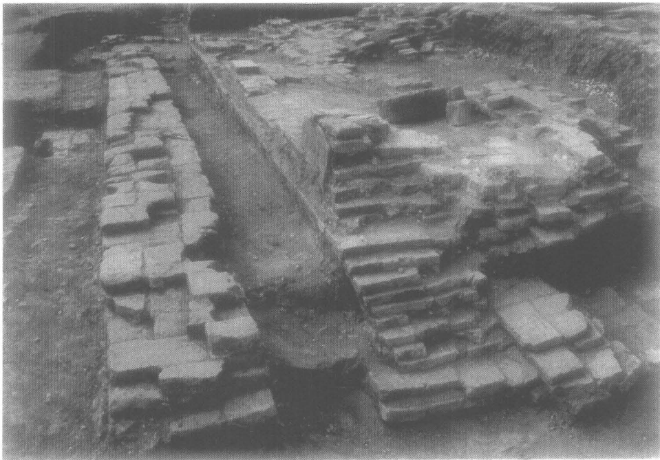
รูปที่ 46 วิหารหลังการขุดแต่งด้านทิศใต้ (ฟิล์ม 6/28)
