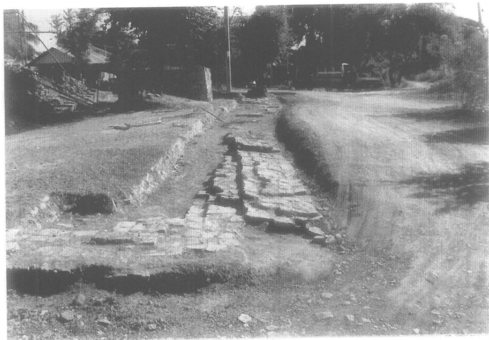
รูปที่ 55 กำแพงวัดทิศตะวันตกหลังการขุดแต่ง (ฟิล์ม 5/39)
