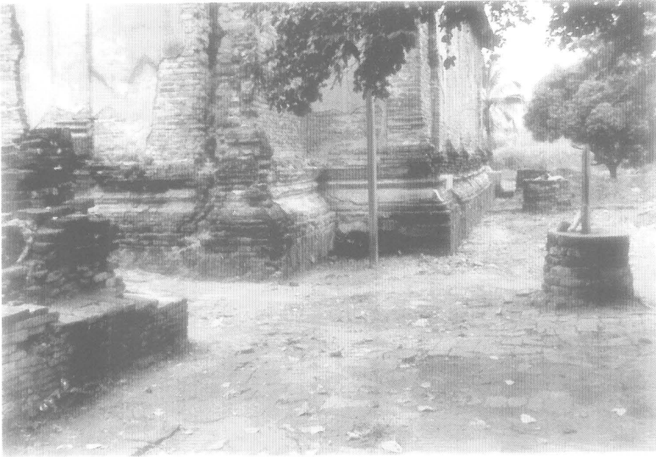
รูปที่ 60 พื้นบริเวณของอุโบสถ (14/3)
