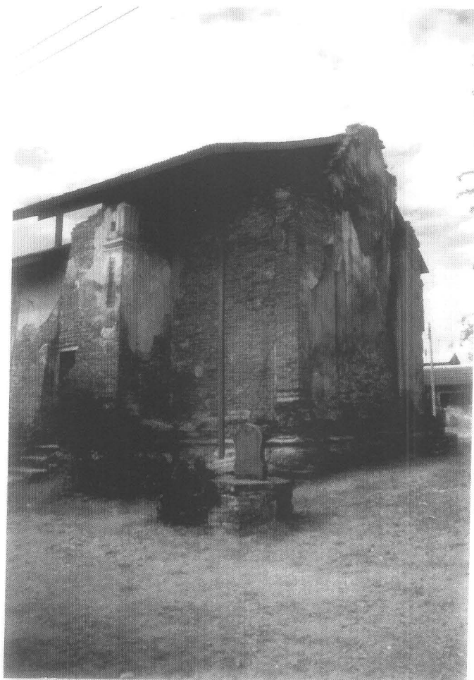
รูปที่ 13 อุโบสถ สภาพก่อนการบูรณะ ด้านทิศตะวันออก (1/23)
