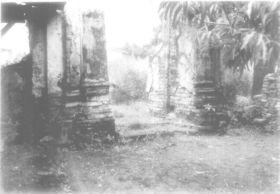
รูปที่ 91 กำแพงวัดหลังการขุดแต่ง (13/15)
