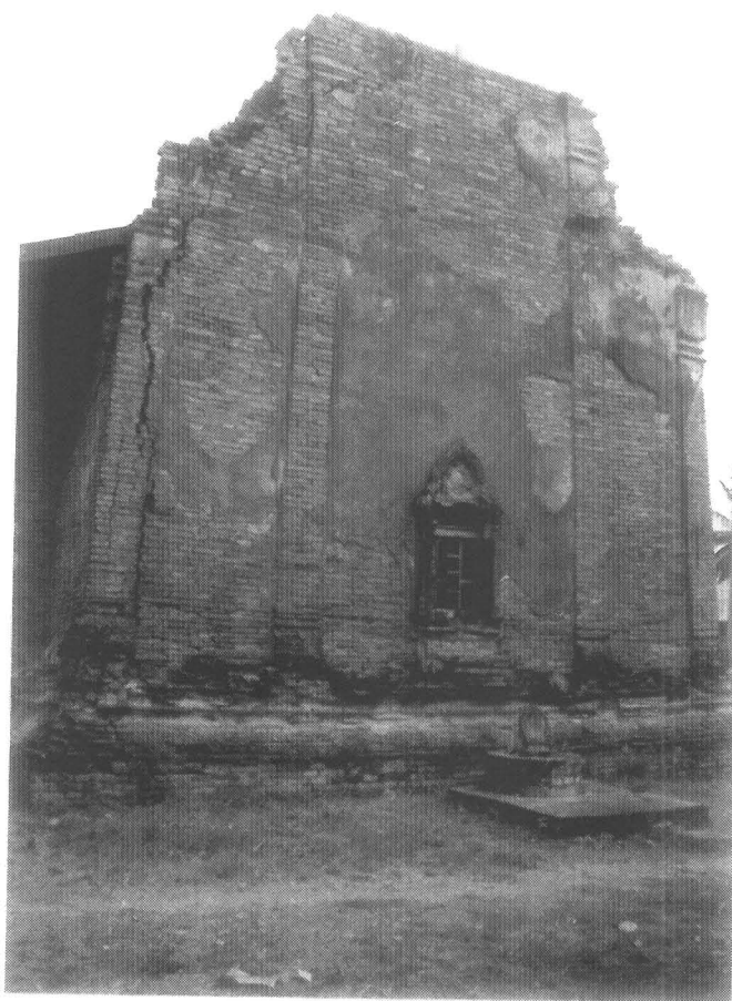
รูปที่ 14 อุโบสถ สภาพก่อนการบูรณะ ด้านทิศตะวันตก (1/27)
