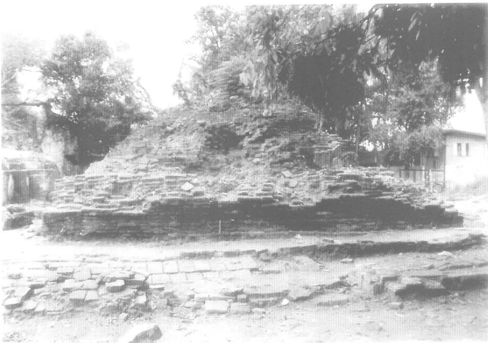
รูปที่ 71 เจดีย์มณฑลทิศตะวันออกเฉียงเหนือ (หมายเลข 5) หลังการขุดแต่ง (11/19)
