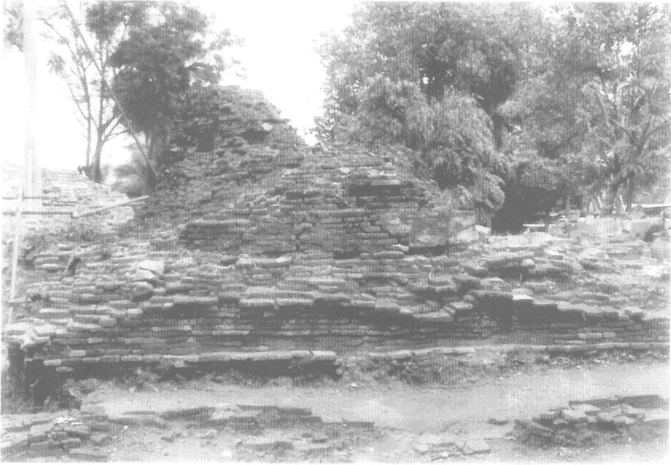
รูปที่ 74 เจดีย์มุนทิสตะวันออกเฉียงใต้ (หมายเลข 6) หลังการขุดแต่ง (11/13)
