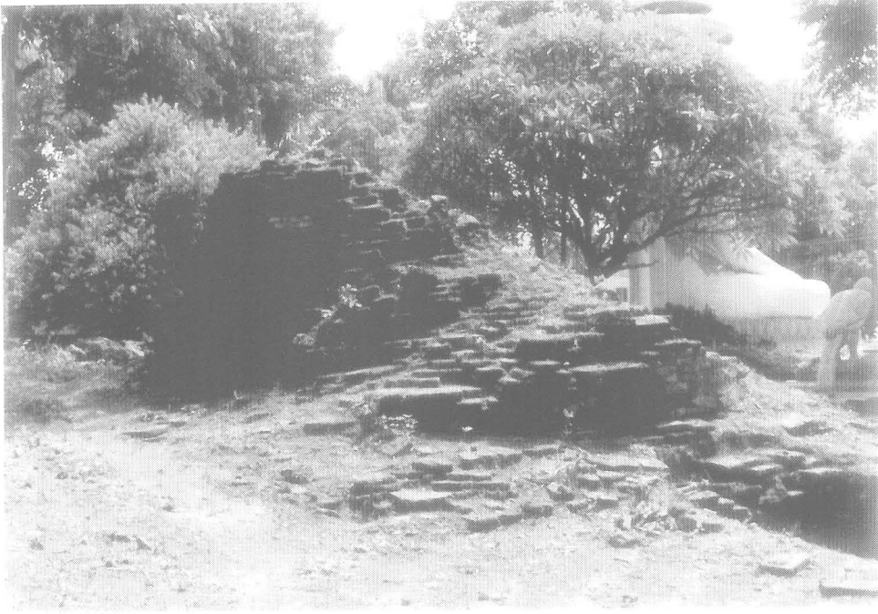
รูปที่ 21 เจดีย์มุนีศตะวันออกเฉียงใต้ (หมายเลข 6) สภาพก่อนการขุดแต่ง (3/17)
