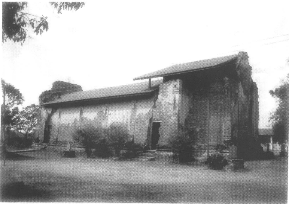
รูปที่ 12 อุโบสถ สภาพก่อนการขุดแต่งด้านทิศใต้ (1/22)
