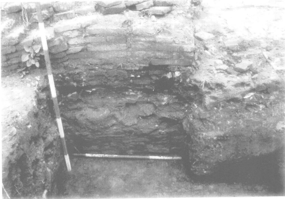
รูปที่ 70 การขุดตรวจสอบฐานเจดีย์ทรงระฆังหมายเลข 4 (12/35)
