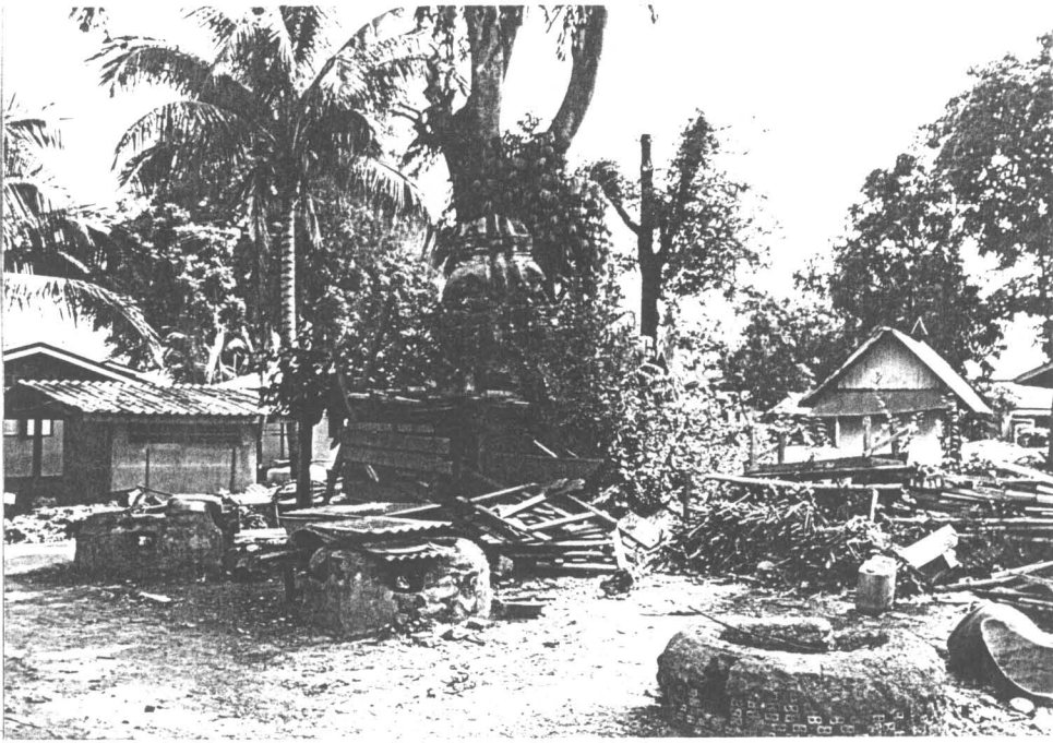
ภาพถ่ายที่ 13 สภาพก่อนการขุดแต่งบริเวณหัวเม็ดมูกำแพง (ฟิล์ม 5/6)
