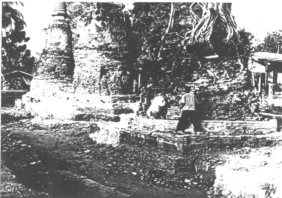
ภาพถ่ายที่ 7 ทำการก่ออิฐลดหลั่นตามชั้นอิฐเดิมของเจดีย์หมายเลข 2 แบบรักษาสภาพ (ฟิล์ม 23/35)
