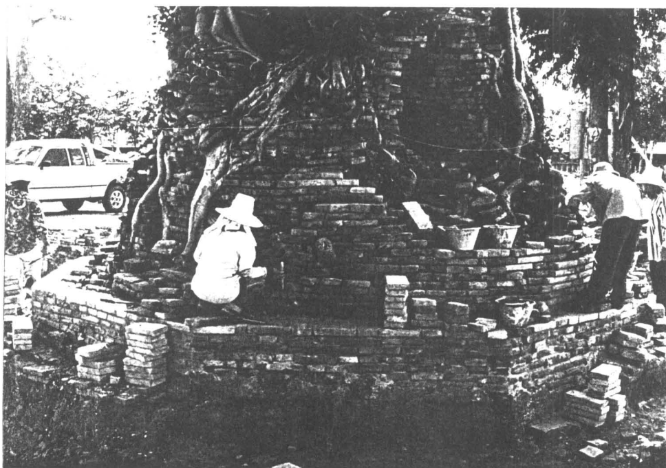
ภาพถ่ายที่ 5 ทำการก่ออิฐตามหลักฐานเดิม เพื่อปิดแนวเขตลานคอนกรีต (ฟิล์ม 23/34)
