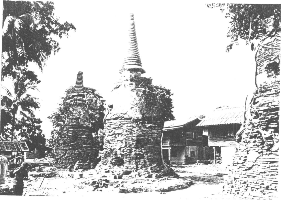
ภาพถ่ายที่ 35 พื้นที่หลังการขุดแต่งระดับ 30 ซม.จากผิวดิน บริเวณเจดีย์รายหมายเลข 3 (ฟิล์ม 8/33A)
