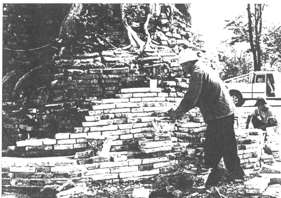
ภาพถ่ายที่ 6 ทำการก่ออิฐลดหลั่นตามชั้นอิฐเดิมของเจดีย์หมายเลข 2 ที่เหลืออยู่ แบบรักษาสภาพ (ฟิล์ม 23/29)
