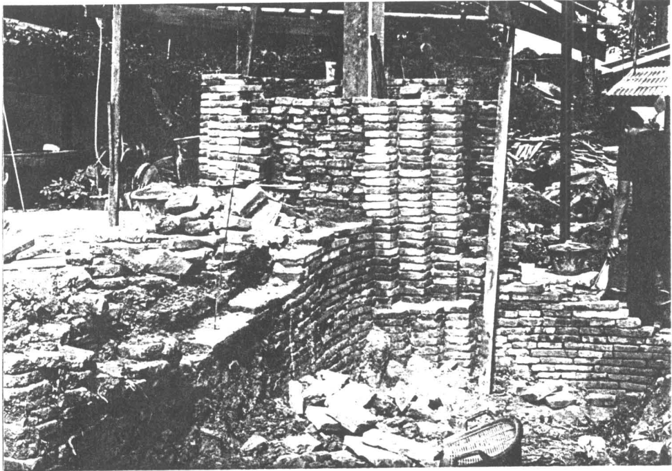
ภาพถ่ายที่49 ก่ออิฐปิดโครงสร้างภายในหัวเม็ดมูกำแพง (ฟิล์ม 24/9)
