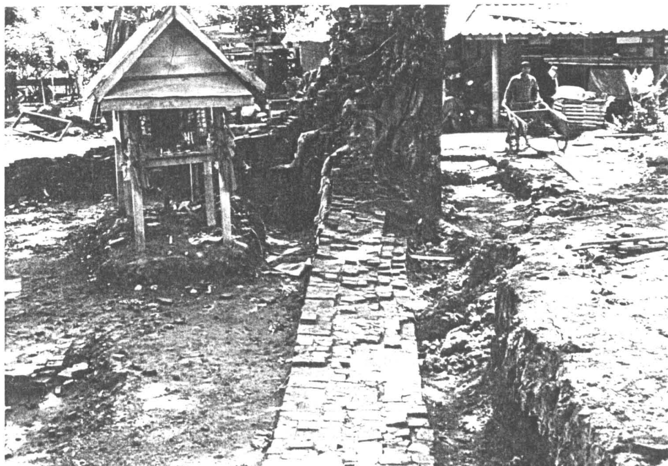
ภาพถ่ายที่ 48 สภาพแนวกำแพงทางทิศเหนือภายหลังจากการขุดแต่ง (ฟิล์ม 13/34)
