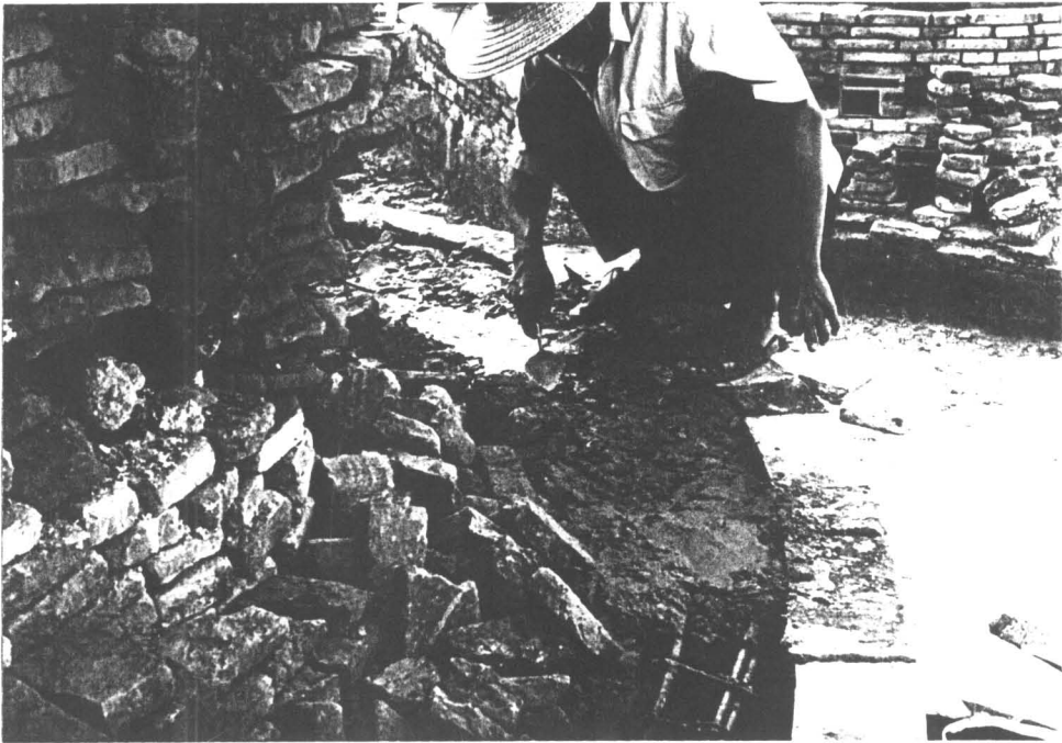
ภาพถ่ายที่15 ทำการเพนทับคานคอนกรีตเสริมเหล็ก เพื่อให้การก่ออิฐใหม่เชื่อมประสานกับอิฐ อย่างมั่นคงแข็งแรง ของเจดีย์หมายเลข 3 (ฟิล์ม23/32)
