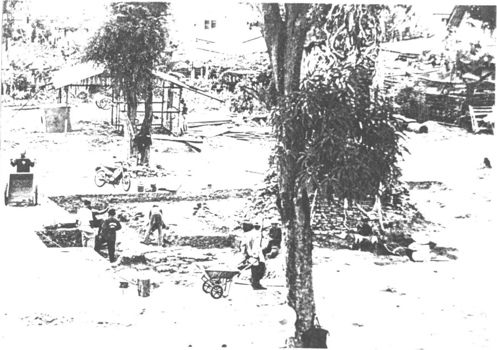
ภาพถ่ายที่ 27 การขุดตรวจพื้นที่บริเวณทิศใต้ของเจดีย์รายหมายเลข 2 ก่อนการขุดแต่งที่บริเวณกลุ่มเจดีย์ราย (ฟิล์ม 8/26A)
