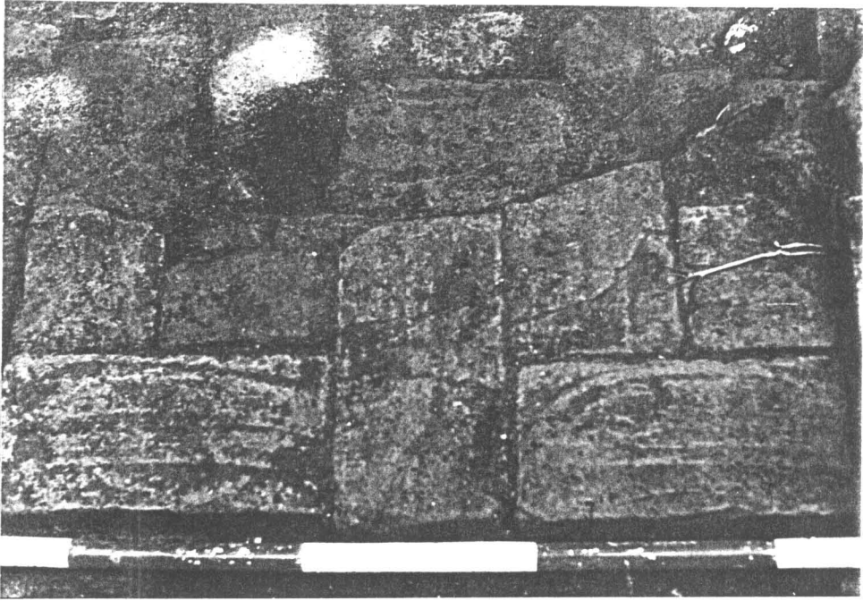
ภาพถ่ายที่ 49 เทคนิคการก่ออิฐของแนวกำแพง เป็นแบบวางอิฐต้นสลับยาว (ฟิล์ม 14/24A)
