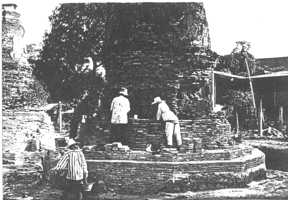
ภาพถ่ายที่18 การก่ออิฐรอบฐานบัวถูกแก้วปิดทับแนวคาน ของเจดีย์หมายเลข 3 (ฟิล์ม22/1)
