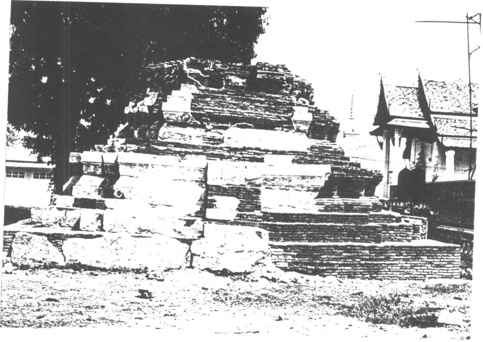
ภาพถ่ายที่ 63 สภาพระปรารงค์ด้านทิศตะวันตกภายหลังการบูรณะแล้วเสร็จ (ฟิล์ม 25/15)
