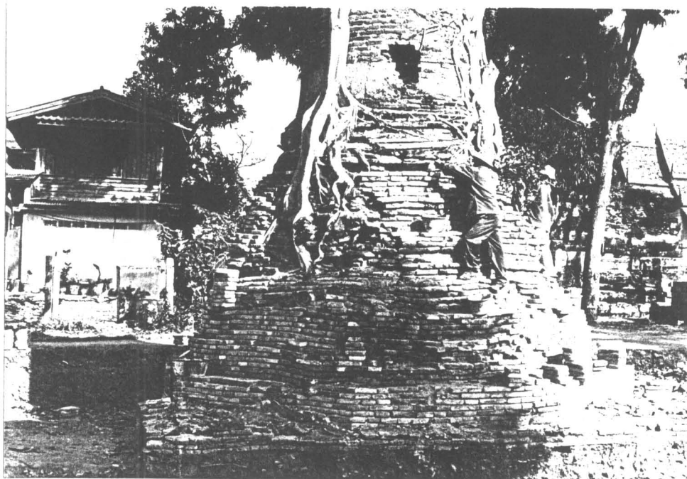
ภาพถ่ายที่ 8 การก่ออิฐลดหลั่นบริเวณบัวลูกแก้วของเจดีย์หมายเลข 2 ตามแนวอิฐเดิมที่เหลืออยู่ แบบรักษาสภาพ (ฟิล์ม 22/0)
