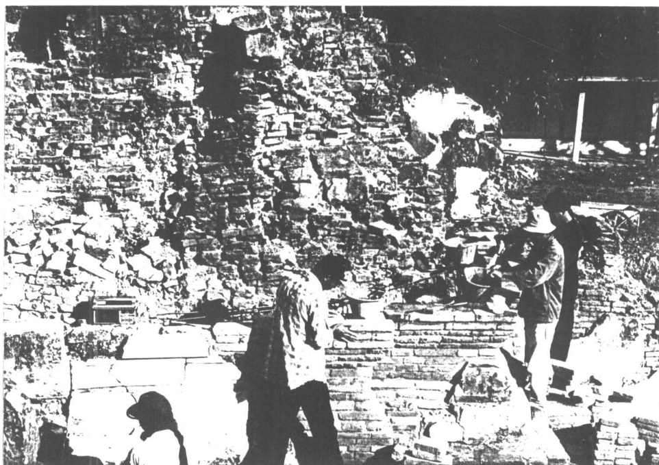
ภาพถ่ายที่43 การก่ออิฐปิดโครงสร้างคานคอนกรีต ที่ส่วนฐานมุ่มพระปรางค์ด้าน ตะวันออกเฉียงใต้(ฟิล์ม 24/28)
