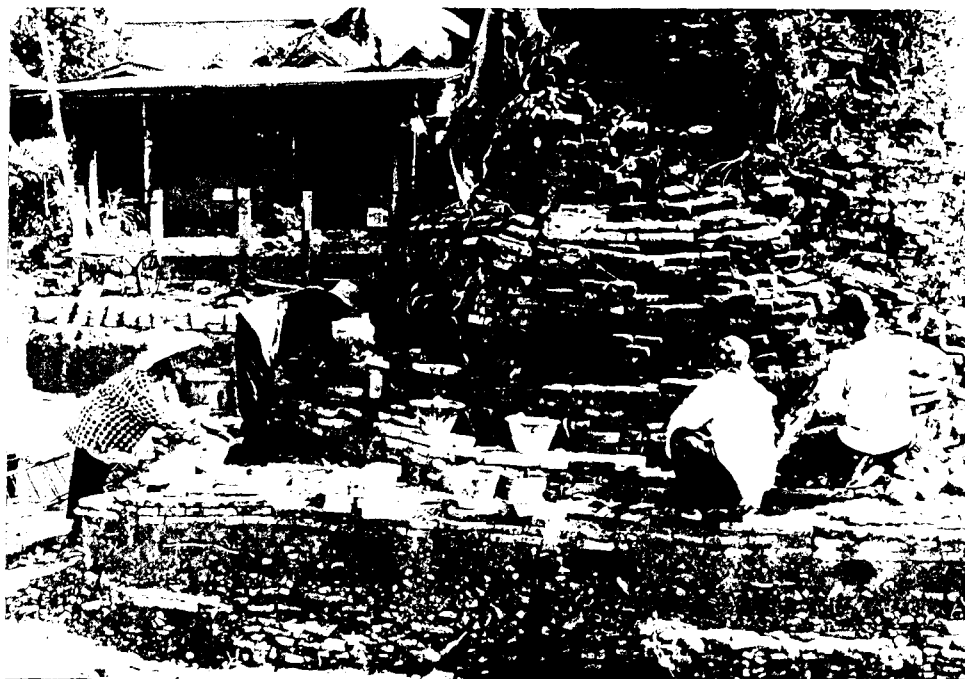
ภาพถ่ายที่2 การก่ออิฐเสริมฐานล่างด้านทิศใต้ และตะวันตก ของเจดีย์หมายเลข2 (ฟิล์ม23/26)
