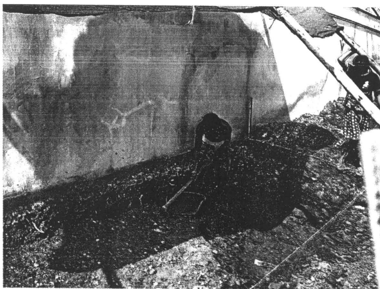
ภาพที่ 40 ขณะทำการขุดตรวจ
