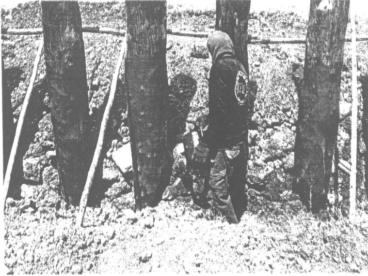
ภาพที่ 131 การราดน้ำยากำจัดปลวกบริเวณโคนเสา
