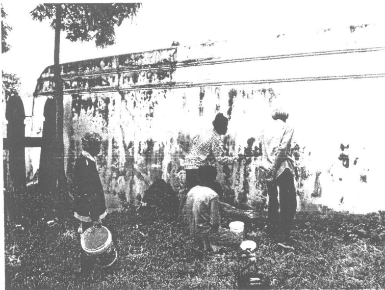
ภาพที่ 137 การสำรวจเตรียมทำความสะอาดขัดล้างสีเดิมของพื้นผิวเดิมของเชิงเทียนออก
