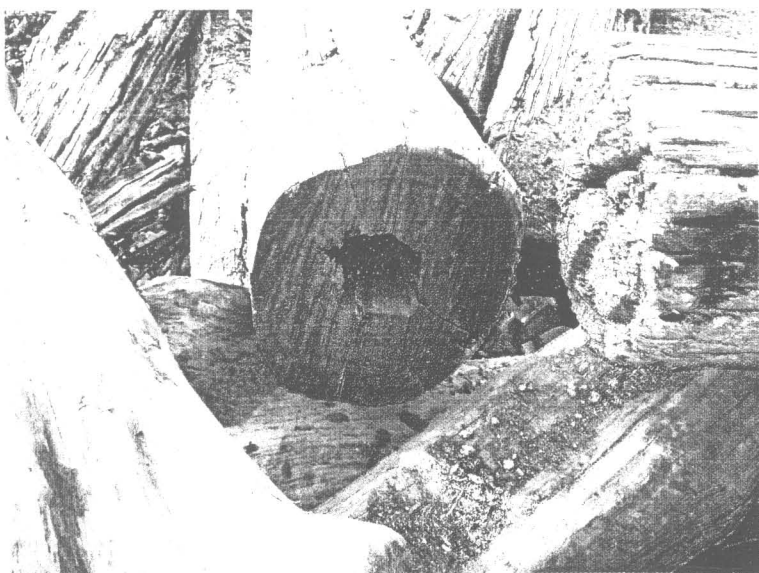
ภาพที่ 122 การตัดเปลี่ยนหัวเสา
