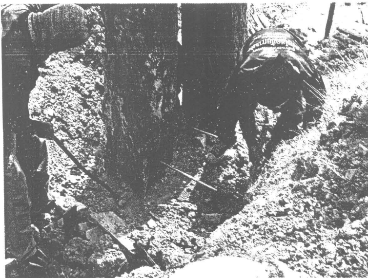
ภาพที่ 128 การติดตั้งเสาเข้ากับเพลาเหล็ก
