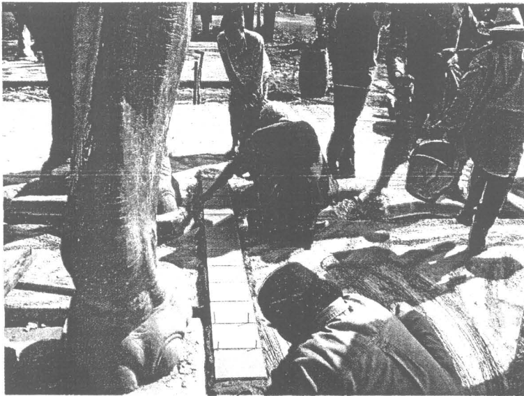
ภาพที่ 153 การปูกระเบื้องดินเผาพื้นแท่นฐาน
