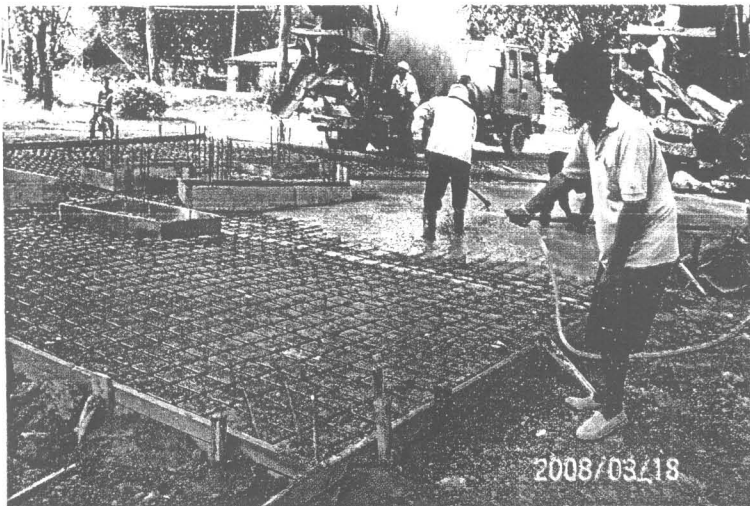
ภาพที่ 151 การก่อสร้างแทนฐานรองรับประติมากรรมรูปช้าง
