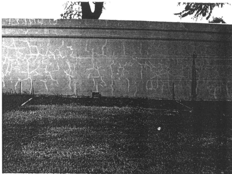
ภาพที่ 33 หลุมขุดตรวจ 1 สภาพก่อนการขุดตรวจ
