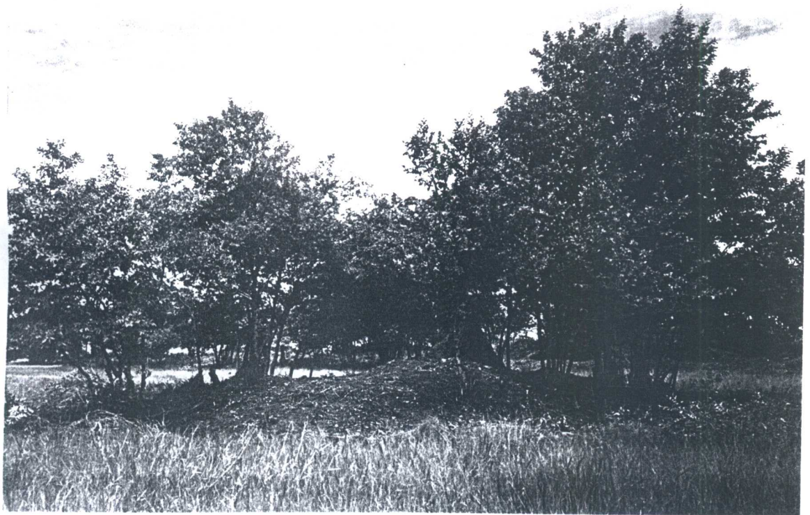
7. ภาพเนิน 2.1 ก่อนการขุดแต่งด้านทิศใต้ (ฟิล์มหมายเลข 2/4)
