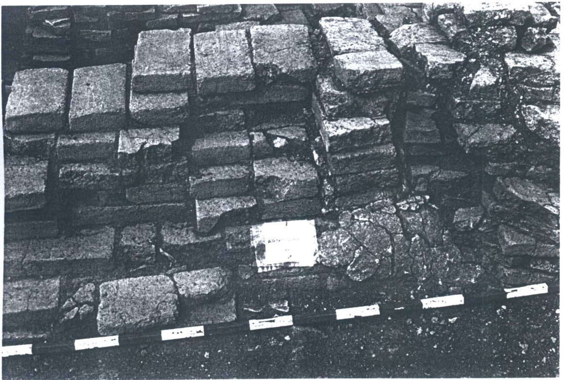
29. ภาพผนังด้านนอกอาคารหมายเลข 1 (ครั้งที่ 3) (ฟิล์มหมายเลข 24/15)
