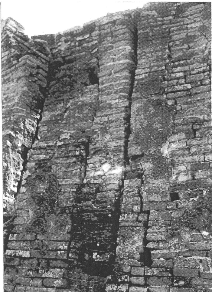
ภาพที่ 35 การบูรณะโดยมีการก่ออิฐปิดช่อง แสงบางช่องของผนังวิหารพระโลกนาถ
