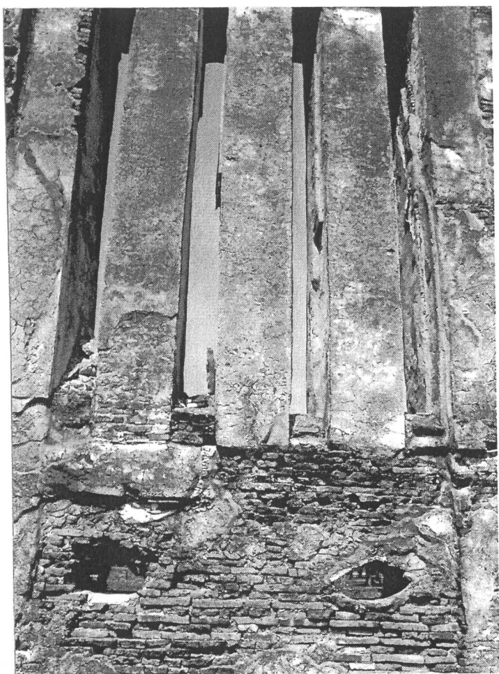
ภาพที่ 5 การก่อเป็นช่องแสงรูป สี่เหลี่ยมผืนผ้า และช่องลมรูปสี่เหลี่ยม ขนมเปียกปูนของผนังวิหารหลวง
