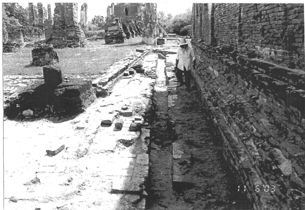
ภาพที่ 22 สภาพภายหลังการขุดแต่งพื้นที่ด้านทิศเหนือของวิหารหลวงบริเวณที่ติดกับพระที่นั่งจอมทอง
