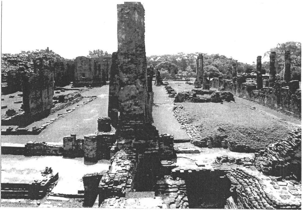
ภาพที่ 13 สภาพภายหลังการขุดแต่ง – ขุดตรวจ วิหารหลวง
