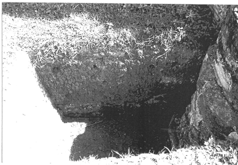
ภาพที่ 30 หลุมขุดตรวจฐานรากที่ฐานเสาและผนังที่ด้านทิศตะวันออกของวิหารหลวง ซึ่งพบว่าเป็นการนำดินจากที่อื่นมาอัดให้แน่นเตรียมปูพื้น?
