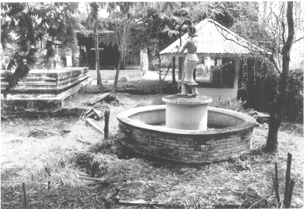
ภาพที่ 4 พื้นที่ด้านทิศตะวันตกขององค์เจดีย์ประธานสภาพก่อนการขุดแต่ง (ฟิล์ม 1/3)
