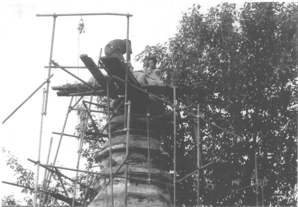
ภาพที่ 92 ก่ออิฐเสริมความมั่นคงบริเวณปล้องไฉนของเจดีย์หมายเลข 8 (8/5)
