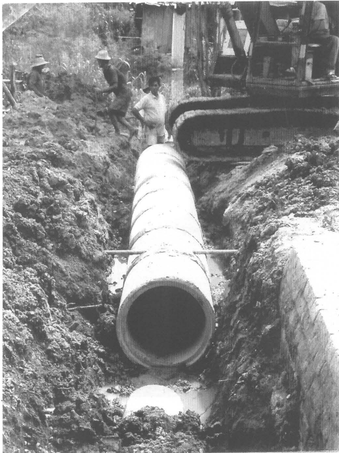
ภาพที่ 128 ดำเนินการติดตั้งระบบระบายน้ำ (49/18)
