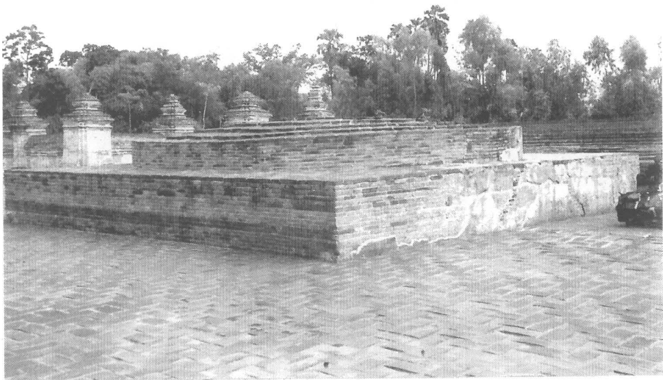
ภาพที่ 159 สภาพทั่วไปเจดีย์รายหมายเลข 7 หลังการบูรณะ (55/9)
