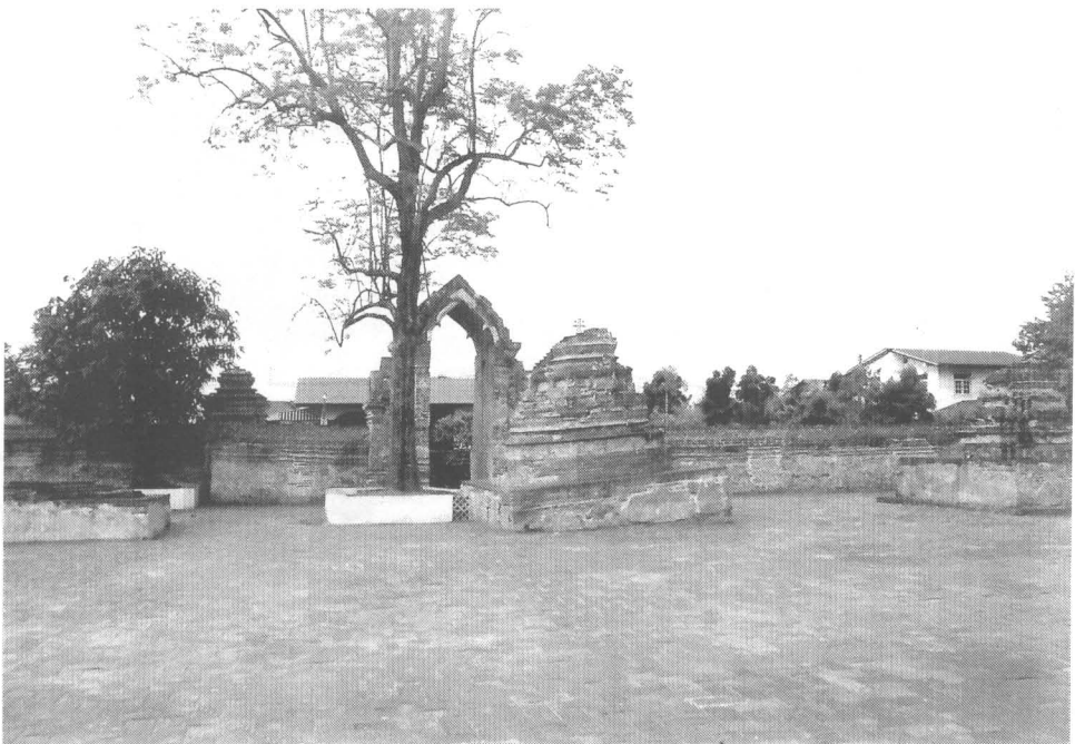
ภาพที่ 162 สภาพทั่วไปเจดีย์รายนหมายเลข 10 หลังการบูรณะ (55/12)
