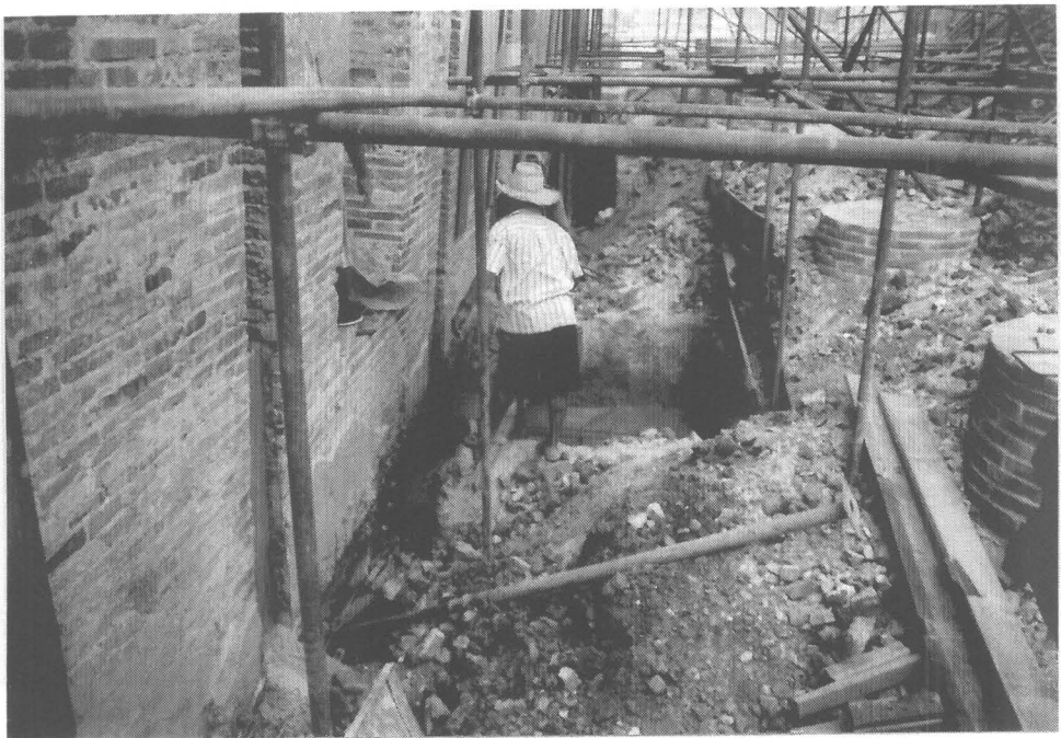
ภาพที่ 74 เทคอนกรีตเสริมโครงสร้างภายในพระวิหาร (34/16)
