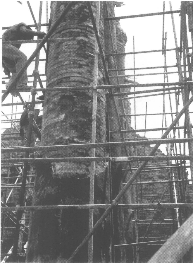
ภาพที่ 56 ติดตั้งนั่งร้านภายในพระอุโบสถ (32/5)
