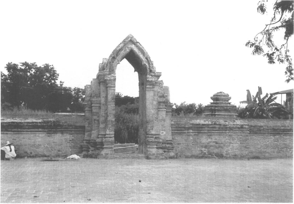
ภาพที่ 175 สภาพโดยทั่วไปของซุ้มประตูและทางเข้าวัดด้านทิศใต้ภายหลังการบูรณะ (52/2)
