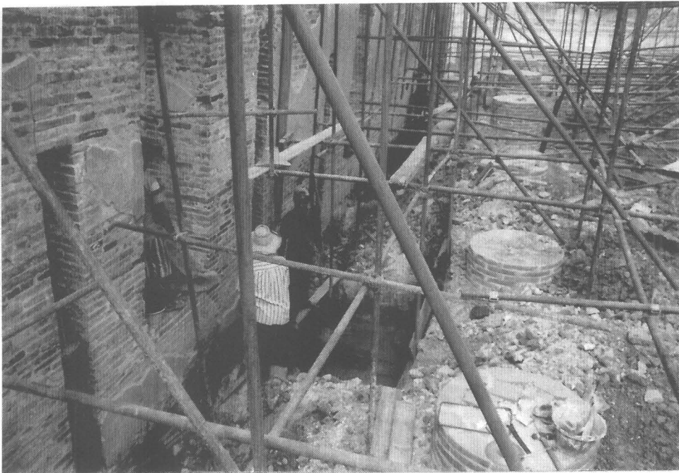
ภาพที่ 72 เพคคอนกรีตเสริมโครงสร้างภายในพระวิหาร (45/37)
