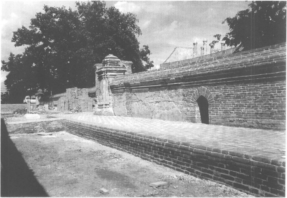
ภาพที่ 179 สภาพโดยทั่วไปของกำแพงกันดินและกำแพงวัด หลังการบูรณะ (52/15)
