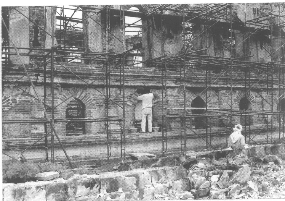
ภาพที่ 78 ดำเนินการติดตั้งแบบเพื่อก่อเรียงอิฐบริเวณซุ้มหน้าต่างของพระตำหนัก กำมะเลียน (28/23)
