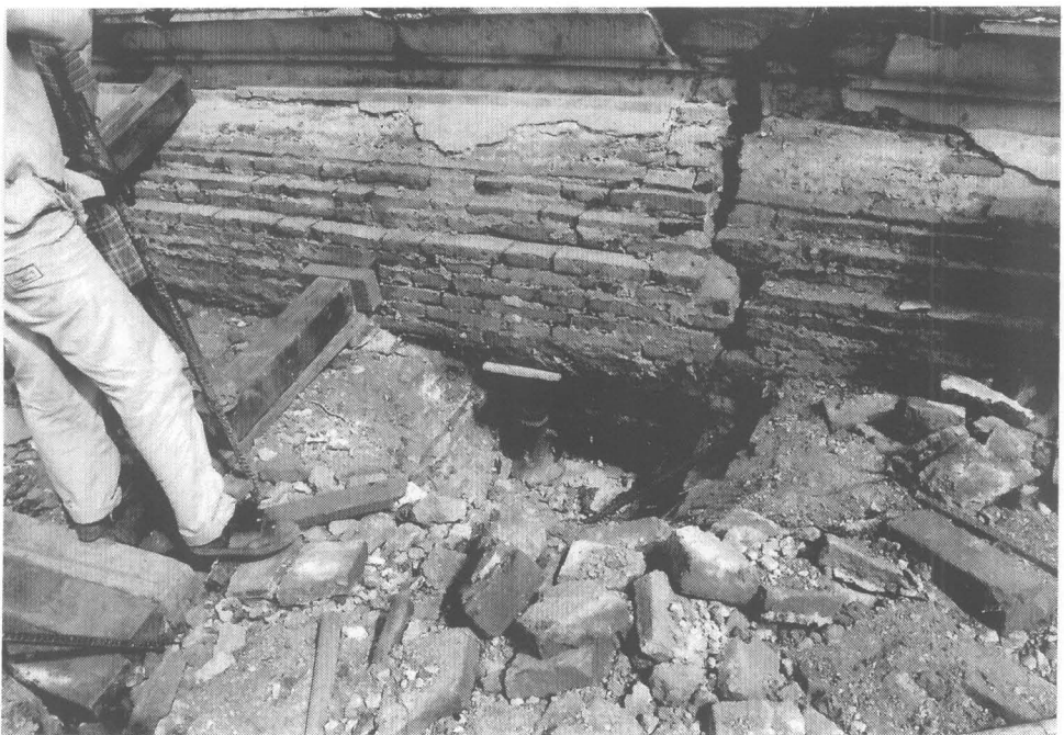
ภาพที่ 86 ดำเนินการรื้ออิฐก่อปูนสอที่ชำรุดเสื่อมสภาพออกบริเวณฐานเจดีย์ราย
