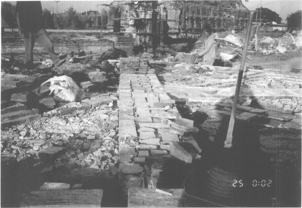
ภาพที่ 91 ดำเนินการก่ออิฐเสริมความมั่นคงบริเวณเอนเจดีย์หมายเลข 7 (6/30)
