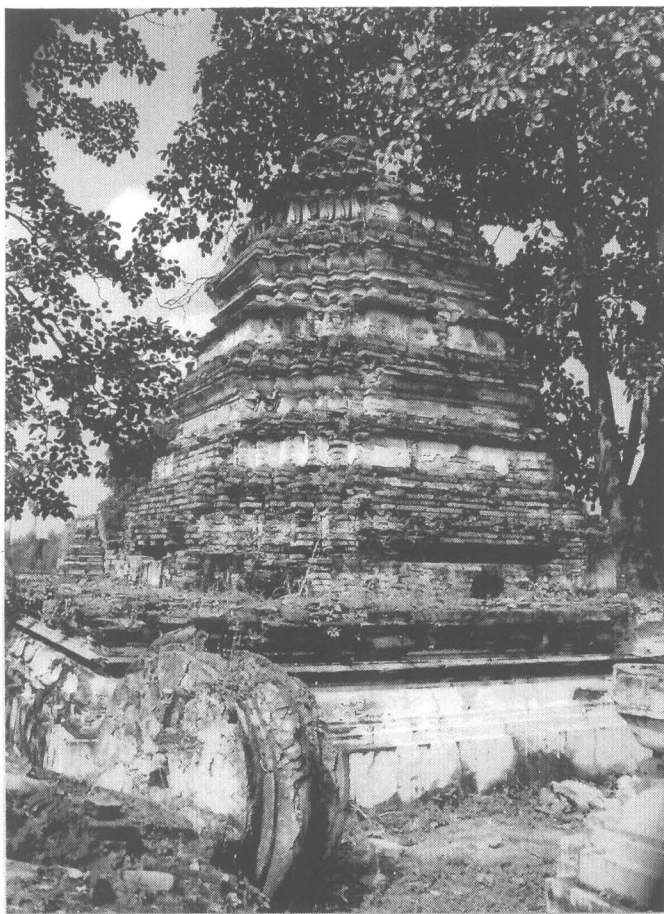
ภาพที่ 33 สภาพโดยทั่วไปของเจดีย์หมายเลข 12 ก่อนการบูรณะ (4/2)
