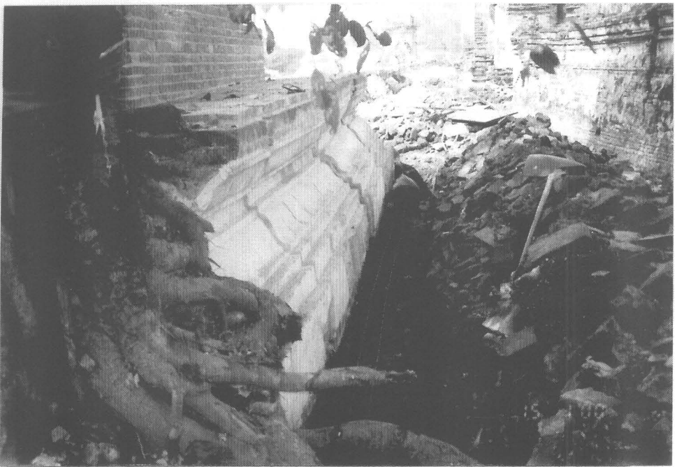
ภาพที่ 88 ผูกเหล็กเตรียมเทคาน ค.ศ.ล.รัศรอบฐานเจดีย์หมายเลข 5
