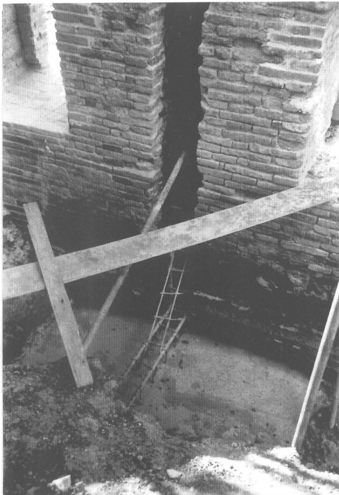
ภาพที่ 81 ดำเนินการเสริมโครงสร้างภายในพระตำหนักกำมะเลียน (40/21)
