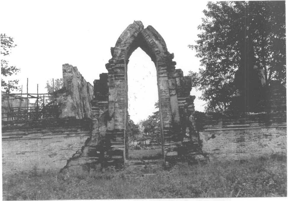
ภาพที่ 43 สภาพโดยทั่วไปของซุ้มประตูทางเข้านด้านทิศใต้ ก่อนดำเนินการบูรณะ (3/7)
