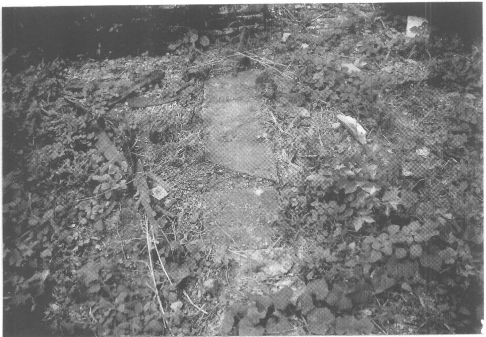
ภาพที่ 20 พื้นปูกระเบื้องดินเผาภายในพระวิหาร ก่อนดำเนินการบูรณะ 4/27
