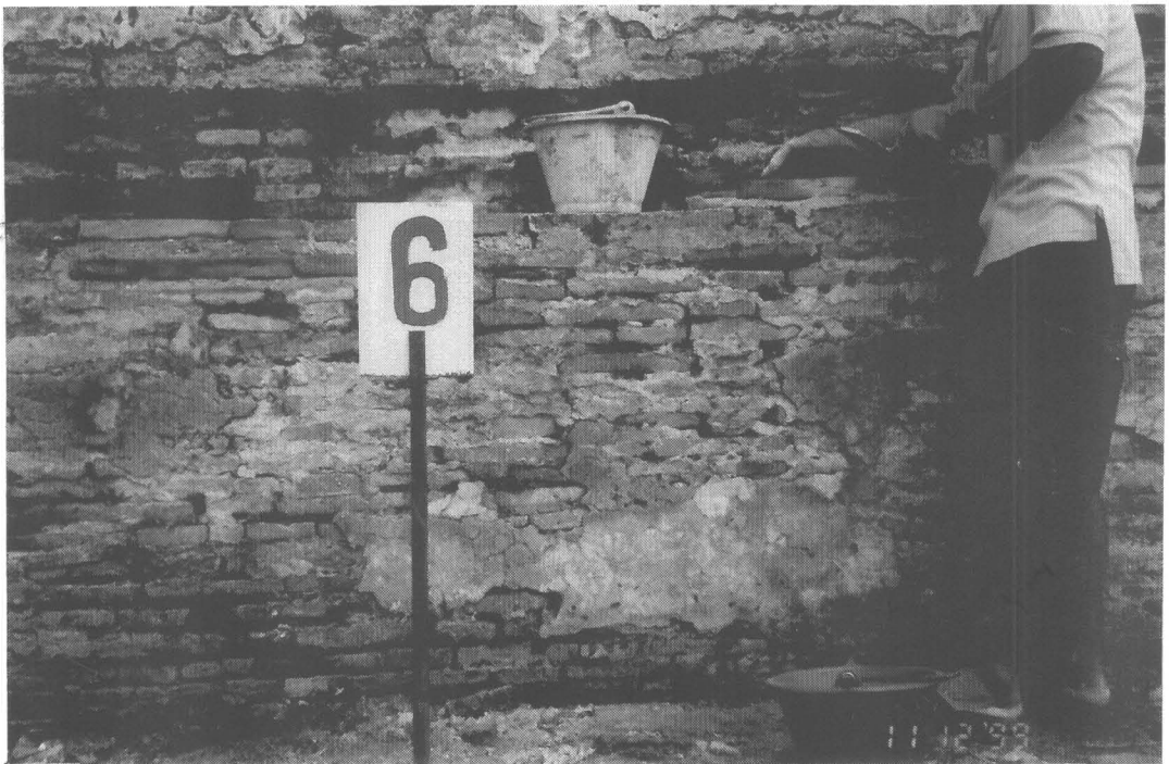
ภาพที่ 90 ก่ออิฐเสริมเจดีย์รายหมายเลข 6 (11/21)
