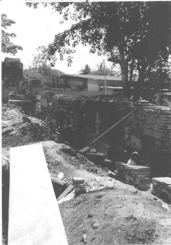
ภาพที่ 116 ดำเนินการประกอบชิ้นส่วนของกำแพงแก้วที่พังทลายกลับเข้าที่ (31/36)
