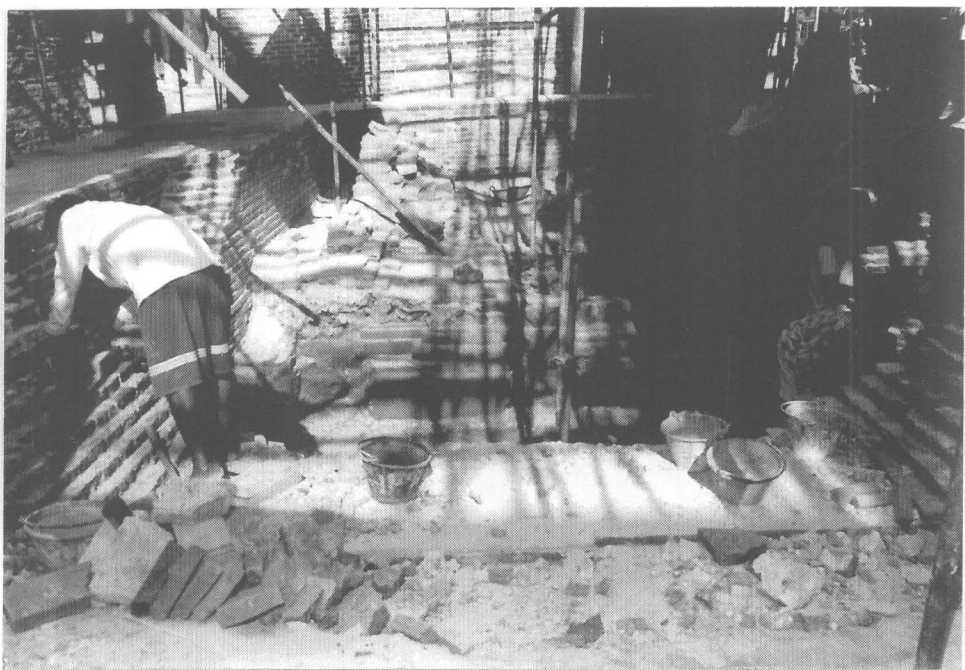
ภาพที่ 68 ดำเนินการก่ออิฐเสริมโดยเปิดให้เห็นฐานชุกชีสมัยแรก (39/20)
