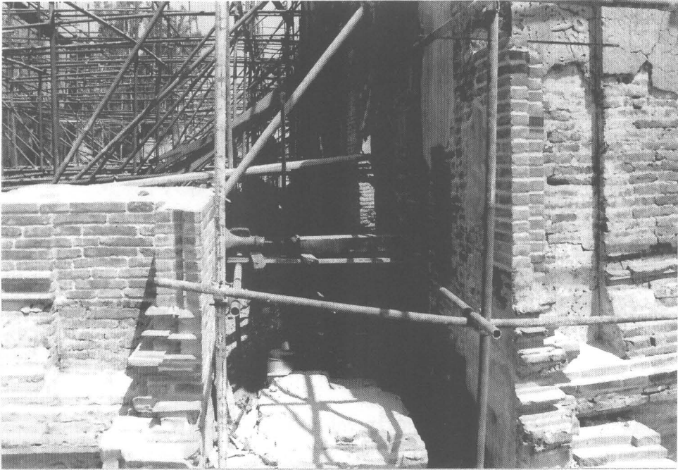
ภาพที่ 71 ดำเนินการผลักดันผนังวิหารกลับเข้าที่ ณ ตำแหน่งเดิม (30/33)
