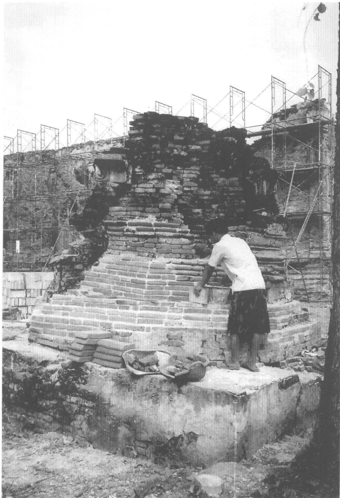
ภาพที่ 98 ก่ออิฐเสริมความมั่นคงเจดีย์หมายเลข 10 (8/4)
