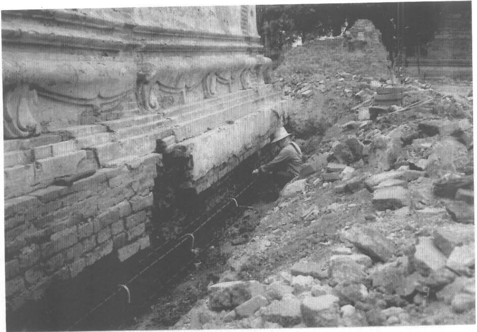
ภาพที่ 47 ผูกเหล็กเพื่อเตรียมเท ค.ศ.ล.รัตรอบลานประทักษิณของเจดีย์ประธาน 32/24 ดำเนินการเท ค.ศ.ล. รัตรอบฐานเจดีย์ประธาน 35/36
