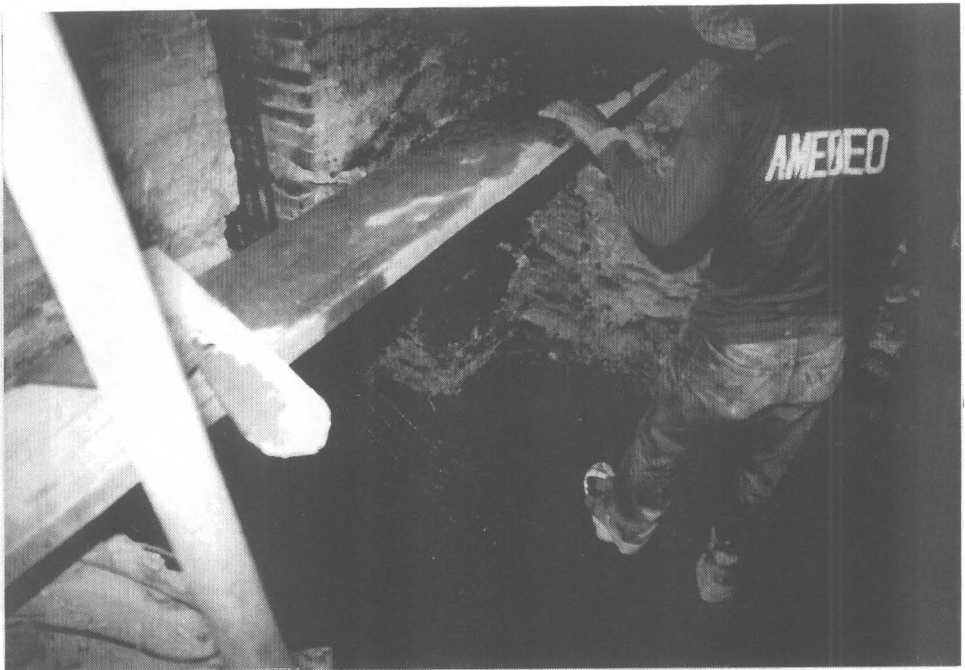
ภาพที่ 64 เทคอนกรีตเสริมโครงสร้างภายในพระอุโบสถ (33/22)
