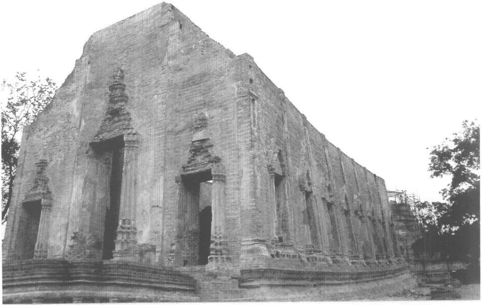
ภาพที่ 141 สภาพโดยทั่วไปของพระอุโบสถ ภายหลังจากการบูรณะ (46/23)
