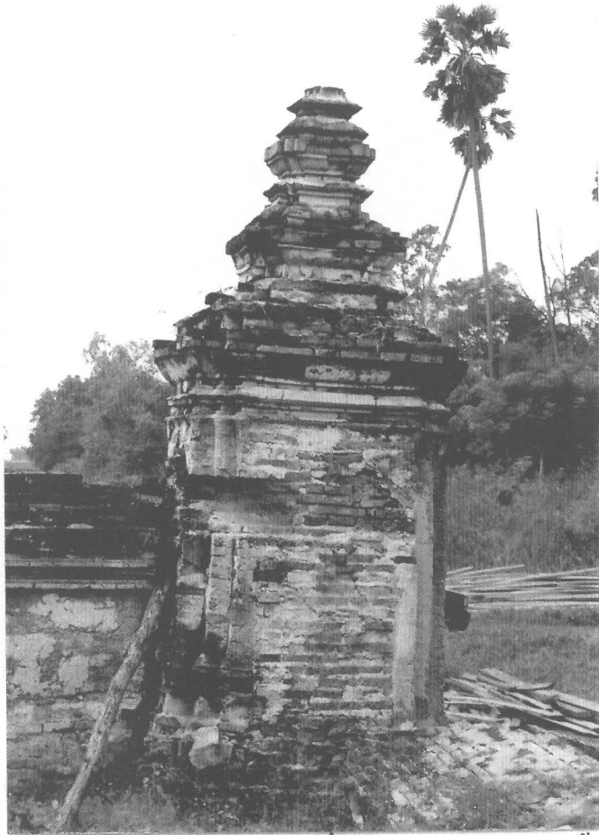
ภาพที่ 45 สภาพโดยทั่วไปของเสาหัวเม็ดทรงมณฑป บริเวณมุมของกำแพงแก้ว 3/33
