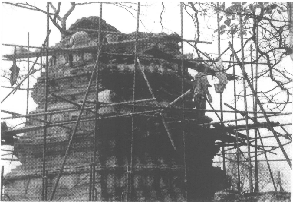
ภาพที่ 100 ก่ออิฐเสริมความมั่นคงเจดีย์หมายเลข 12 (12/6)
