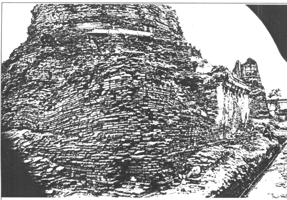
รูปที่ 25 เท ค.ส.ล. รัตรอบฐานเจดีย์ทรงกลมบนฐานสี่เหลี่ยมทรงสูง (ฟิล์มที่ 15/23)
