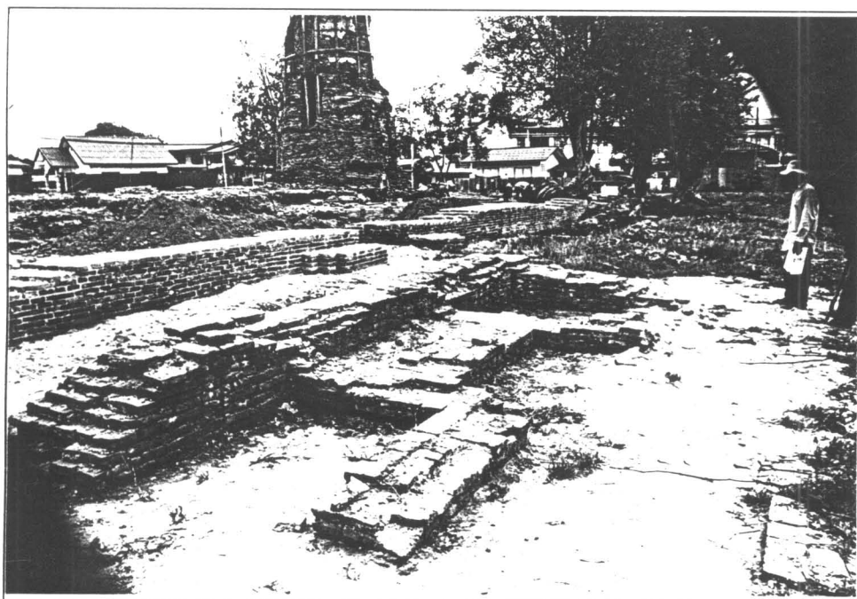
รูปที่ 11 สภาพโดยทั่วไปของอาคารหมายเลข 2 ก่อนดำเนินการบูรณะ (ฟิล์มที่ 15/19)
