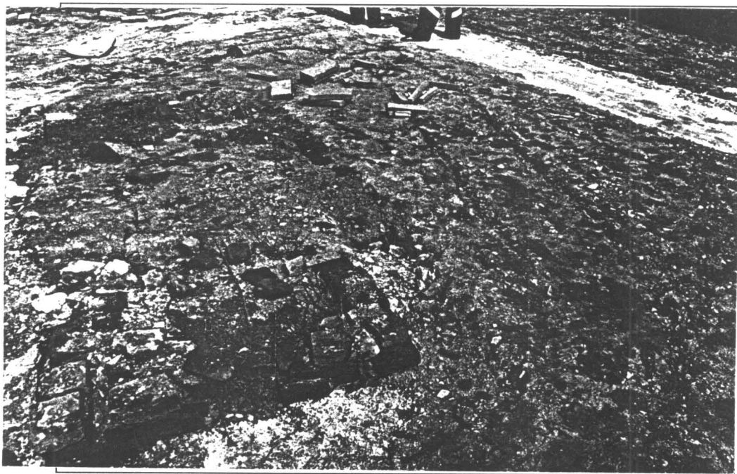
รูปที่ 36 ดำเนินการบูรณะฐานสิ่งก่อสร้างด้านทิศใต้ของวิหาร (ฟิล์มที่ 27/19)
