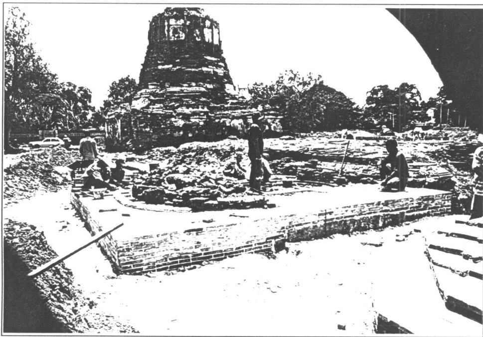
รูปที่ 32 ดำเนินการบูรณะเจดีย์รายนหมายเลข 6 (ฟิล์มที่ 15/17)
