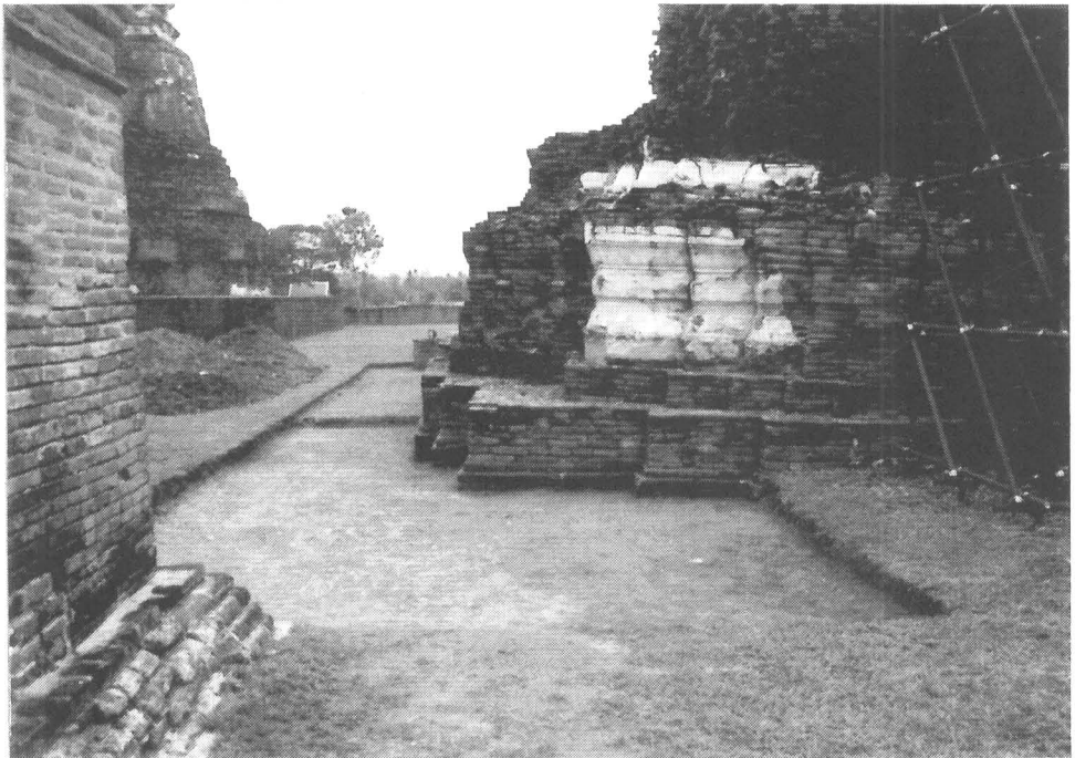
ภาพที่ 10 สภาพภายหลังการขุดแต่งด้านทิศใต้ ของปรางค์ประจำมณฑลวันตกเฉียงใต้
