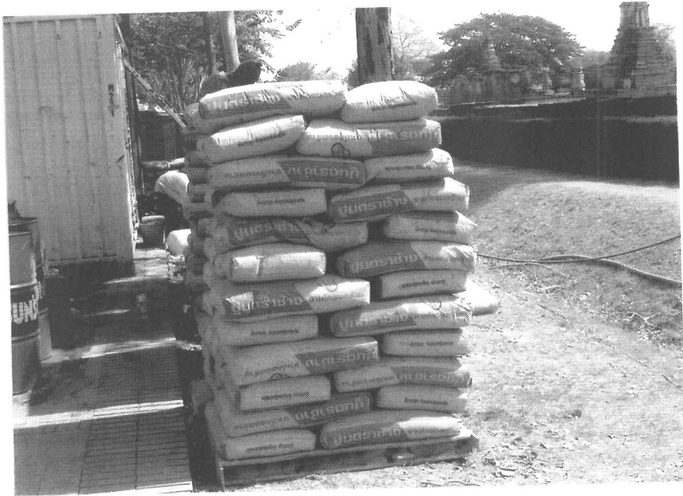
ภาพที่ 16 ปูนซีเมนต์ปอร์ตแลนด์ ตราช้าง วัสดุหลักในการทำ Soil Cement Column
