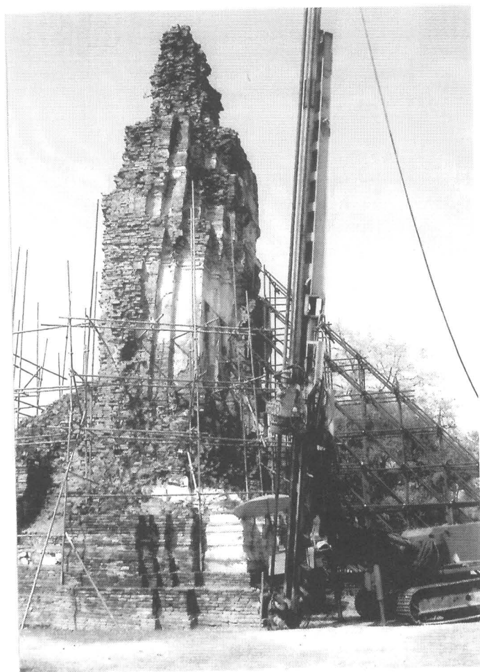
ภาพที่ 14 ทำการเริ่ม Soil Cement Column โดย วิธี Jet Grouting จุดแรกที่มุมด้าน ตะวันออกเฉียงใต้
