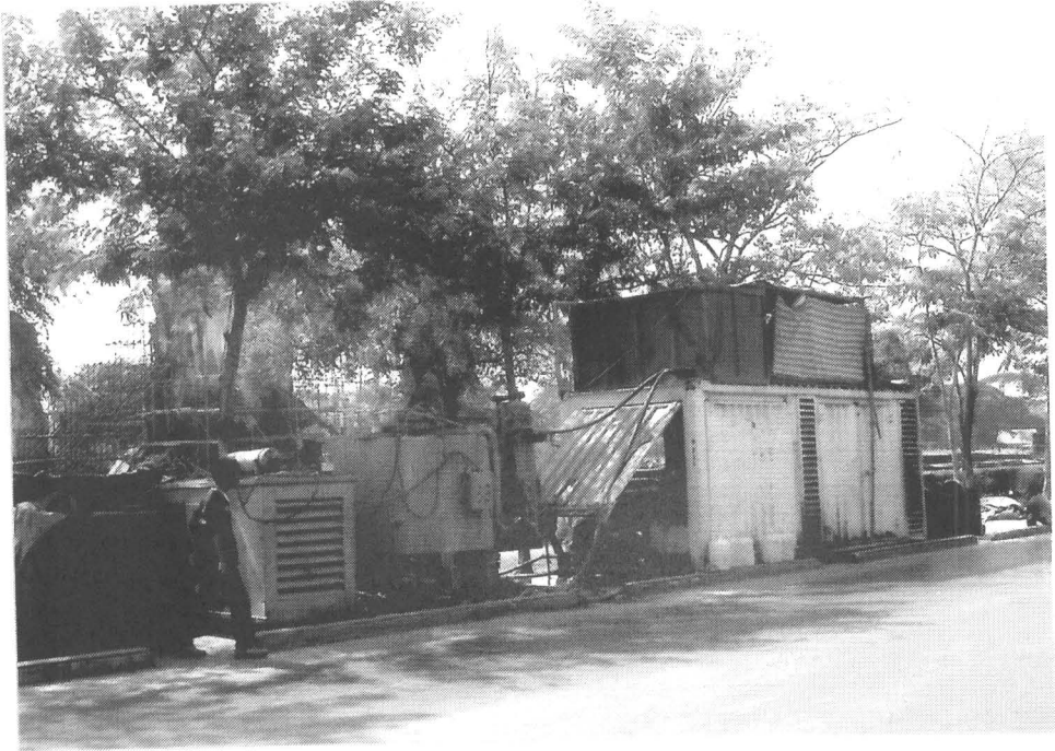
ภาพที่ 17 เครื่อง Mixer Plant และปั๊มความดันสูง ที่ทำการส่งซีเมนต์เหลวไปยังรถเจาะ
