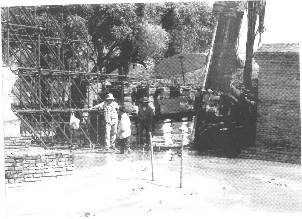
ภาพที่ 15 ดินโคลนที่ไหลออกมาเพราะการอัดฉีดซีเมนต์ผสมน้ำไปแทนที่
