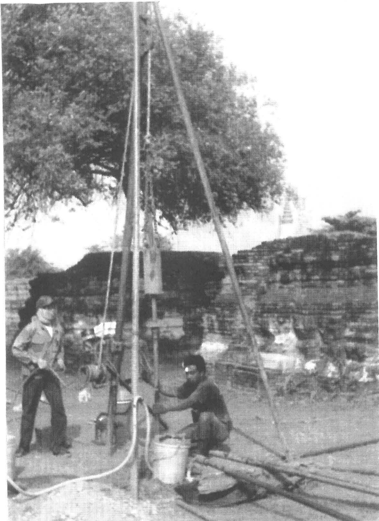
รูปภาพ แสดงการเจาะสำรวจ หลุม BH-2
