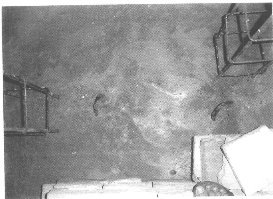
ภาพที่ 26 การงอเหล็กเป็นรูป U เพื่อใช้เป็นที่ยึดเกี่ยวกับลวดสลิง
