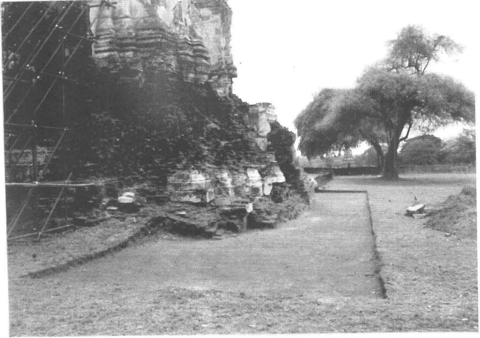
ภาพที่ 9 สภาพภายหลังการขุดแต่งด้านทิศเหนือ ของปรางค์ประจำมณฑลวันตกเฉียงใต้
