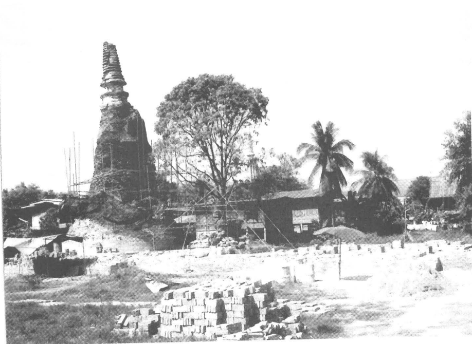
ภาพที่ 23 โบราณสถานวัดชุมแสง สภาพทั่วไปด้านทิศใต้ ขณะทำการบูรณะ
