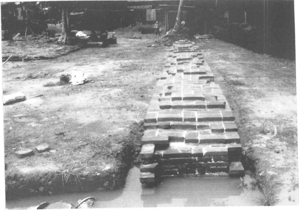
ภาพที่ 43 แนวกำแพงวัดด้านทิศตะวันออก สภาพภายหลังการบูรณะ
