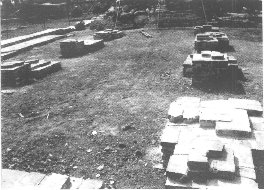
ภาพที่ 39 ภายในวิหาร สภาพภายหลังการบูรณะ
