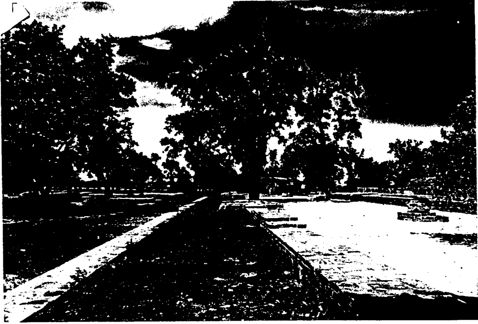
รูปที่ 56 สภาพโดยทั่วไปของแนวกำแพงแก้ว ภายหลังจากดำเนินการบูรณะ (4/19)
