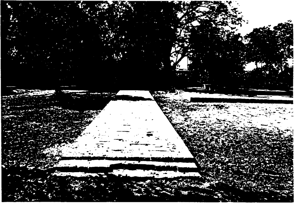
รูปที่ 54 สภาพโดยทั่วไปของแนวทางเดินภายในวัดโคกพระยา ภายหลังจากดำเนินการบูรณะ (4/17)
