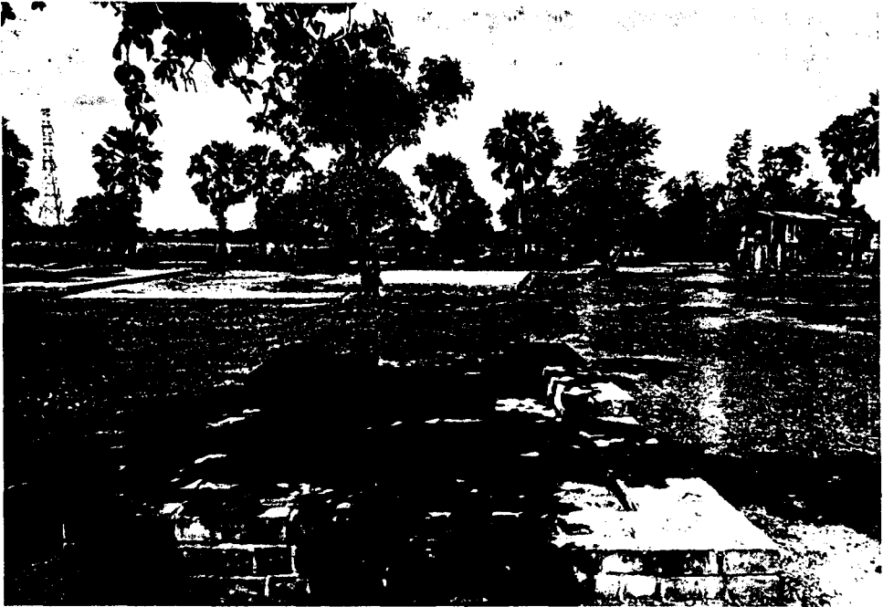
รูปที่ 51 สภาพโดยทั่วไปของอาคารหมายเลข 7 ภายหลังจากดำเนินการบูรณะ (4/14)
