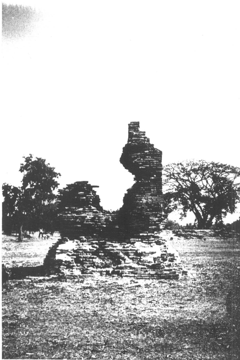
ภาพที่ 228 ภาพแสดง หอระฆังด้านทิศเหนือ สภาพก่อนบูรณะ (ฟิล์ม 1/22)
