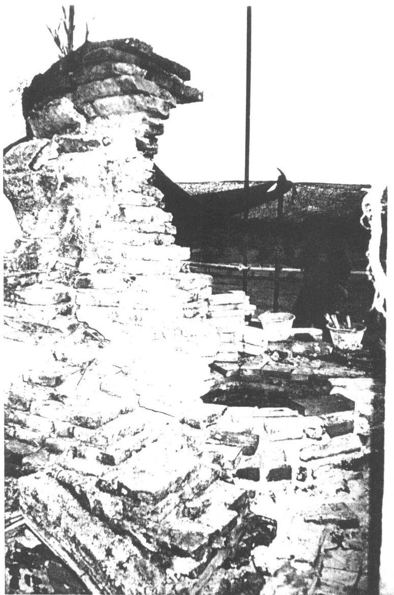
ภาพที่ 187 ก่ออิฐซ่อมเสริมส่วนยอดของเจดีย์หมายเลข 2 (ฟิล์ม 11/9)
