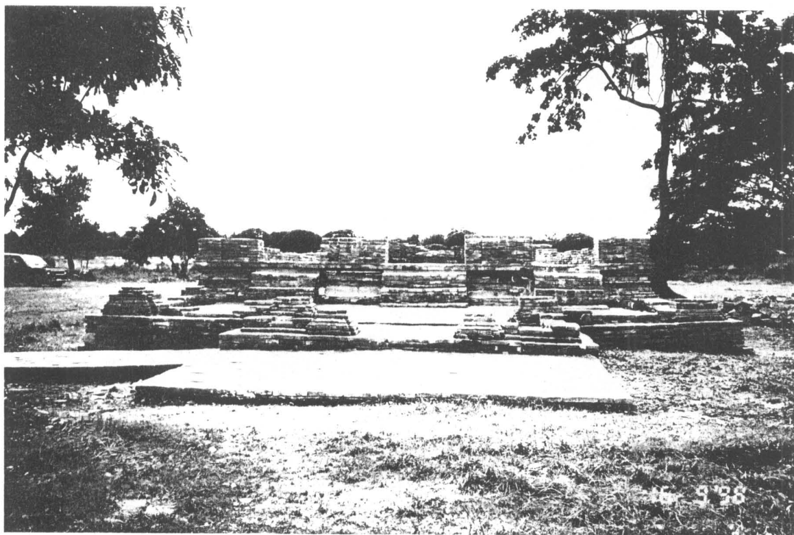
ภาพที่ 224 ภาพแสดง อาคารหมายเลข 3 ด้านทิศตะวันออกสภาพหลังการบูรณะ (ฟิล์ม 16/28)
