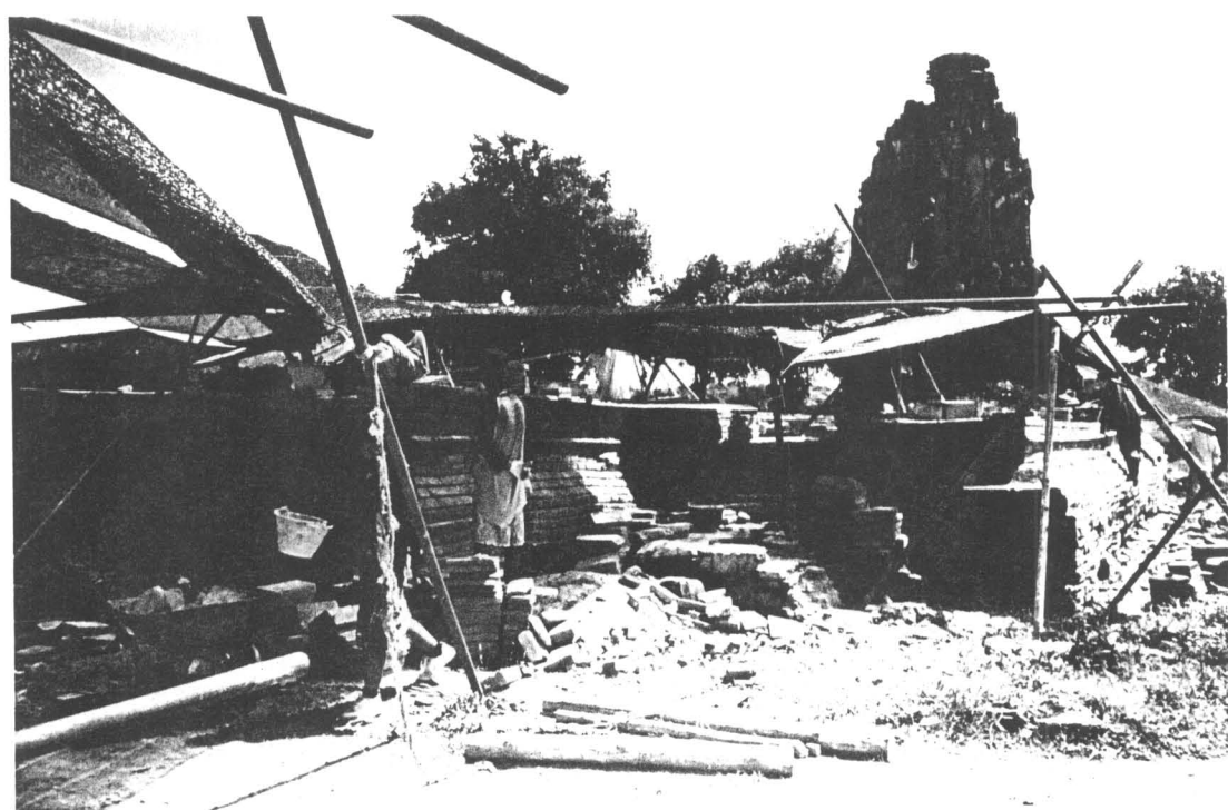
ภาพที่ 115 ทำการก่ออิฐเสริมฐานของวิหาร ให้อยู่ในสภาพที่สมบูรณ์ (ฟิล์ม 8/23)
