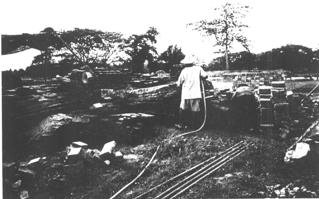
ภาพที่ 112 ก่อนก่ออิฐทำการฉีกล้างด้วยน้ำ (ฟิล์ม 8/5)
