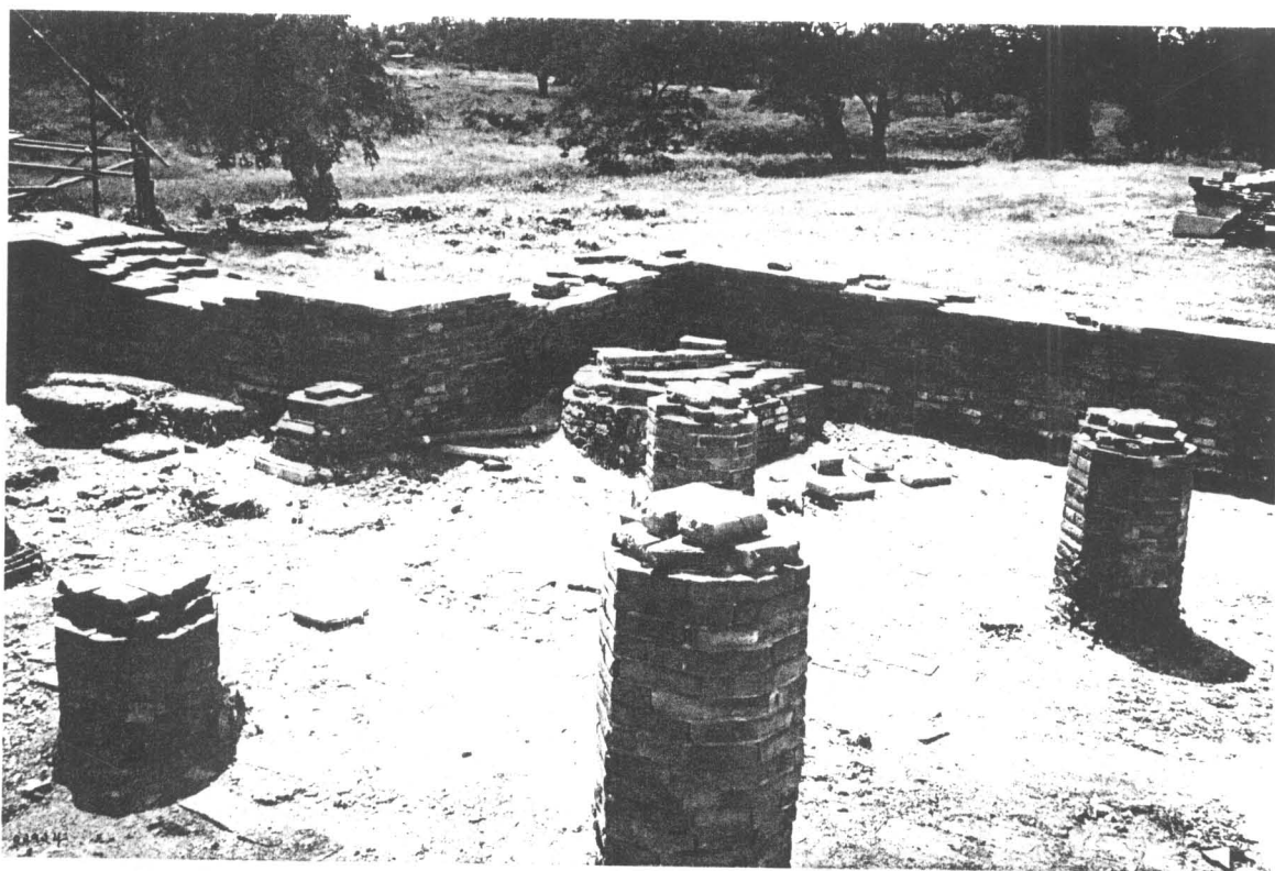
ภาพที่ 131 สภาพของเสาแปดเหลี่ยมภายในวิหาร หลังจากก่ออิฐเสริมแล้วเสร็จ (ฟิล์ม 12/13)
