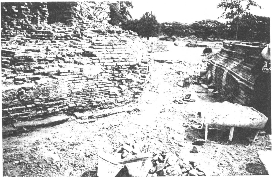
ภาพที่ 154 ภาพฐานพระเจดีย์ แสดงหลักฐานเดิม มีหน้ากระดานและบัวคว่ำว่าเป็นแนวทางในการบูรณะ (ฟิล์ม 12/7)
