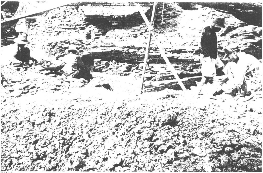
ภาพที่ 162 ทำการก่ออิฐบุผนังช่องแคบ โดยเริ่มจากฐานของเจดีย์ (ฟิล์ม 9/00)
