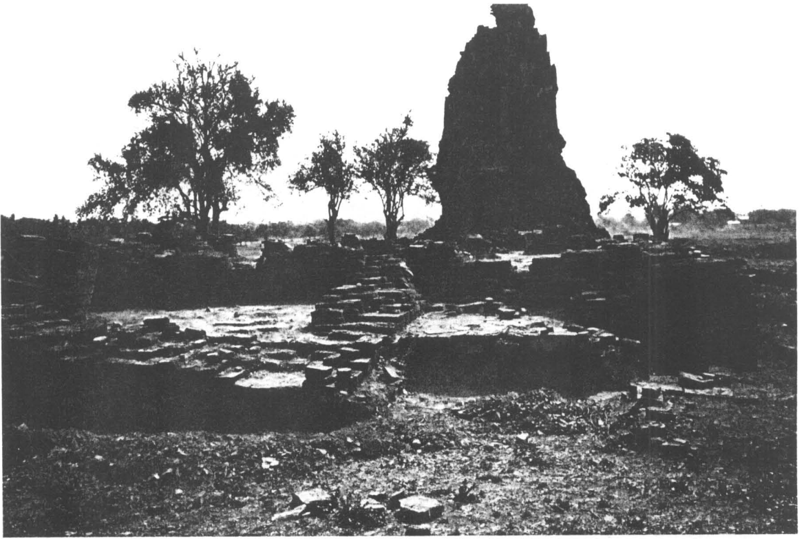
ภาพที่ 104 วิหารหมายเลข 4 สภาพก่อนบูรณะด้านทิศตะวันออก (ฟิล์ม 2/27)
