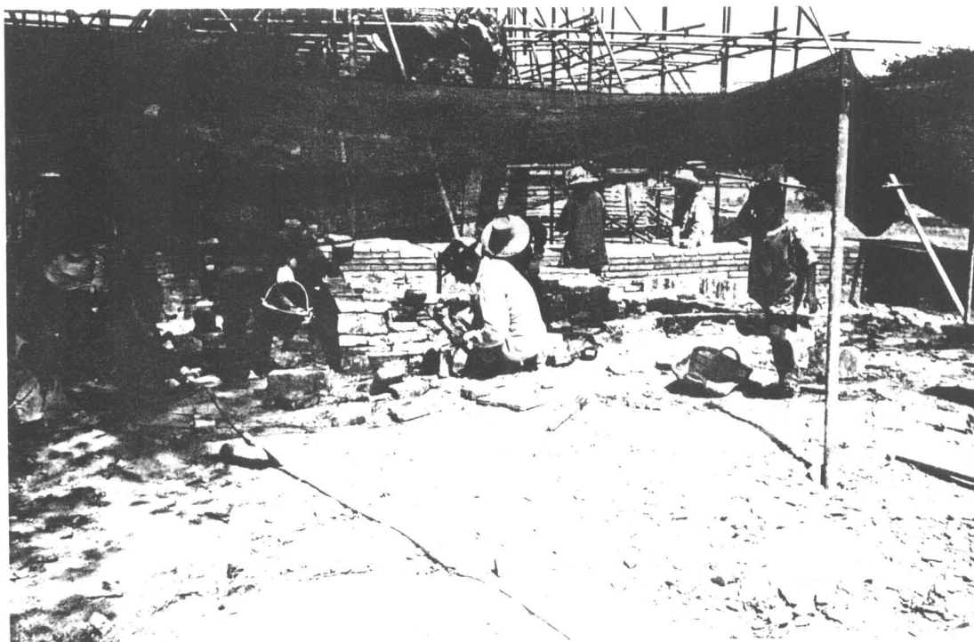
ภาพที่54 แสดงให้เห็นขณะทำการบูรณะฐานชุกชีภายในพระอุโบสถ (ฟิล์ม18/30)
