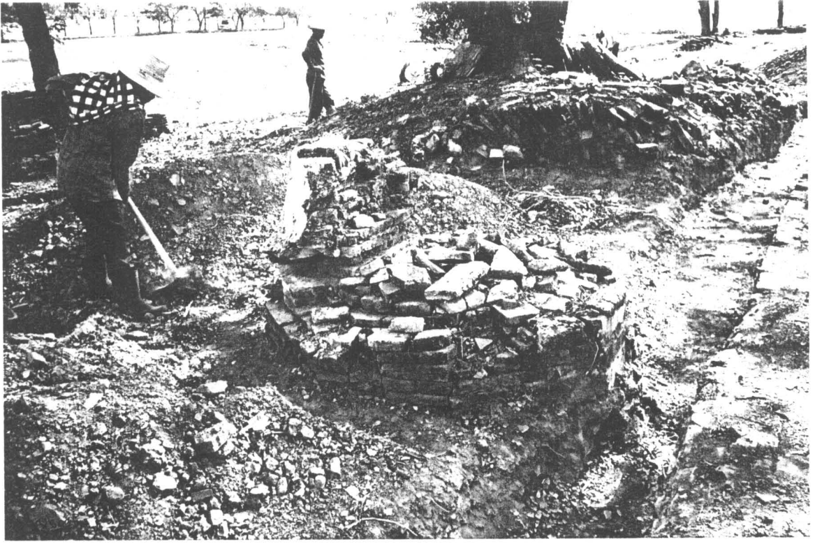
ภาพที่ 80 ทำการขุดลอกดินจนถึงฐานล่างสุดก่อนการบูรณะ (ฟิล์ม 3/26)
