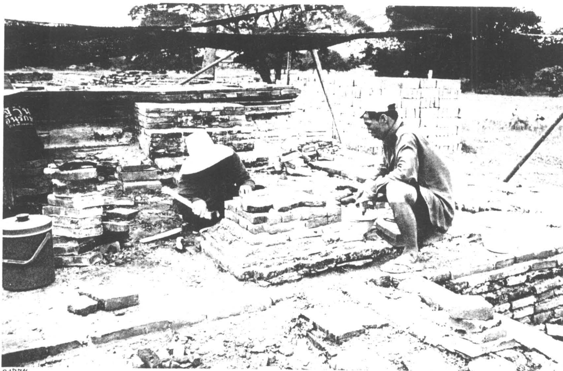
ภาพที่ 208 ภาพแสดง การบูรณะเสามุขด้านหน้าของอาคารหมายเลข 3 (ฟิล์ม 9/24)
