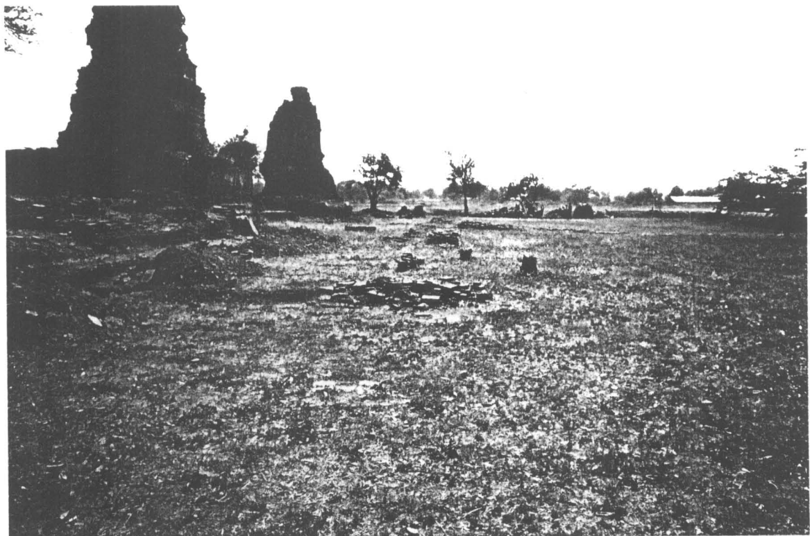
ภาพที่ 252 ภาพแสดง แนวกำแพงแก้ว ด้านทิศเหนือ สภาพก่อนการบูรณะ (ฟิล์ม 3/0)
