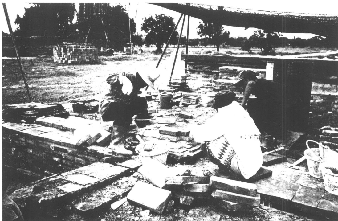
ภาพที่ 210 ภาพแสดง การก่ออิฐซ่อมแซมเสามุขด้านหน้าของอาคารหมายเลข 3 (ฟิล์ม 9/25)
