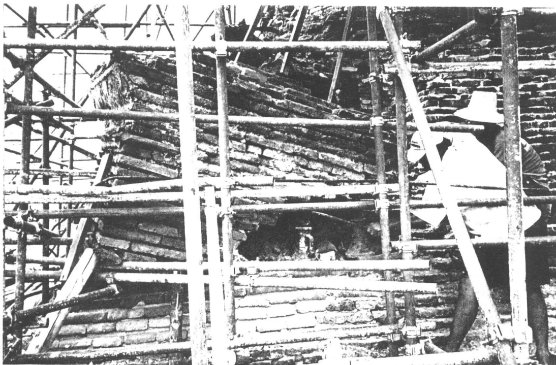
ภาพที่ 12 ไข้แม่แรงยกขึ้นส่วนของฐานเจดีย์ด้านทิศตะวันตกเฉียงใต้ที่ล้มลง (ฟิล์ม 5/8)
