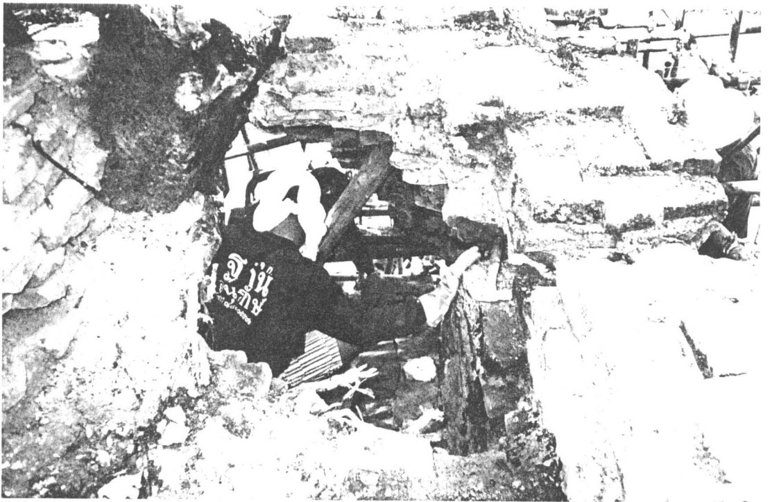
ภาพที่ 17 ทำการก่ออิฐรับด้านในของชั้นส่วนฐานเจดีย์ที่ยกกลับเข้าตำแหน่งเดิมแล้ว (ฟิล์ม 5/14)
