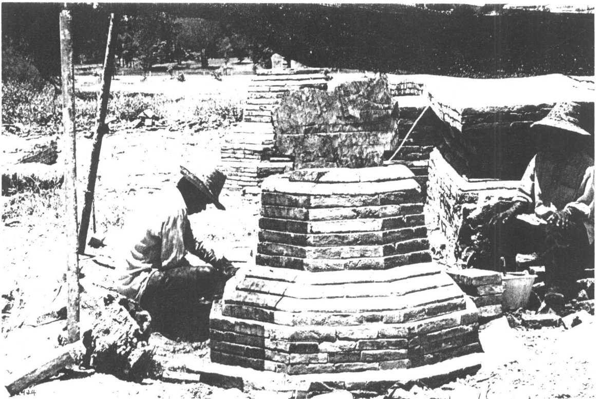
ภาพที่ 85 ทำการบุระฐานโบสถ์เต็มรูปแบบ และนำโบสถ์กลับเข้ามาติดตั้ง (ฟิล์ม 12/24)
