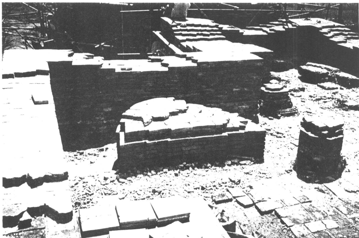
ภาพที่ 132 สภาพหลังการบูรณะของฐานชุกชี ค้ำยันมือภายในวิหาร (ฟิล์ม 12/12)
