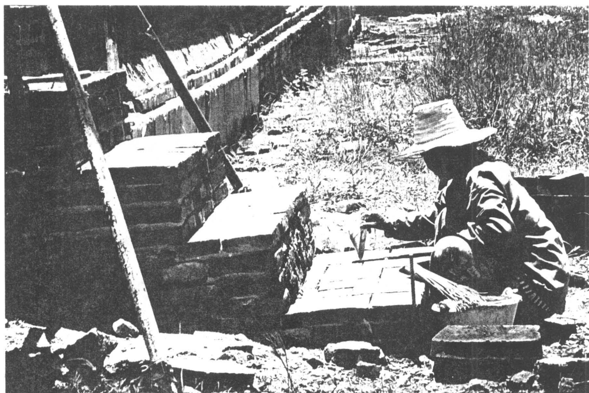
ภาพที่ 215 ภาพแสดง การหยอดคาน้ำปูนทรายยาแนวอิฐหลังการบูรณะซ่อมแซม (ฟิล์ม 12/20)
