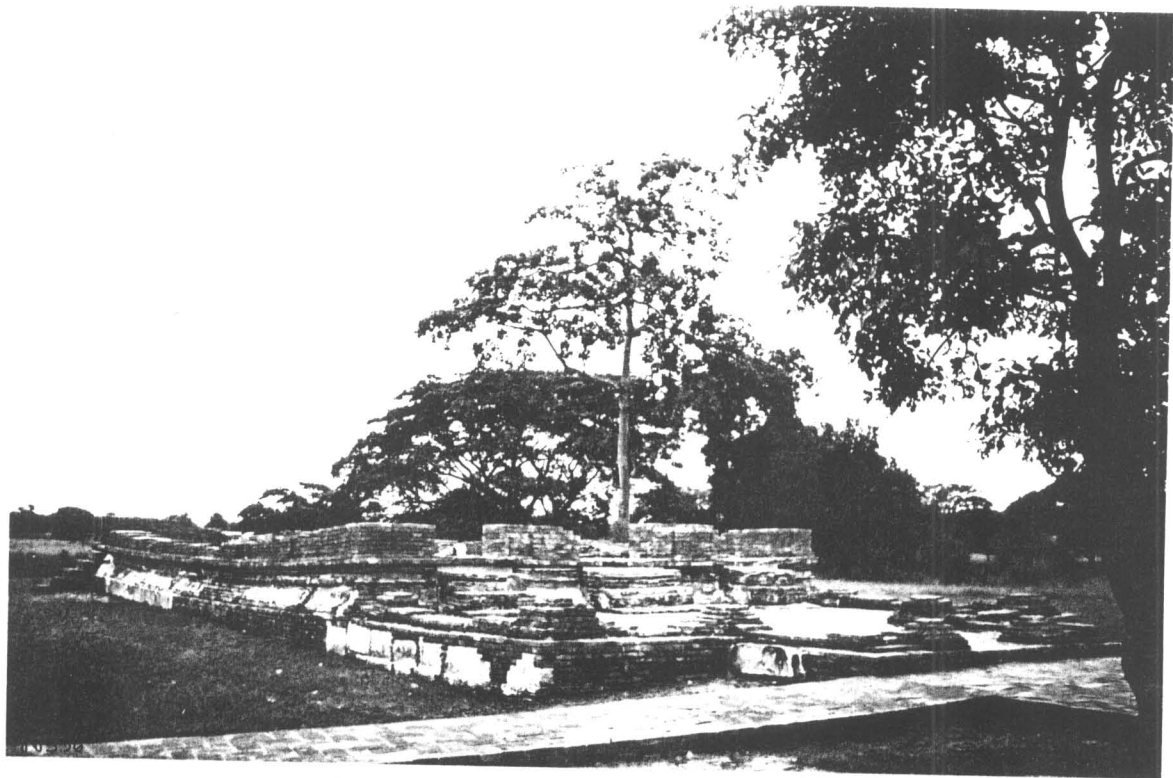
ภาพที่ 226 ภาพแสดง อาคารหมายเลข 3 ด้านทิศตะวันออกเฉียงใต้ สภาพหลังการบูรณะ (ฟิล์ม 19/37)
