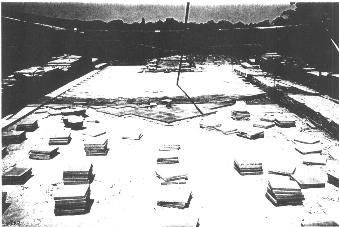
ภาพที่ 223 ภาพแสดง การปูพื้นกระเบื้องดินเผาภายในอาคาร โดยการนำกระเบื้องเก่ามาทำการปูก่อนจนหมด จึงนำกระเบื้องใหม่มาปูเพิ่มเติมจนเต็มพื้นที่ทั้งหมด (ฟิล์ม 15/2)
