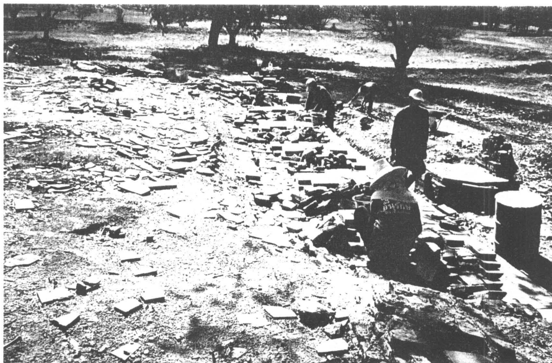
ภาพที่ 50 แสดงการบูรณะฐานค้ำหินสอใต้ ของพระอุโบสถ (ฟิล์ม 18/5)
