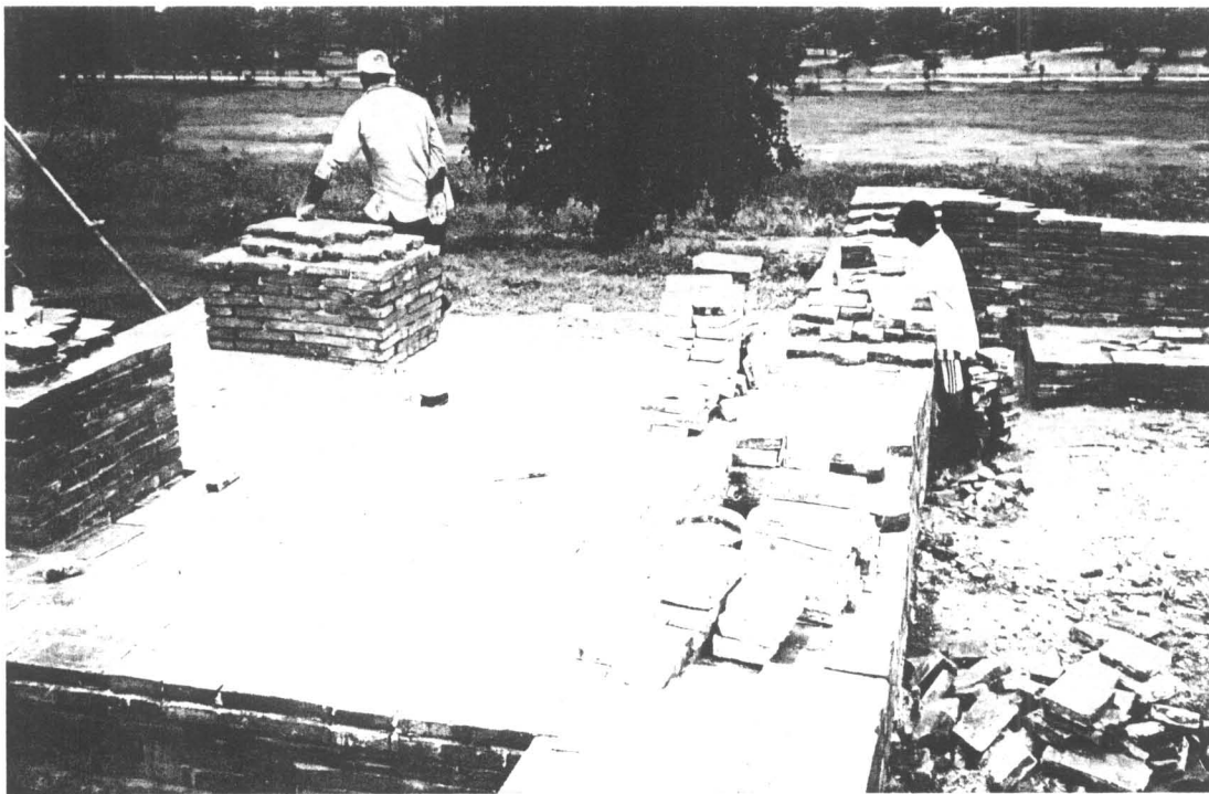
ภาพที่ 118 ก่ออิฐเสริมผนัง ด้านหน้าของวิหาร (ฟิล์ม 9/34)
