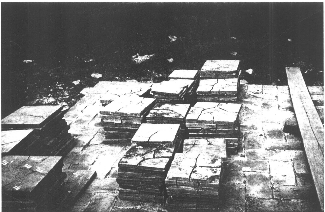
ภาพที่ 219 ภาพแสดง สภาพกระเบื้องเก่าที่แตกหักได้มีการทำเครื่องหมายโดยใส่ตัวเลขกำกับชิ้นส่วนในแต่ละชิ้น เพื่อเป็นการง่ายและสะดวกในการนำชิ้นส่วน เหล่านั้นมาต่อเข้าด้วยกัน (ฟิล์ม 10/34)
