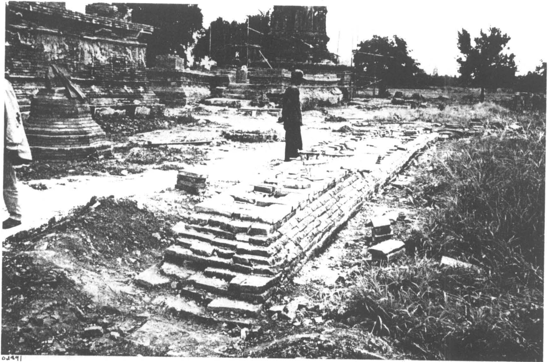
ภาพที่ 267 ภาพแสดง การก่ออิฐบุระแนวกำแพงแก้ว ด้านทิศเหนือ โดยการอนุรักษ์หลักฐานเดิมของฐานกำแพงแก้วไว้ด้วย (ฟิล์ม 10/29)
