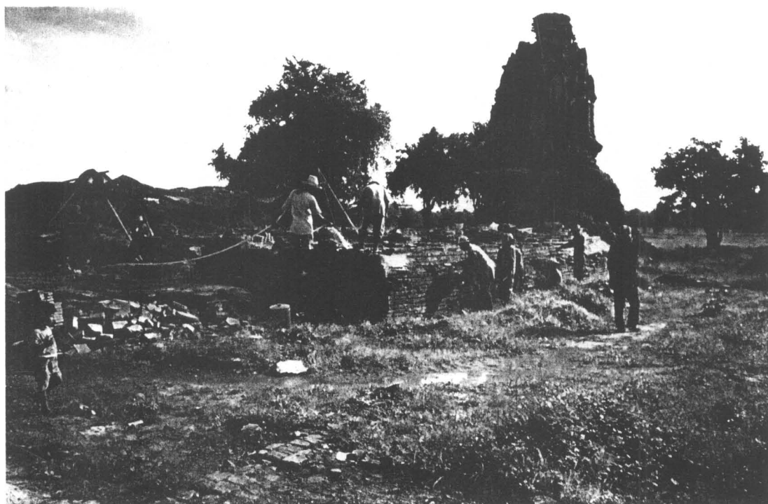
ภาพที่ 107 ฉีดล้างด้วยน้ำ ชักทำความสะอาดผิวอิฐก่อนก่อเสริม (ฟิล์ม 8/15)
