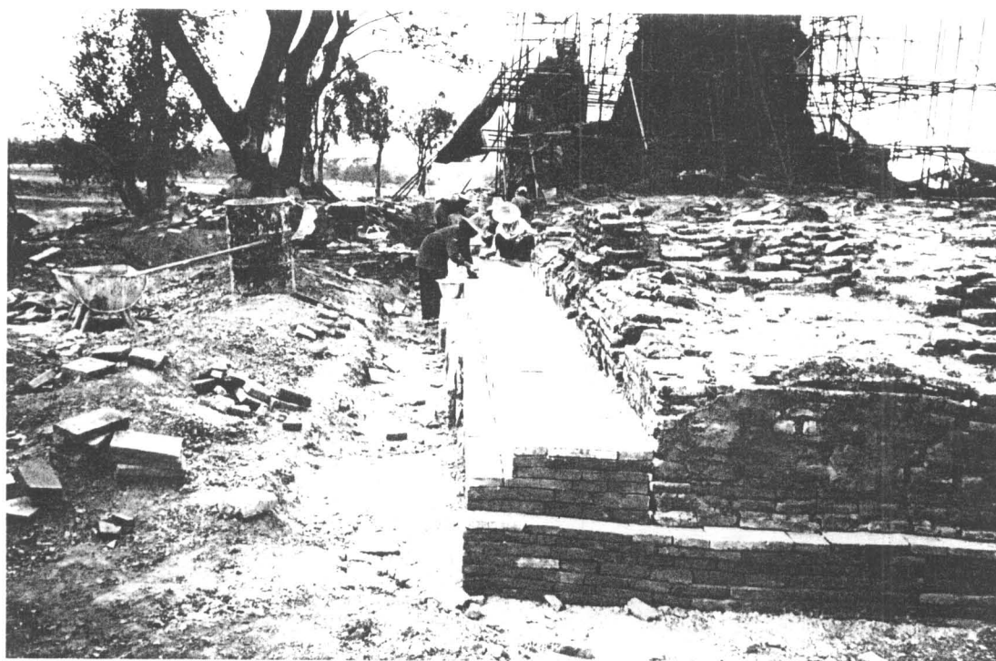
ภาพที่ 51 การบูรณะ ใต้ ทำการก่ออิฐไปตามรอยแนวเดิมของอิฐเก่า (ฟิล์ม 18/1)
