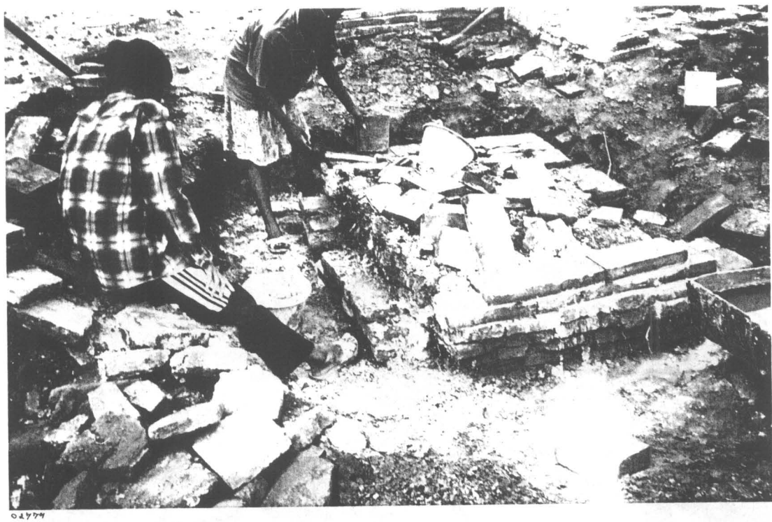
ภาพที่ 244 ภาพแสดง การก่ออิฐซ่อมแซมฐานเจดีย์ราย ด้านทิศตะวันออกเฉียงเหนือ ของพระวิหารหมายเลข 4 (ฟิล์ม 9/16)
