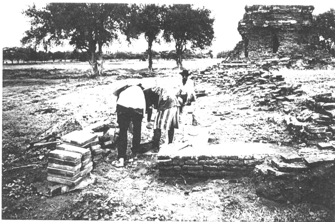
ภาพที่ 47 เริ่มทำการบูรณะ ได้ทำการขุดลอกดินถึงฐานชั้นล่างสุด เพื่อหาแนวอิฐเดิม (ฟิล์ม 5/33)
