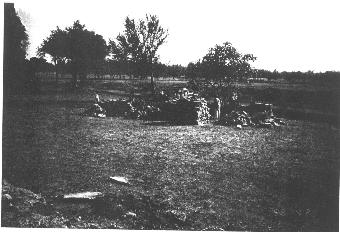
ภาพที่ 44 ภาพแสดง การคัดเลือกอิฐเก่าเพื่อนำไปทำความสะอาด และจะได้นำไปใช้ในการบูรณะ (ฟิล์ม 4/18)
