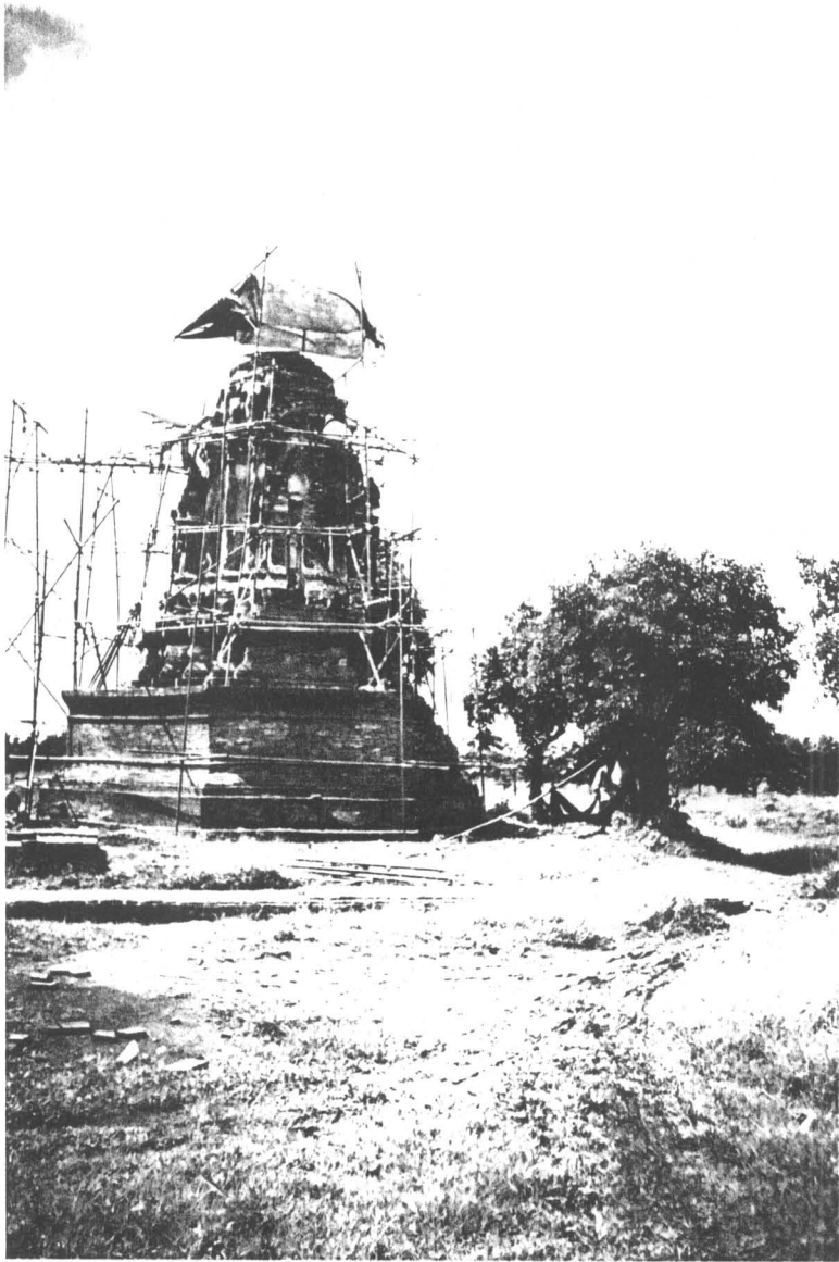
ภาพที่ 185 ก่ออิฐซ่อมแซมส่วนยอดของเจดีย์ ด้านทิศเหนือ (ฟิล์ม 11/37)
