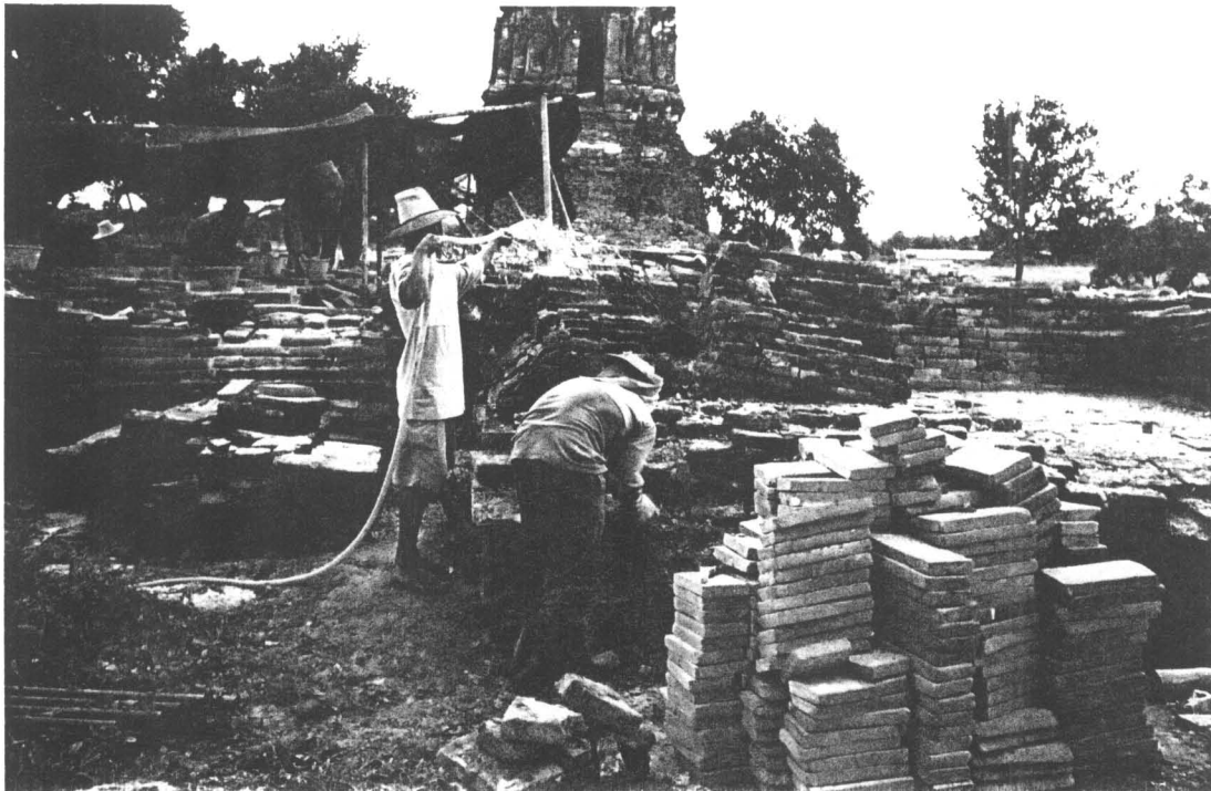
ภาพที่ 110 ขณะล้างทำความสะอาด และรื้ออิฐที่ผูกเรือนอกก่อนทำการก่ออิฐซ่อมแซม (ฟิล์ม 8/4)
