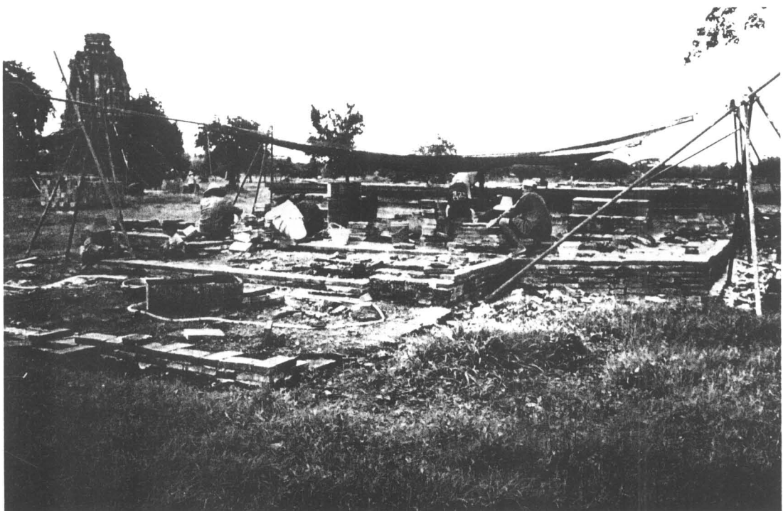
ภาพที่ 207 ภาพแสดง การบูรณะโดยเริ่มทำการก่ออิฐล้อมแซมฐานคานหน้า ของอาคารหมายเลข 3 (ฟิล์ม 9/23)
