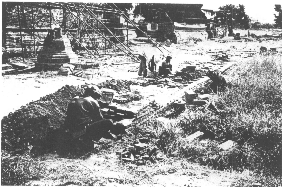
ภาพที่ 265 ภาพแสดง การก่ออิฐบุผนังกำแพงแก้ว ด้านทิศเหนือ โดยการยึดหลักฐานเดิมเป็นแนวทางในการบูรณะ (ฟิล์ม 10/5)
