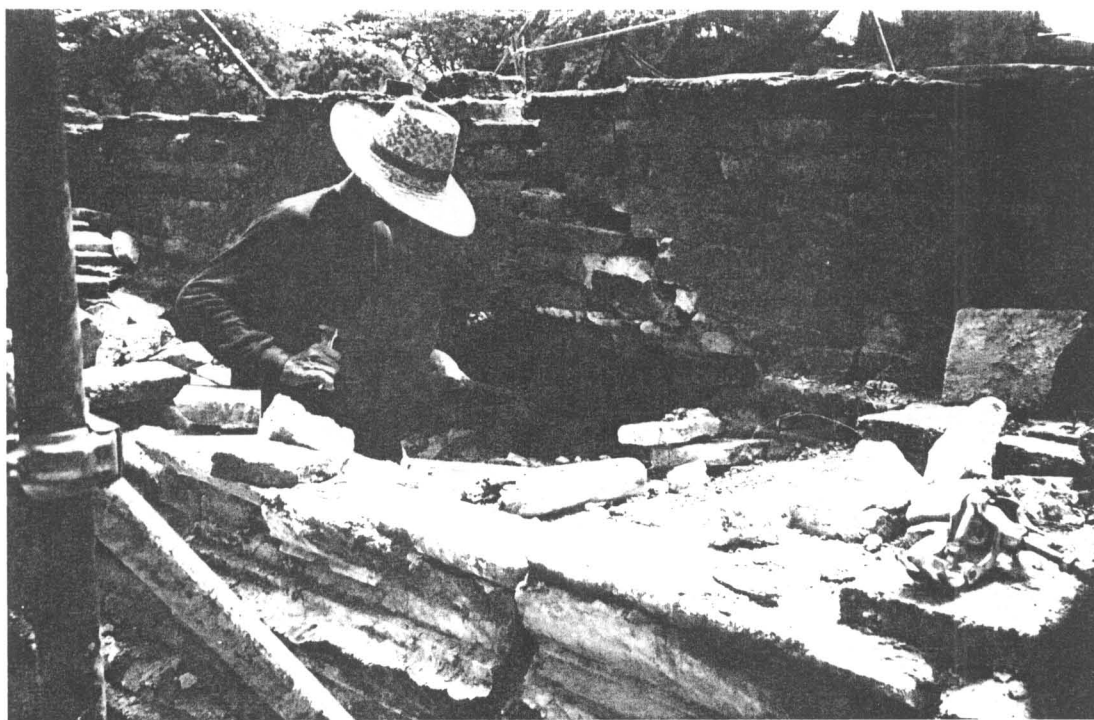
ภาพที่52 ผนังด้านหลังของพระอุโบสถทรุดตัวลง ได้ทำการปรับตักขึ้นกลับเข้าที่เดิม (ฟิล์ม18/14)
