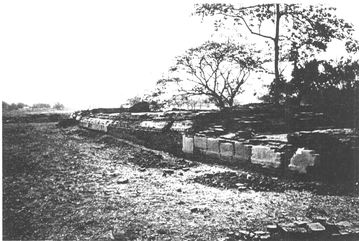
ภาพที่ 200 ภาพแสดง อาคารหมายเลข 3 ด้านทิศใต้ สภาพก่อนบูรณะ (ฟิล์ม 1/29)
