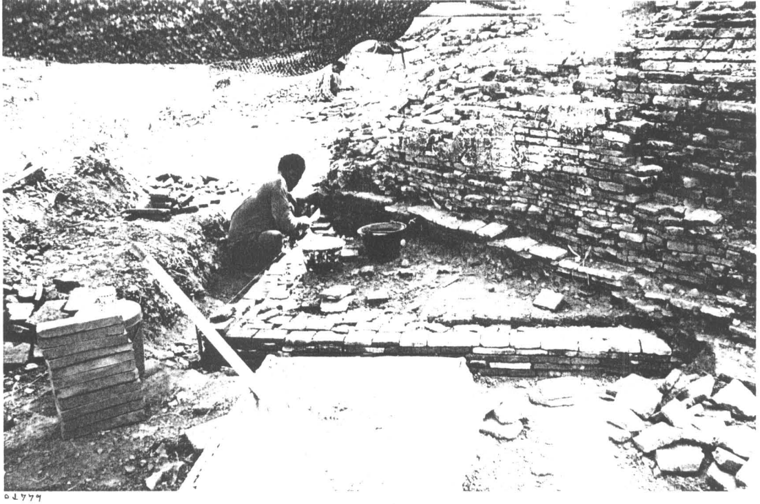
ภาพที่ 160 ภาพแสดงการเริ่มทำการก่ออิฐบุระณะ ทำการก่ออิฐซ่อมแซมจากฐานชั้นล่างสุดก่อน (ฟิล์ม 9/0)
