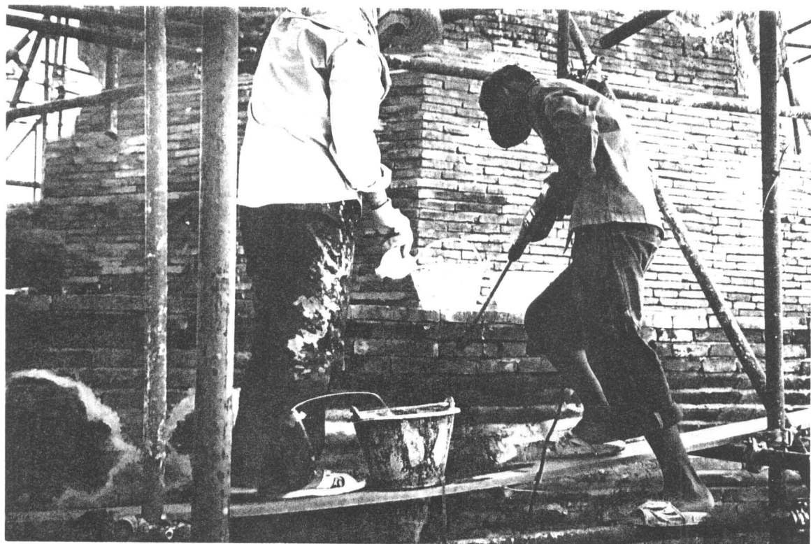
ภาพที่ 24 ทำการเจาะเย็บด้วยสว่าน โดยฝังเหล็กข้ออ้อยมีความยาว 0.80-1.00 เมตร (ฟิล์ม 12/26)
