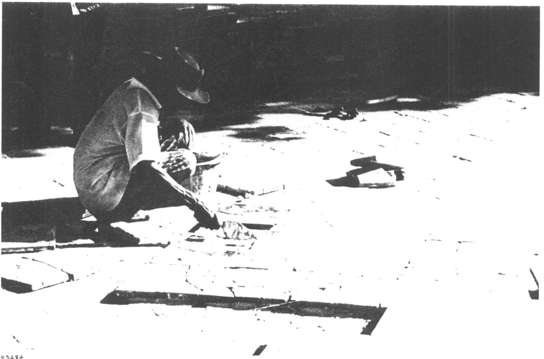
ภาพที่ 67 แสดงให้เห็นว่าพื้นเดิมนั้นมีการปูด้วยกระเบื้องดินเผา และได้ทำการนำกระเบื้องเก่าซึ่งแตกหักได้ทำการต่อด้วยภาววิทยาศาสตร์แล้วนำกลับเข้ามาปูด้วย (ฟิล์ม 7/24)
