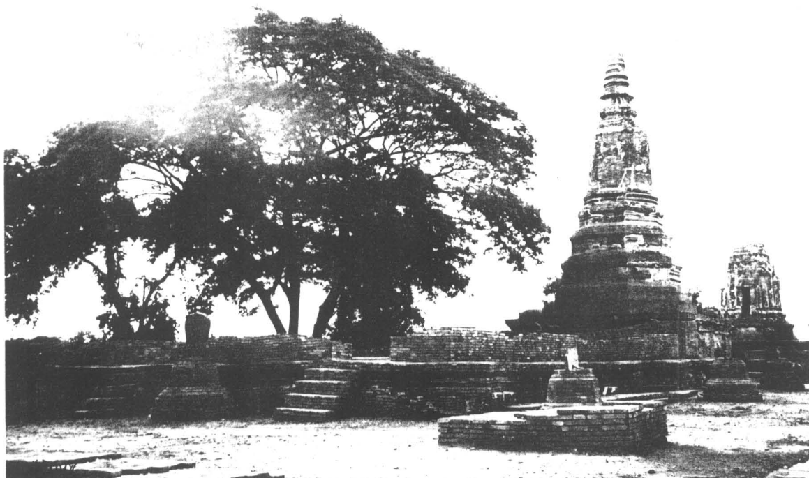
ภาพที่ 76 ภาพพระอุโบสถ สภาพหลังการบูรณะด้านทิศตะวันออกเฉียงเหนือ (ฟิล์ม 14/3)
