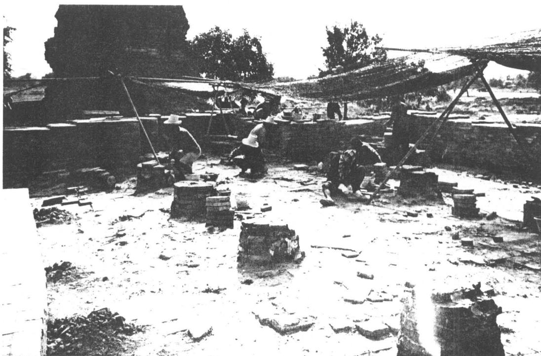
ภาพที่ 129 ทำการก่ออิฐเสริมเสาแปดเหลี่ยมภายในวิหาร (ฟิล์ม 9/9)
