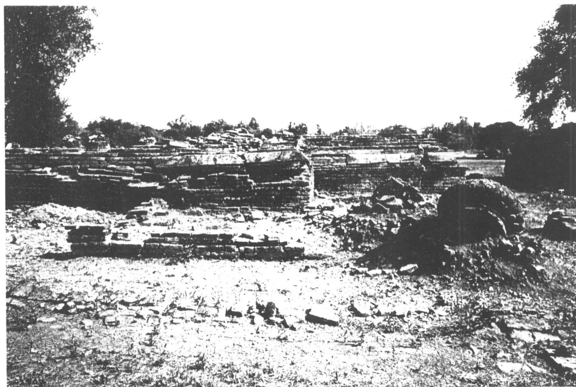
ภาพที่ 241 ภาพแสดง เจดีย์ราย (ด้านทิศเหนือ) สภาพก่อนบูรณะด้านทิศตะวันออกเฉียงเหนือ ของพระวิหาร หมายเลข 4 (ฟิล์ม 2/24)
