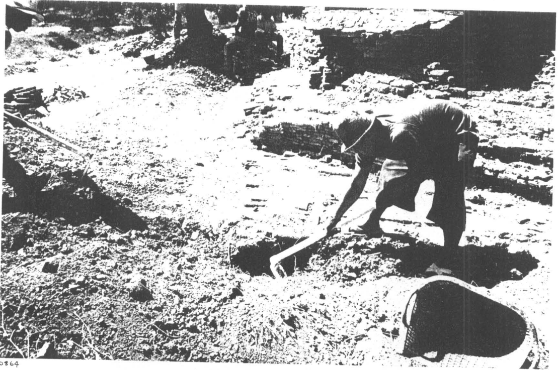
ภาพที่ 157 ภาพแสดงการขุดค้นหาฐานอิฐชั้นล่างสุด เพื่อทำการก่ออิฐซ่อมแซมตั้งแต่อิฐชั้นล่างสุดก่อน (ฟิล์ม 8/34)
