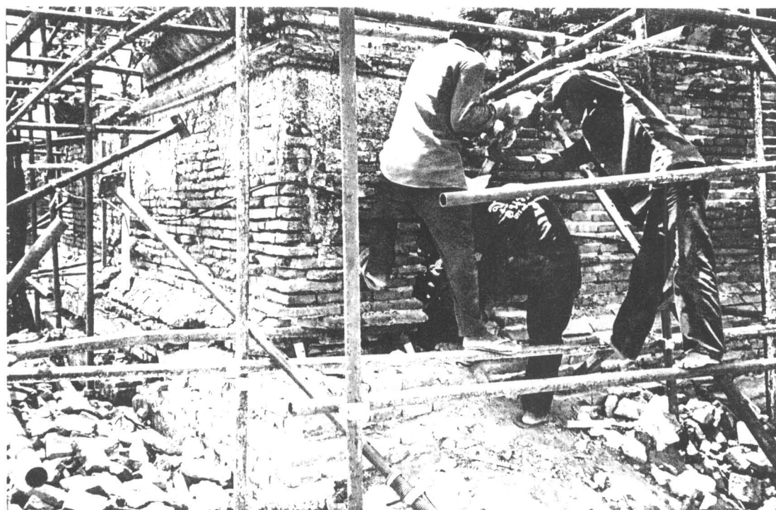
ภาพที่ 11 ใช้แม่แรงยกขึ้น ปรับฐานเจดีย์ที่แยกออกจากกันให้เข้าที่เดิม (ฟิล์ม 5/7)
