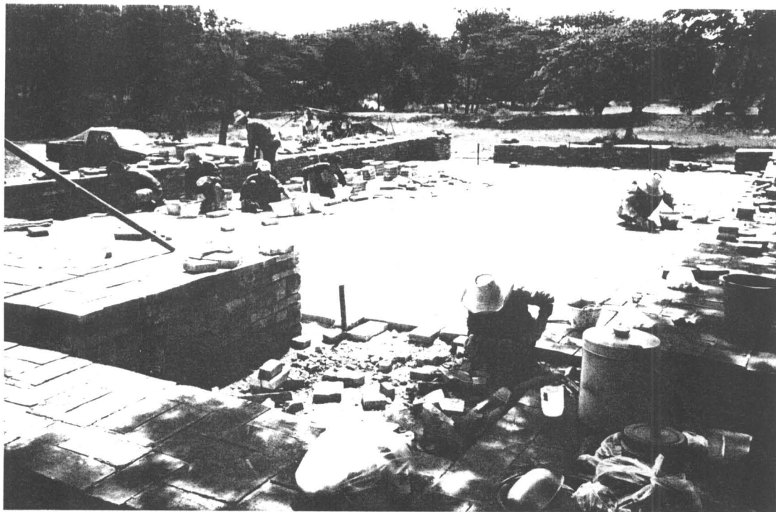
ภาพที่ 60 เมื่อบดอัดพื้นจนได้ที่แล้ว จึงทำการปูด้วยอิฐใหญ่ขนาดเท่าของเดิม ลักษณะการปู ได้ยึดลักษณะ การปูอิฐของเดิมเป็นหลัก (ฟิล์ม 5/28)
