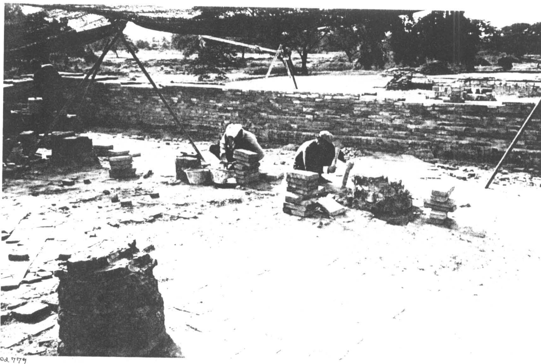
ภาพที่ 130 ทำการก่ออิฐเสริมเสาแปดเหลี่ยมภายในวิหาร (ฟิล์ม 9/8)
