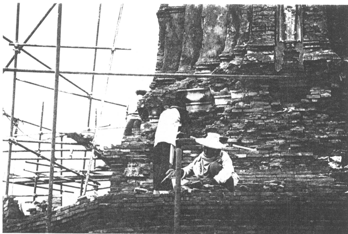
ภาพที่ 180 ภาพแสดงการก่ออิฐซ่อมแซมฐานย่อมุมของเรือนธาตุ ด้านทิศเหนือ (ฟิล์ม 6/9)
