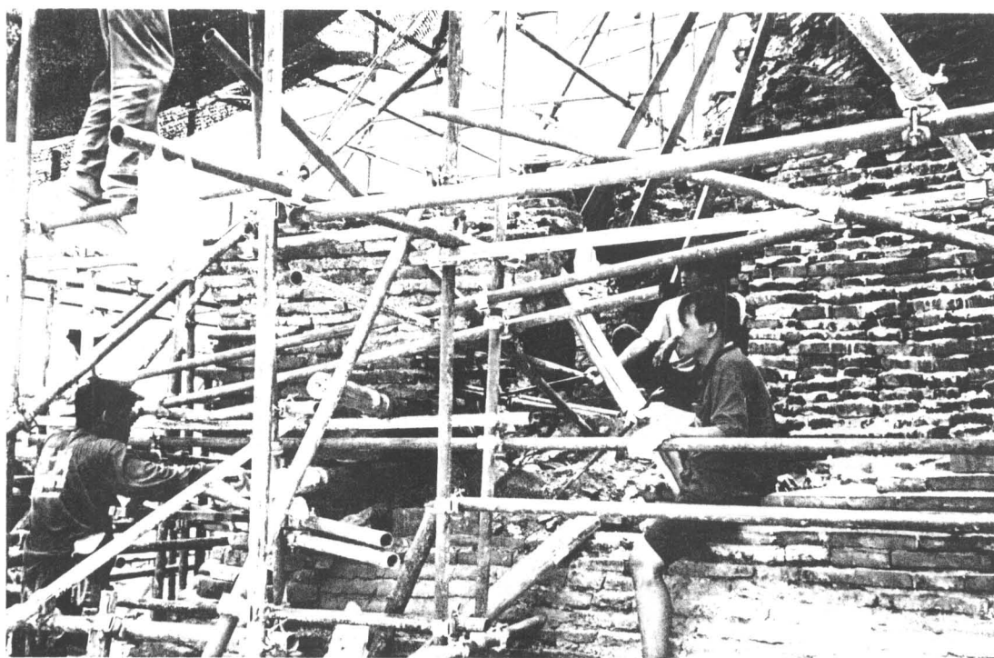
ภาพที่ 13 ขณะทำการยกขึ้นส่วนของฐานเจดีย์ให้กลับเข้าในตำแหน่งเดิม (ฟิล์ม 5/9)
