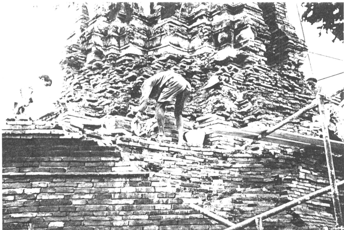
ภาพที่ 176 ภาพแสดงการก่ออิฐเสริมฐานย่อมุมของเรือนธาตุ ด้านทิศตะวันตกเฉียงเหนือ (ฟิล์ม 6/11)
