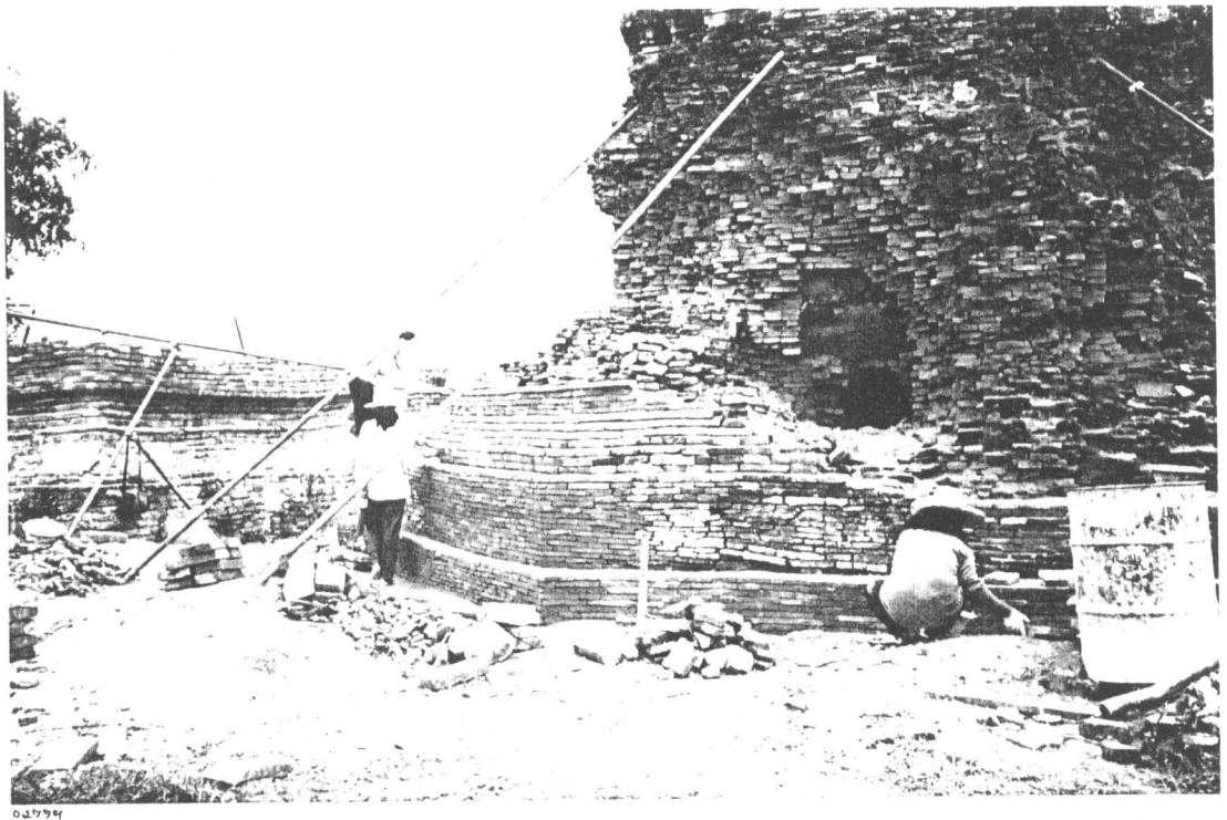
ภาพที่ 167 ภาพแสดงการก่ออิฐซ่อมแซมฐานแปดเหลี่ยมของเจดีย์ ด้านทิศตะวันออกเฉียงเหนือ (ฟิล์ม 9/19)
