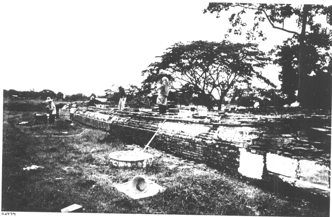
ภาพที่ 211 ภาพแสดง การก่ออิฐซ่อมแซมและก่ออิฐเสริมฐานอาคารหมายเลข 3 (ฟิล์ม 9/18)
