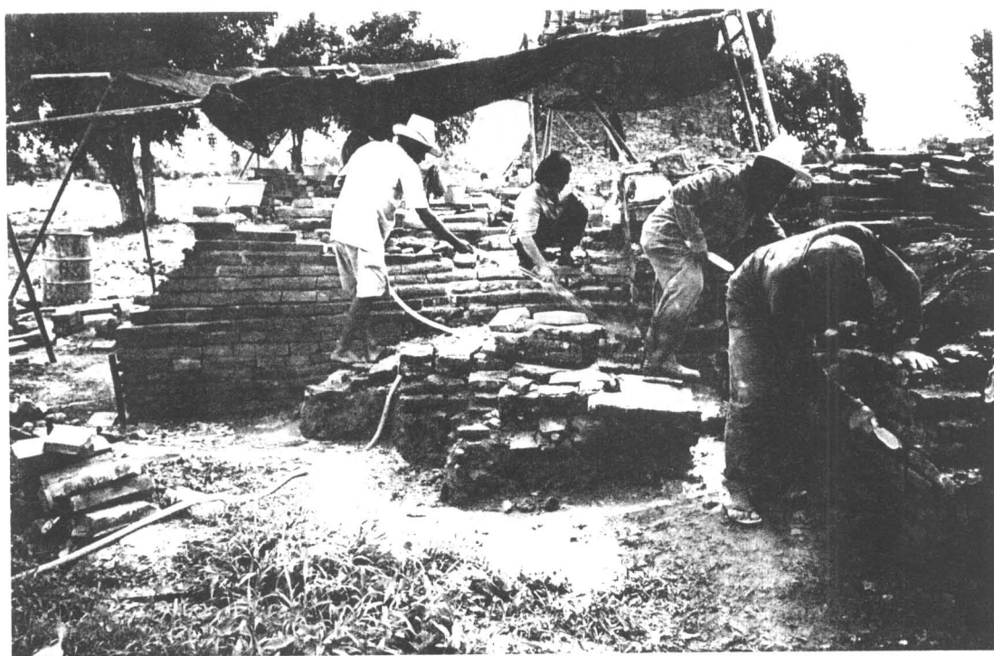
ภาพที่ 109 ล้างทำความสะอาดก่อนก่ออิฐซ่อมแซม (ฟิล์ม 8/9)
