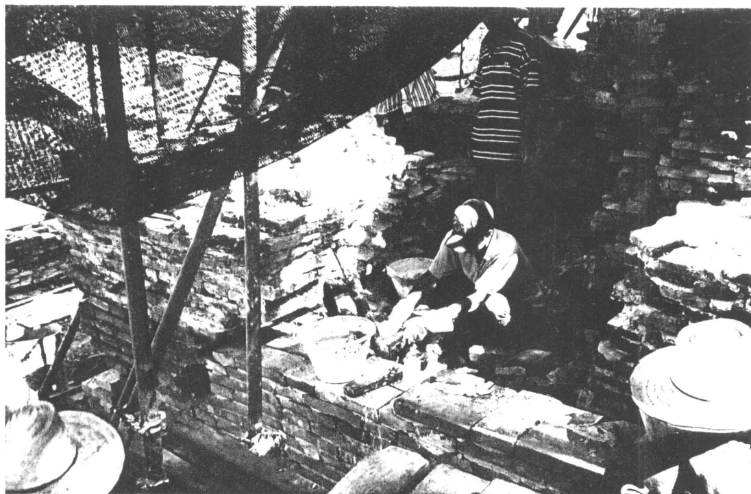
ภาพที่ 19 ทำการก่ออิฐซ่อมแซมฐานเจดีย์ (ฟิล์ม 5/18)
