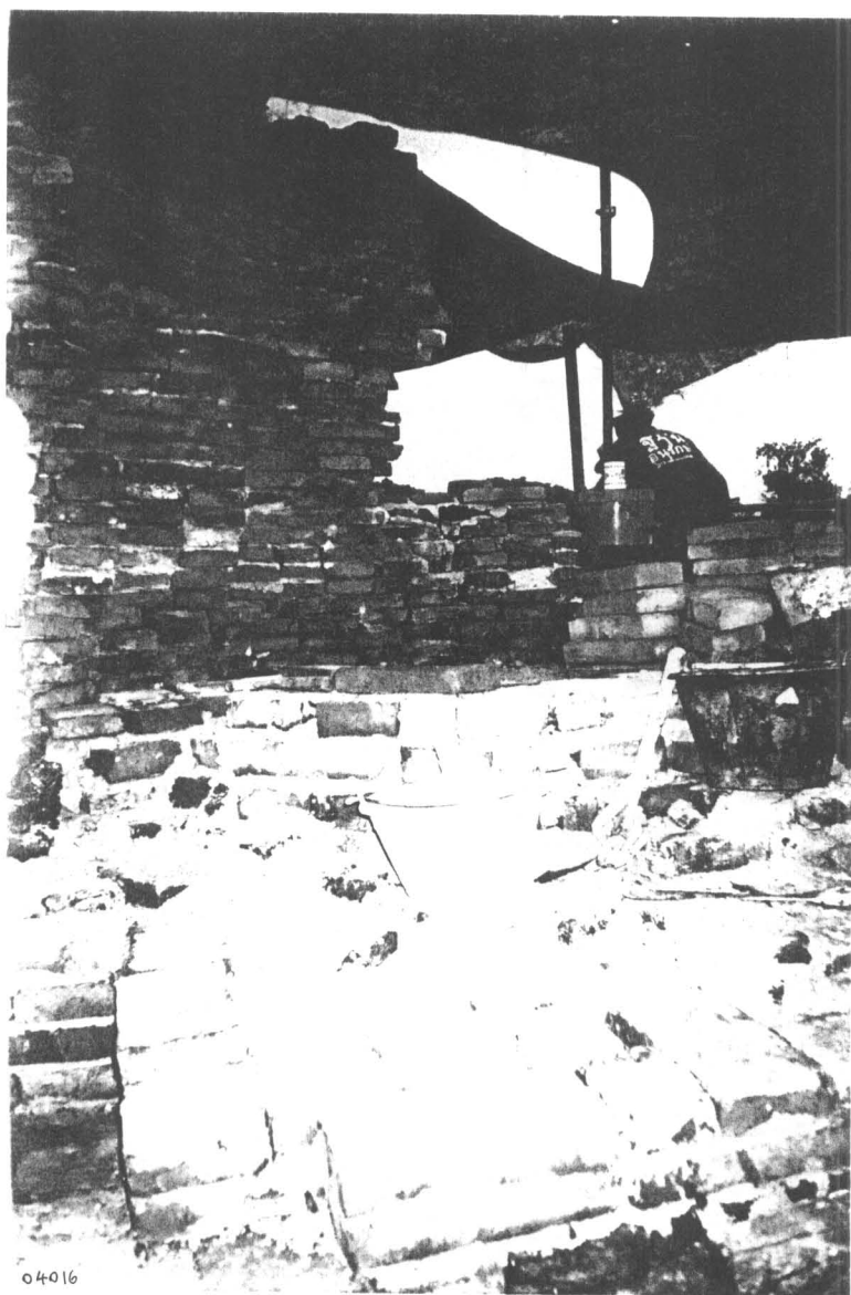
ภาพที่ 186 ก่ออิฐปิดส่วนยอดของเจดีย์เหนือซุ้มเรือนธาตุ (ฟิล์ม 11/13)
