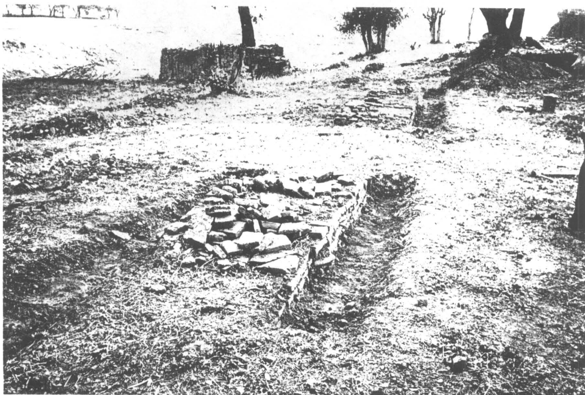
ภาพที่ 261 ภาพแสดง แนวกำแพงแก้วหลังการขุดแต่ง (ฟิล์ม 4/32)
