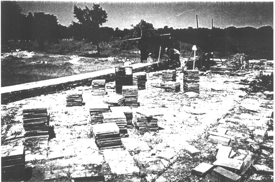
ภาพที่ 218 ภาพแสดง การรื้อกระเบื้องดินเผาพื้นเดิมออก เพื่อนำไปทำความสะอาด (ฟิล์ม 12/15)
