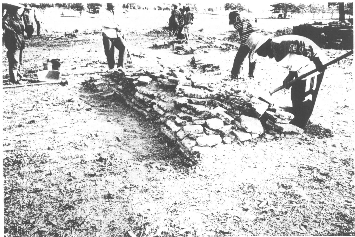
ภาพที่ 258 ภาพแสดง การขุดลอกดินหาแนวฐานกำแพงแก้ว ด้านทิศตะวันออก ก่อนทำการก่ออิฐซ่อมแซม (ฟิล์ม 4/31)
