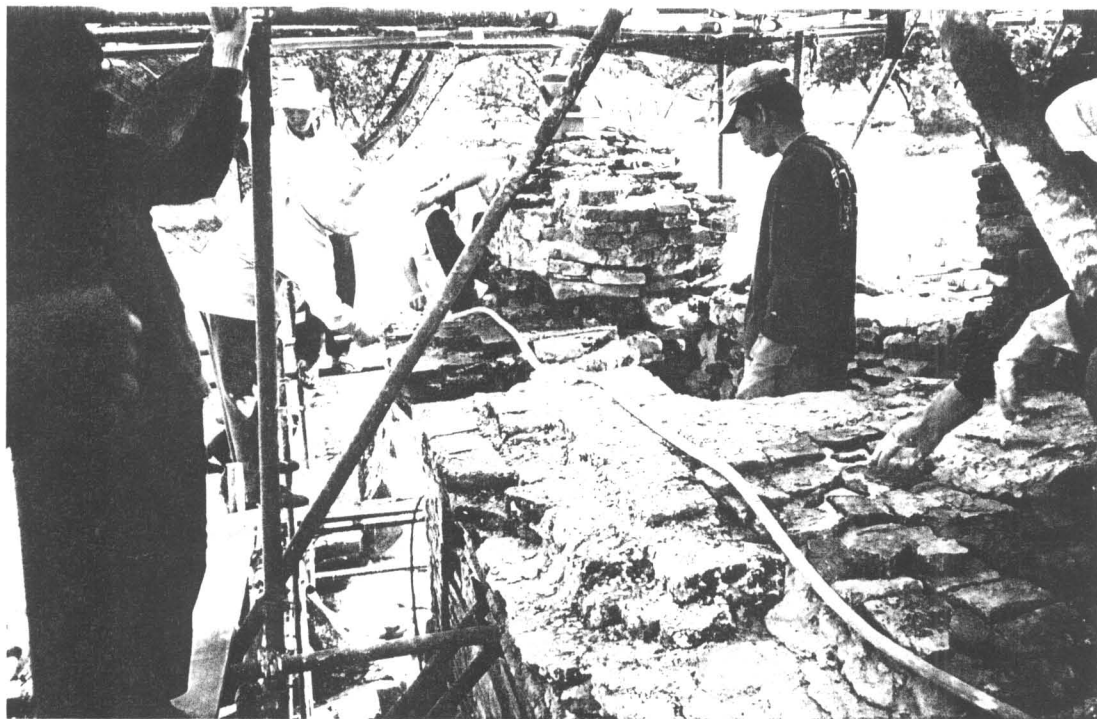
ภาพที่ 18 ล้างทำความสะอาดก่อนก่ออิฐซ่อมฐานเจดีย์ (ฟิล์ม 5/12)
