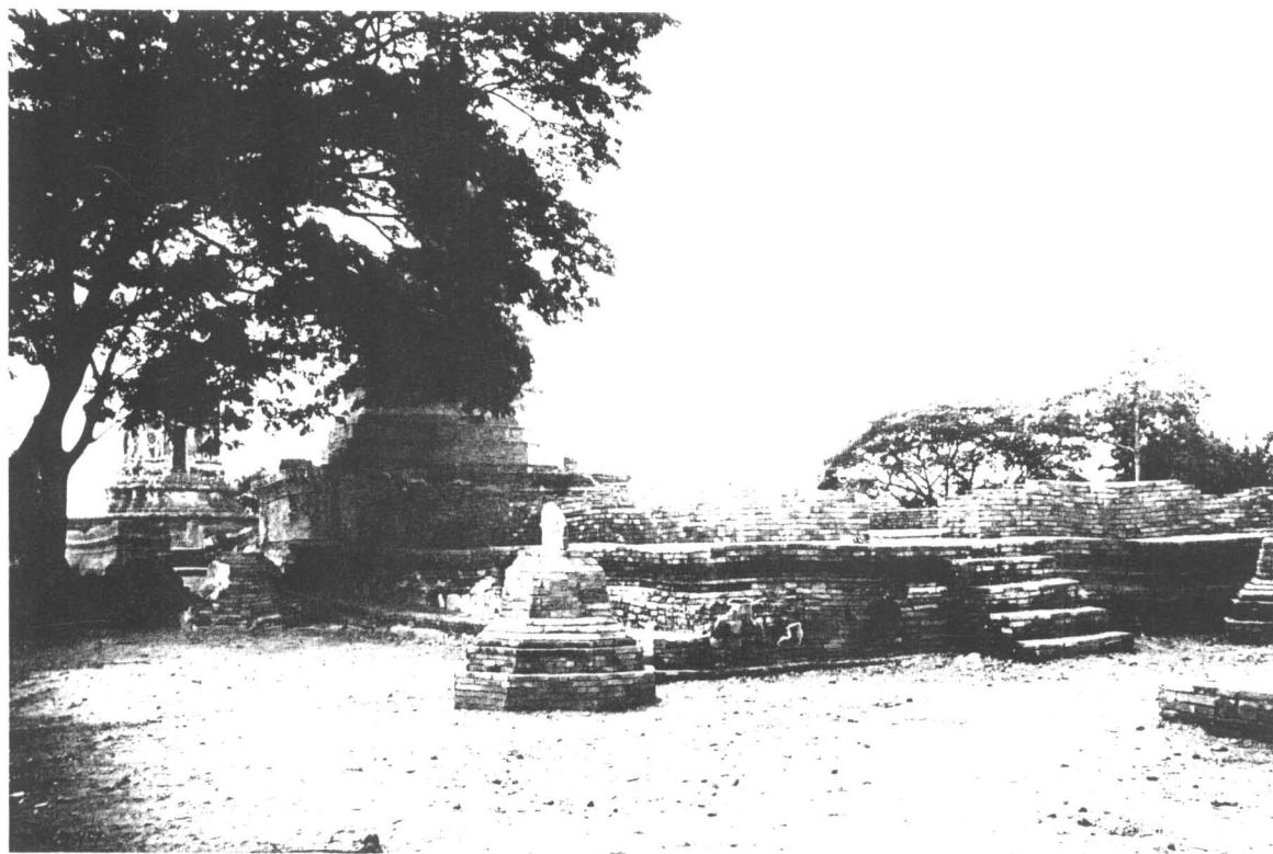
ภาพที่ 77 ภาพพระอุโบสถ สภาพหลังการบูรณะด้านทิศตะวันออกเฉียงใต้ (ฟิล์ม 14/6)
