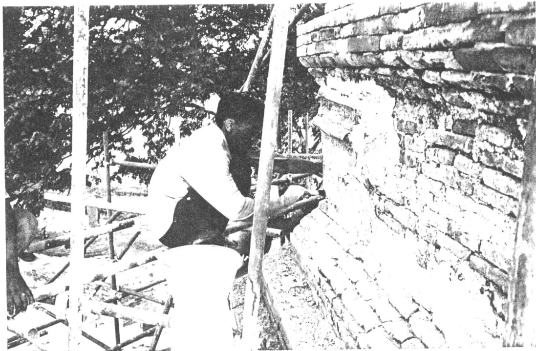
ภาพที่ 25 หลังจากทำการก่ออิฐซ่อมแซมแล้วเสร็จ จึงทำการอนุรักษ์ปูนฉาบของเดิมไว้ (ฟิล์ม 8/30)
