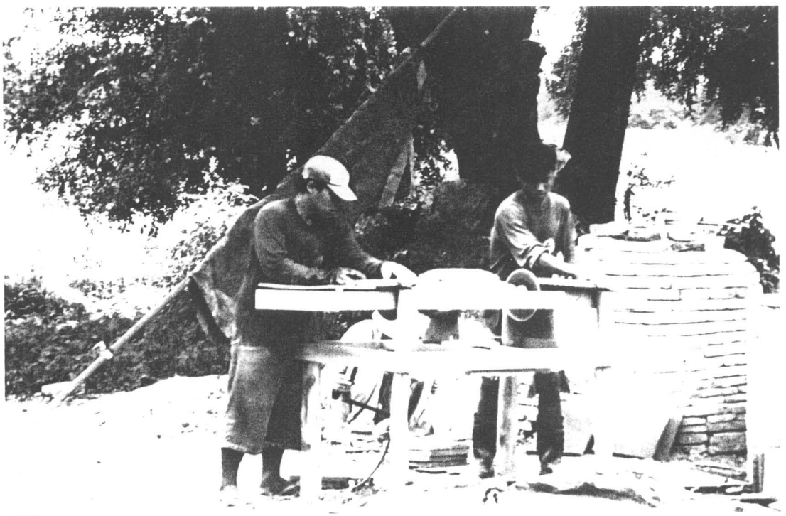
ภาพที่ 63 ภาพแสดง การซัดขอบกระเบื้องใหม่ให้เรียบ เพื่อนำไปปูพื้นภายในอาคารหมายเลข 3 , วิหารหมายเลข 4 , พระอุโบสถหมายเลข 5 (ฟิล์ม 10/28)
