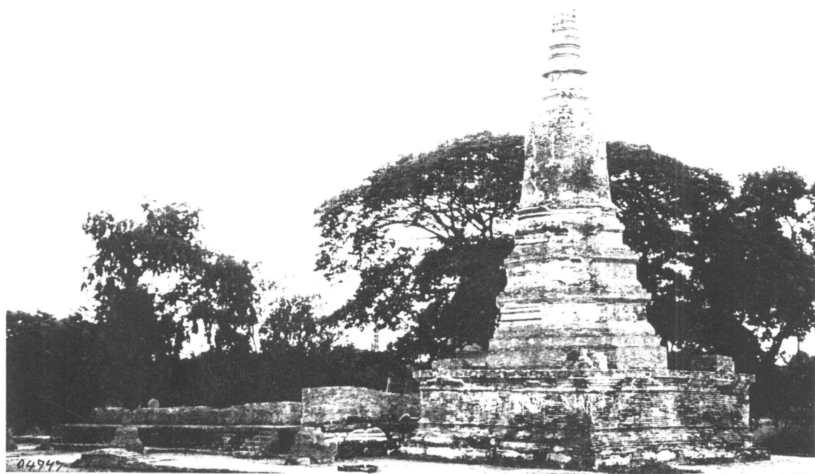
ภาพที่ 35 ภาพเจดีย์หมายเลข 1 แสดงสภาพหลังการบูรณะ ด้านทิศตะวันตกเฉียงเหนือ (ฟิล์ม 14/14)
