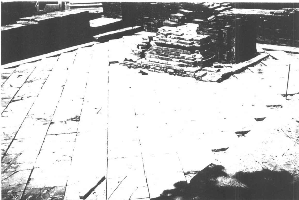
ภาพที่ 222 ภาพแสดง การปูพื้นกระเบื้องดินเผาภายใน อาคารหมายเลข 3 (ฟิล์ม 15/4)
