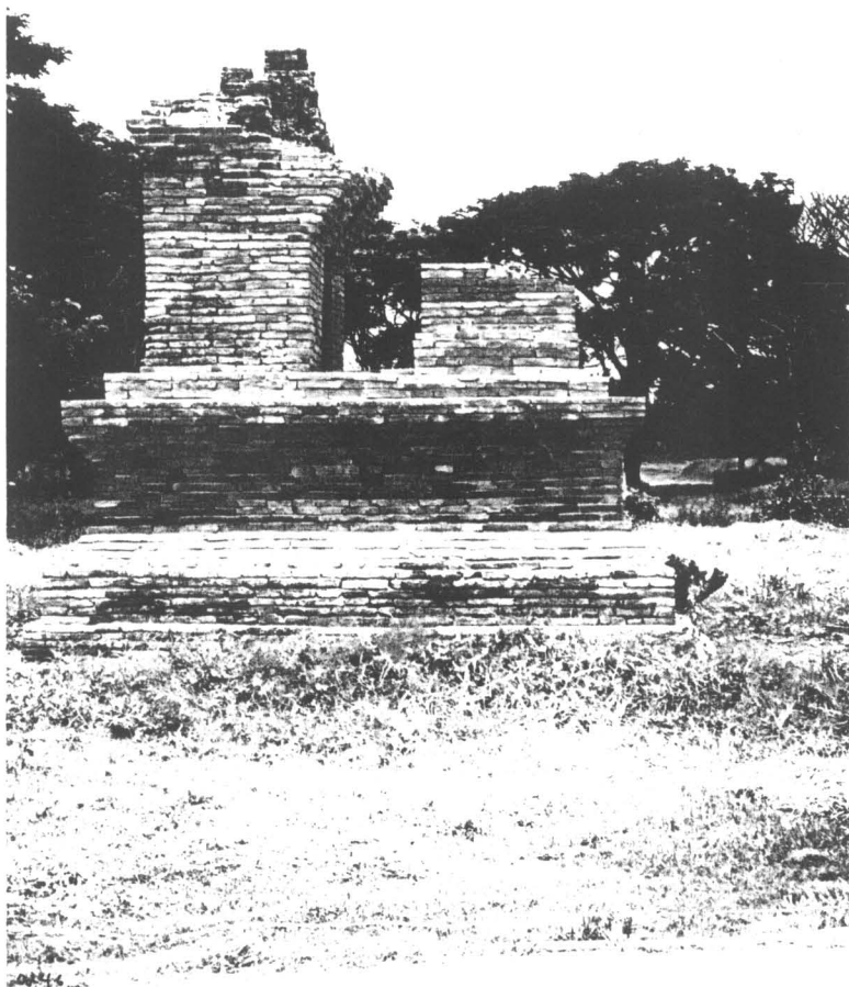
ภาพที่ 237 ภาพแสดง หอระฆังสภาพหลังการบูรณะ ด้านทิศใต้ (ฟิล์ม 16/14)
