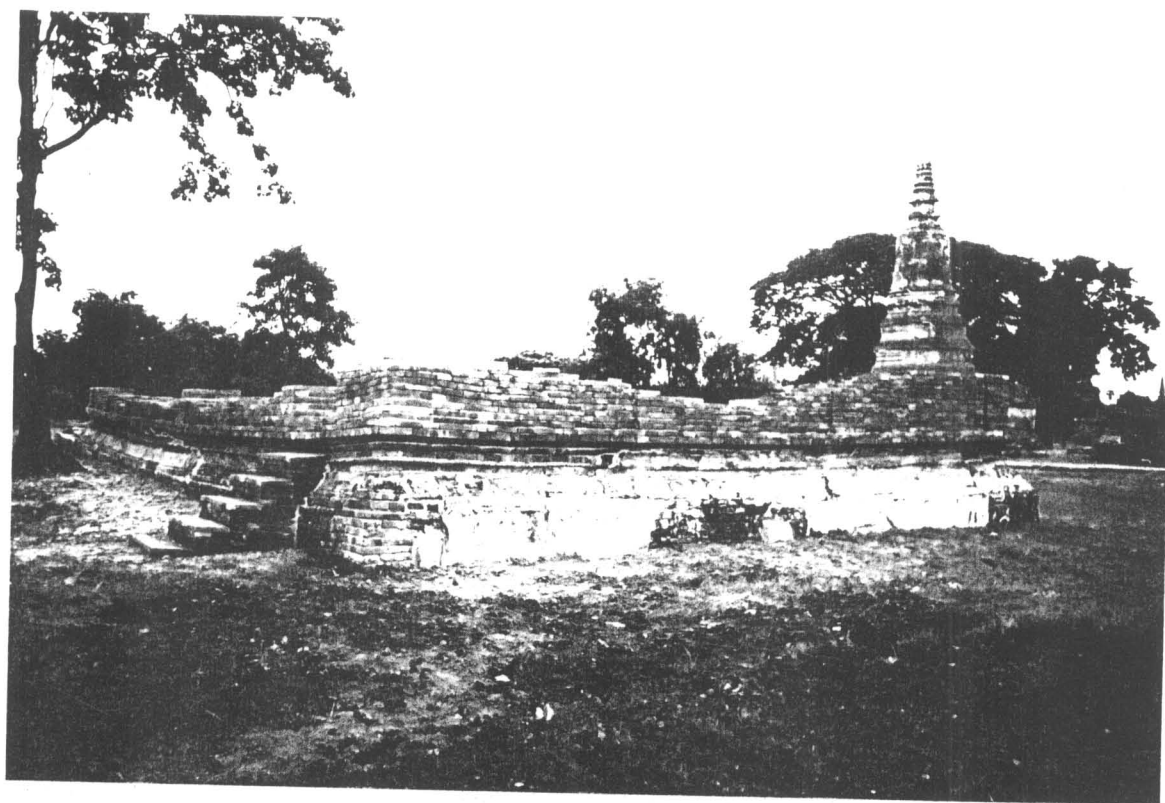
ภาพที่ 227 ภาพแสดง อาคารหมายเลข 3 ด้านทิศตะวันตกเฉียงเหนือ สภาพหลังการบูรณะ (ฟิล์ม 19/35)
