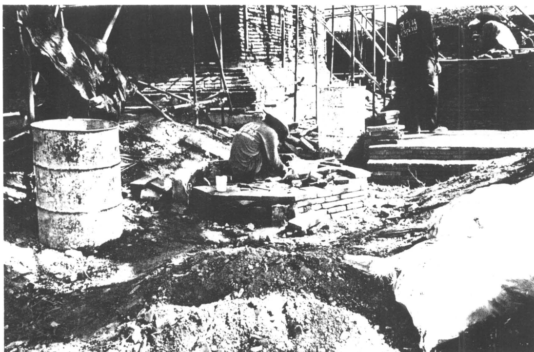
ภาพที่ 87 ทำการก่ออิฐเสริมตามรูปแบบเดิม (ฟิล์ม 18/7)
