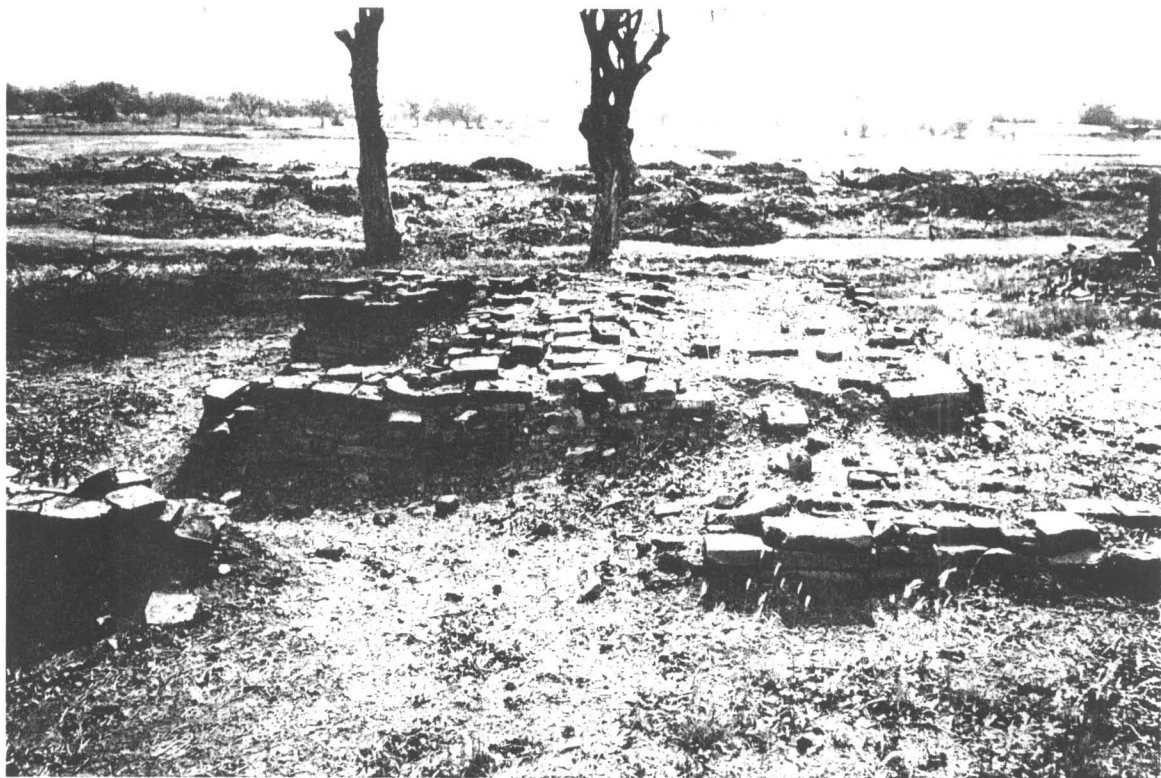
ภาพที่ 242 ภาพแสดง เจดีย์ราย (ด้านทิศเหนือ) สภาพก่อนบูรณะด้านทิศตะวันตกเฉียงใต้ ของพระวิหารมหาย เลข 4 (ฟิล์ม 2/18)
