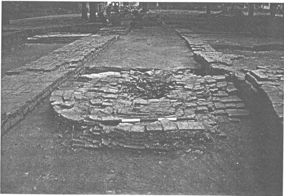
ภาพที่ 84 เจดีย์รายหมายเลข 4.2 ด้านตะวันตก ภายหลังจากการขุดแต่ง
