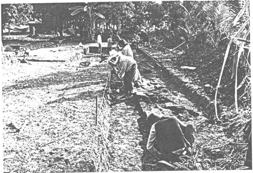
ภาพที่ 16 ขณะขุดแต่งแนวกำแพงวัดระยะที่สองด้านใต้
