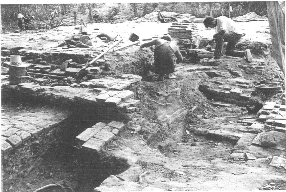
ภาพที่ 60 ขณะขุดแต่งฐานวิหารระยะแรก
