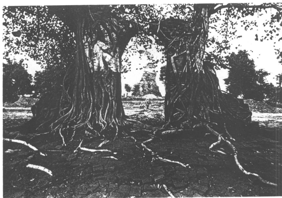
ภาพที่ 78 สภาพของซุ้มประตูด้านทิศตะวันออก หลังการขุดแต่ง
