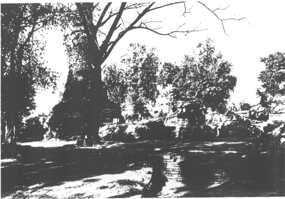
ภาพที่ 170 สภาพของเจดีย์และวิหารวัดตะไกร ที่วิหารตั้งอยู่ด้านหน้าเจดีย์ประธาน ซึ่งมีเจดีย์รายล้อมรอบเจดีย์และวิหาร
