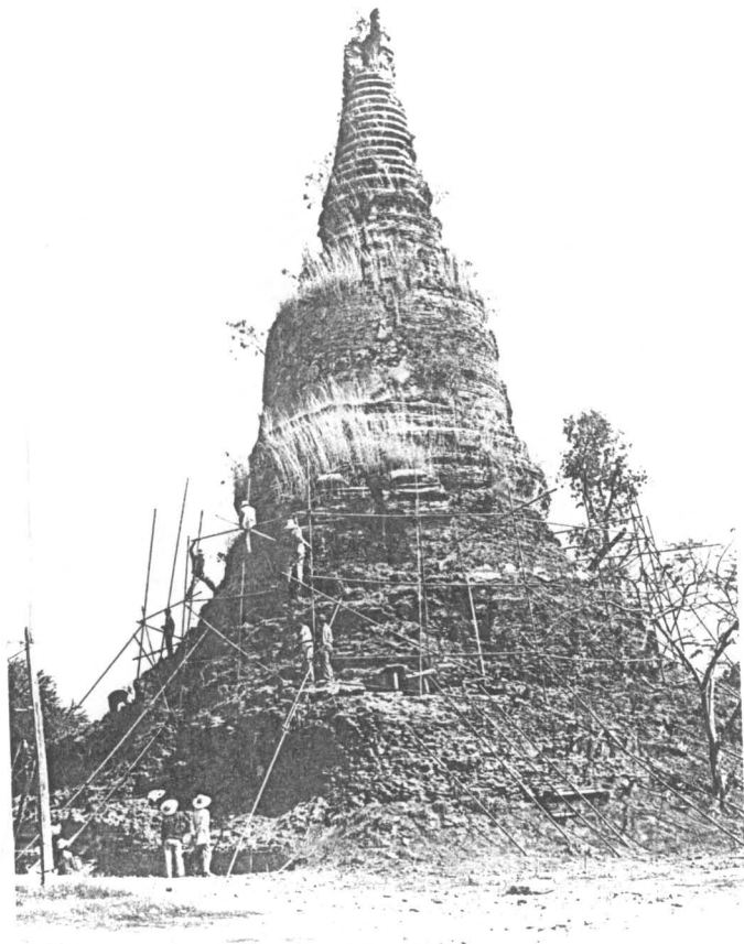
ภาพที่ 10 ขณะปฏิบัติงานการตักนั่งร้านมูมตะวันตกเฉียงใต้ของเจดีย์ประธาน
