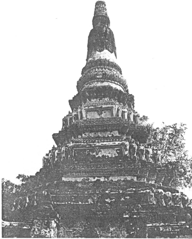
ภาพที่ 69 เจดีย์ทรงเครื่องด้านเหนือหลังขุดแต่ง
