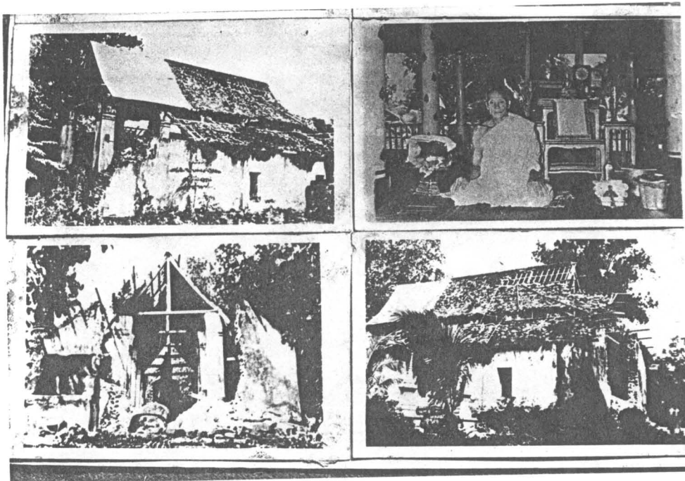
ภาพที่ 237 ภาพถ่ายพระอุโบสถเก่าก่อนบูรณะใหม่บนรากฐานเดิม
