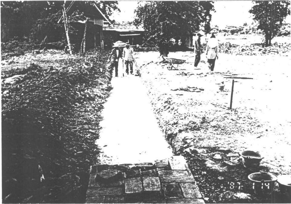
รูปที่ 44 ขณะเทพื้นคอนกรีตฐานรากกำแพงแก้วด้านทิศตะวันตก
