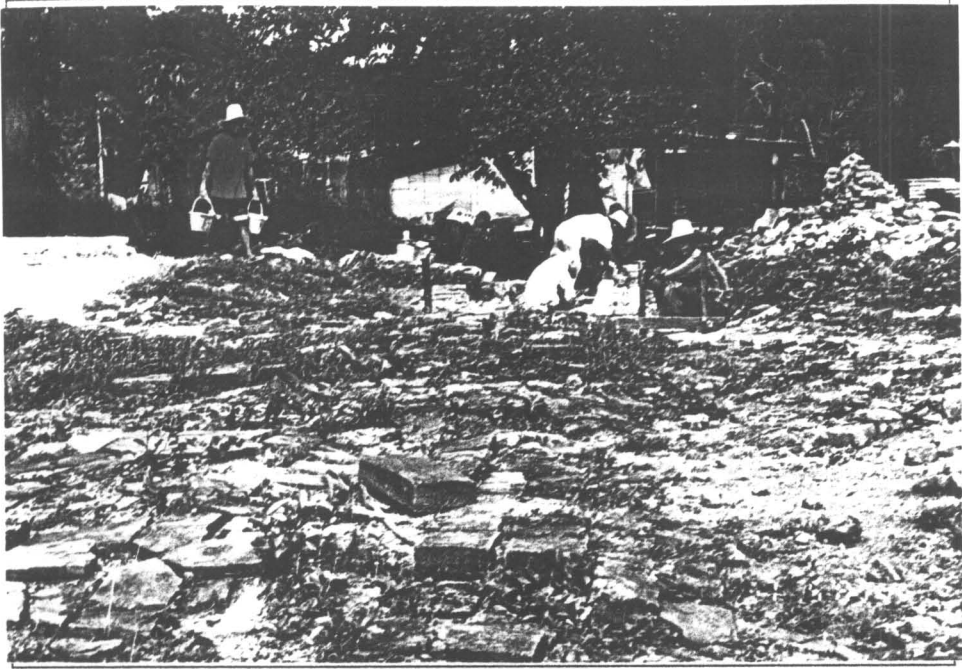
รูปที่ 16 การปูพื้นซากอาคารด้านทิศเหนือ
