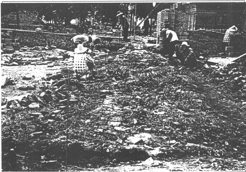
รูปที่ 43 เฉลียงทางเดินด้านทิศตะวันออก ขณะทำการบูรณะ
