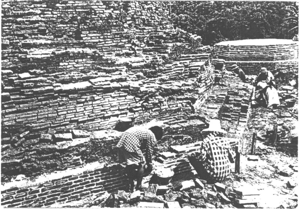
รูปที่ 22 ก่ออิฐเสริมบริเวณฐานเขียงชั้นล่าง
