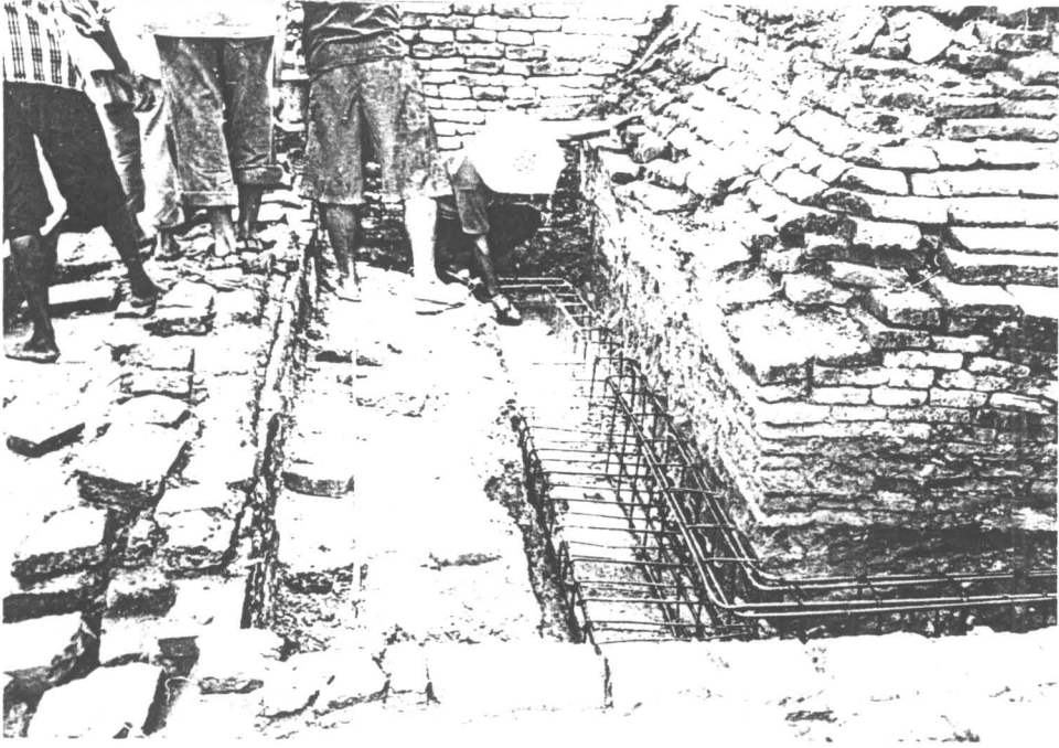
รูปที่ 32 เทศานค.ส.ล.บริเวณพื้นระเบียงชั้นล่าง
