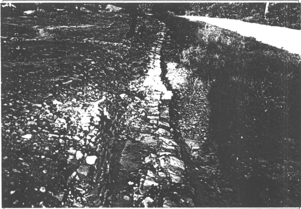
รูปที่ 19 แนวกำแพงกันดินด้านทิศใต้ ก่อนดำเนินการบูรณะ
