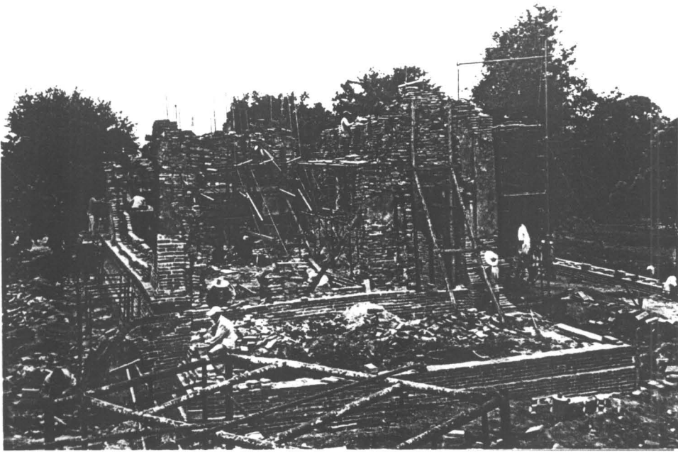
รูปที่ 30 สภาพทั่วไปของอุโบสถ ขณะทำการบูรณะ
