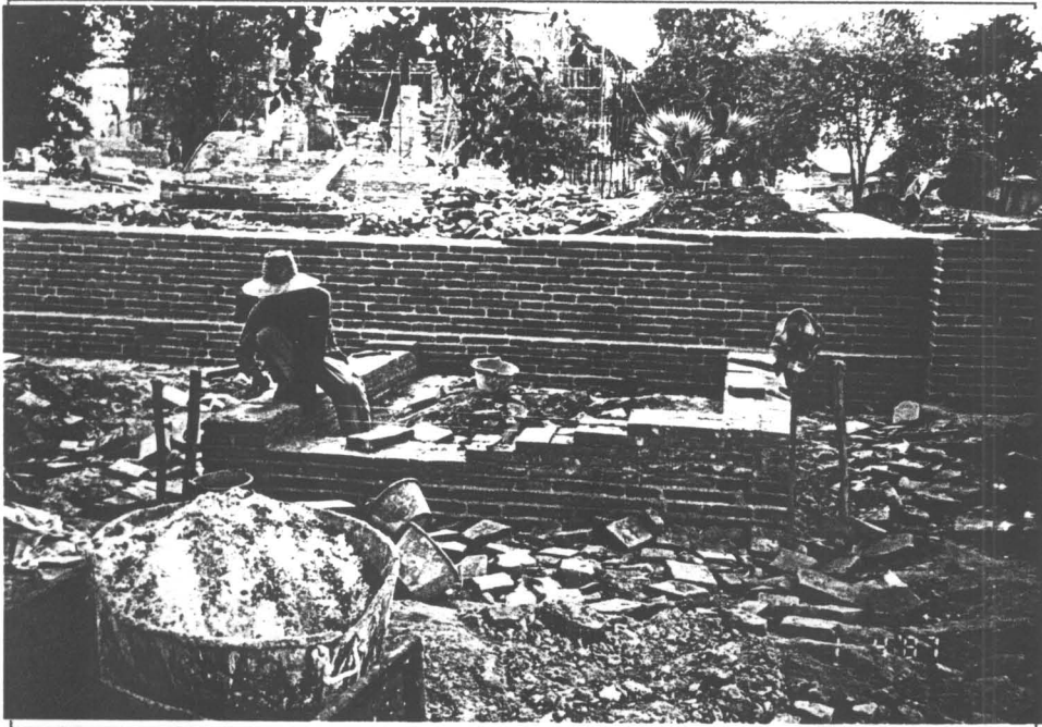
รูปที่ 39 ซากอาคารฝั่งตะวันออกเฉียงเหนือ ขณะทำการบูรณะ
