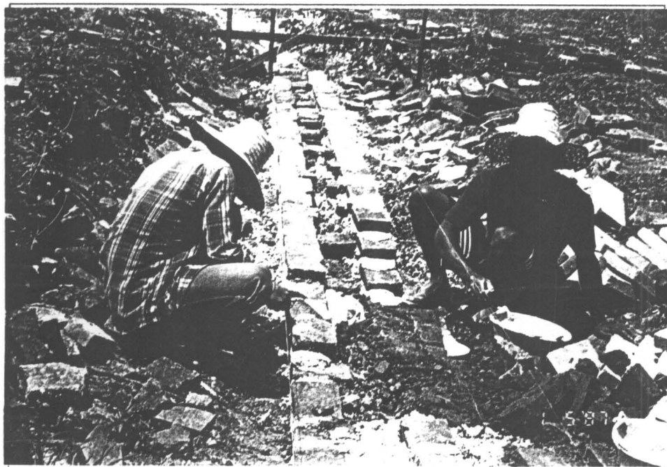
รูปที่ 46 กำแพงกันดิน ขณะทำการบูรณะ
