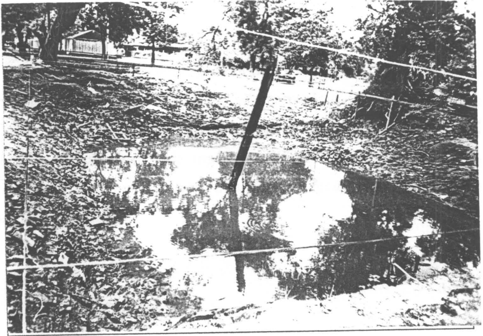
รูปที่ 17 สภาพโดยทั่วไปของสระน้ำ ก่อนดำเนินการบูรณะ (11/33)
