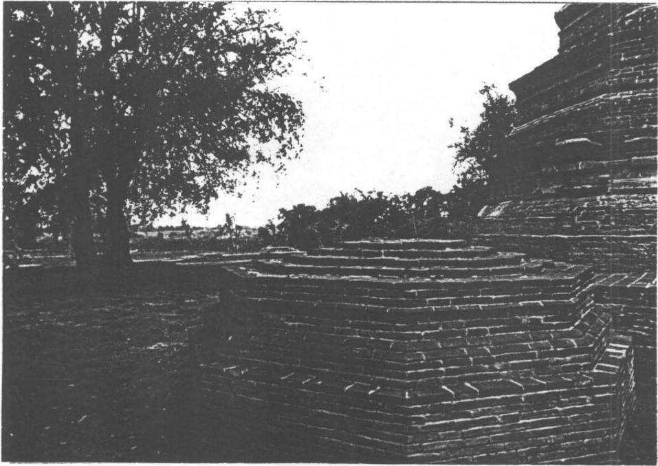
รูปที่ 59 เจดีย์รายหมายเลข 1 ภายหลังจากดำเนินการบูรณะ (31/7)
