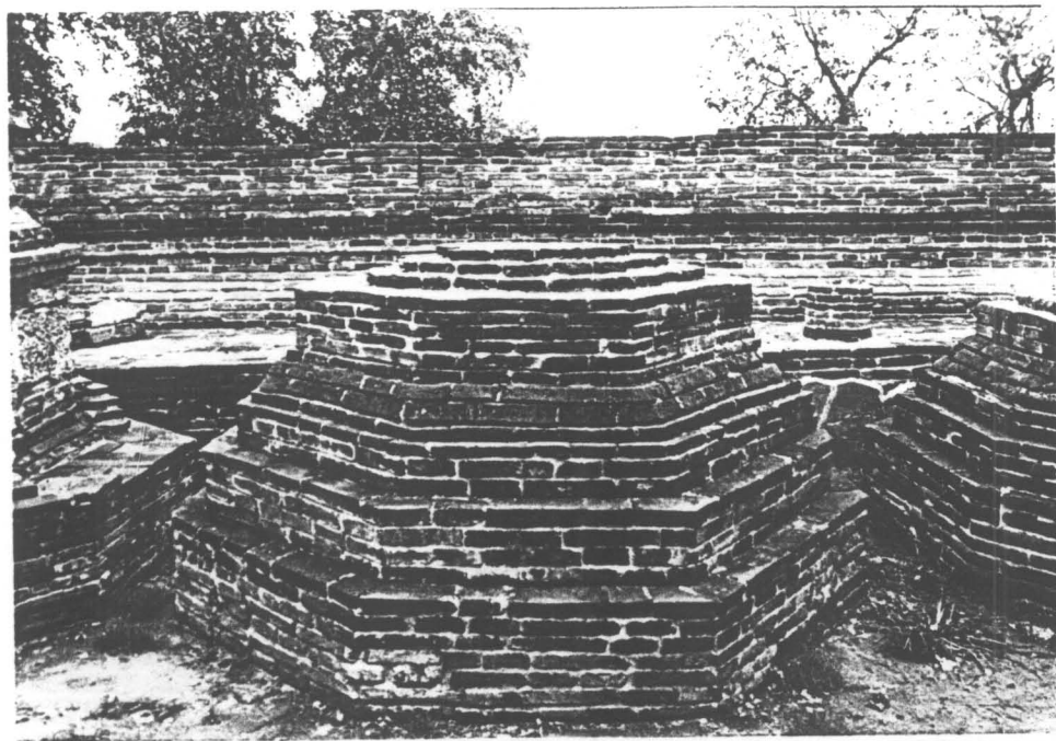
รูปที่ 66 เจดีย์รายหมายเลข 8 ภายหลังจากดำเนินการบูรณะ (31/14)
