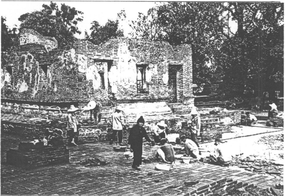
รูปที่ 42 ดำเนินการปูพื้นอิฐ บริเวณลานประทักษิณของอุโบสถ (23/4)
