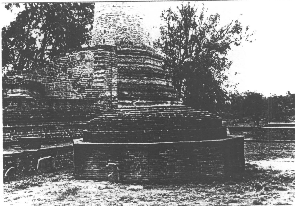
รูปที่ 73 เจดีย์รายหมายเลข 15 ภายหลังจากดำเนินการบูรณะ (31/21)
