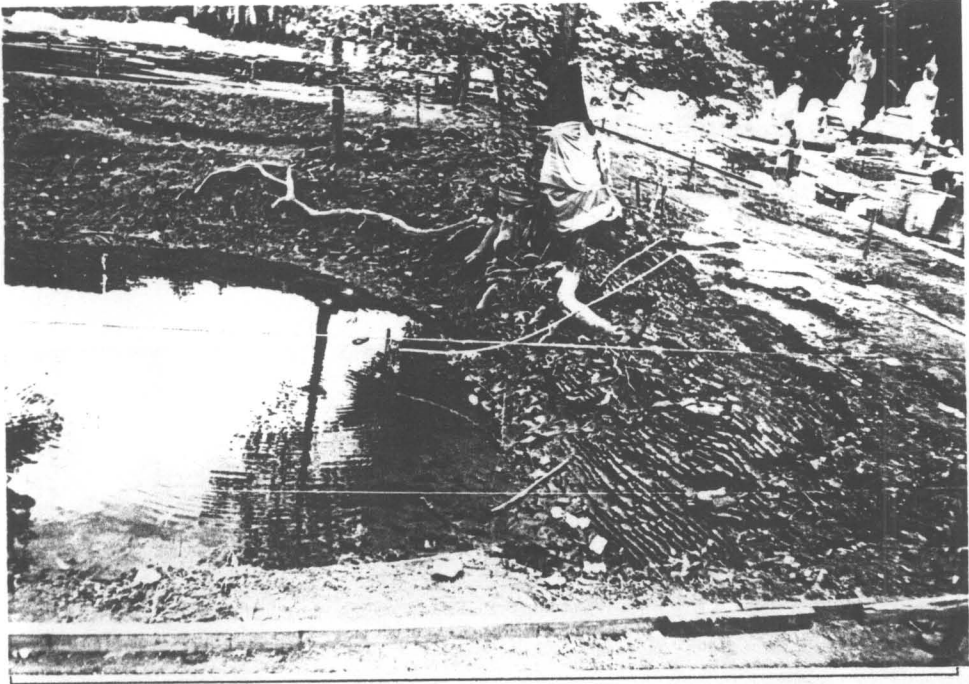
รูปที่ 16 สภาพโดยทั่วไปของสระน้ำ ก่อนดำเนินการบูรณะ (1/ 2)
