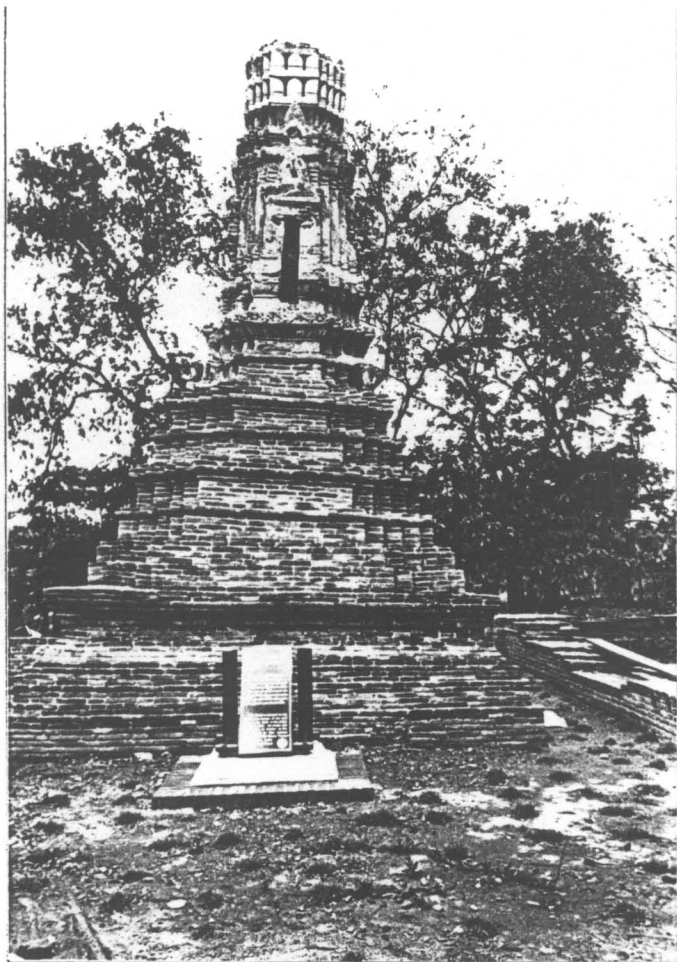
รูปที่ 74 เจดีย์ทรงปราสาท ภายหลังจากดำเนินการบูรณะ (31/22)
