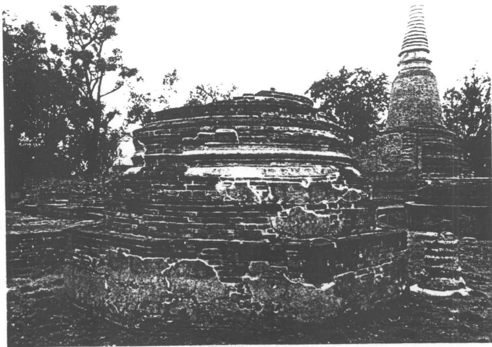
รูปที่ 72 เจดีย์รายหมายเลข 14 ภายหลังจากดำเนินการบูรณะ (31/20)
