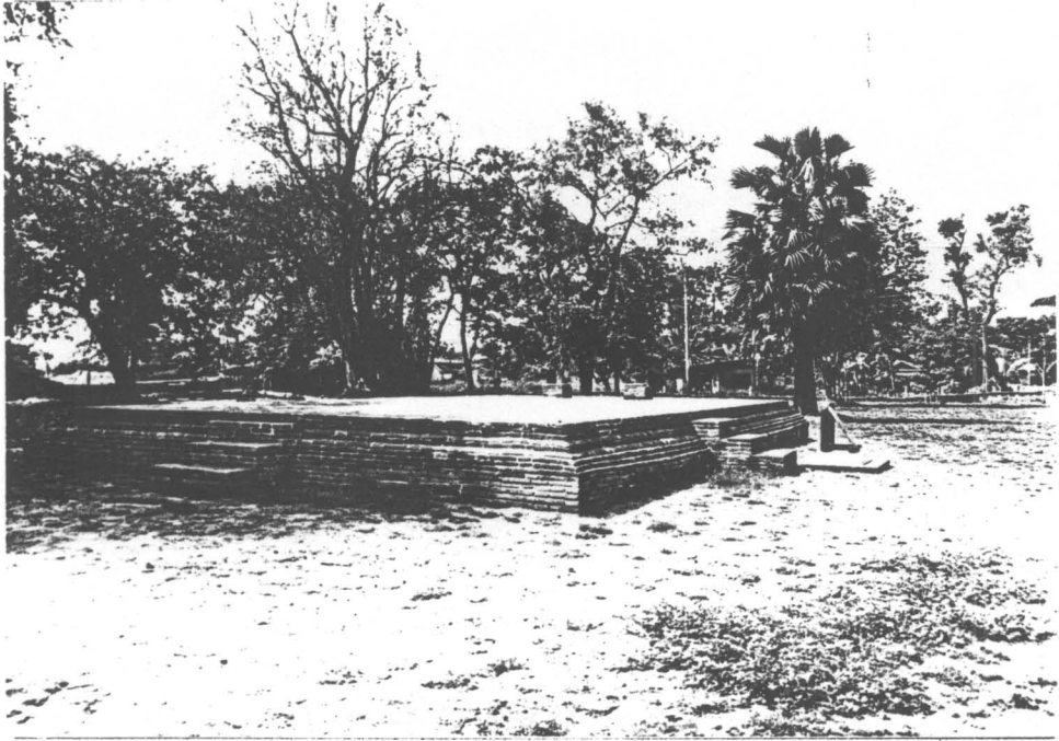
รูปที่ 80 อาคารด้านหน้าสระน้ำ ภายหลังจากดำเนินการบูรณะ (31/28)
