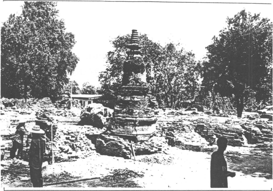
รูปที่ 8 เจดีย์รายภายในวัดตะไกร ก่อนดำเนินการบูรณะ (4/12)
