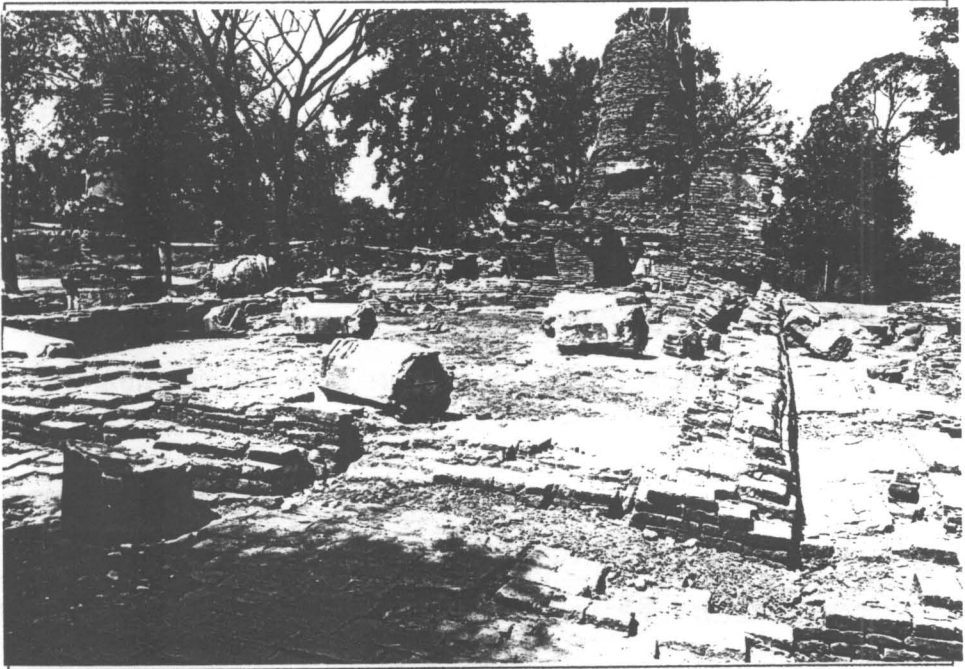
รูปที่ 4 สภาพโดยทั่วไปของวิหาร ก่อนดำเนินการบูรณะ (4/18)
