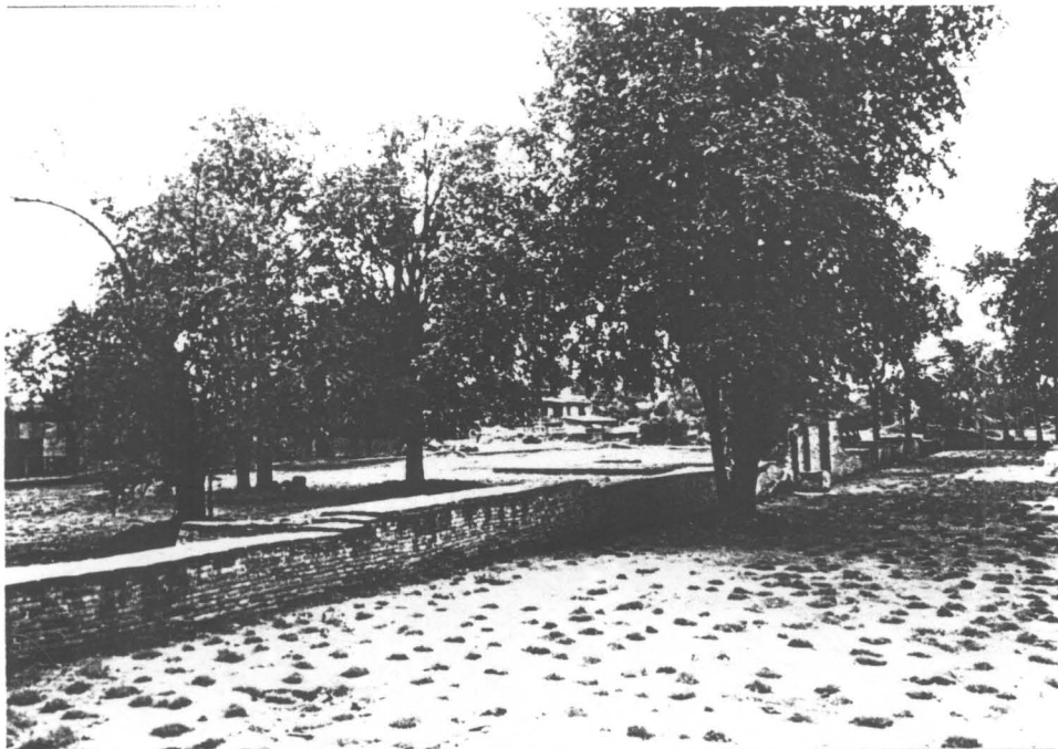
รูปที่ 75 กำแพงแก้ว ภายหลังจากดำเนินการบูรณะ (31/23)
