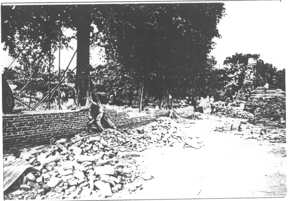
รูปที่ 49 ดำเนินการบูรณะแนวกำแพงวัด (10/16)
