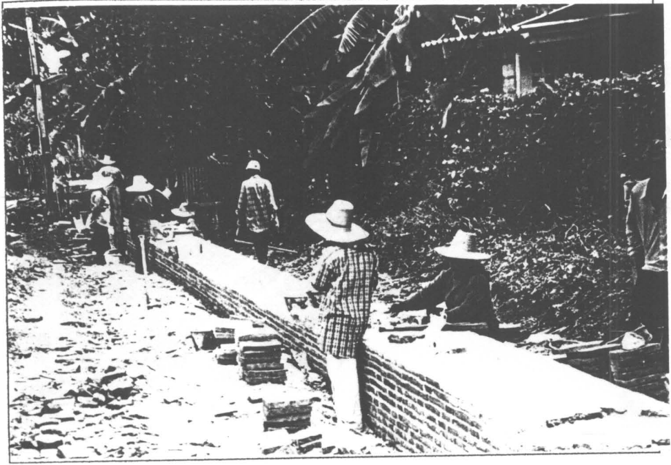
รูปที่ 48 ก่ออิฐเสริมแนวกำแพงวัด (15/2)
