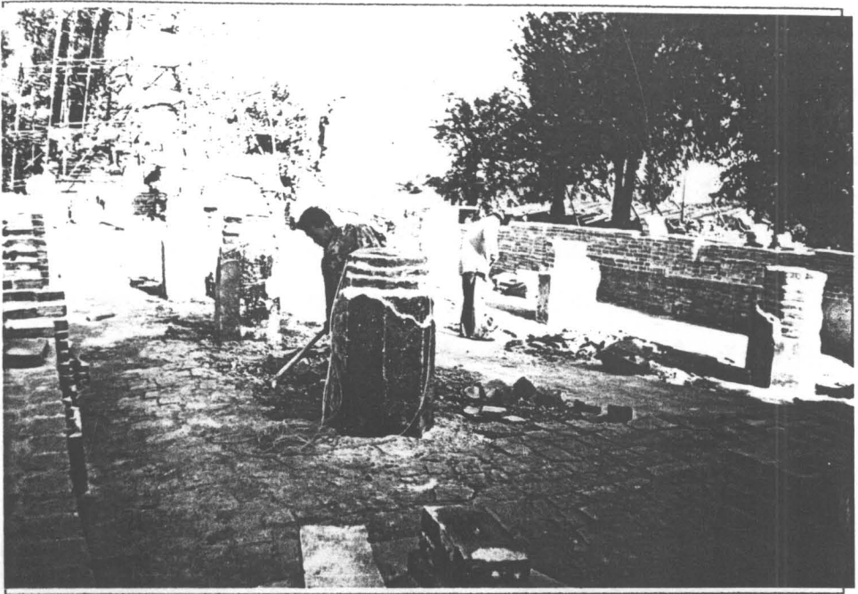
รูปที่ 28 ดำเนินการบูรณะวิหาร (ปรับระดับพื้นภายใน) (10/34)
