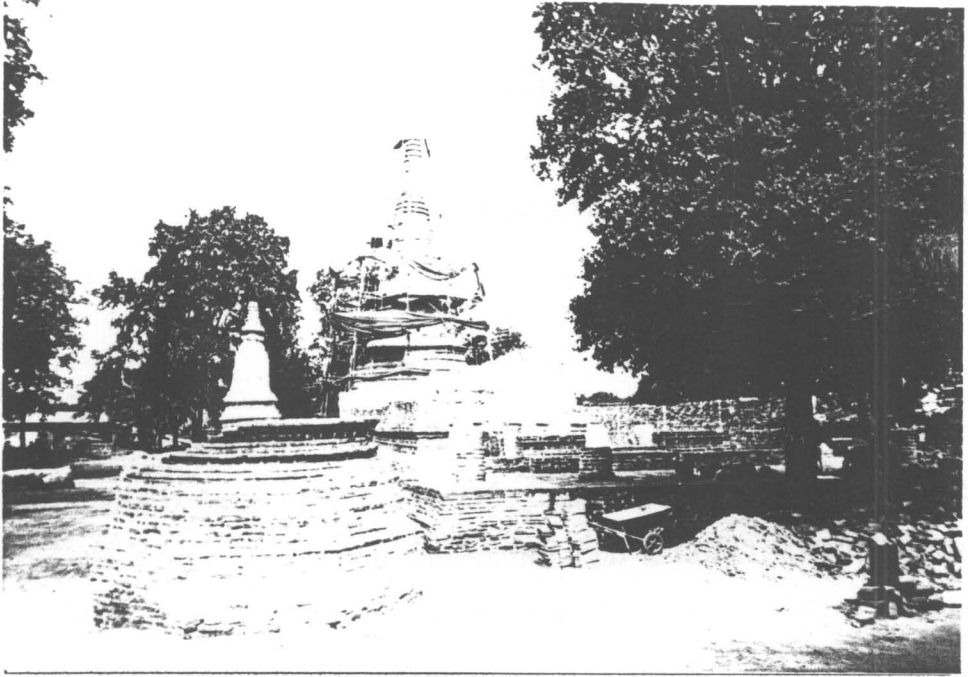
รูปที่ 52 สภาพโดยรวมของวัดตะไกร ขณะดำเนินการบูรณะ (22/7)
